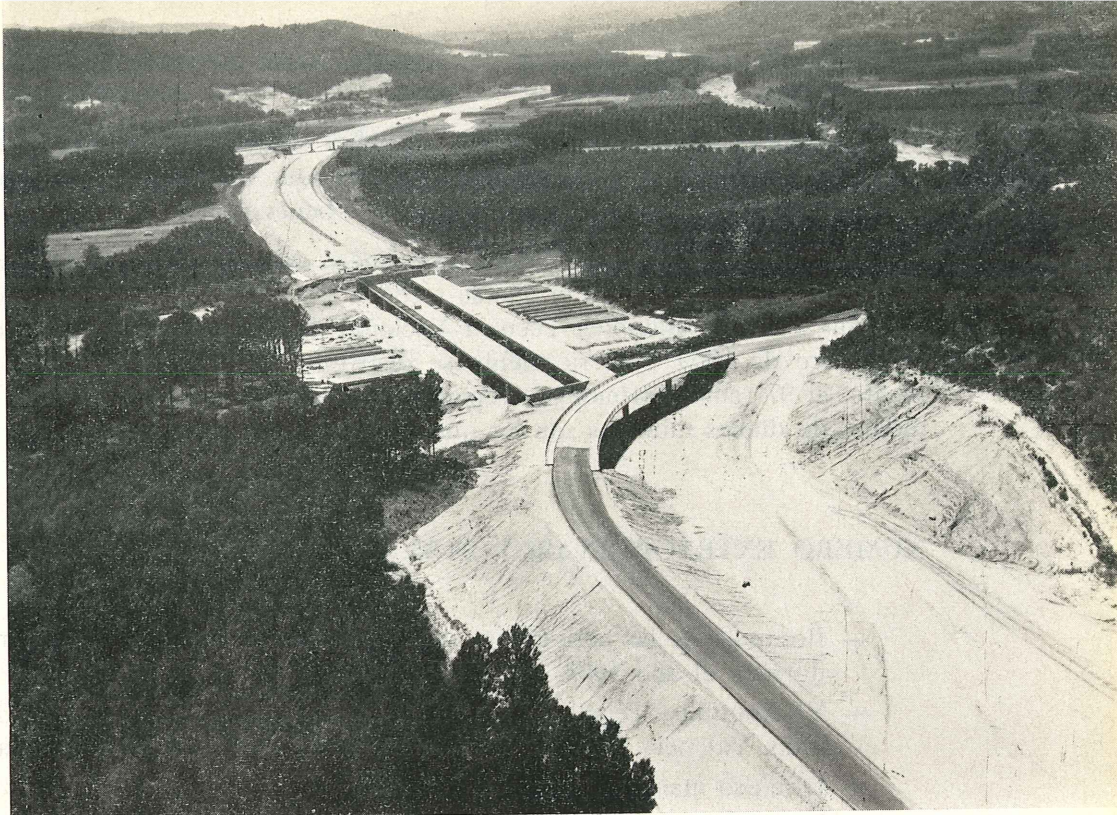
Autopista Barcelona-La Junquera. Puente sobre el río Ter y dos pasos superiores.
