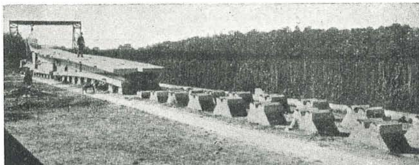
Fig. 5 Bancada para el montaje de las vigas.
