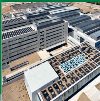
Hospital de Cuenca. Asistencia técnica y control de proyecto, materiales, ejecución y pruebas de instalaciones para el SESCAM
