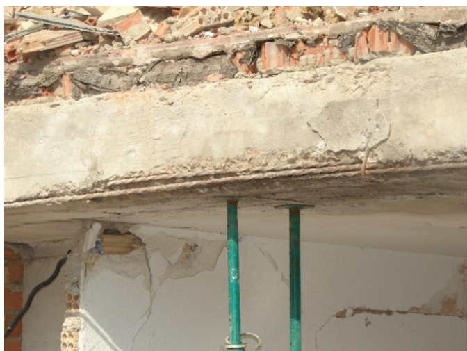
Desconchones en el hormigón.
