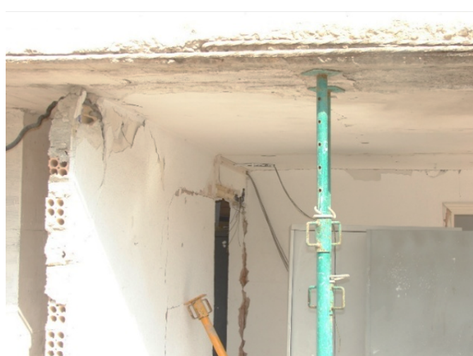
Desconchones en el hormigón.
