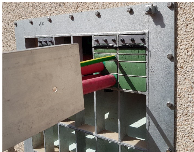
Figura 8. Sistema del tipo MCT para entrada aérea de cableado eléctrico en una subestación.
