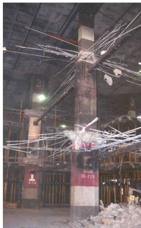
Figura 31. Aparcamiento P2. Arriostramiento de los pilares para asegurar su estabilidad tras la demolición.
