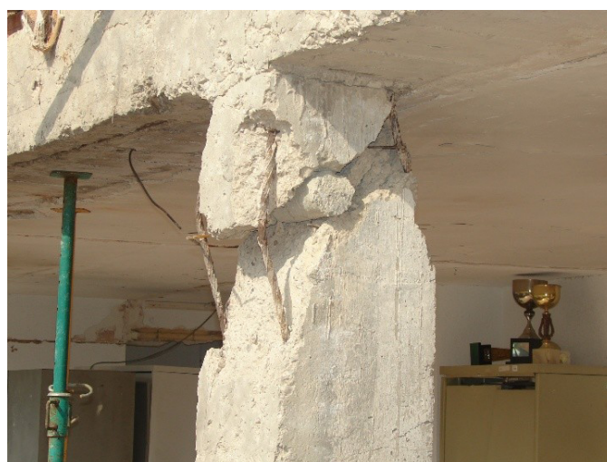
Daños en cabeza de un soporte por una explosión exterior junto a un cuerpo de una única altura adyacente al edificio principal.
