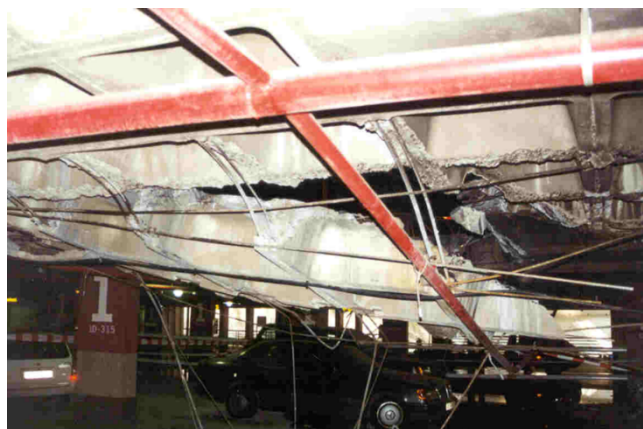
Aparcamiento P2 Aeropuerto Barajas, Madrid. 1998.
