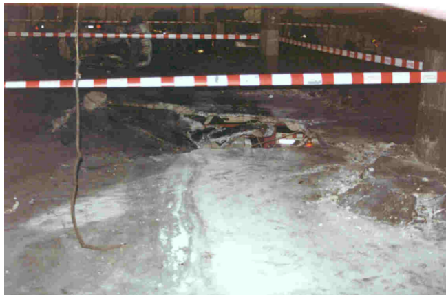
Aparcamiento Pza. Colón, Madrid. 2001.
