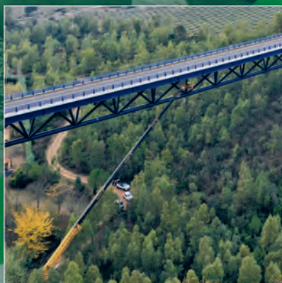
Puente de los Carneros. Inspección especial para la DGC
