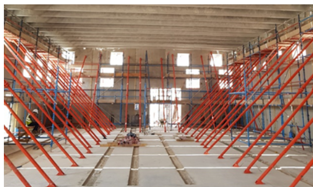
Figura 12. Subestación eléctrica totalmente prefabricada.
