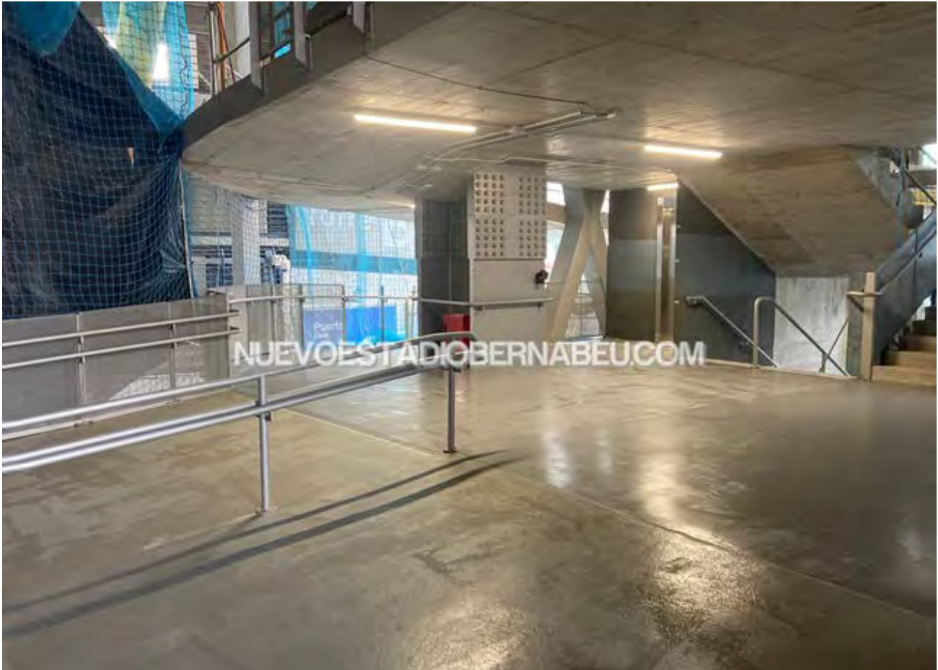
Figura 25. Acabado final de una planta tipo. Foto cedida por cortesía de 'Nuevo Estadio Bernabéu' - Copyright © 2024 Nuevo Estadio Bernabéu.
