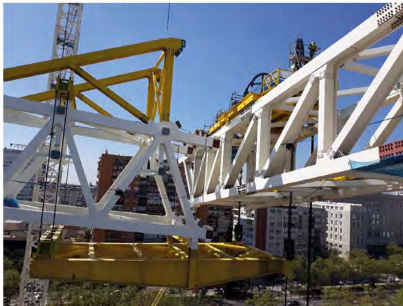
Figura 49. Vista estructura de izado.
