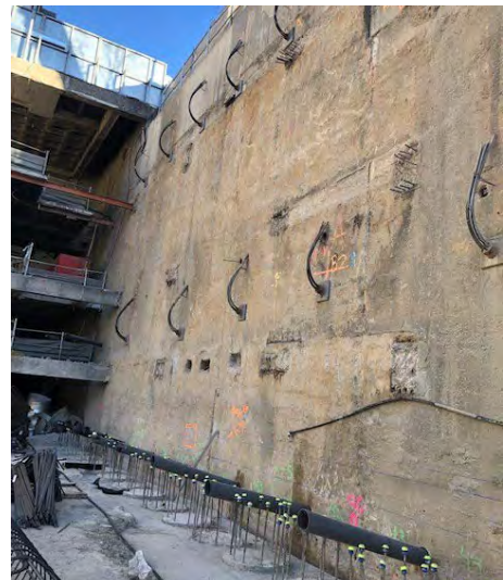
Figura 21. Vista de los pilotes ejecutados.
