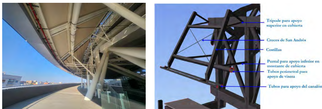
Figura 20. Izquierda: Configuración de módulo de visera en fondos norte y sur. Derecha: Estructura de visera y skywalk .
