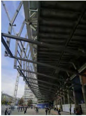
Figura 17. Izquierda: Puntales de sofito oeste. Montaje parcial, previamente a la colocación de arriostramientos en su plano. Derecha: Arriostramientos y juntas de movimiento en sofito oeste.
