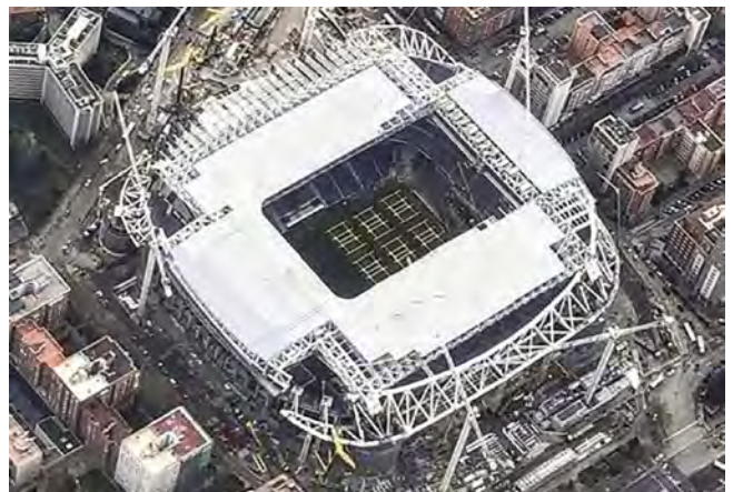
Figura 47. Vista aérea montaje de la cubierta.
