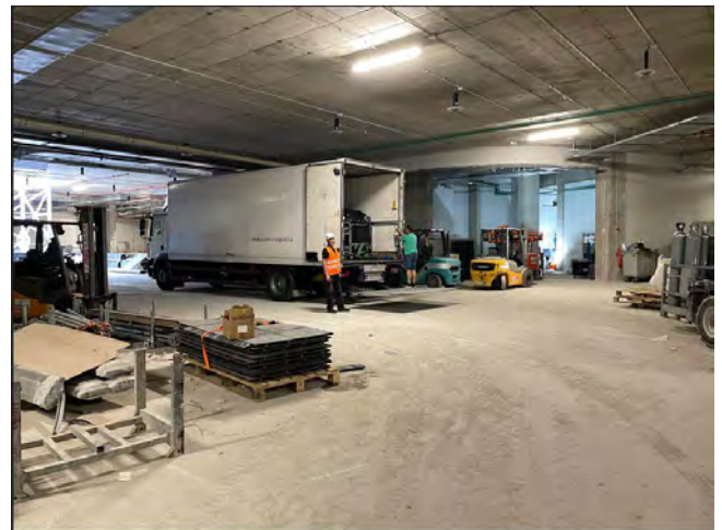
Figura 4. Paso de camiones en sótano 2
