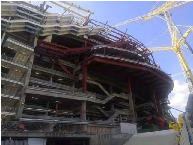
Figura 34. Vista del montaje de la escalera mecánica TMI 16.
