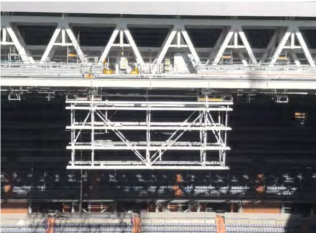
Figura 65. Izado del módulo central. Módulo 3.
