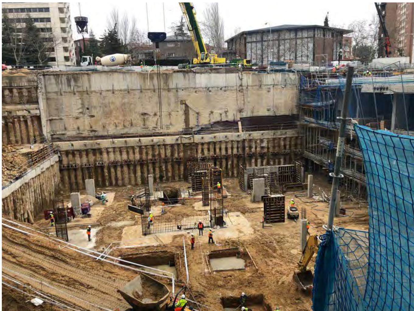
Figura 30. Ejecución de zapatas en extremo norte del sótano 5.
