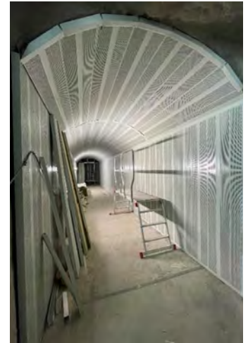
Figura 39. Imagen de galería subterránea de extracción de aire en el momento de instalación de paneles acústicos. Fotografía tomada por equipo de diseño en visita a obra.
