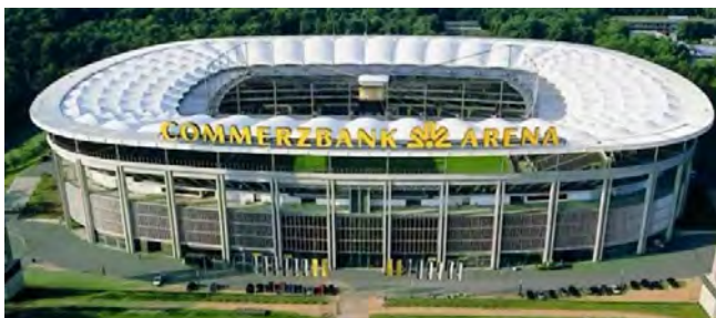
Figura 2. Vista general estadio Commerzbank.
