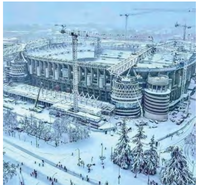
Figura 41. El estadio en obras cubierto de nieve.
