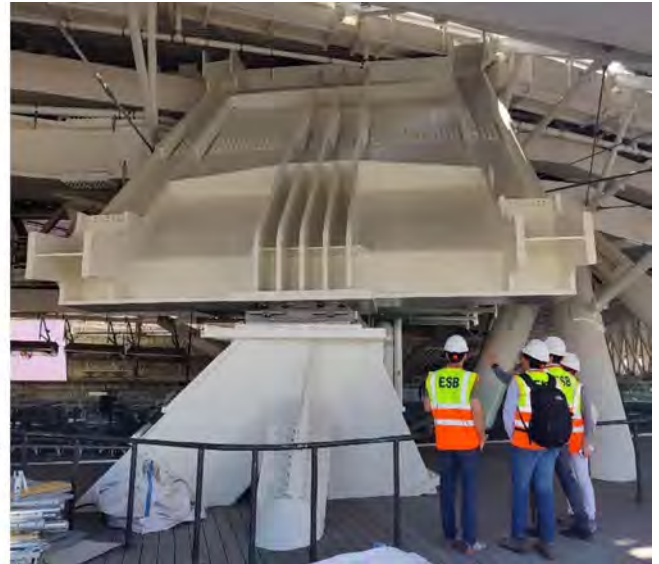
Figura 4. Apoyo esférico.
