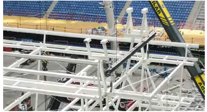
Figura 52. Viga balancín durante la ejecución.
