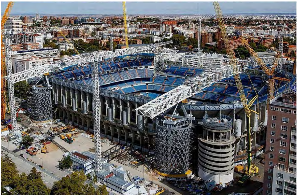
Figura 8. Montaje de los sectores cilíndricos de la cesta -izquierda- y torre durante la construcción -derecha- Vista general -inferior-. Foto derecha e inferior cedidas por cortesía de 'Nuevo Estadio Bernabéu' - Copyright © 2024 Nuevo Estadio Bernabéu.
