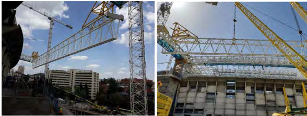
Figura 42. Unión atornillada cercha atirantada y paso de carretones.
