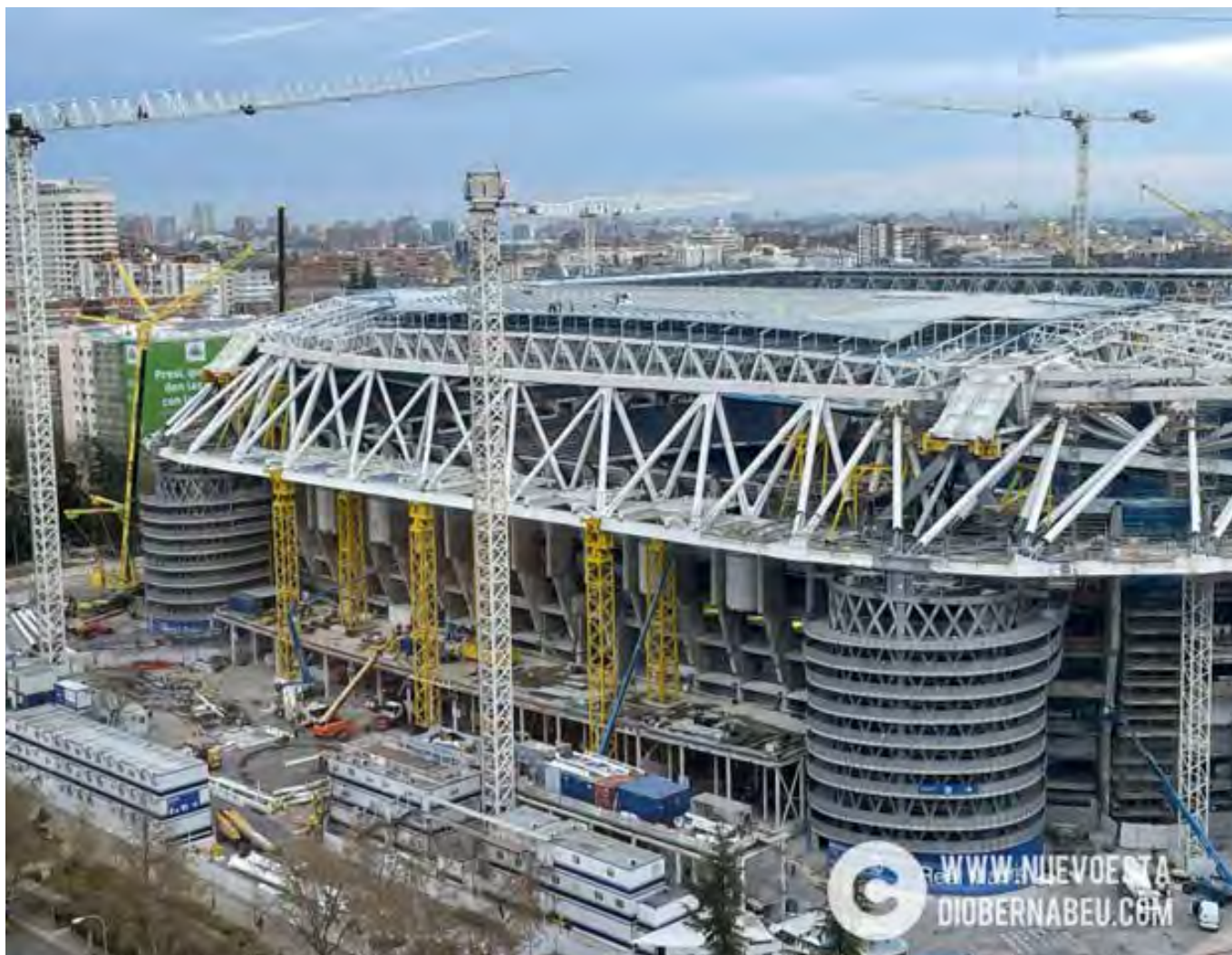
Figura 21. Montaje corona. Izado de cordón superior mediante grúas. Foto cedida por cortesía de 'Nuevo Estadio Bernabéu' - Copyright © 2024 Nuevo Estadio Bernabéu.
