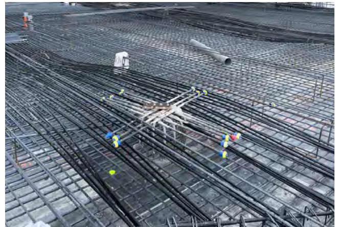
Figura 10. Detalle de pretensado en forjado de Planta Primera.
