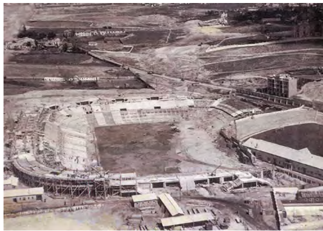
Figura 2. Obras del nuevo estadio junto al antiguo estadio de Chamartín.
