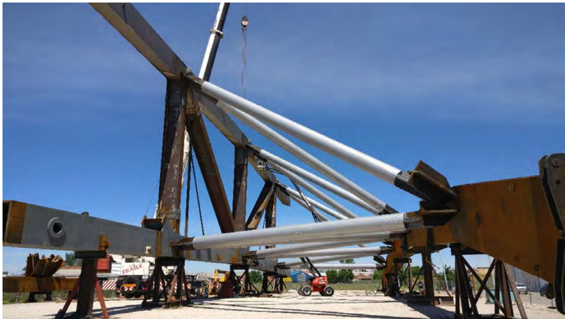
Figura 20. Premontaje en blanco de módulo de corona en taller.
