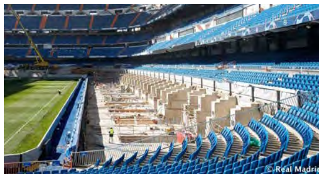
Figura 19. Columna de hormigón para apoyo de vigas metálicas en voladizo.
