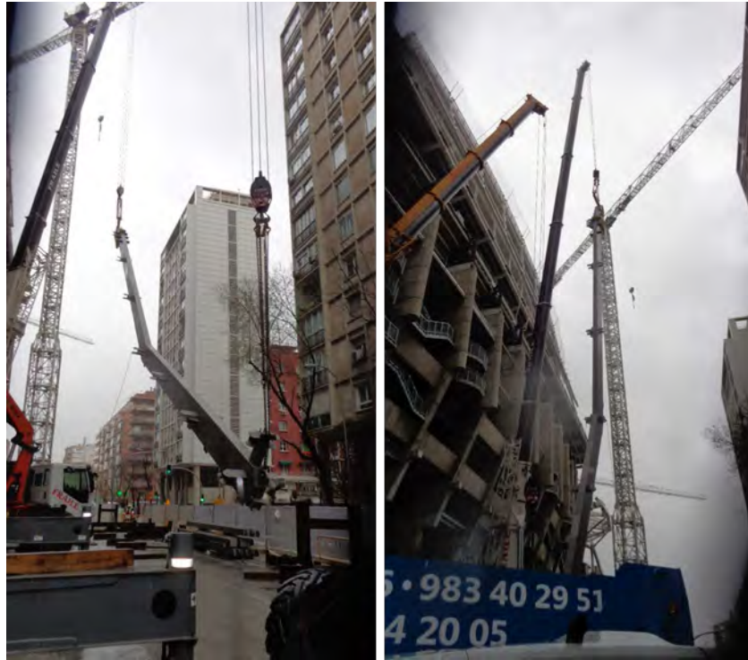
Figura 25. Izado de primera costilla en el fondo sur.
