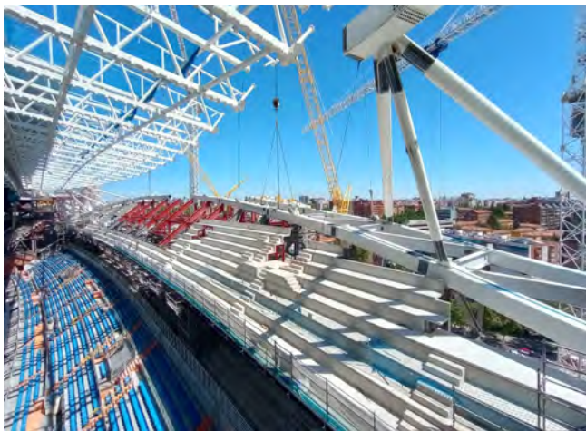
Figura 41. Viga corona. Montaje parcial.
