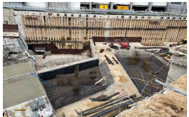
Figura 28. Vista de la realización de anclajes lado estadio.
