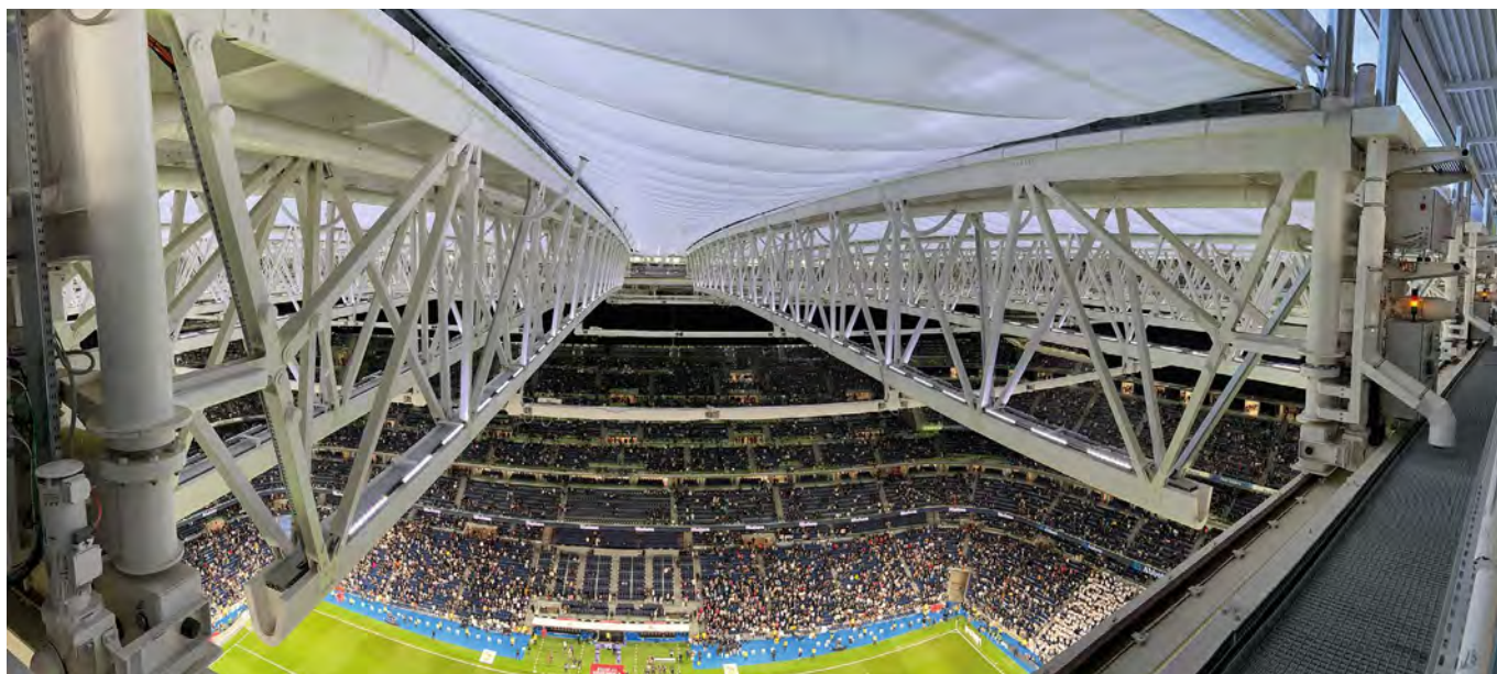
Figura 45. Vista interior de la cubierta retráctil.
