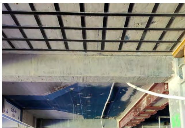
Figura 38. Losa reforzada con bandas de fibra y viga reforzada con estructura metálica.
