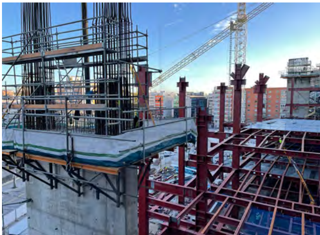
Figura 19. Pantallas de hormigón en ejecución.
