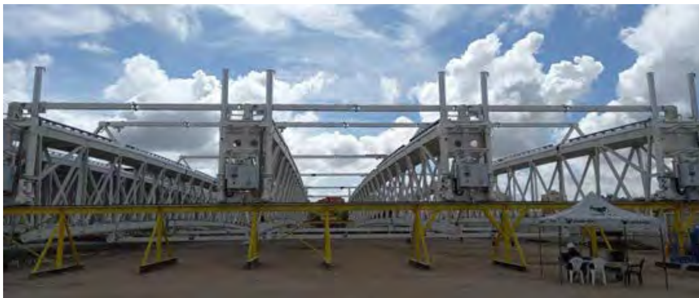
Figura 62. Montaje en blanco en taller.
