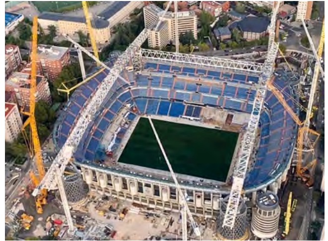
Figura 34. Vista montaje cerchas atirantadas.
