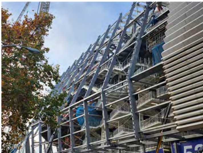
Figura 4. Derecha: Vista de subestructura de la fachada intermedia, inferior y sofito. (Copyright © 2024 Nuevo Estadio Bernabéu) Izquierda: Principales elementos estructurales de la estructura de soporte de la fachada y dimensiones aproximadas.
