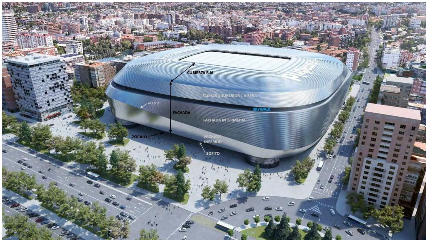
Figura 1. Parte de la envolvente y de la Fachada. Vista desde el oeste. (Copyright © 2024 Nuevo Estadio Bernabéu).
