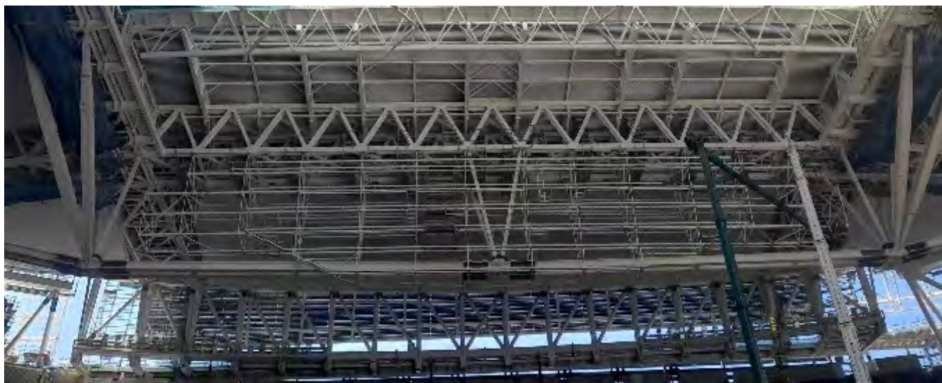
Figura 46. Estructura de fondos totalmente ejecutada.
