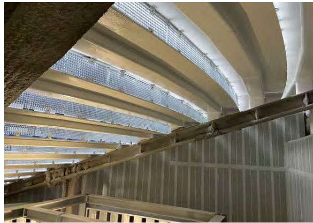
Figura 35. Imagen proceso constructivo desde sala de toma de aire bajo grada hacia la grada donde se aprecian las tabicas de rejilla metálica para toma de aire. Imagen tomada por equipo de diseño en visita a obra.
