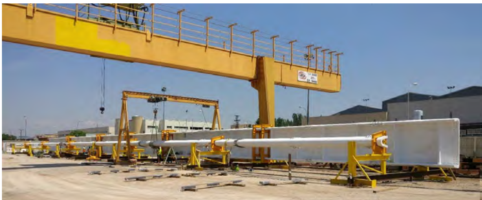
Figura 39. Proceso de curvado cercha en taller.
