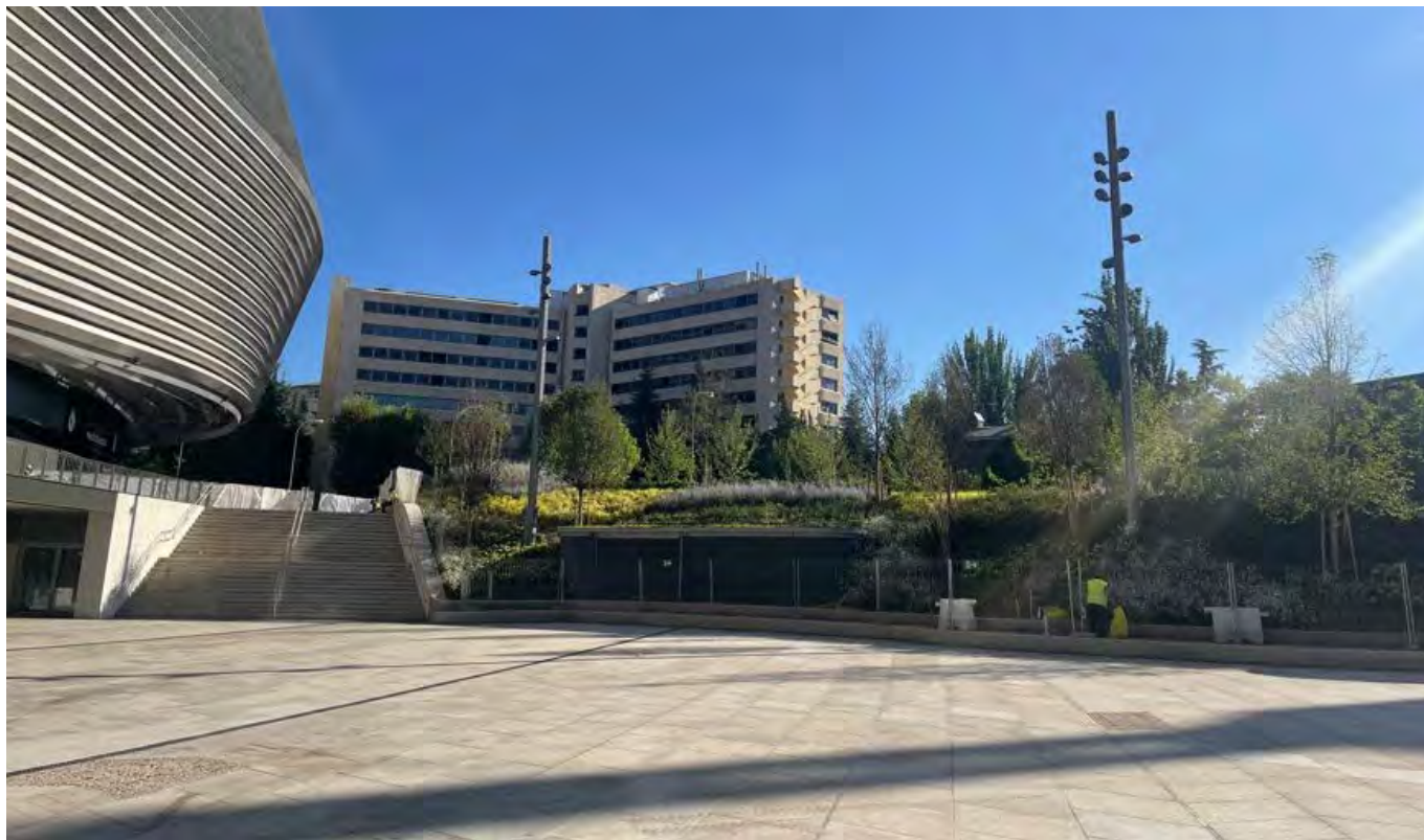
Figura 5. Sótano 1 y Planta Primera. Vista general de la plaza pública.
