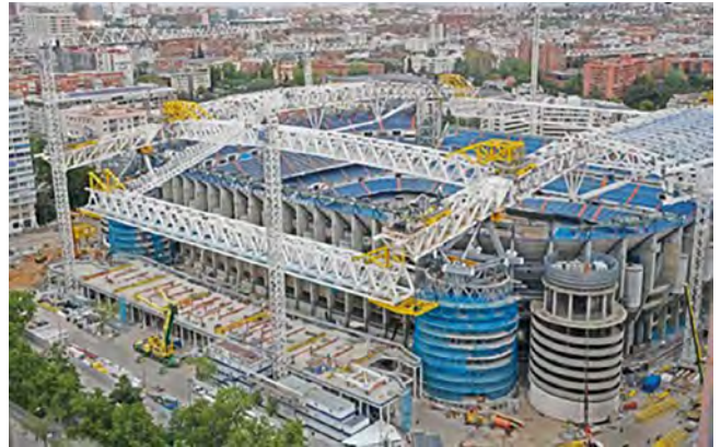
Figura 44. Elevación cerchas transversales.
