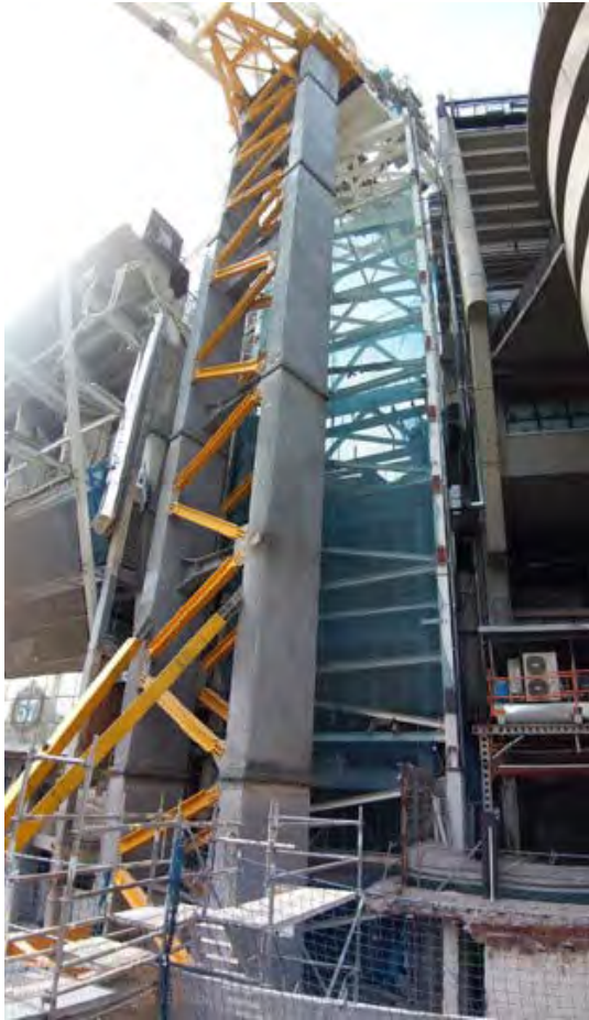
Figura 3. Torreón Sur, el nuevo péndulo de la cubierta a la izquierda, y el torreón tras la primera fase de demolición, a la derecha. Se aprecia como el torreón está encajado entre gradas del estadio.
