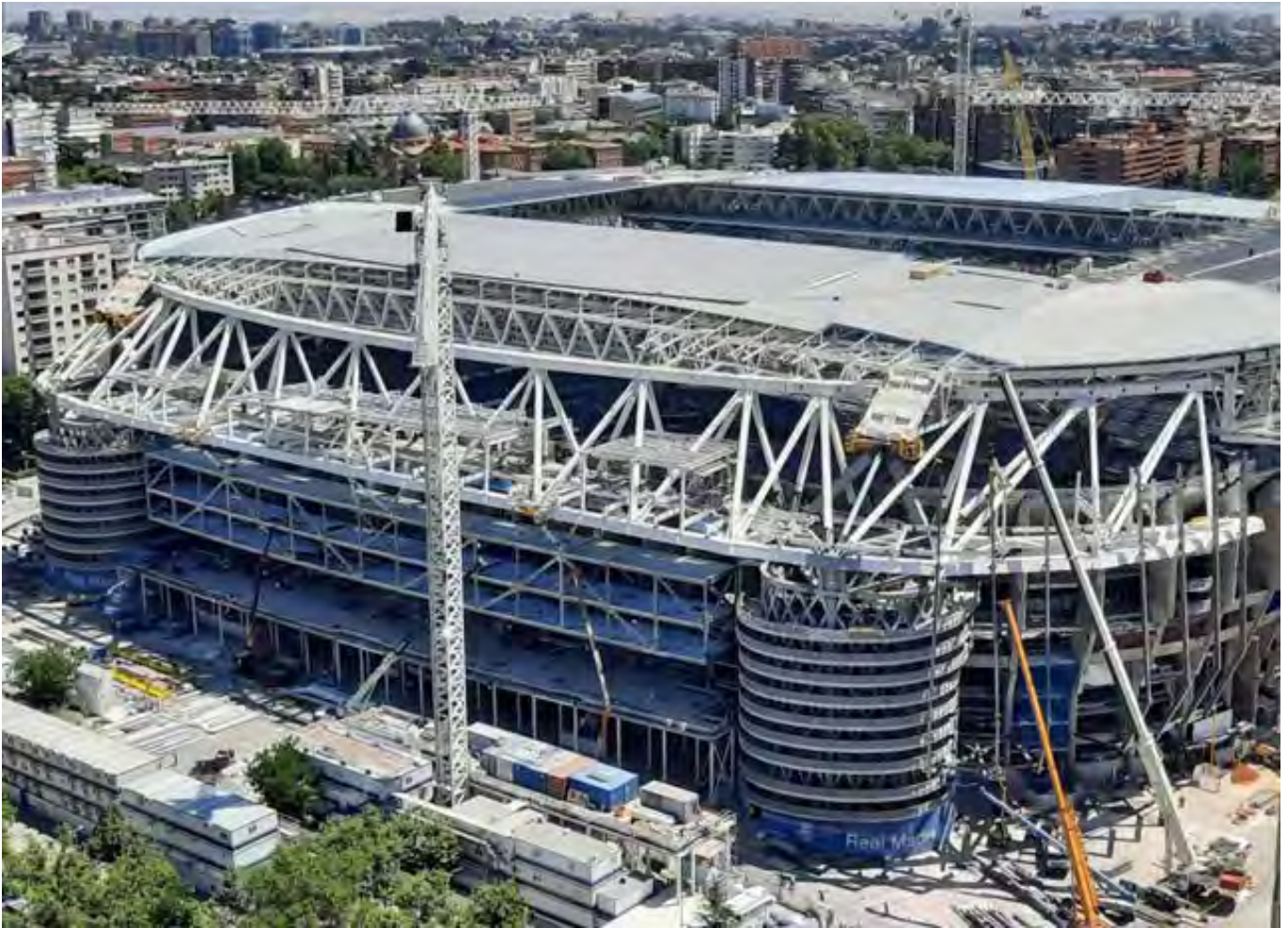
Figura 1. Vista aérea del Edificio Oeste durante la construcción. Foto cedida por cortesía de 'Nuevo Estadio Bernabéu' - Copyright © 2024 Nuevo Estadio Bernabéu.
