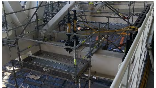
Figura 57. Apoyo de los gatos en uno de los cordones de la cercha de Rodadura. Ejecución.
