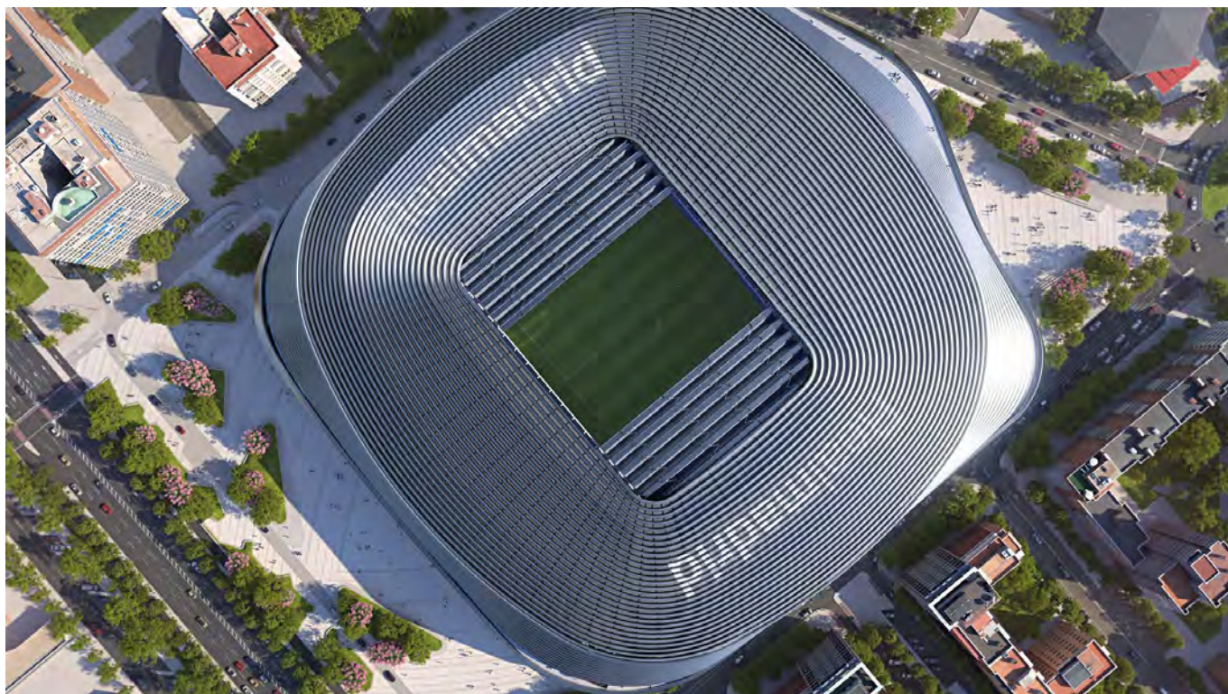
Figura 18. Vista aérea de la cubierta retráctil.
