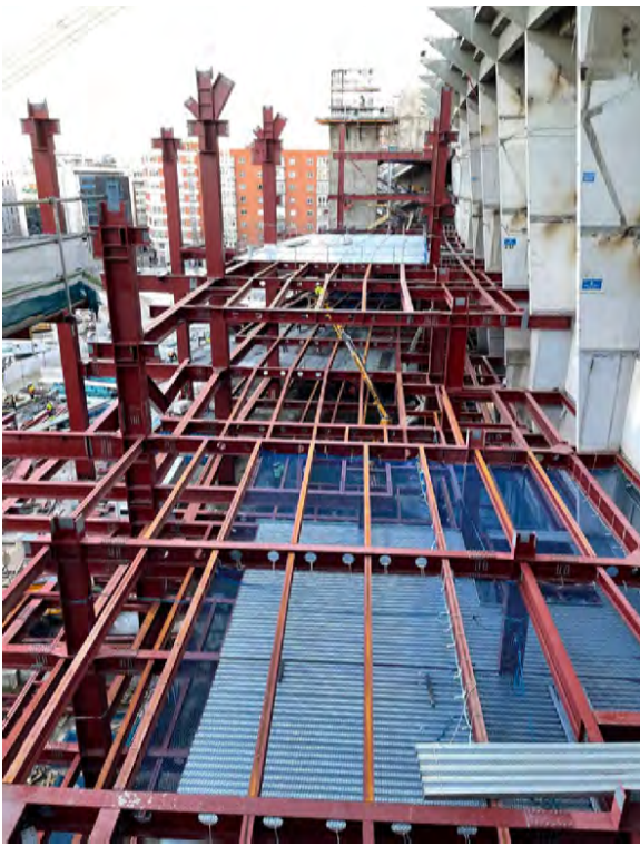
Figura 3. Ejecución de forjado de chapa colaborante.
