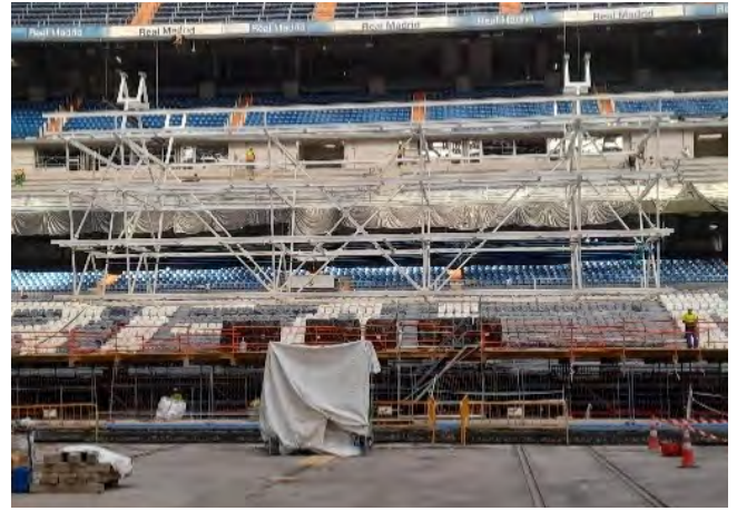
Figura 64. Montaje de los tramos en la estructura sobre la plataforma situado sobre los graderios.
