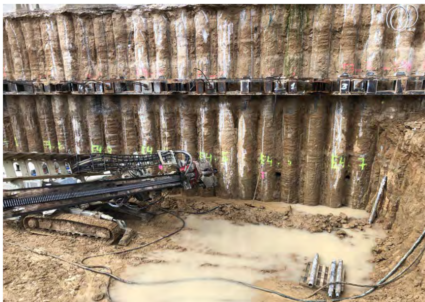
Figura 22. Ejecución de anclajes al terreno.
