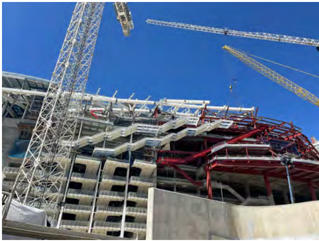
Figura 31. Escaleras perimetrales sur y escaleras voladas (por debajo).
