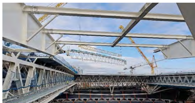
Figura 48. Montaje cerchas cubierta retráctil.
