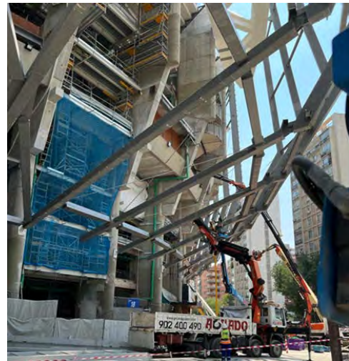
Figura 19. Izquierda: Torre B. Estructura de sofito rodeando la torre. Derecha:Detalle de estructura de sofito junto a torre.
