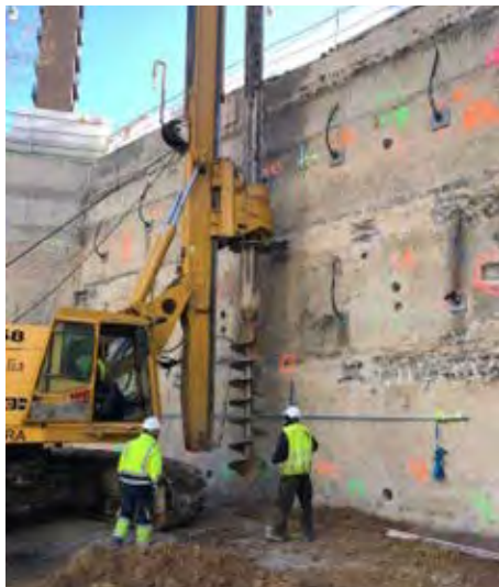
Figura 20. Ejecución de pilotes en intradós de pantalla existente.
