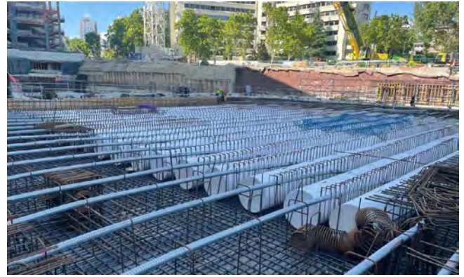
Figura 9. Ejecución de losa aligerada.
