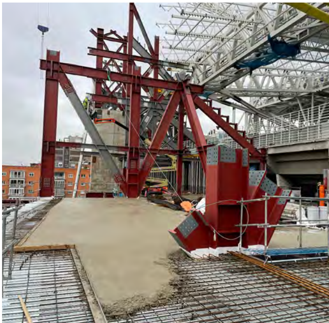
Figura 11. Pórtico tipo principal en ejecución.
