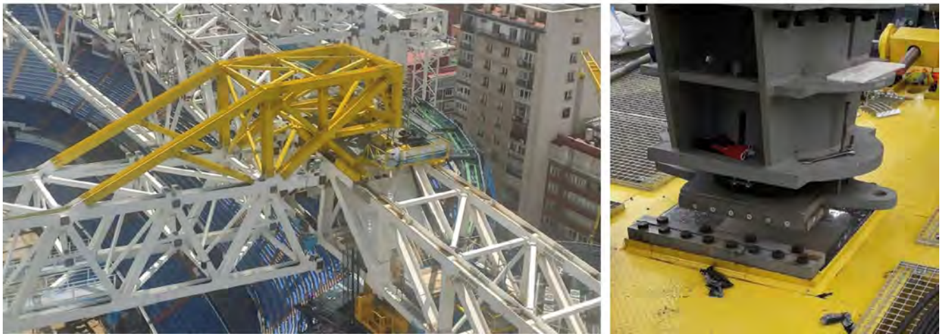
Figura 50. Vista estructura de cuelgue y gato de apoyo.
