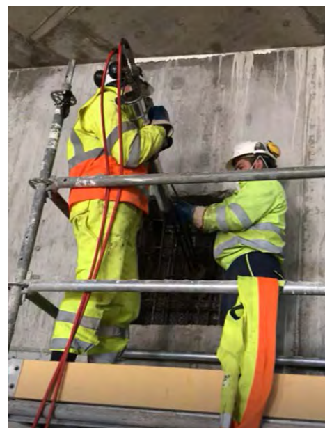
Figura 23. Destesado y retirada de anclajes con muro forro.
