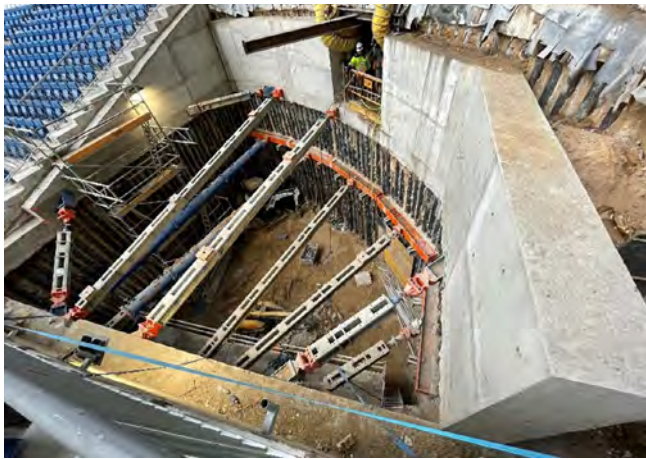
Figura 34. Imagen proceso constructivo de las salas de contacto con arriostramientos temporales. Fotografía tomada por el equipo de diseño en visita a obra.
