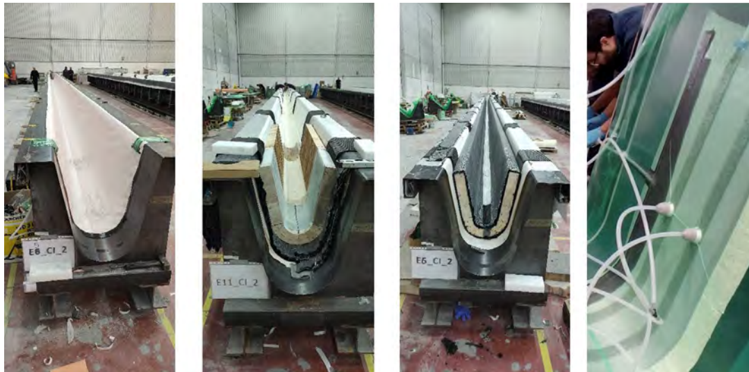
Figura 38. Proceso de fabricación cordón inferior.
