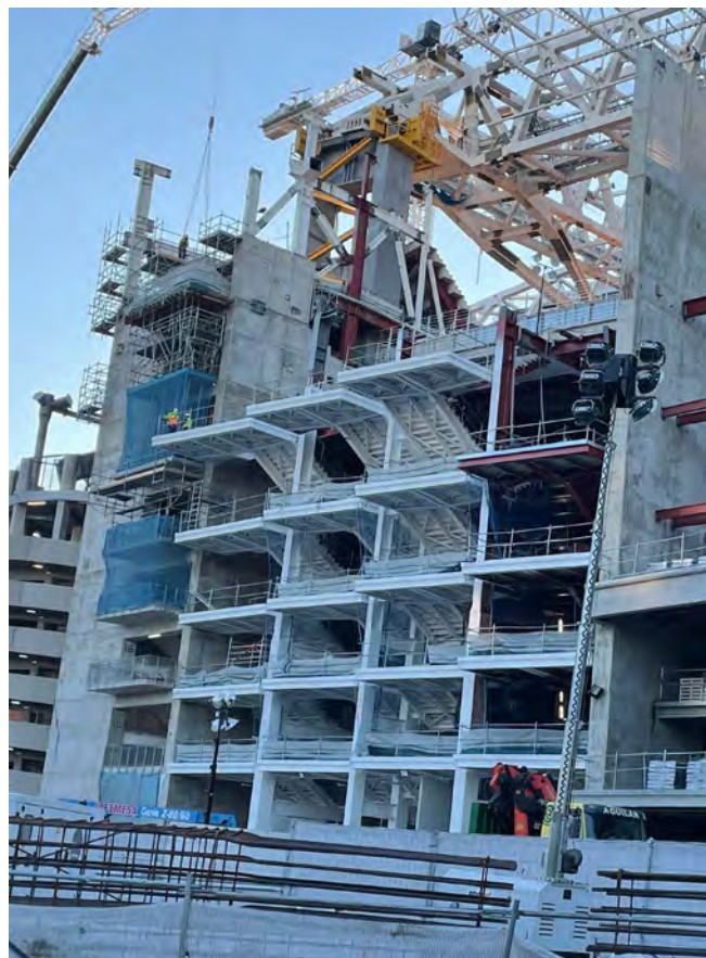
Figura 27. Escalera voladas en ejecución.
