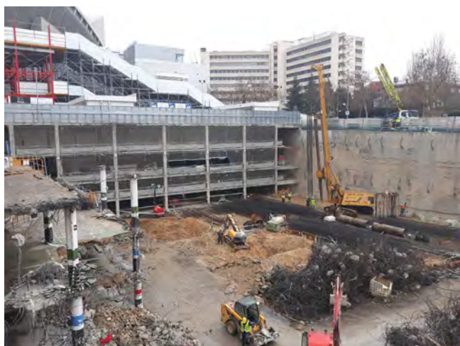
Figura 18. Demolición del lado sur del centro comercial.
