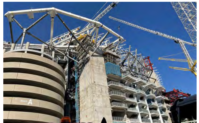
Figura 44. Viga corona. Apoyos en torres en ejecución.
