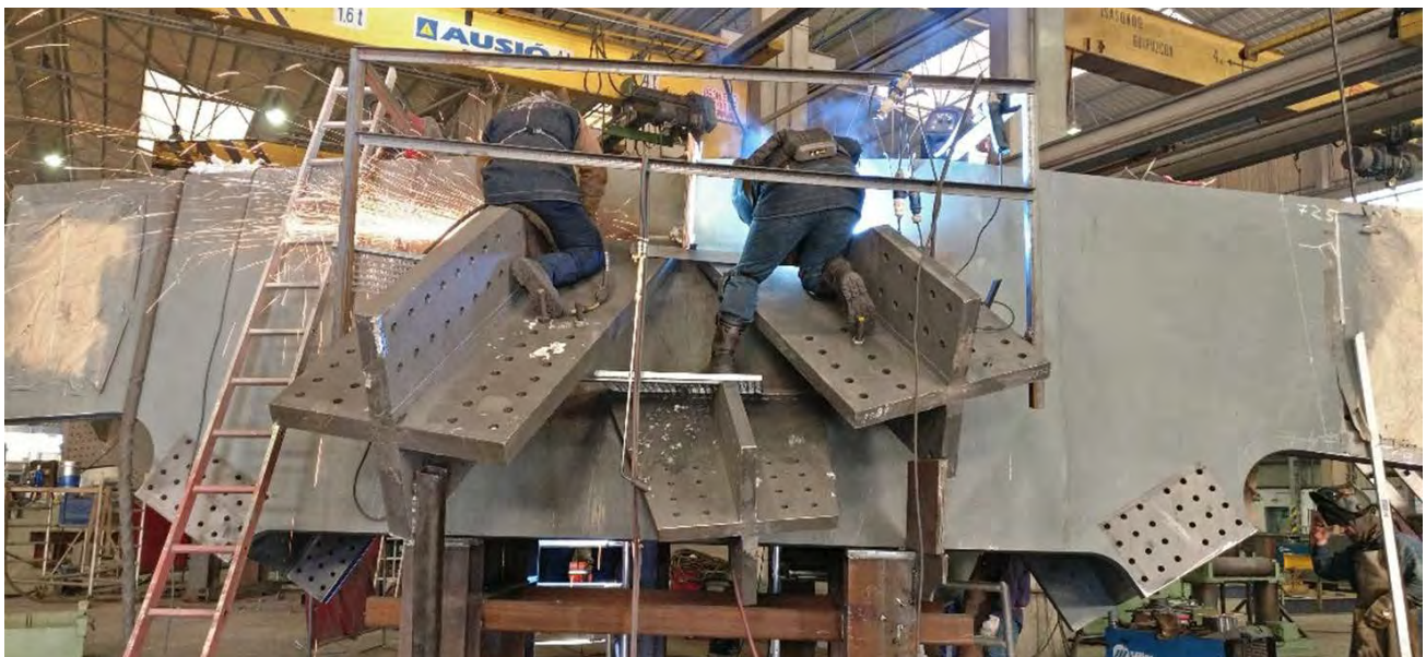
Figura 12. Ejecución de nudo corona en taller.
