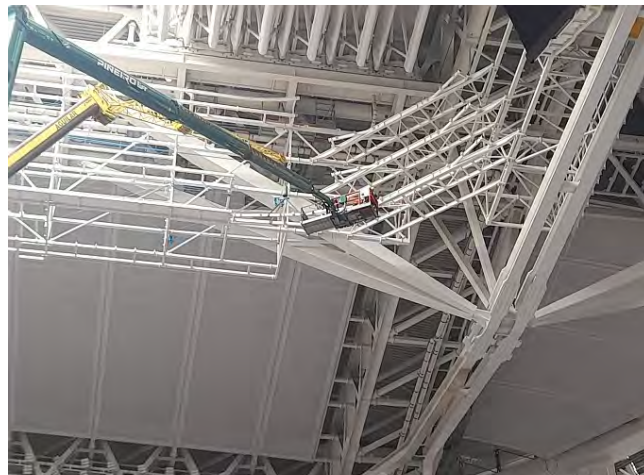
Figura 72. Colocación de las vigas de apoyo de la pasarela.
