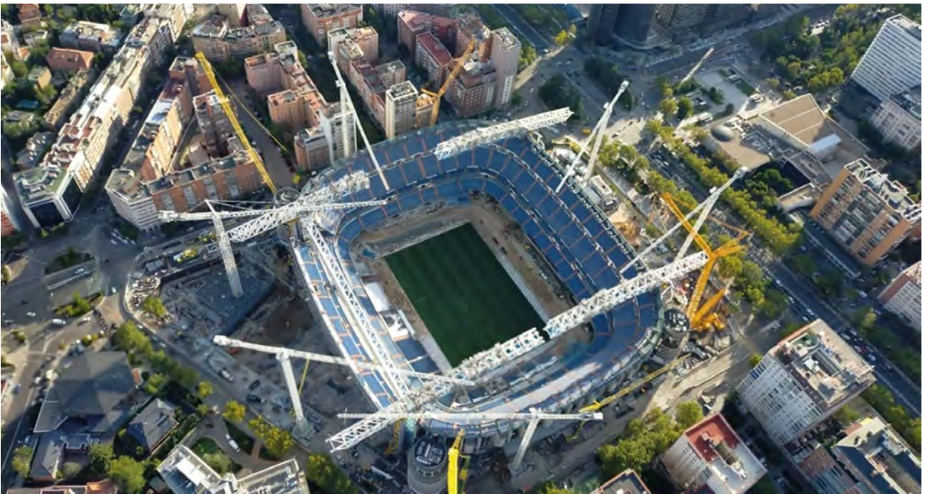
Figura 37. Vista aérea montaje cerchas atirantadas.
