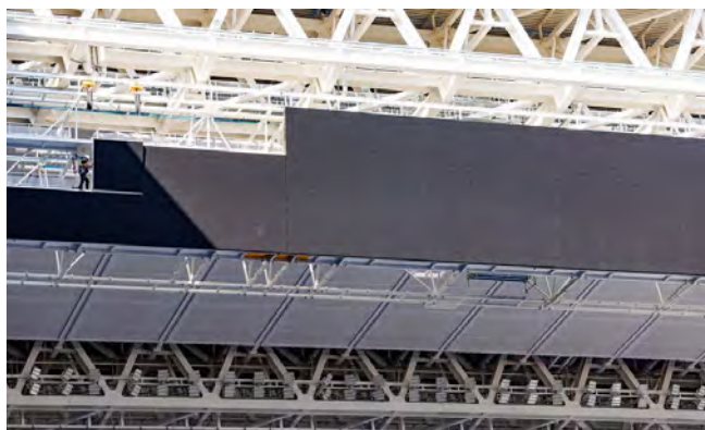
Figura 69. Instalación de las pantallas del videomarcador.
