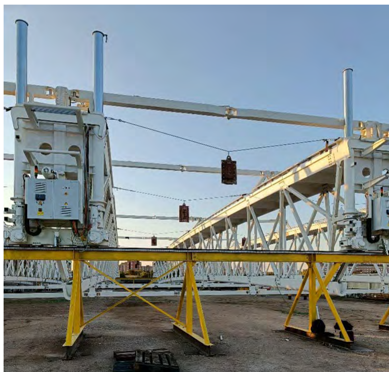
Figura 63. Prueba de carga.
