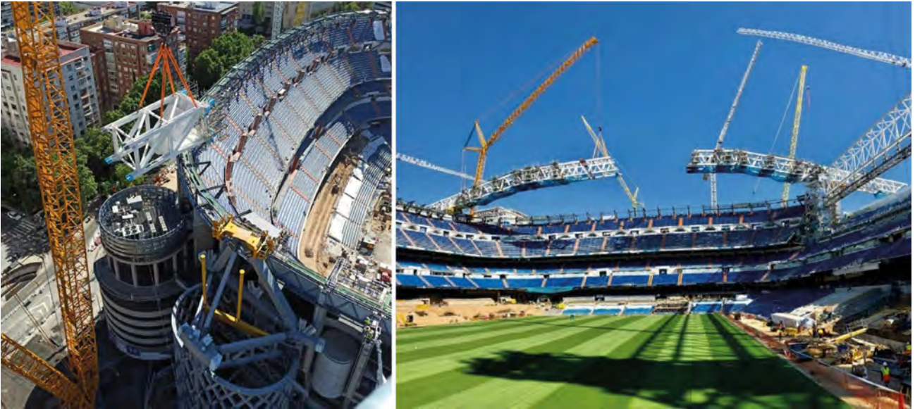
Figura 36. Vistas montaje cerchas atirantadas.
