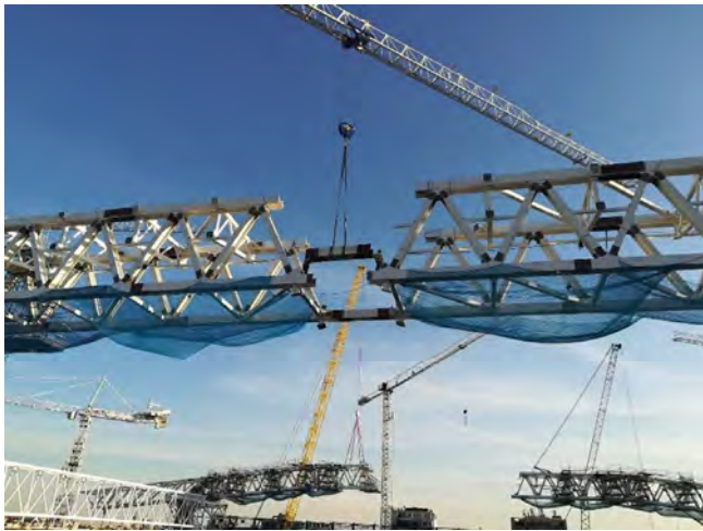
Figura 38. Vista cierre cercha atirantada.
