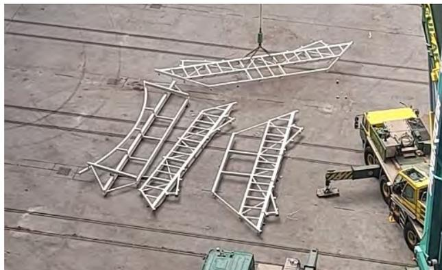
Figura 70. Estructura horizontal de la zona de curvas.
