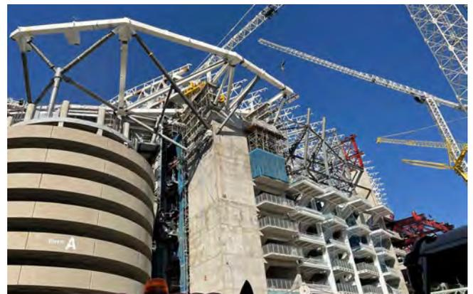
Figura 44. Viga corona. Apoyos en torres en ejecución.
