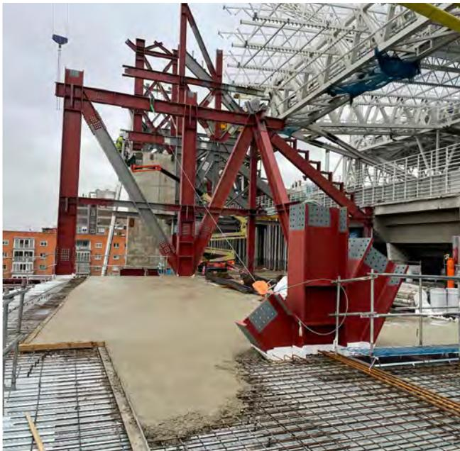
Figura 11. Pórtico tipo principal en ejecución.
