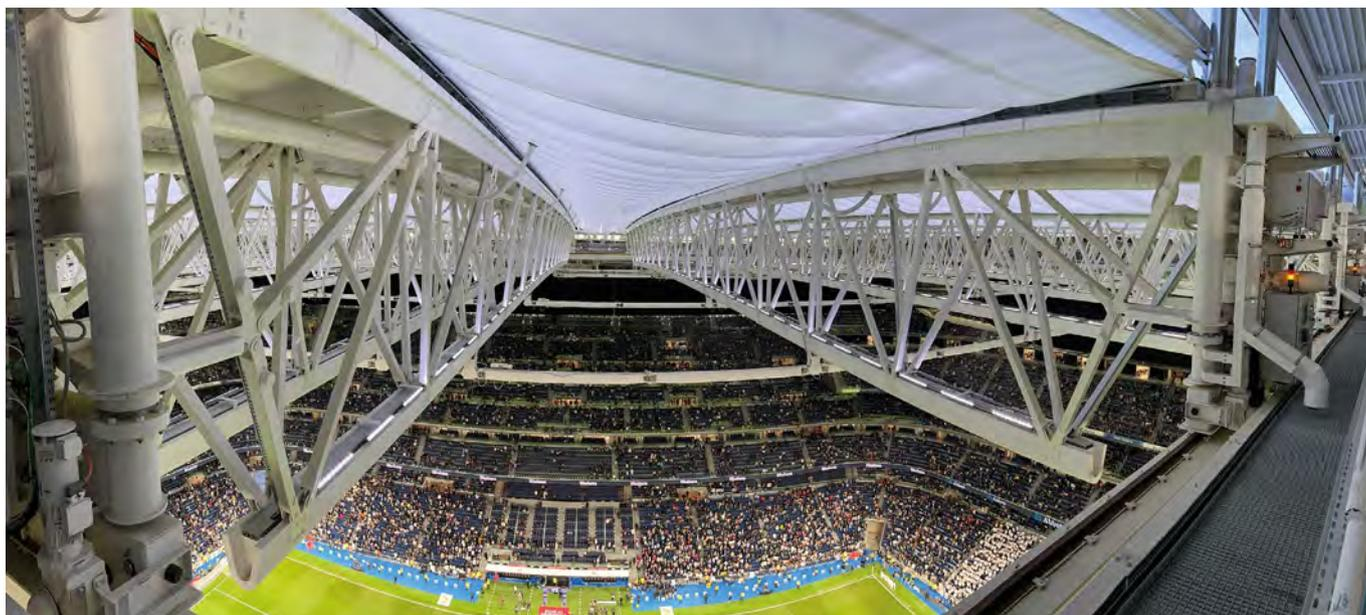
Figura 45. Vista interior de la cubierta retráctil.
