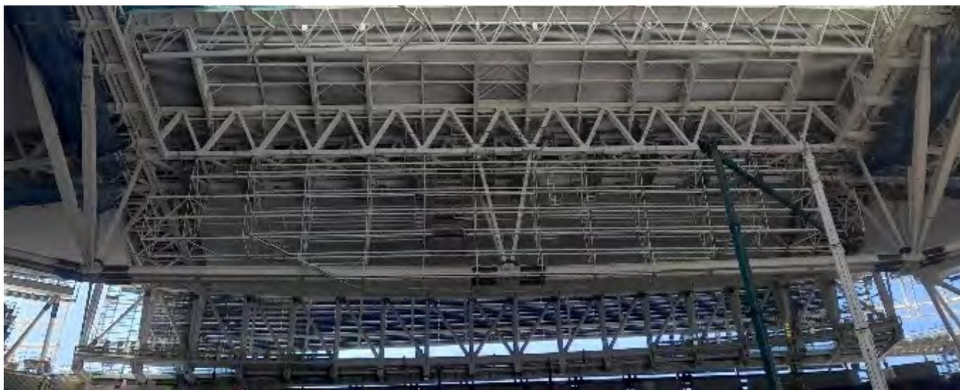
Figura 46. Estructura de fondos totalmente ejecutada.
