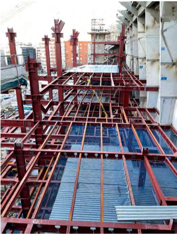
Figura 3. Ejecución de forjado de chapa colaborante.
