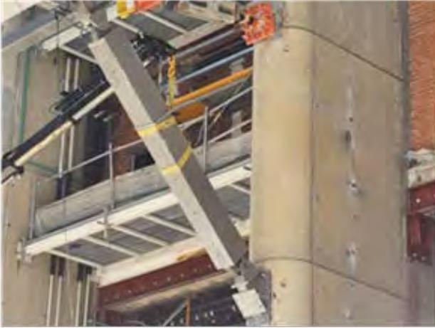
Figura 11. Detalle de conexión de puntales de sofito con las pantallas del edificio existente.
