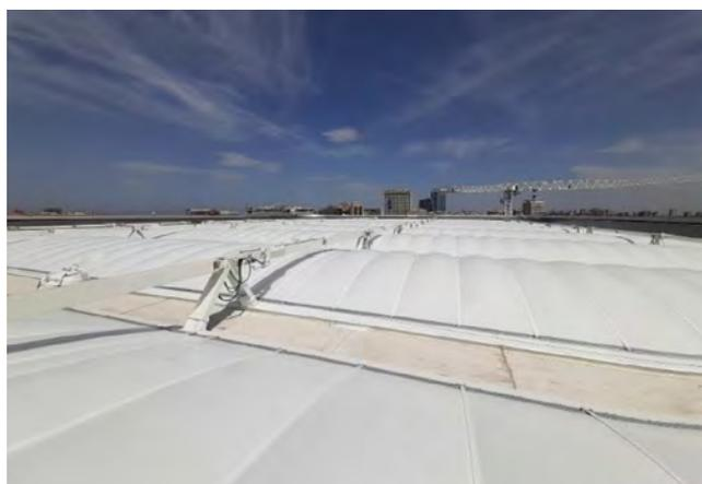
Figura 44. Prototipo de cojín (arriba) – Cojines instalados (abajo).
