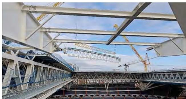
Figura 48. Montaje cerchas cubierta retráctil.
