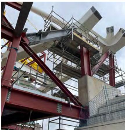
Figura 42. Viga corona. Apoyo de cordones inferiores sobre pórticos.
