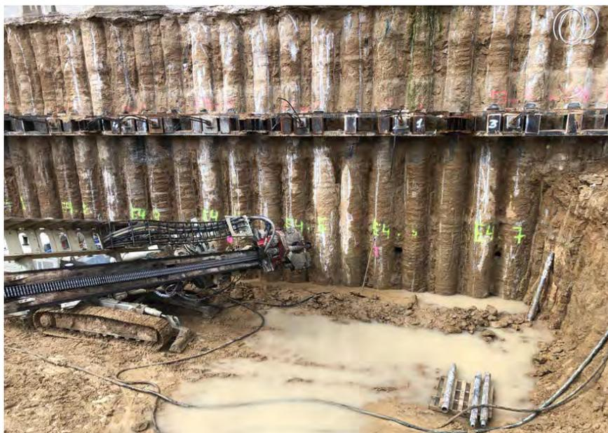
Figura 22. Ejecución de anclajes al terreno.
