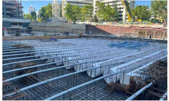
Figura 9. Ejecución de losa aligerada.
