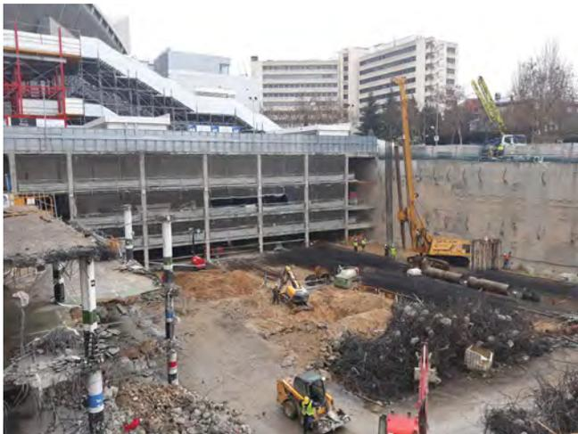
Figura 18. Demolición del lado sur del centro comercial.
