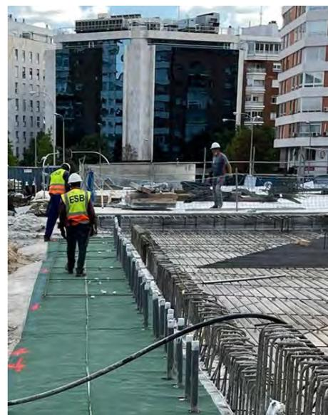
Figura 34. Detalle de conexión de muro perimetral a losa de Planta Primera.
