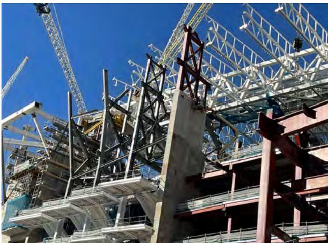
Figura 14. Pórticos en alineaciones de escaleras voladas en ejecución.
