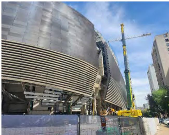
Figura 22. Vano de junta de fachada previamente a la colocación de lamas especiales.
