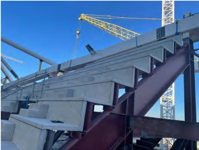
Figura 23. Gradas prefabricadas.
