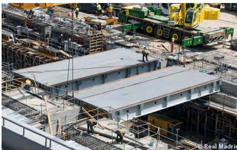
Figura 11. Montaje de módulos de tapa.
