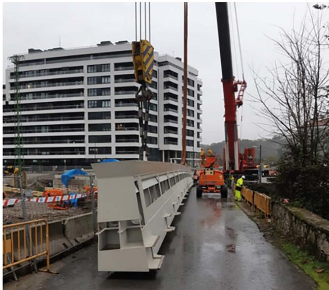
Figura 13. Posicionamiento de nervios longitudinales.
