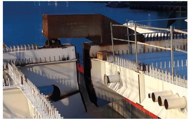
Figura 13. Colocación de bow-string sobre apoyos provisionales.
