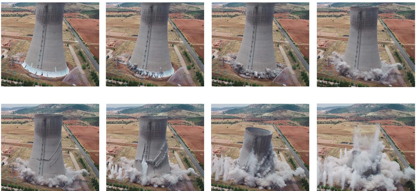
Figura 21. Fotografías del proceso de caída de la torre de refrigeración.
