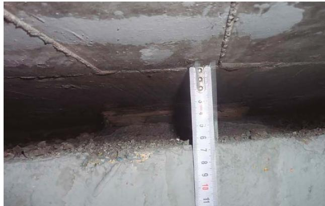
Figura 5. Detalle del reducido espacio disponible entre el estribo y el tablero en la zona de apoyos.
