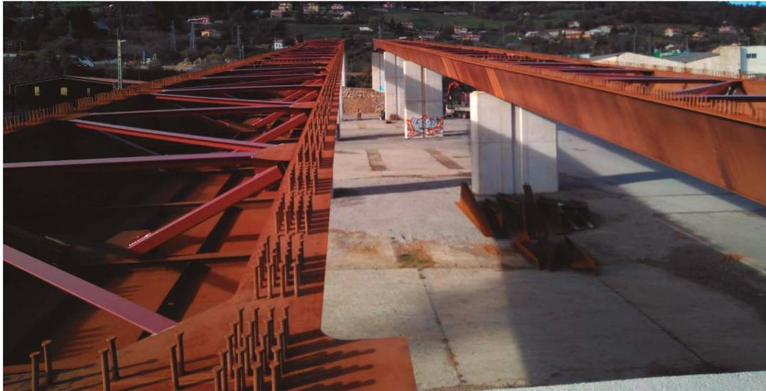
Figura 7. Vista de los cajones metálicos del tramo de tablero único de ancho constante, pila 3 a estribo 2.
