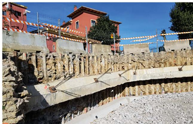
Figura 7. Pantalla de micropilotes en Estribo 2.
