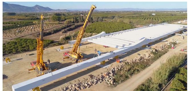
Figura 10. Fotografía aérea de una fase avanzada del montaje de estructura metálica.
