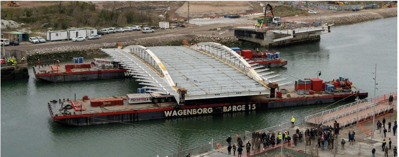
Figura 12. Traslado del bow-string por flotación.
