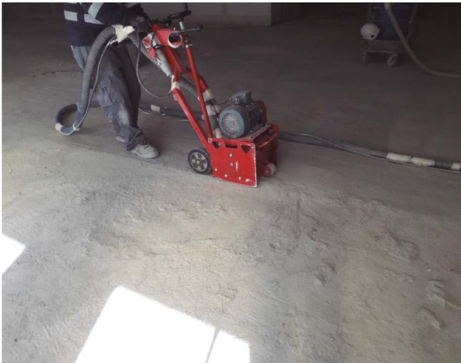
Figura 15. Preparación del soporte.
