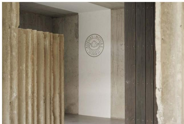
Figura 6. Tratamientos superficiales en hormigones vistos.
