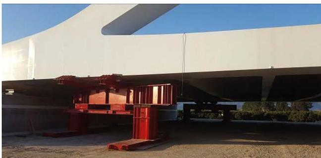
Figura 23. Apoyo mecánico provisional al terreno.
