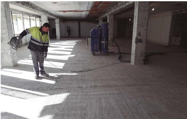
Figura 16. Estado final con la rugosidad requerida.
