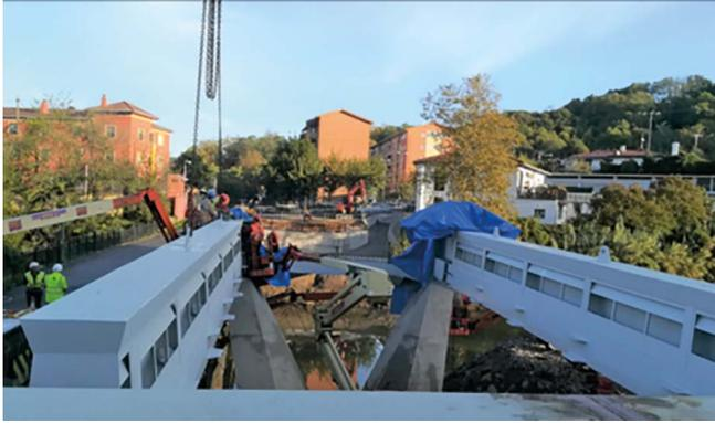
Figura 12. Posicionamiento de nervios longitudinales.
