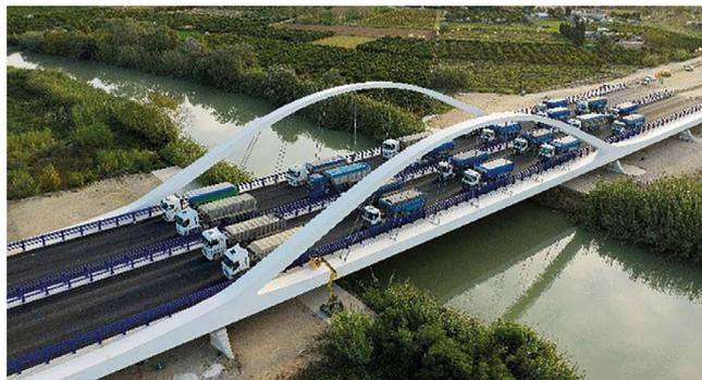
Figura 29. Vista aérea durante la prueba de carga.
