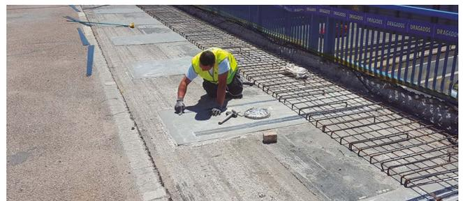
Figura 17. Colocación de las láminas de refuerzo de fibra de carbono.
