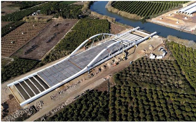
Figura 15. Vista del montaje en obra de la estructura metálica del tablero y prelosas previa al lanzamiento.
