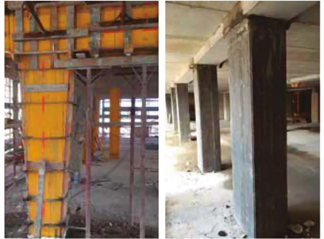
Figura 11. Refuerzo de pilares de hormigón.
