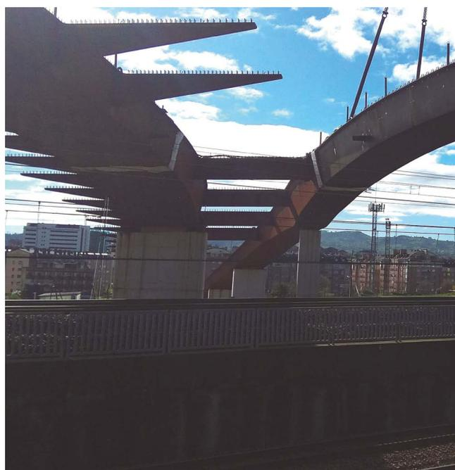
Figura 9. Vista de las rios tras entre cajones metálicos.
