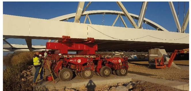
Figura 25. Vista de control topográfico midiendo a dianas dispuestas en las vigas.
