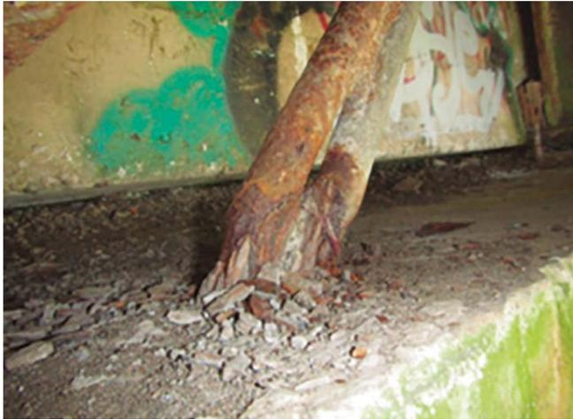
Figura 8. Estado barras antisísmicas.
