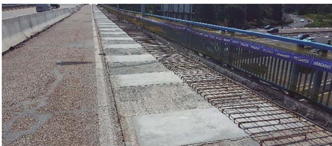
Figura 16. Capa de mortero de nivelación ya ejecutada. Armado para el nuevo zuncho ya colocado.
