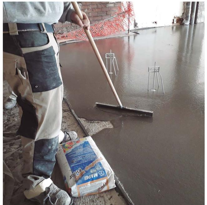
Figura 18. Extendido y control de espesores.
