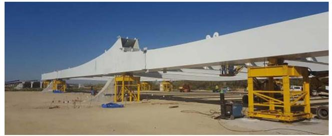
Figura 8. Vista del montaje en obra de la estructura metálica del tablero.
