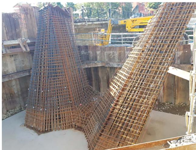
Figura 9. Ferralla alrededor del bastidor metálico de pila.
