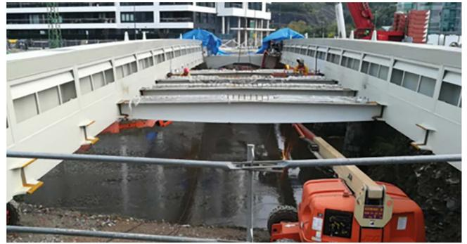
Figura 14. Soldadura de costillas transversales.
