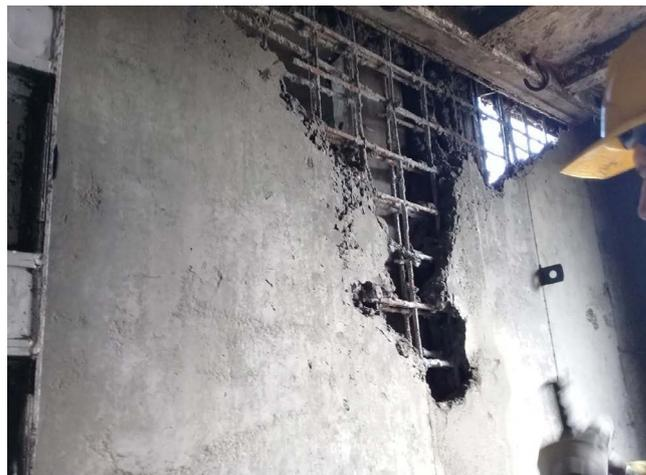
Figura 2. Problemas en el vaciado del concreto.
