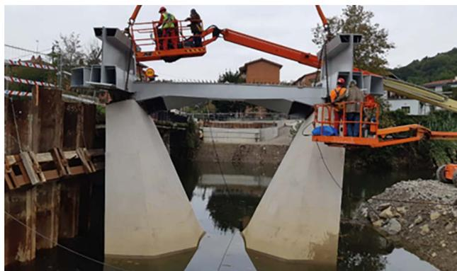
Figura 11. Colocación de nudo en pila.
