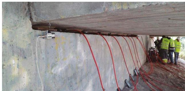
Figura 6. Vista de estribo, gatos hidráulicos instalados para maniobra de sustitución de apoyos.
