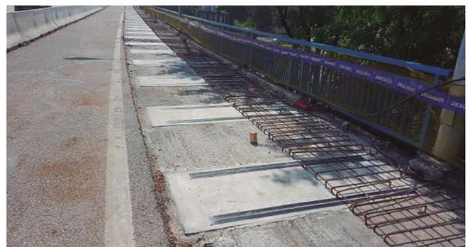
Figura 18. láminas de refuerzo de fibra de carbono ya instaladas.
