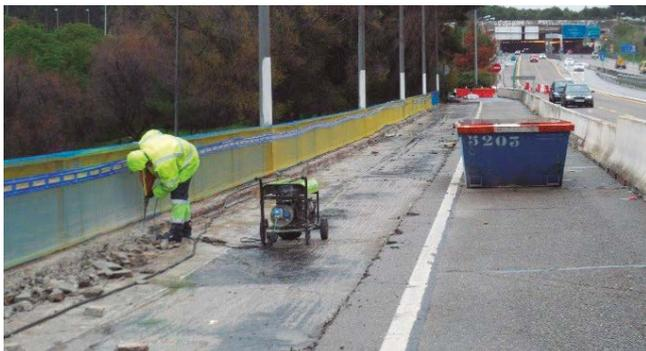
Figura 15. Fresado y demolición de la barandilla existente.
