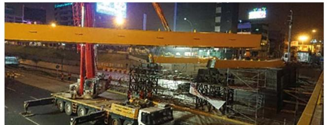
Figura 13. Izado de viga (Junín).
