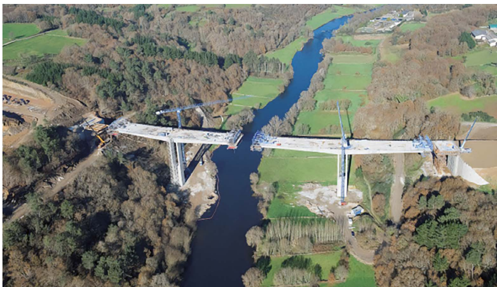
Figura 18. Imagen durante la construcción.
