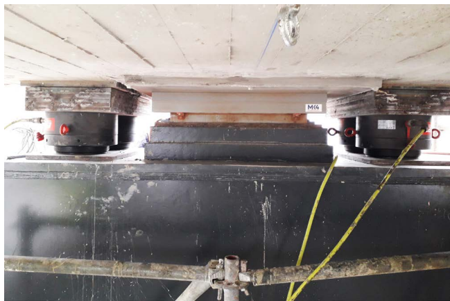
Figura 29. Gatos y aparato de apoyo para la fase de transferencia 2.2.
