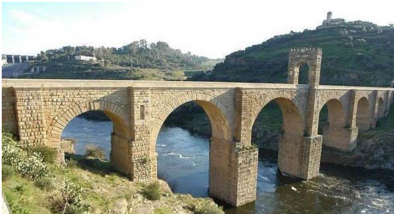
Figura 1. Puente romano de Alcántara.
