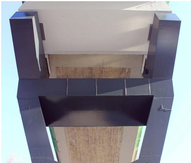
Figura 7. Vista inferior de los voladizos de apoyo.
