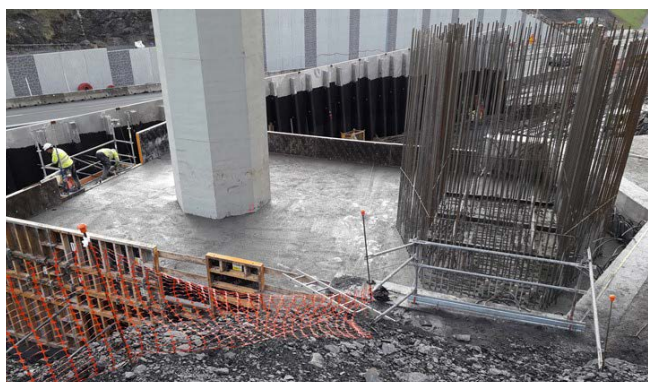
Figura 15. Trabajos de armado y hormigonado de la zapata.
