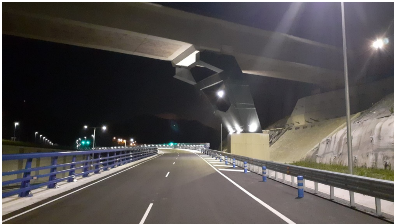
Figura 33. Vista nocturna de la estructura.
