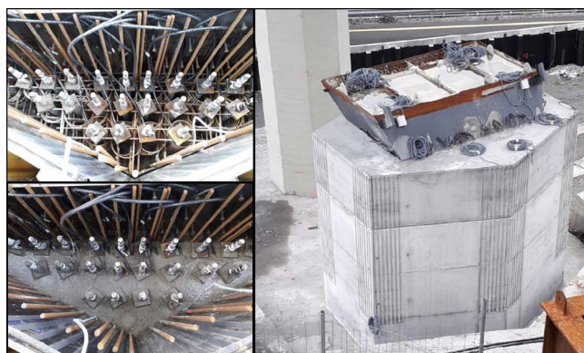
Figura 17. Ejecución de pedestal de hormigón.
