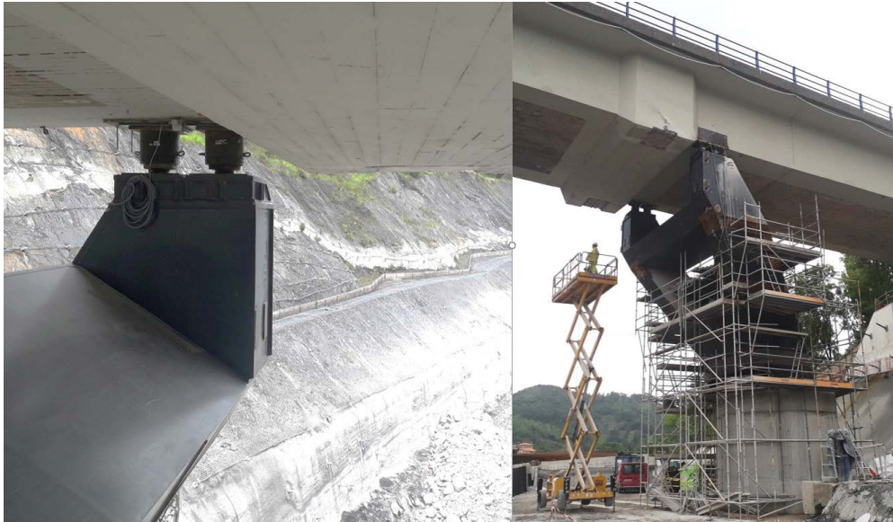
Figura 25. Situación provisional de apeo en Fase 1 previa a la instalación de la dovela 5.
