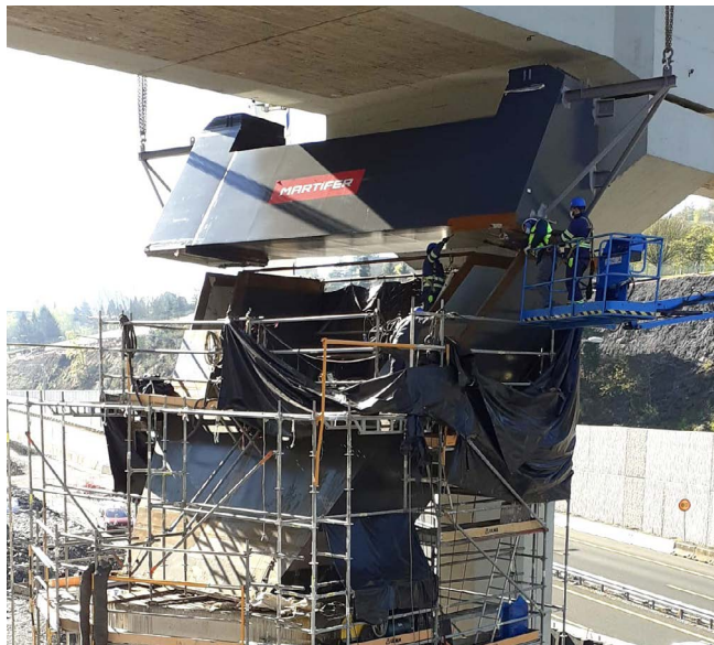
Figura 19. Montaje de dovela 4.
