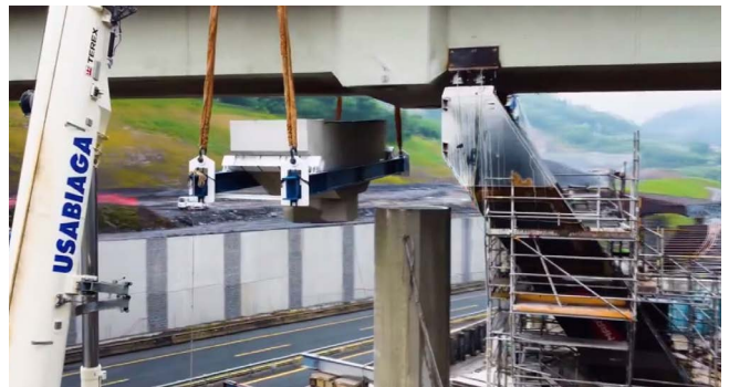
Figura 24. Retirada del dintel de la pila original.
