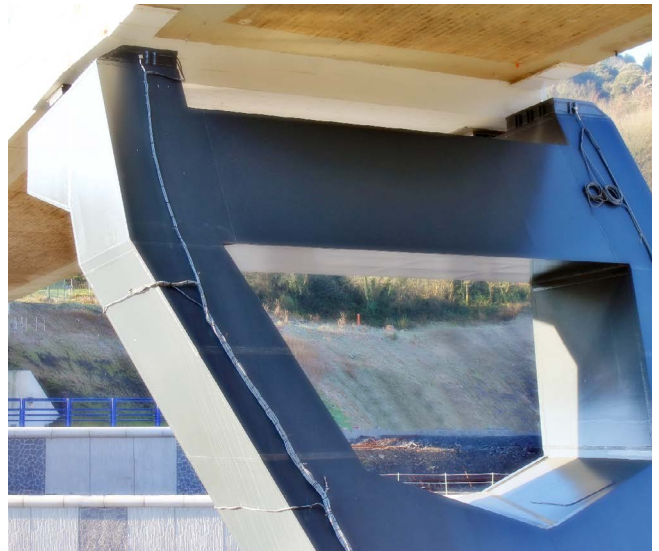
Figura 8. Detalle de encuentro de chapas.
