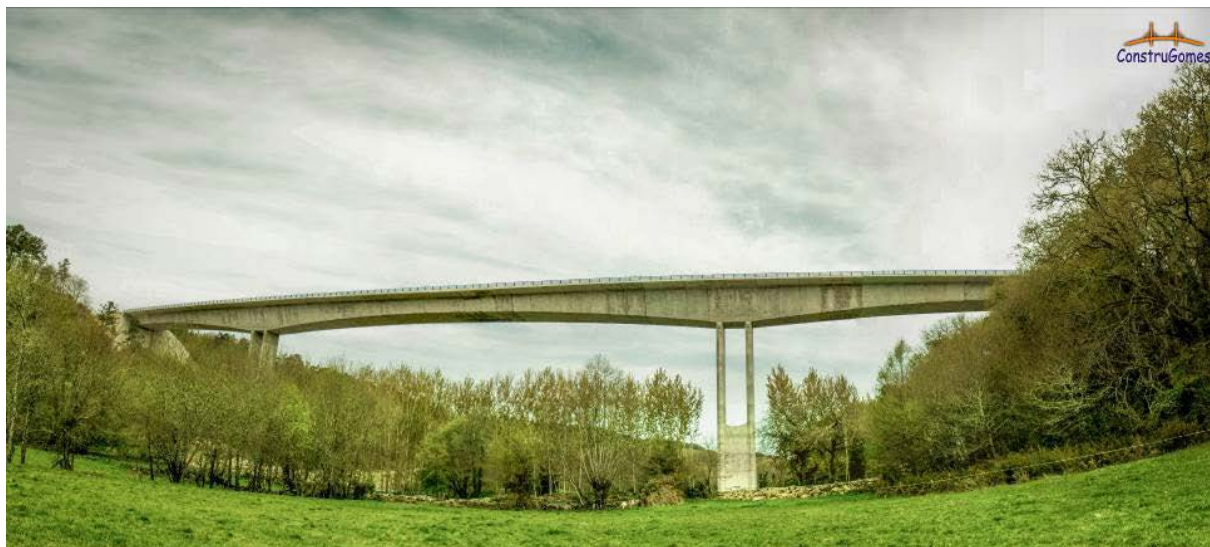
Figura 7. Vista de la obra terminada.
