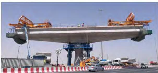
Figura 4. Alzado y sección sobre apoyos del 3span. Colocación de dovelas prefabricadas mediante ejecución por voladizos.
