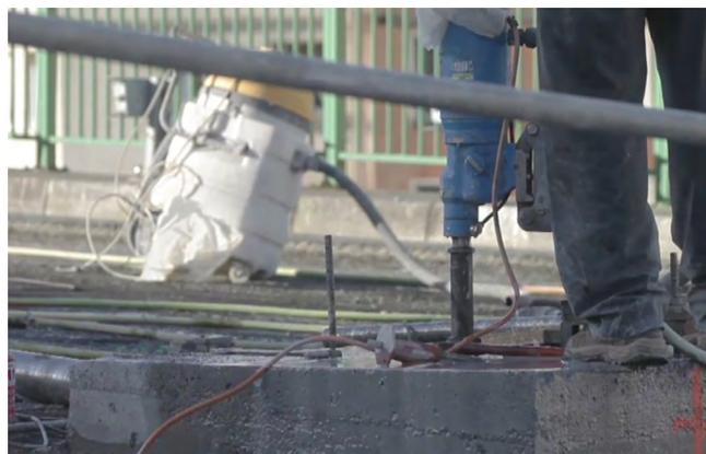
Figura 18. Perforación de orificios en el tablero para enfielar las barras Dywidag.
