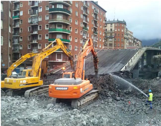
Figura 11. Equipo de demolición mecánica.
