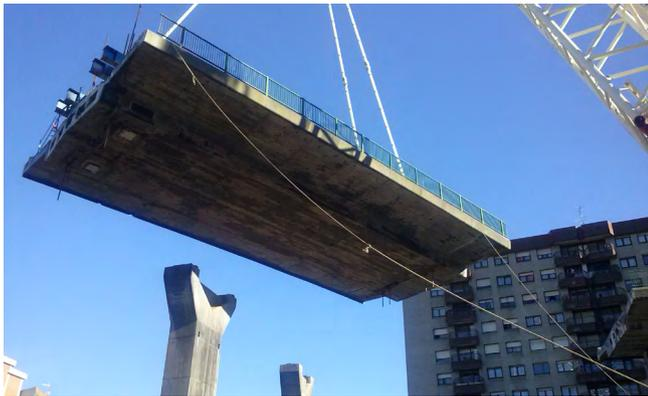
Figura 21. Desplazamiento de tramo de tablero tras su separación del resto de estructura.
