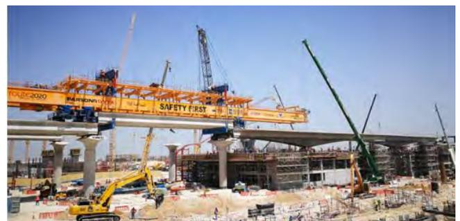
Figura 3. Proceso constructivo con viga lanzadora.
