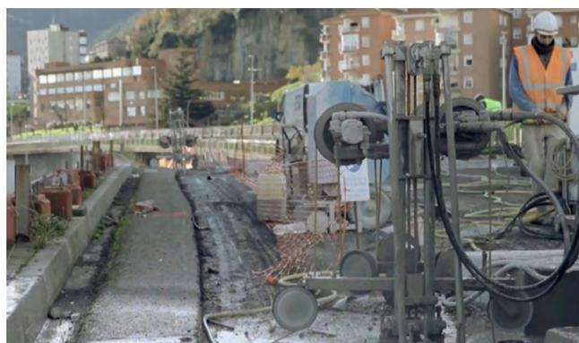
Figura 20. Corte con hilo diamantado.
