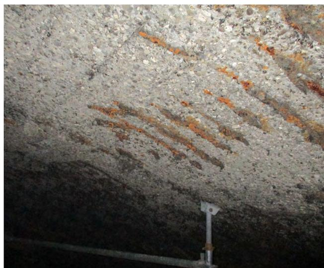
Figura 1. Ataque ácido en bóveda de digestor.
