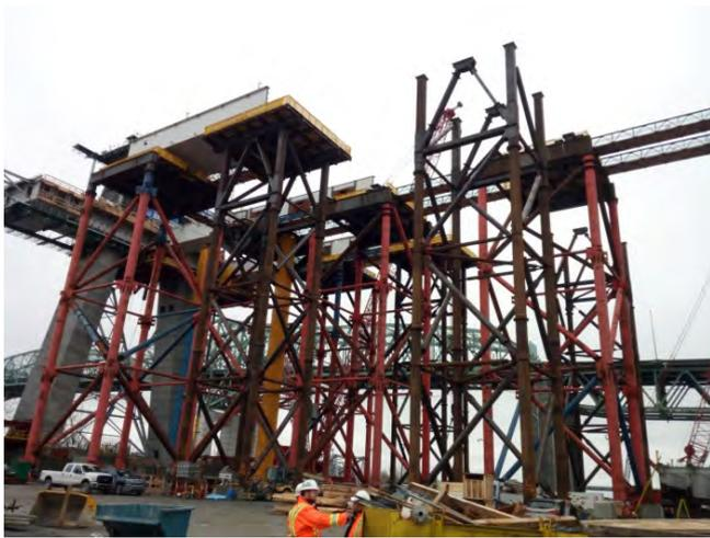
Figura 7. Montaje de las torres e izado de los primeros tramos del Back Span.
