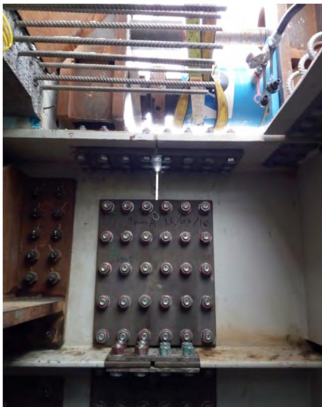
Figura 19. Unión atornillada entre dovelas después de la corrección con los dispositivos de ensamblaje.
