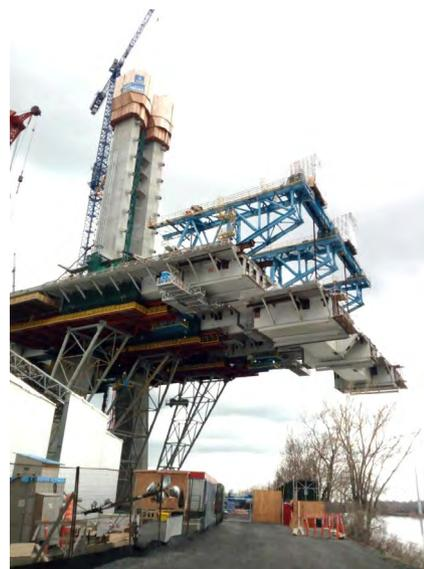
Figura 12. Delta Frame y avance en voladizos del Main Span mediante carro de izado.
