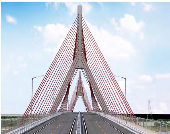
Figura 15. Imagen del atirantamiento visto desde la calzada.
