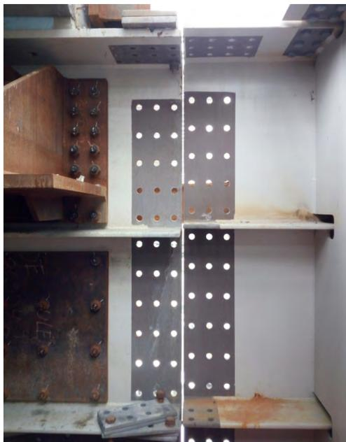
Figura 17. Desalineación entre dovelas.
