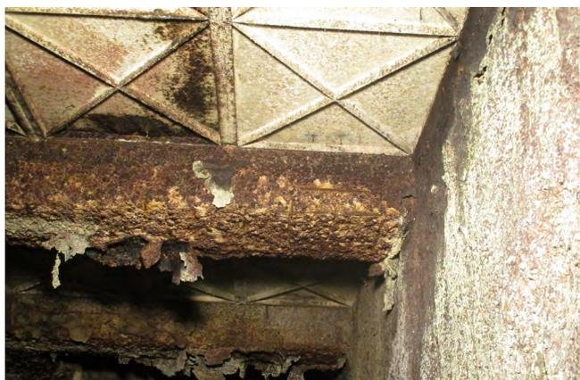
Figura 5. Degradación por ataque ácido en pozo.
