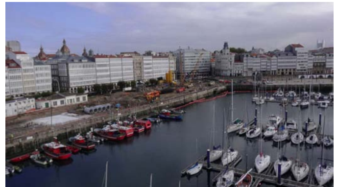
Vista general de las obras
