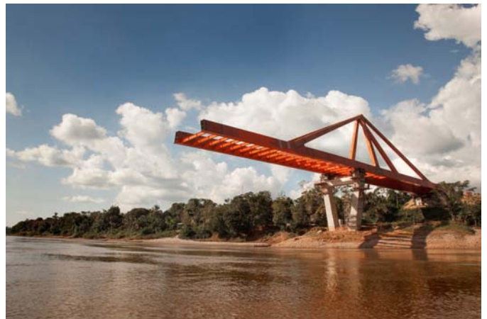
Lanzamiento de la estructura metálica del puente
