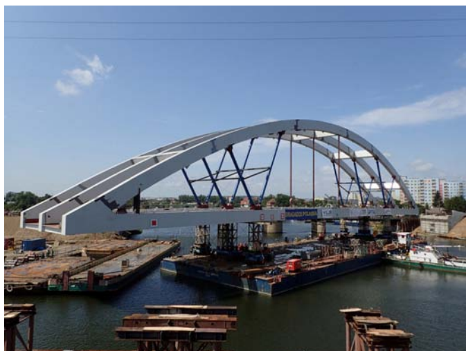
Colocación del arco
