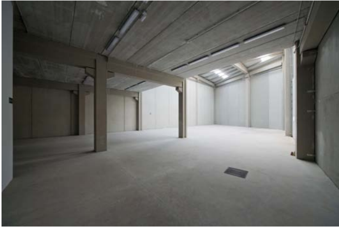
Estructura prefabricada de hormigón
