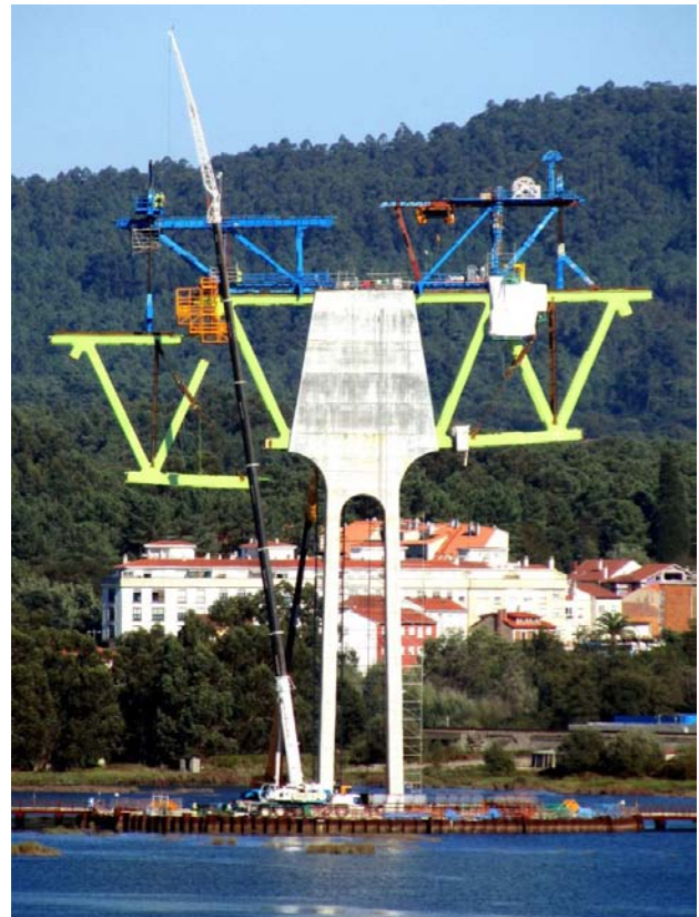
Pórticos para izado de dovelas en la construcción del Puente sobre el Río Ulla
