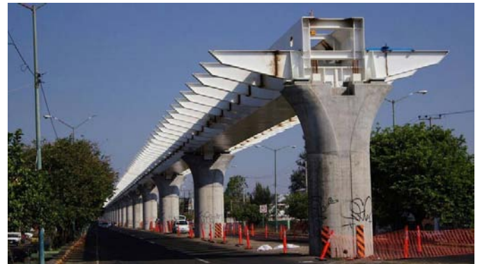
Vista general de tramos isostáticos
