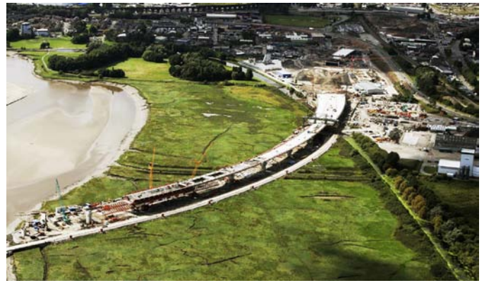
Viaducto norte de aproximación en construcción
