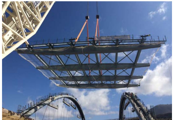
Fase de colocación del tablero
