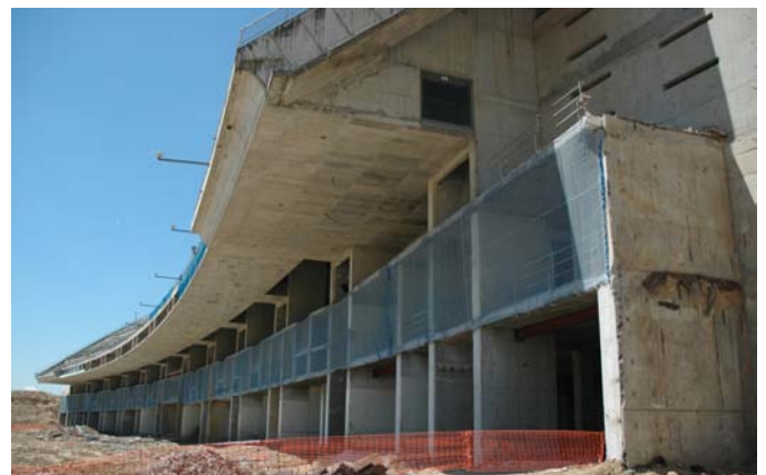
Vista frontal del edificio existente con el graderío bajo demolido
