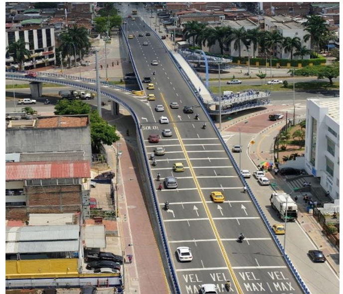
Puente aislado sísmicamente con neoprenos de núcleo de plomo
