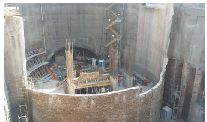
Estación Inés de Suárez. Demolición parcial del manto
