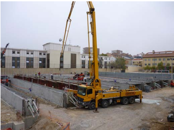
Figura 1. Ejecución vigas cubierta polideportivo
