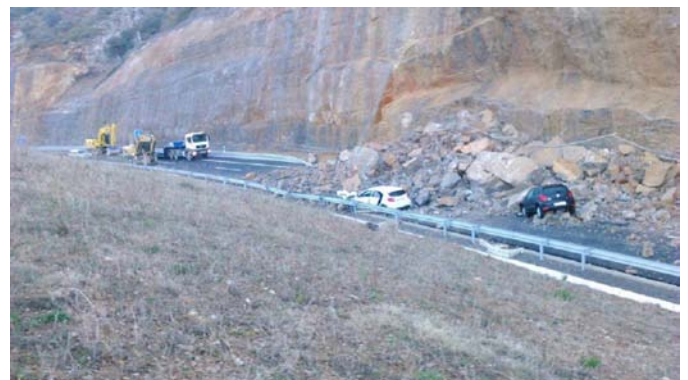
Situación de la calzada tras el desprendimiento
