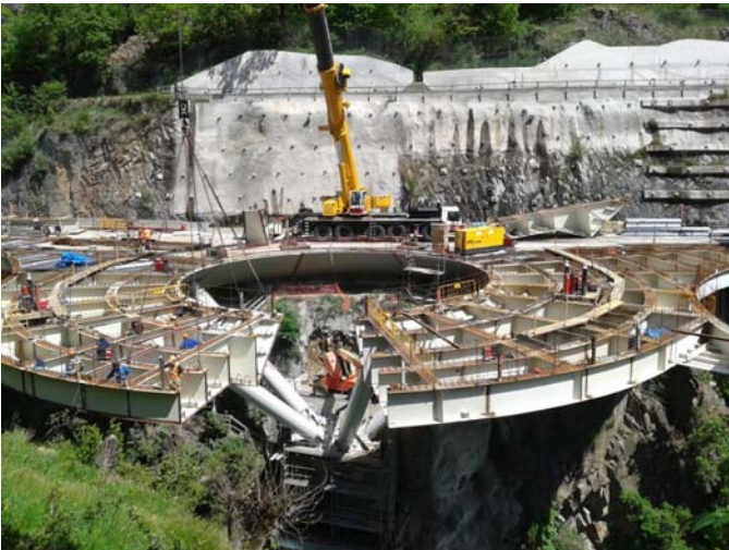
Figura 2. Puente en construcción
