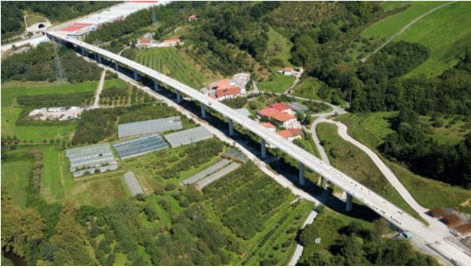
Vista aérea del Viaducto de Urumea
