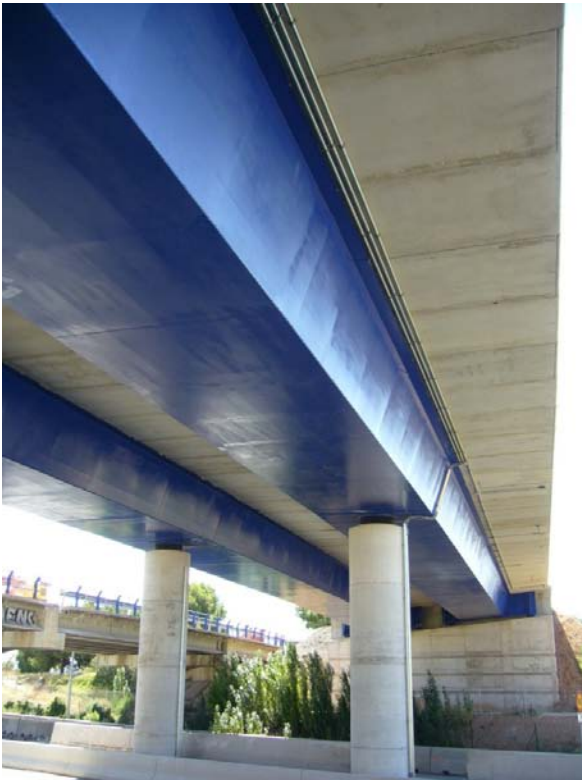
Vista inferior del puente sobre la A-3
