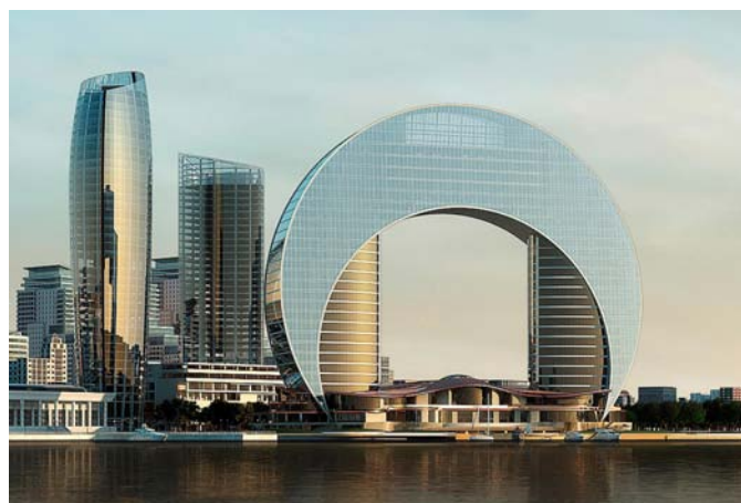
Recreación mediante fotorealismo de la situación del edificio una vez concluido
