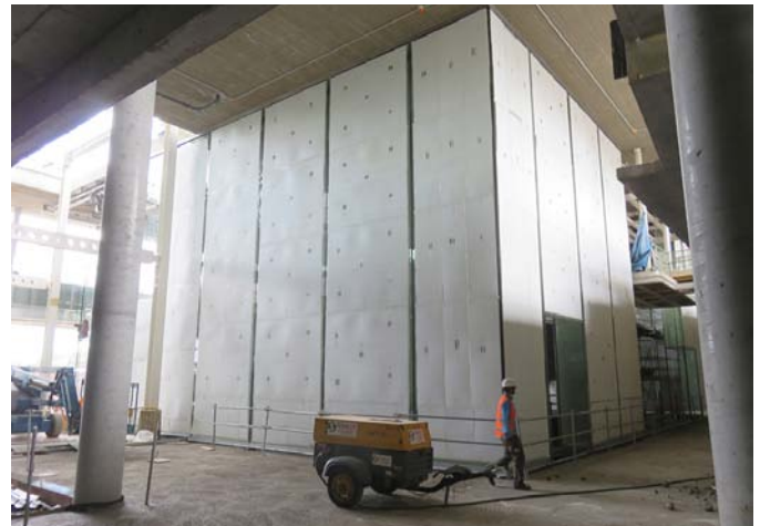
Figura 1. Vista desde el interior con elementos de protección
