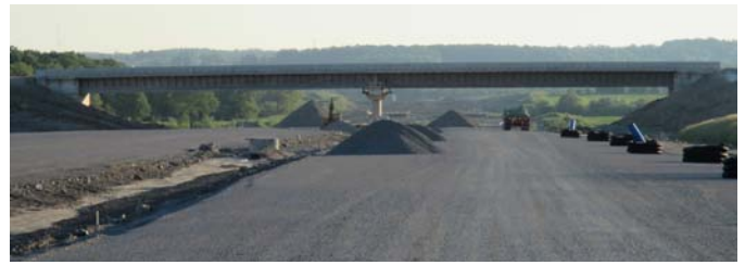
Estructura M-19 en construcción
