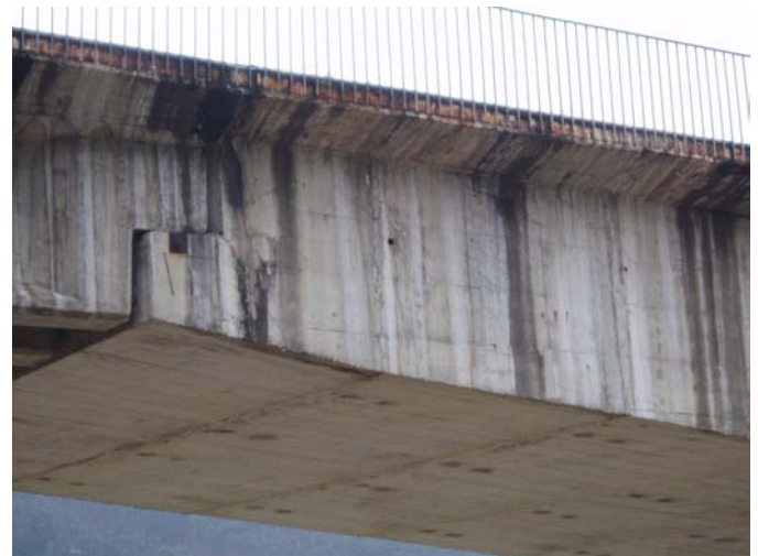
Ménsula corta en un puente en Galicia
