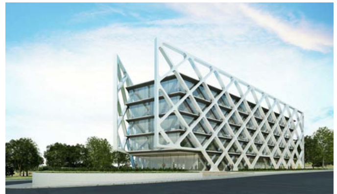
Exterior del edificio y vista de las celosías portantes por fuera de su fachada
