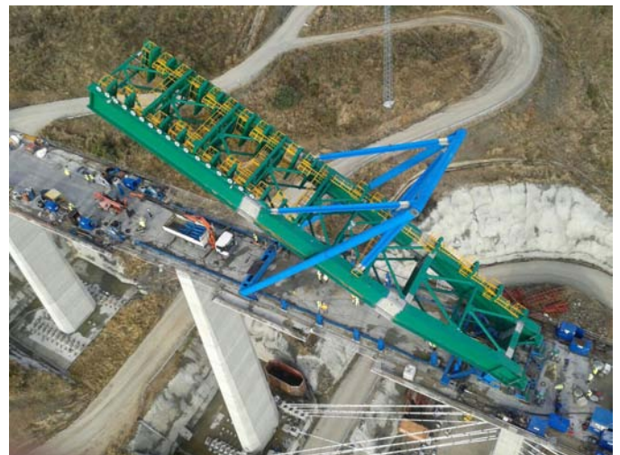
Montaje de la torre provisional
