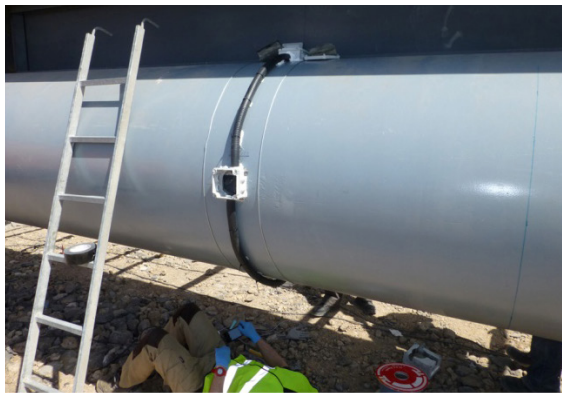
Figura 1. Instrumentación de secciones de tubos
