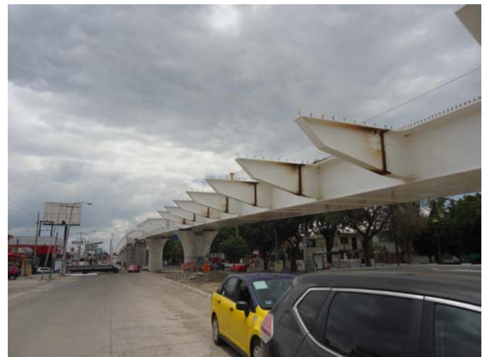
Vista general de tramos continuos
