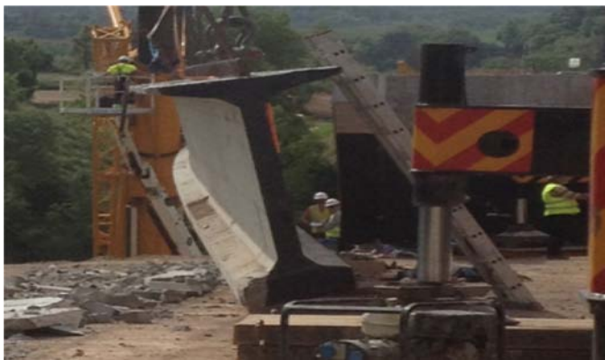
Figura 1. Configuración deformada de la viga en fase de izado
