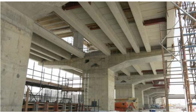
Al Wakra. Vista de la pila por encima de la cual se desarrolla el forjado y el pórtico transversal
