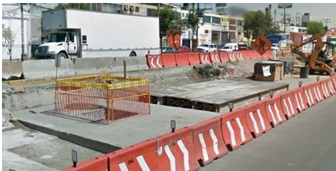
Cimentación tipo cáliz para las pilas prefabricadas
