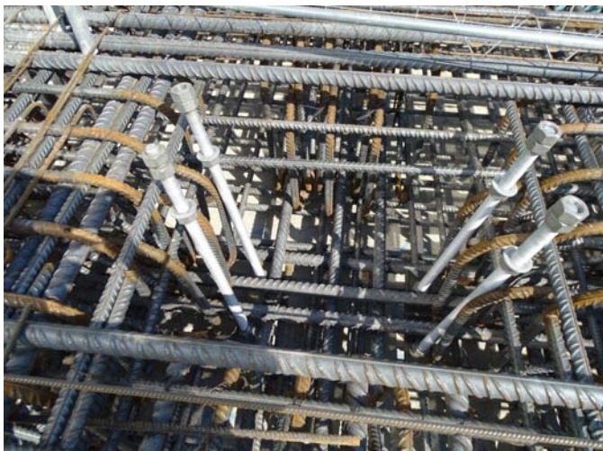
Detalle en obra de conexión con llave de cortante
