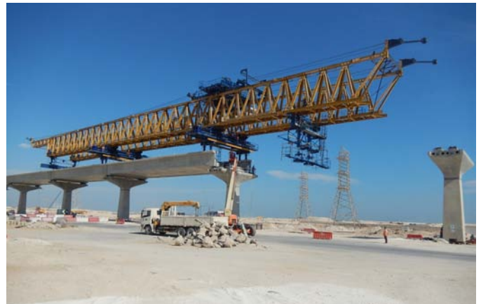
Viga de lanzamiento avanzando
