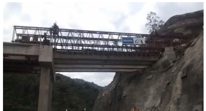
Cimbra autoportante para hormigonado de vigas
