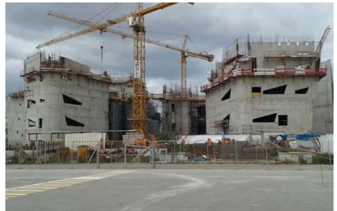
Avance de las obras (vista del exterior)
