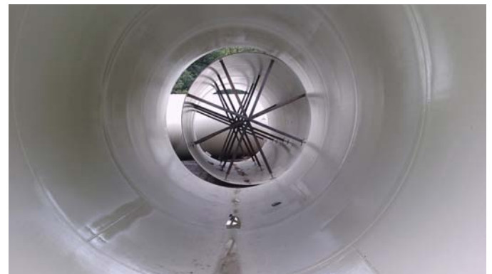
Figura 1. Tubería metálica de Renace II. Arañas de rigidización provisional durante el transporte
