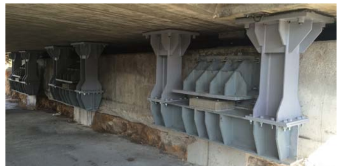
Topes antilevantamiento en estribos
