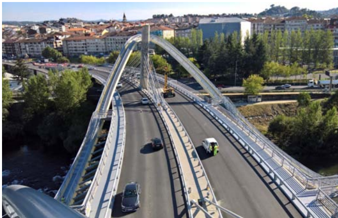
Vista general de los trabajos
