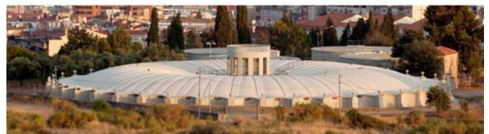
Estado inicial y final. Vista exterior
