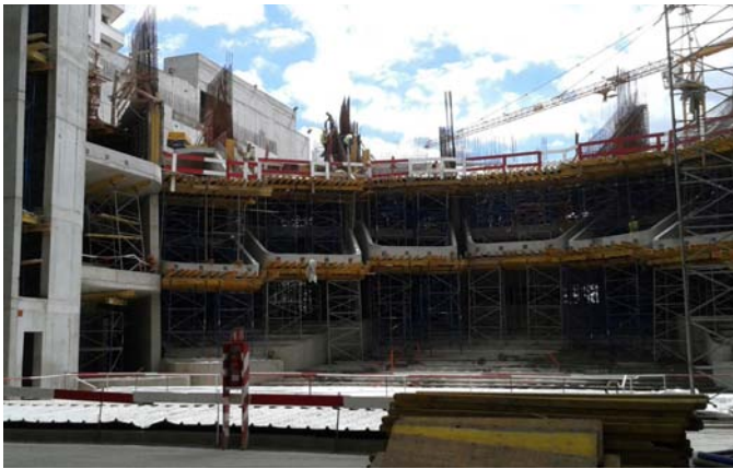
Avance de las obras (vista de los balcones del Gran Teatro)
