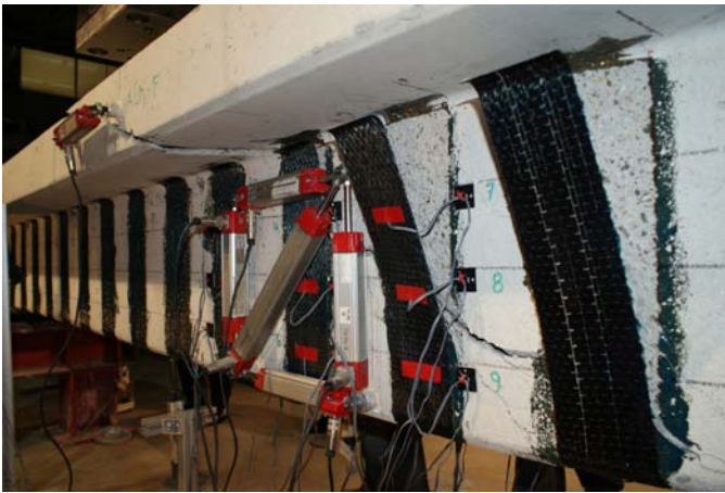
Figura 1. Desprendimiento prematuro del refuerzo externo a cortante con PRF
