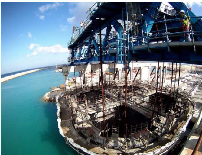
Puente grúa de 4.000 t de capacidad empleado en la construcción del Port de Tanger Mediterranee (II)
