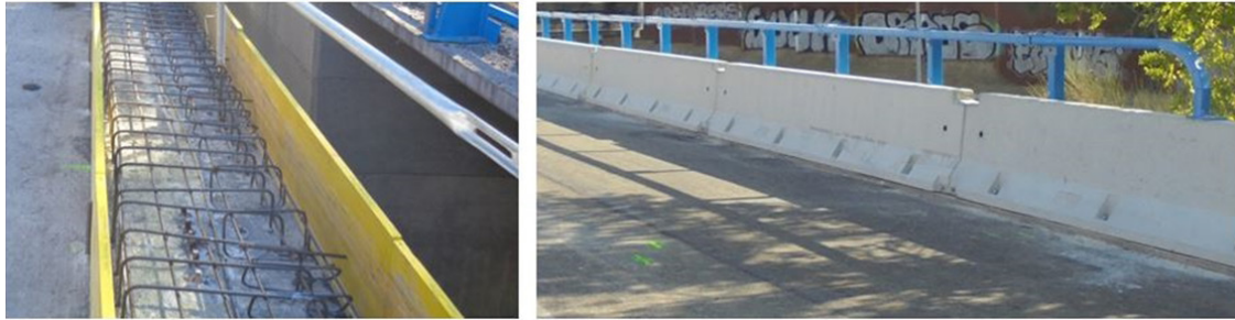
Sustitución de pretel H4b de hormigón anclado químicamente
