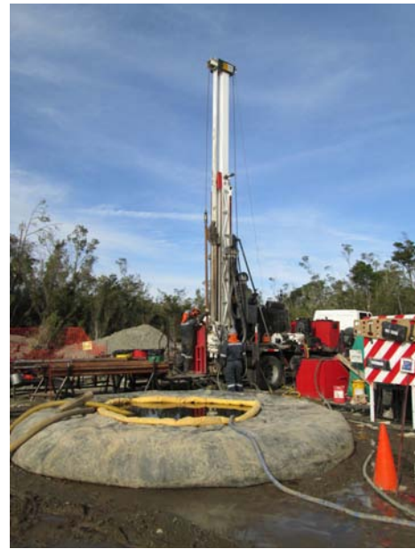
Trabajos de ingeniería básica
