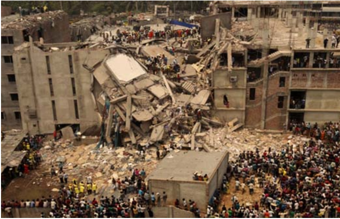
Colapso estructural del Edificio Rana Plaza en Dacca, Bangladesh
