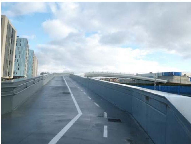
Acceso a la pasarela desde la rampa noroeste
