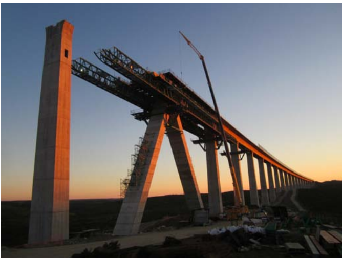
Cimbra autolanzable al paso sobre la pila delta durante la construcción del tablero
