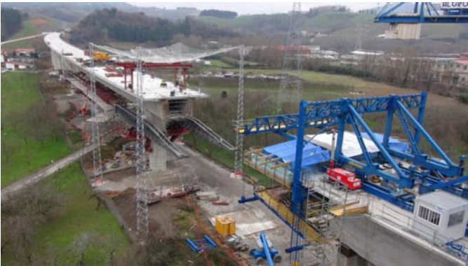
Construcción del Viaducto de Urumea: autocimbra y carro de avance
