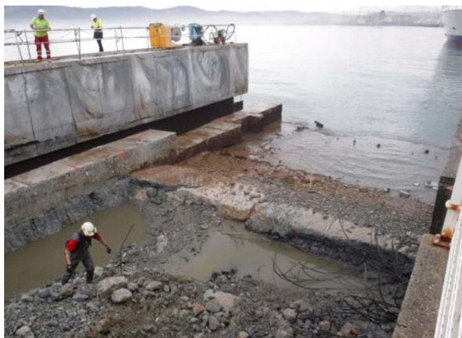
Figura 1. Demoliciones realizadas, corte con hilo de diamante, muro trasero
