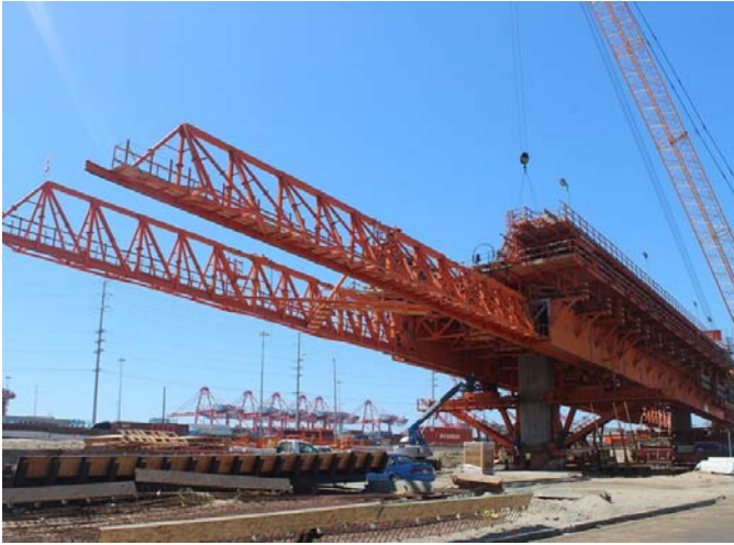
Cimbra autolanzable en viaductos de aproximación
