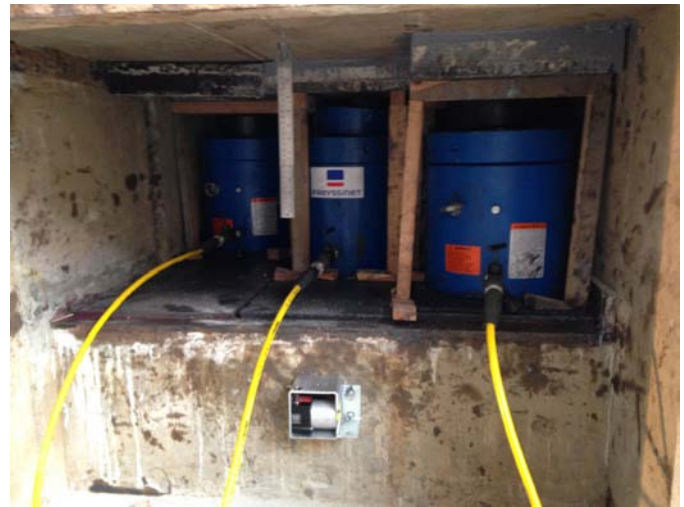
Gatos hidráulicos para la maniobra heavy - lifting
