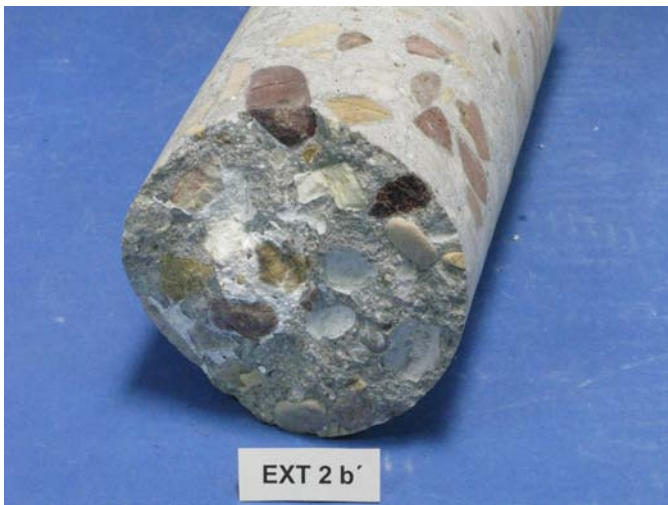
Depósitos blancos en la superficie de fractura
