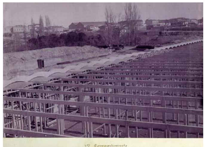
Vista del depósito durante la construcción
