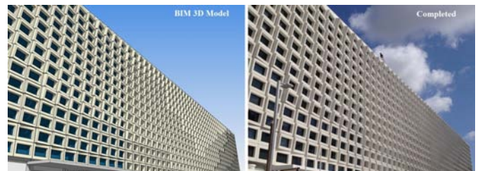
Fachada en prefabricado de hormigón: del proyecto BIM a la realidad
