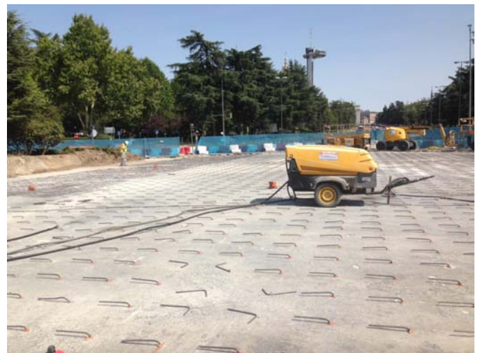
Barras ancladas para recrecido superior de losa existente
