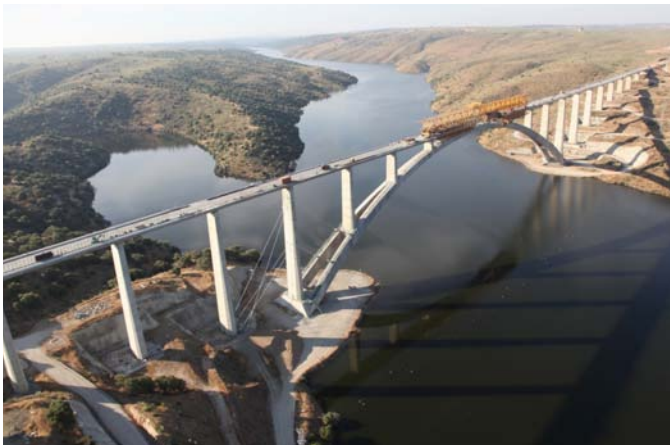
Vista general durante la construcción del arco
