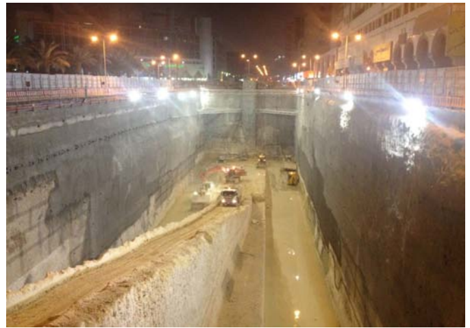
Excavación parcial con sostenimiento del propio terreno
