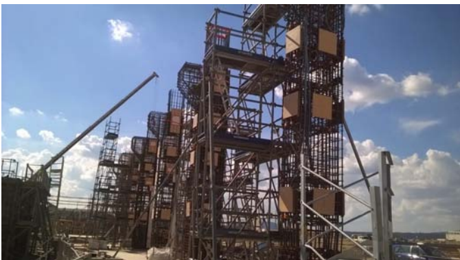
Pilares ferrallados y montados, preparados para su encofrado y hormigonado
