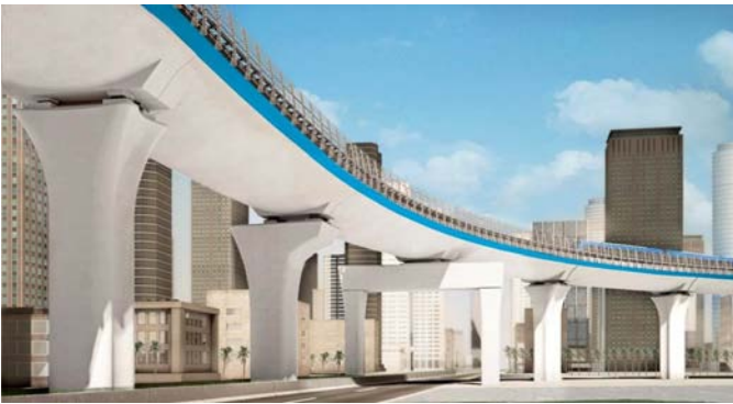
Recreación mediante foto-realismo del viaducto una vez concluido
