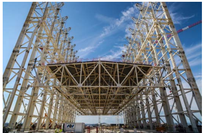
Operación de izado en marcha
