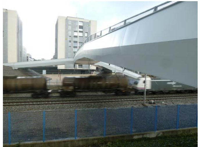
Vano principal sobre el ferrocarril, y vanos extremos en rampa y escalera
