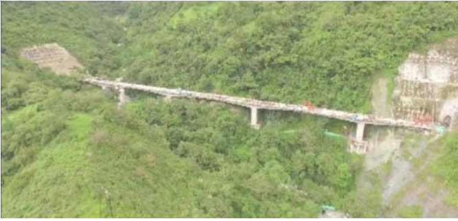
Vista general del puente
