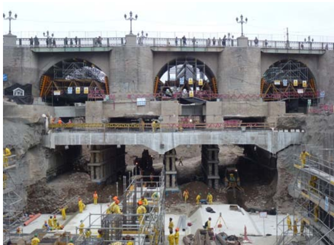
Puente Trujillo apeado sobre micropilotes
