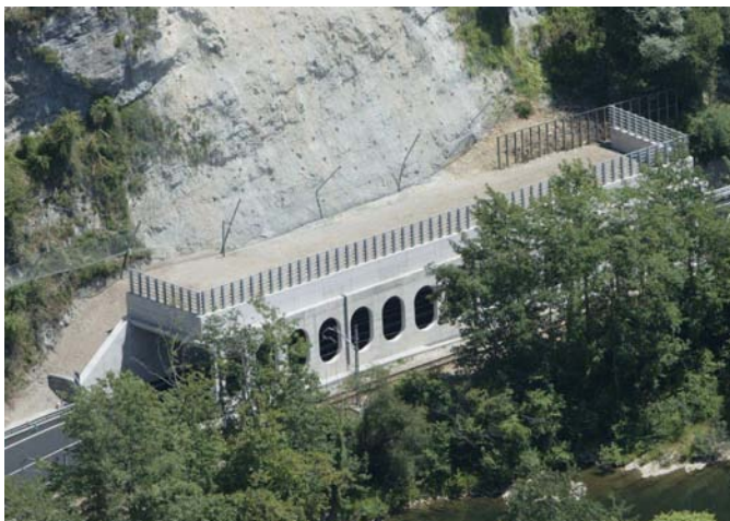
Vista aérea de la galería con el lecho amortiguador superior
