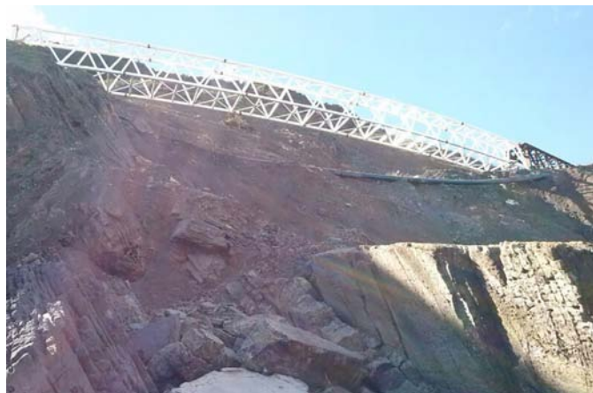
Figura 1. Acantilados de El Tranqueru. Proceso de empuje de la pasarela
