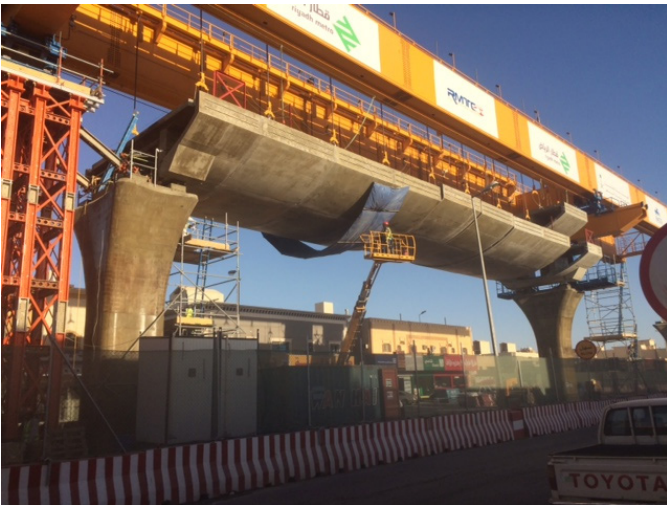
Erección de los vanos mediante viga de lanzamiento
