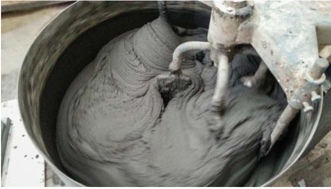
Hormigón de muy altas prestaciones
