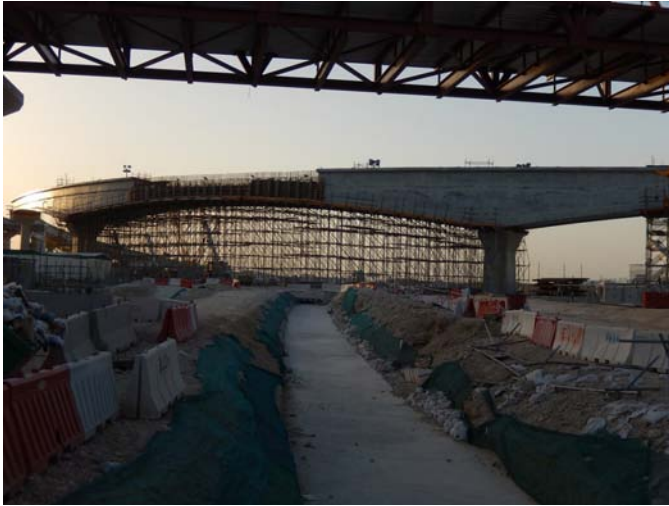
Puente continuo de canto variable ejecutado in situ. Cimbrado de la fase central
