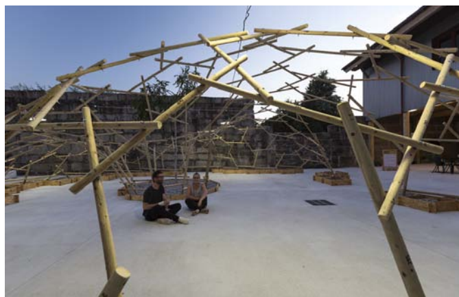
Detalle de la estructura
