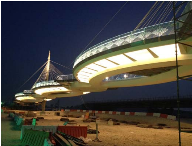
Vista lateral de una pasarela
