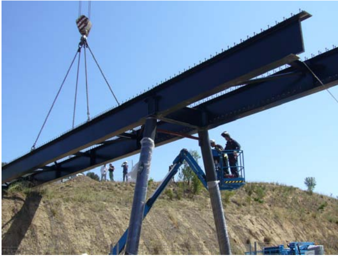
Detalle del montaje en obra de tramos sobre pilas tubulares
