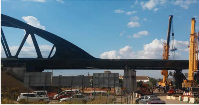
Viaducto de A45 durante el proceso de empuje
