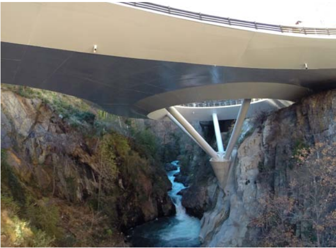
Figura 1. Vista inferior del puente
