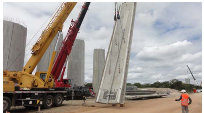
Segmento durante el premontaje
