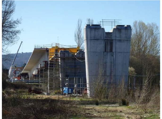
Vista lateral en fase inicial de empuje
