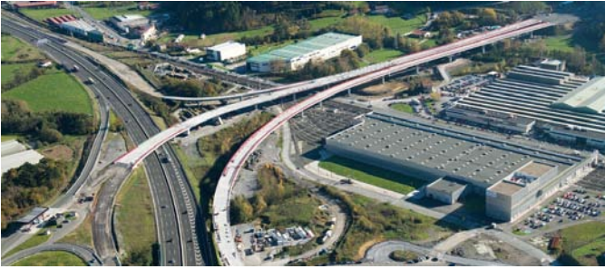
Vista general de los viaductos mixtos del enlace de Gerendiaga (Vizcaya)
