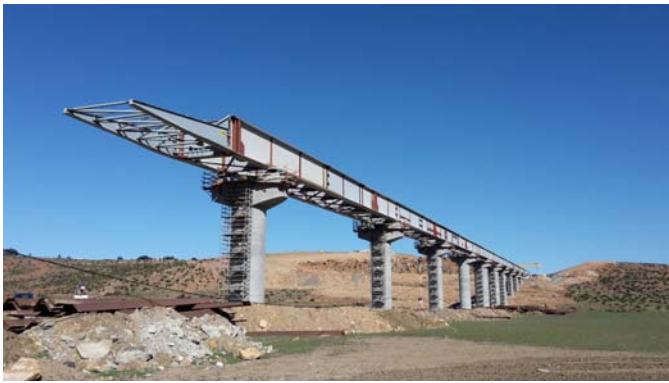
Vista General del tramo Norte
