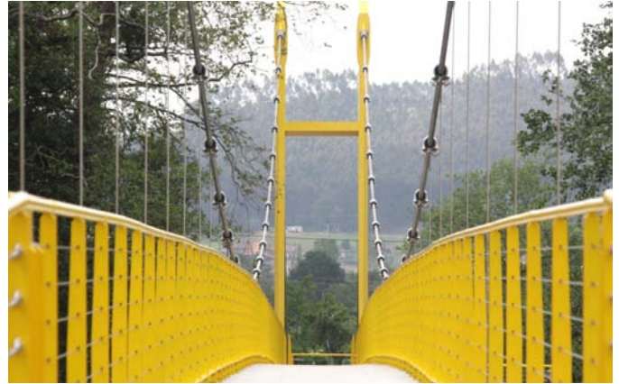
Vista longitudinal desde el interior y péndolas de cuelgue
