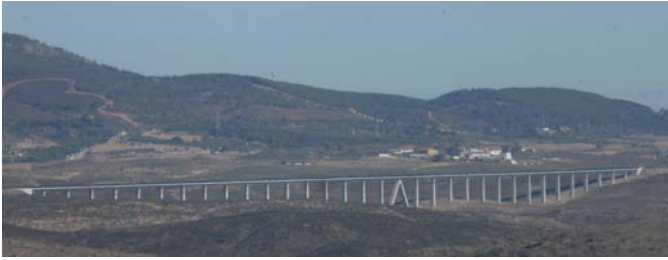
Vista panorámica del Viaducto sobre el arroyo de Valdegravieso
