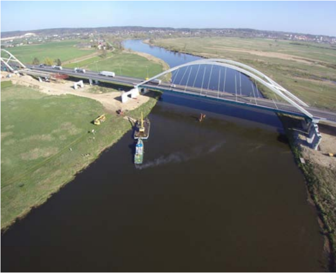
Vista del lugar de construcción
