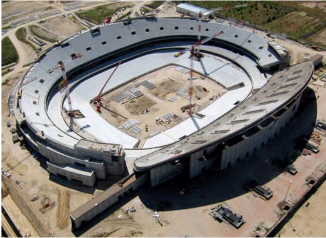
Finalización de la estructura de la ampliación del estadio
