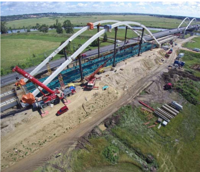
Montaje de la estructura metálica
