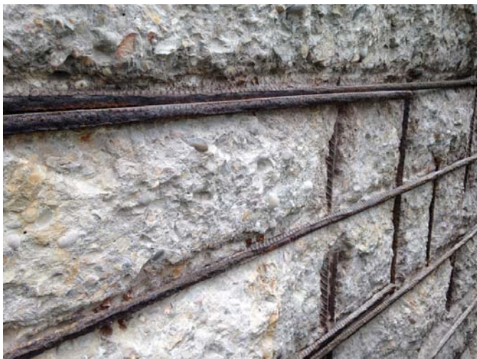
Detalle de armaduras
