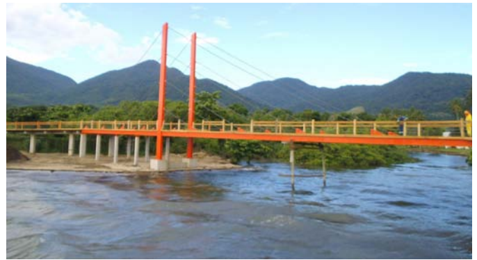
Pasarela de Ilhabela en la fase final de las obras
