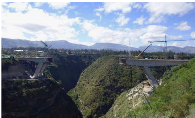
Pilas en V terminadas y avance en voladizo
