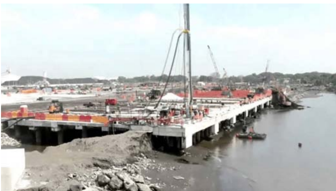
Vista general del muelle de descarga y plataforma de almacenaje de contenedores de Puerto Quetzal
