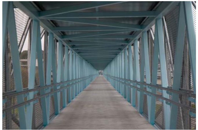
Vista desde el interior de la pasarela
