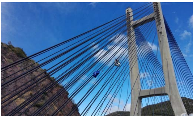
Trabajos de reparación en altura
