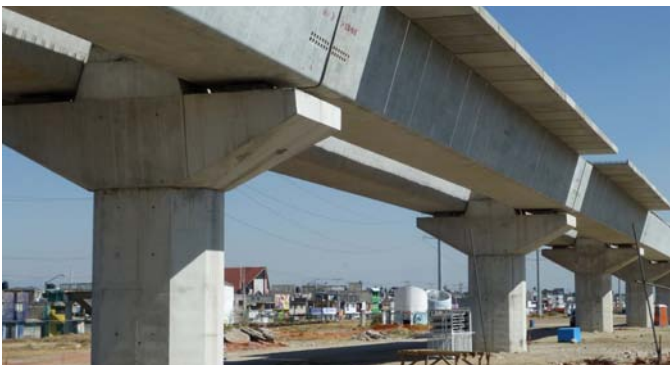
Construcción soluciones prefabricadas
