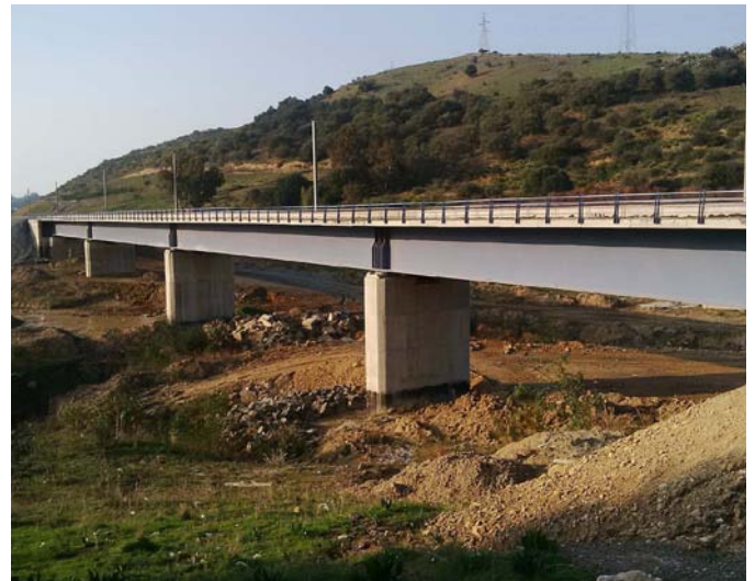
Viaducto de 156m de longitud
