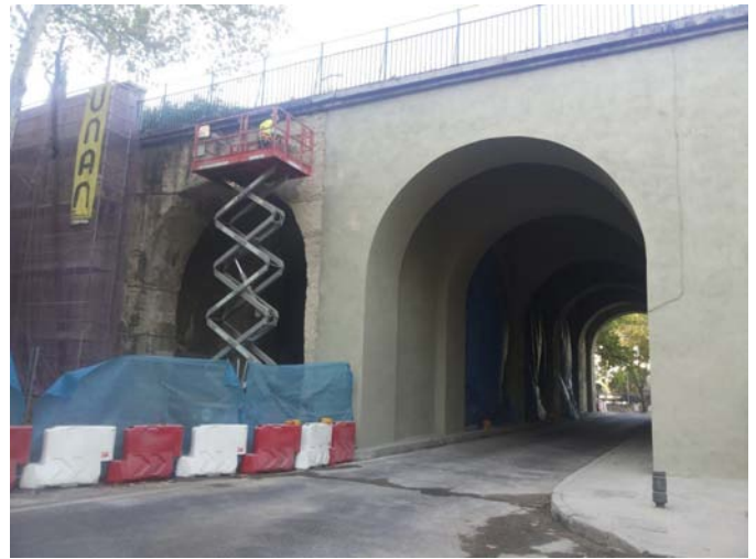
Puente de los 15 Ojos durante el desarrollo de los trabajos de acondicionamiento
