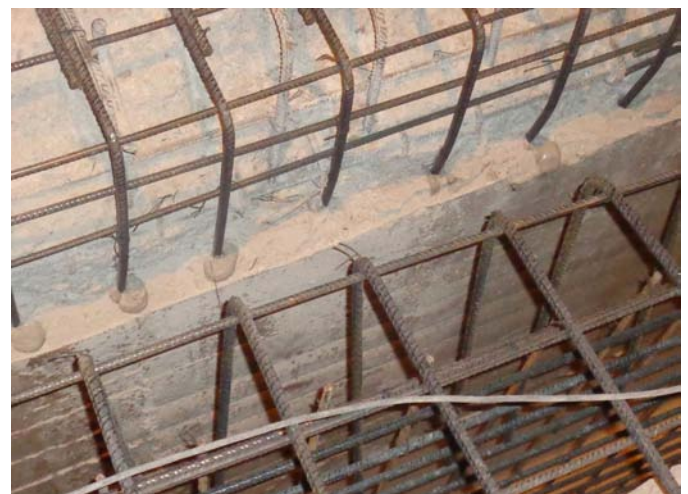
Recrado del estribo para reducción de holgura estructural
