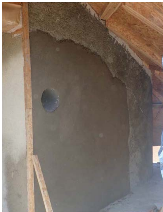
Mortero de revestimiento con arena de mejillón
