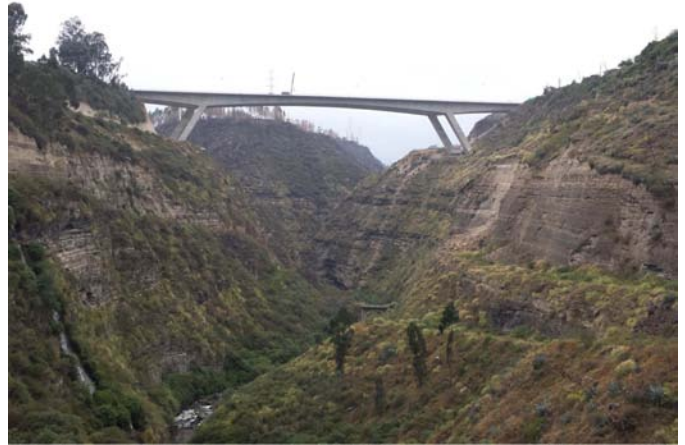
Puente totalmente terminado
