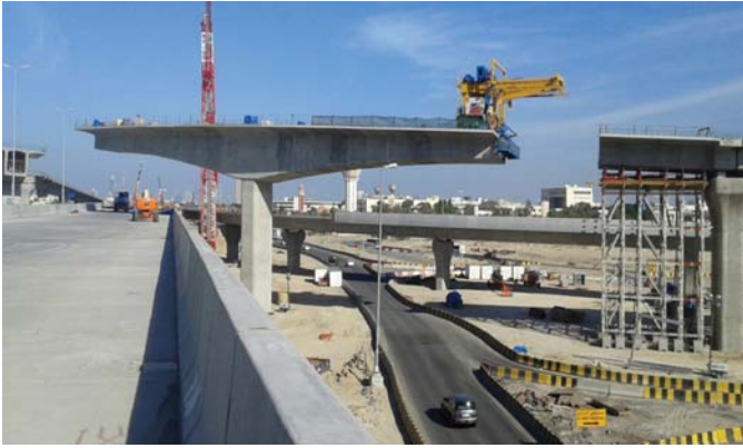
Construcción de una de las rampas por avance en voladizo
