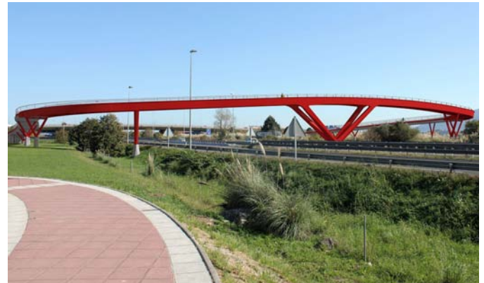
Vista general de la pasarela
