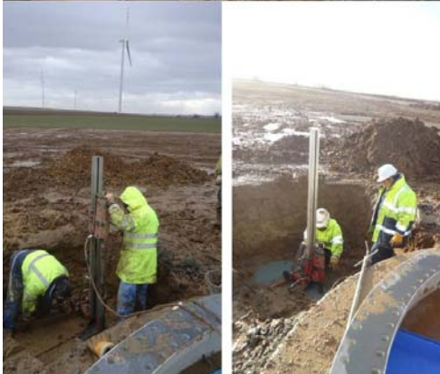
Extracción de probeta testigo de la cimentación de un aerogenerador
