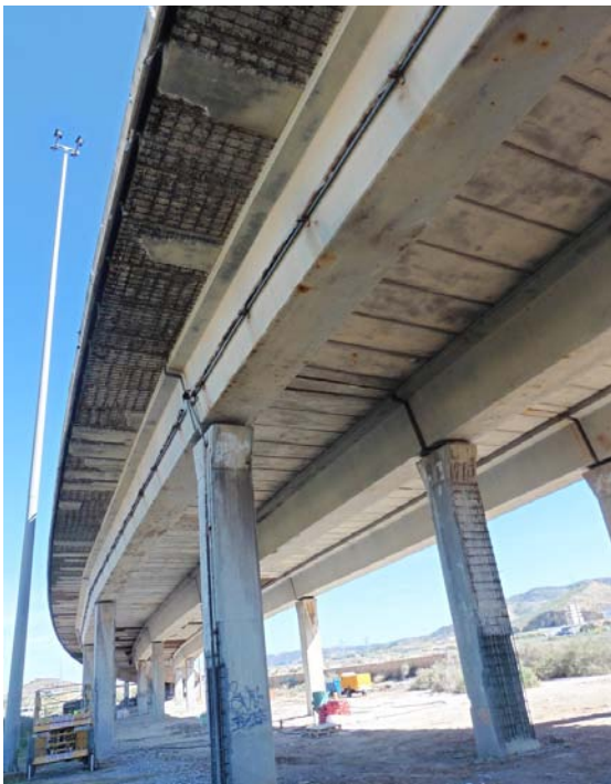
Reparaciones en pilas y losas
