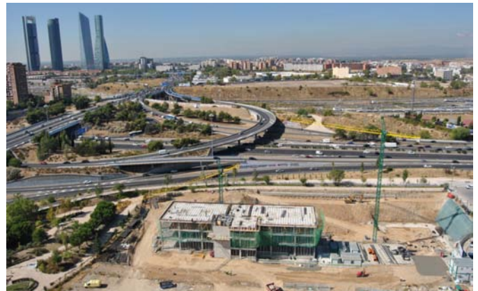
Emplazamiento y evolución de la obra
