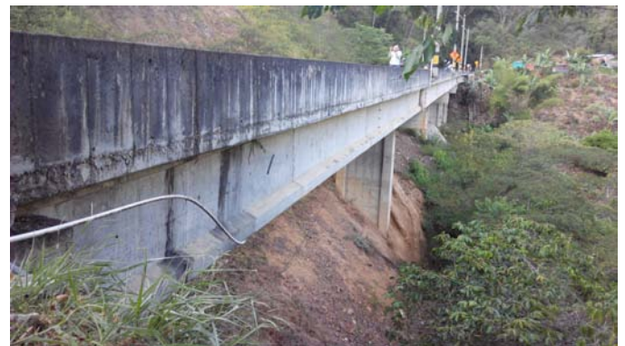
Detalle del emplazamiento a media ladera
