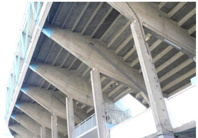
Vista exterior del pórtico existente en hormigón armado
