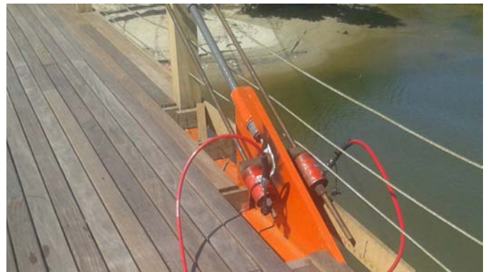
Tesado de barras mediante barras auxiliares
