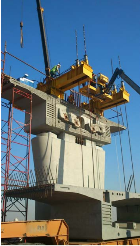
Vista General del izado de las primeras dovelas con clamping
