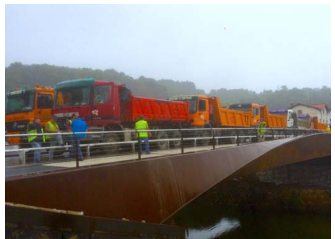
Puente Bicontentio en Martutene. Prueba de carga
