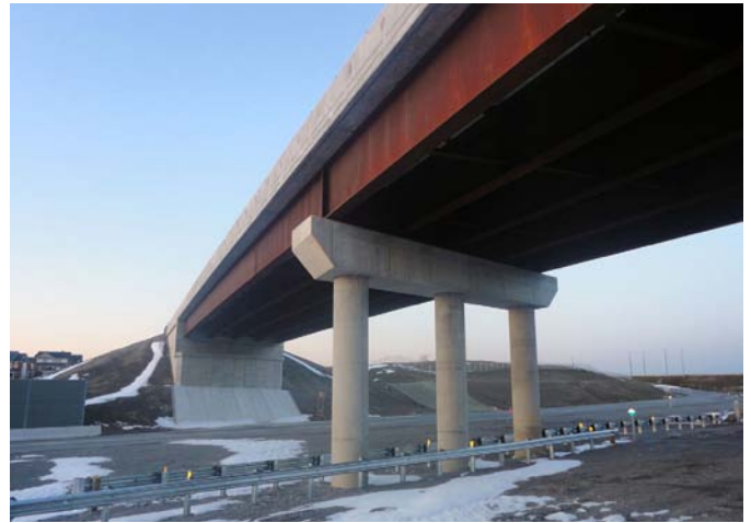
Paso superior de tablero mixto
