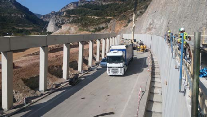
Vista de la galería en construcción
