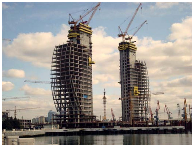
Imagen de la construcción de LA LUNA HOTEL
