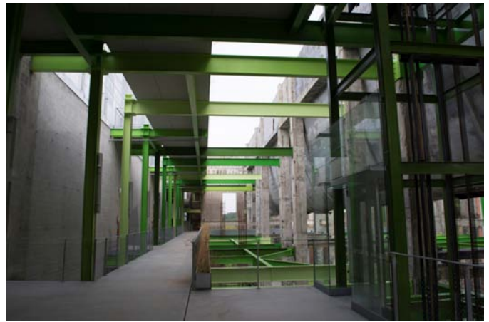
Vista interior del edificio de calderas
