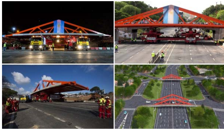
Figura 2. Montaje de los pasos de Beiró I y II con carretones autopropulsados
