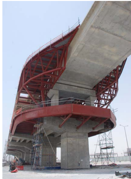
Al Wakra. Vista de la celosía 3D para realizar el voladizo al final de la estación
