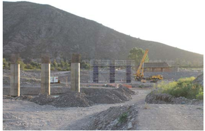
Viaducto de Las Tinajas. Construcción de pilas-pilote
