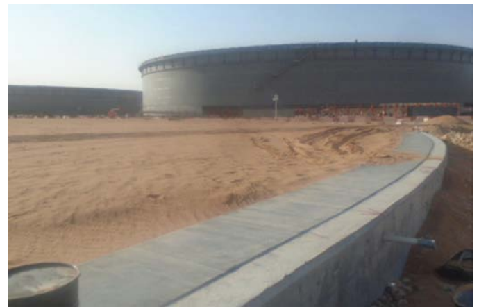
Estructuras en construcción
