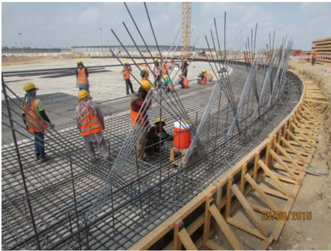
Colocación de cables sísmicos en el anillo de cimentación
