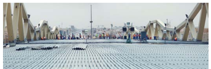
Trabajos de montaje de la chapa de acero nervada
