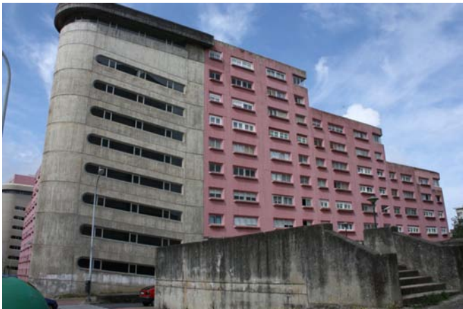
Bloque L6 con la desproporcionada rampa de acceso limitado
