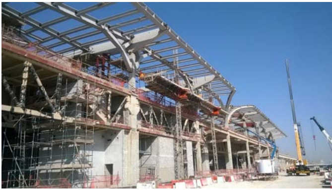
Vista general de la cubierta de estación
