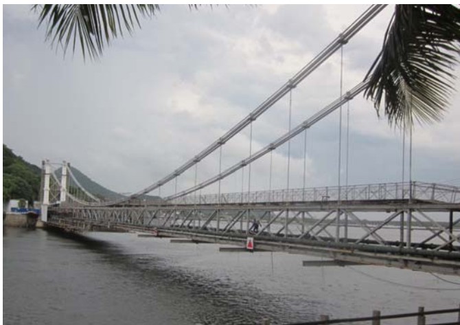
El puente, con las vigas transversales provisionales, antes de la colocación de los cables provisionales
