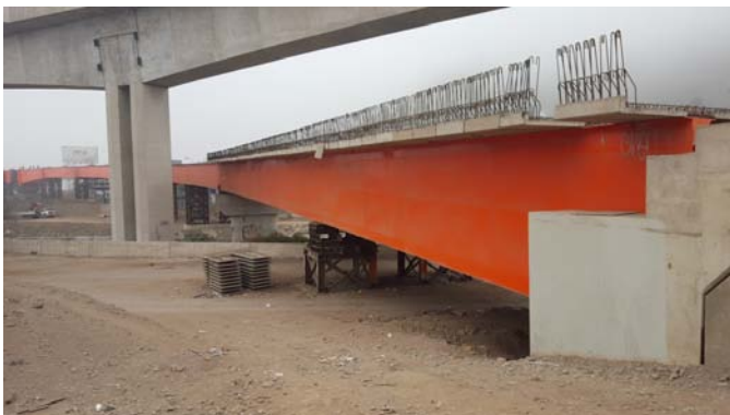
Colocación de prelosas en el último vano, cerca del estribo 2
