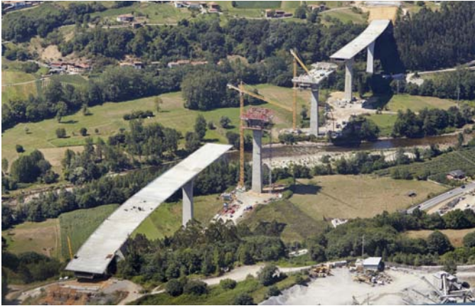
Vista general durante la construcción del Viaducto sobre río Narcea
