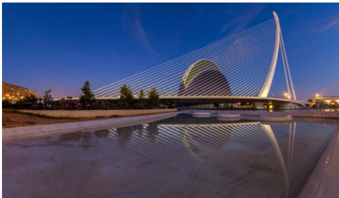
Figura 1. Una de las estructuras analizadas, el Puente de Serrería de S. Calatrava. Imagen: D. Delso
