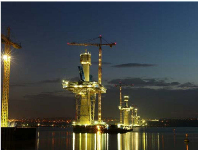
Vista de las tres torres en construcción
