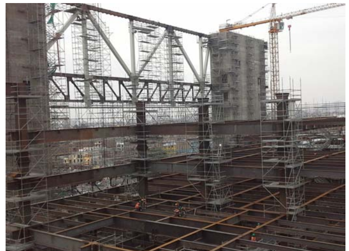
Centro de Convenciones de Lima. Ejecución
