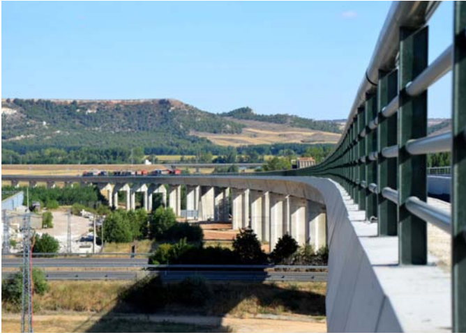
Prueba de carga. Se observan las distintas configuraciones de pilas y otro de los viaductos del nudo
