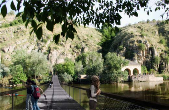
Pasarela banda tesa sobre el río Tajo en Toledo. Vista desde la pasarela
