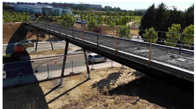
Vista general de la pasarela a falta del hormigón in situ de la losa y acabados
