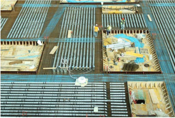
Techo montado/ferrallado previo al hormigonado
