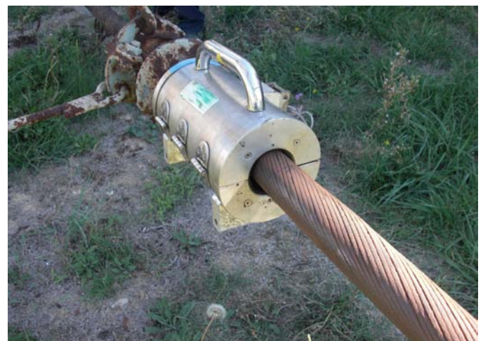
Inspección de cable por equipo magneto-inductivo
