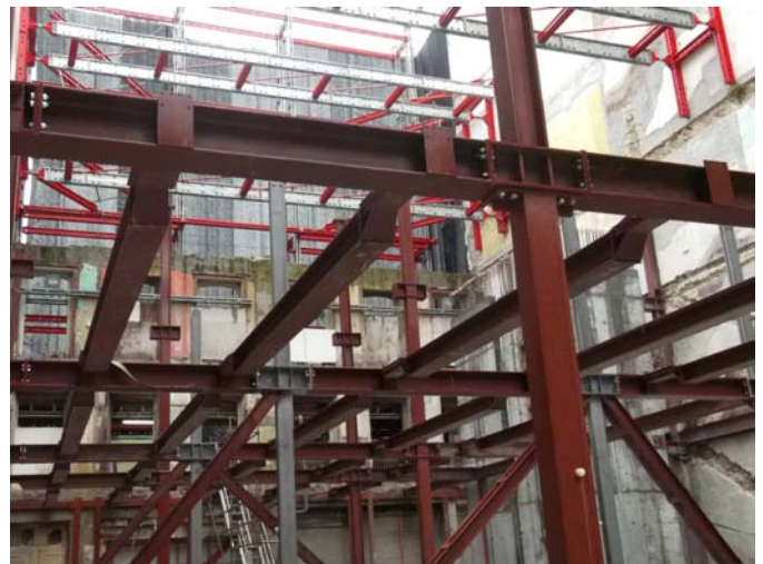
Vista general de la estructura
