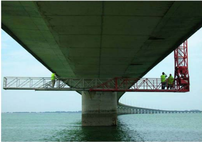
Inspección especial del puente de la Isla de Arosa
