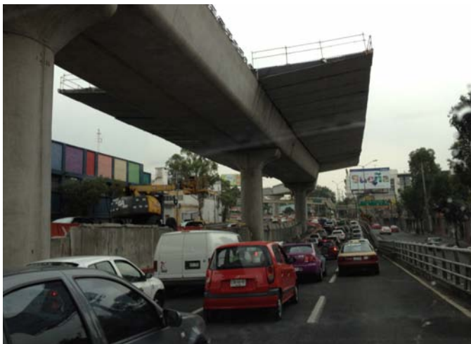
Construcción de la estructura de las autopistas elevadas, Segundos Pisos, Ciudad de México
