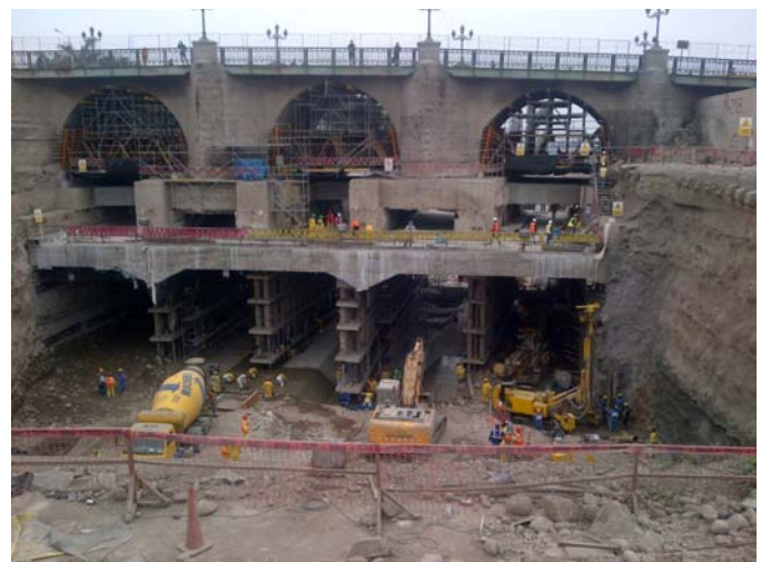
Vista del puente durante los trabajos
