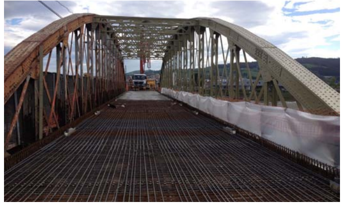
Armadura y trabajos de hormigonado en nueva losa
