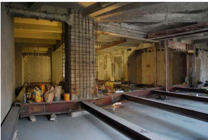
Confinamiento de soporte de hormigón, emparrillado metálico de refuerzo y gateo
