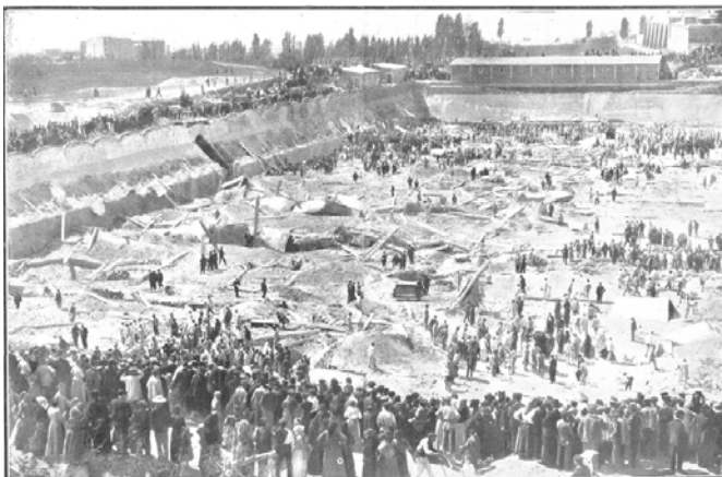
Vista general del hundimiento
