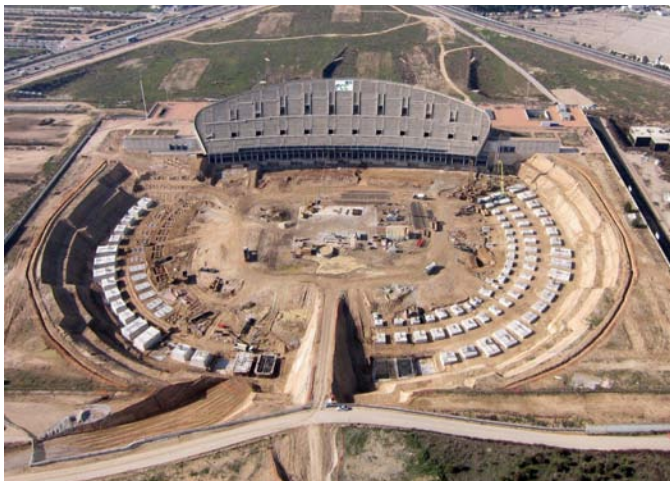
Vista general de cimentación
