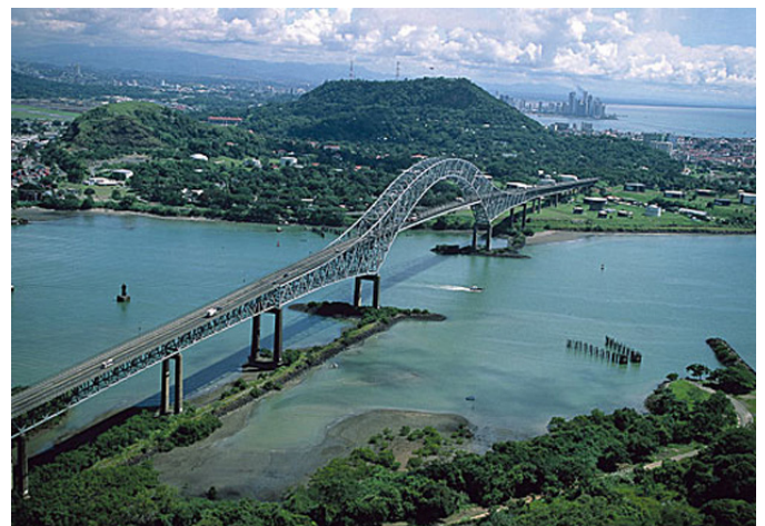
Vista del Puente de las Américas
