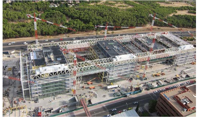
Figura 2. Vista exterior del edificio en construcción
