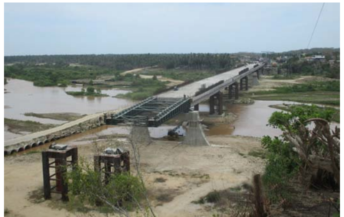
Figura 2. Empuje del tablero
