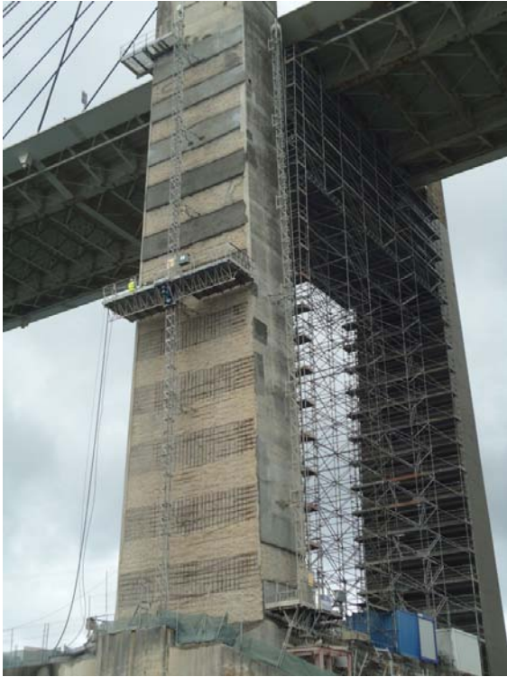
Vista de la pila norte durante los trabajos
