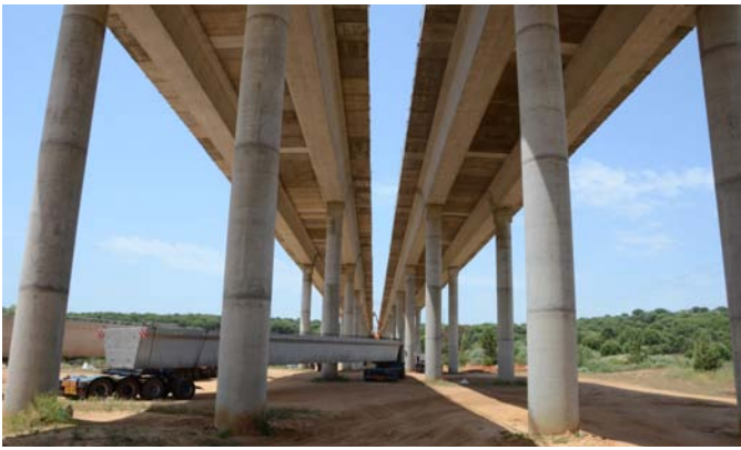
A26. Autoestrada do Baixo Alentejo. Puente sobre el río Sado
