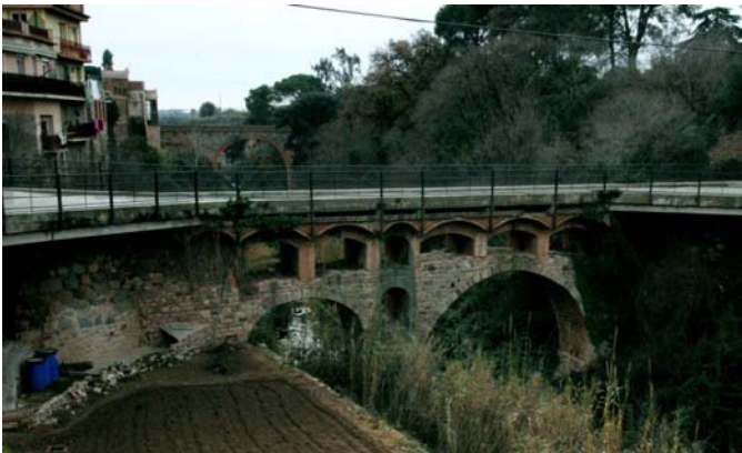
Antiguo Puente de "Les Cremades" en Caldes de Montbui en su situación inicial (2012)
