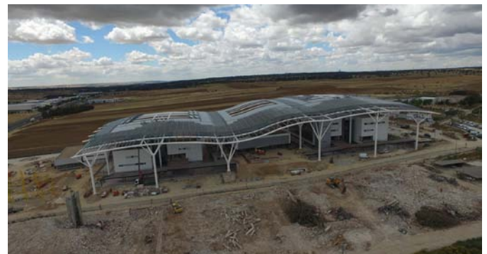
Vista general de marquesina y edificios
