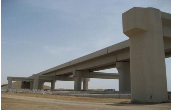
Figura 2. Vista del Viaducto 184 + 193 ya finalizado
