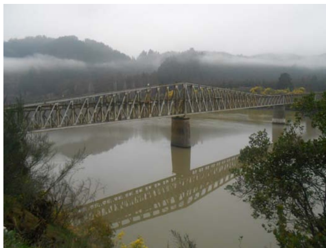
Puente sobre el río Maule, en la VII Región
