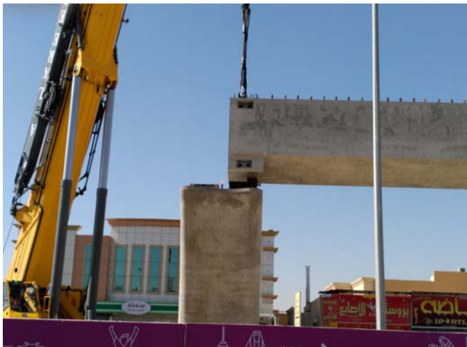
Viga colocada sobre pila
