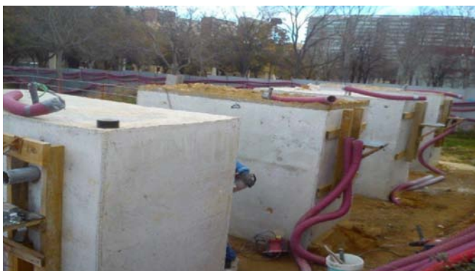
Figura 2. Dados de hormigón armado ( h = 2,0 \text{ m} ) bajo condiciones termohigrométricas in situ
