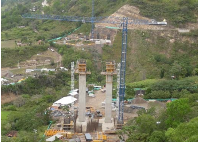
Alzado de pilono en construcción
