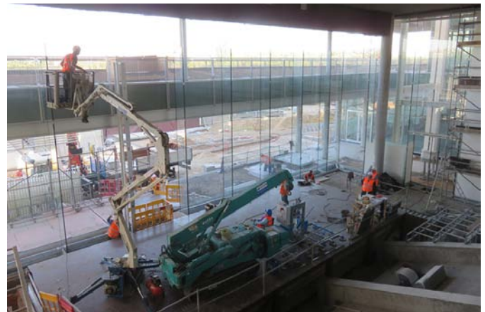
Figura 2. Vista del montaje desde el interior
