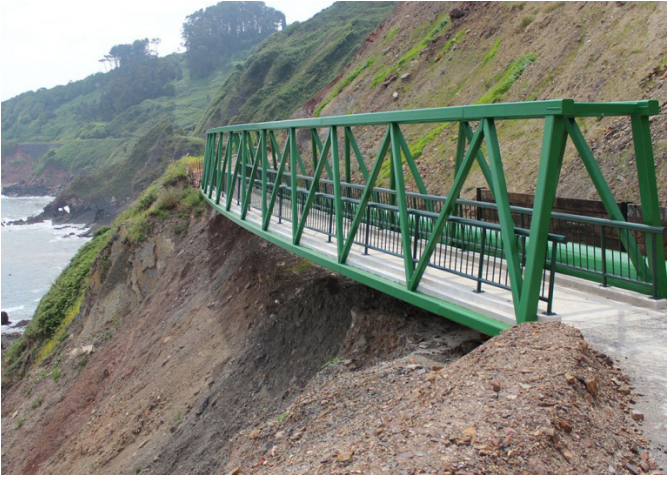
Figura 2. Pasarela en servicio
