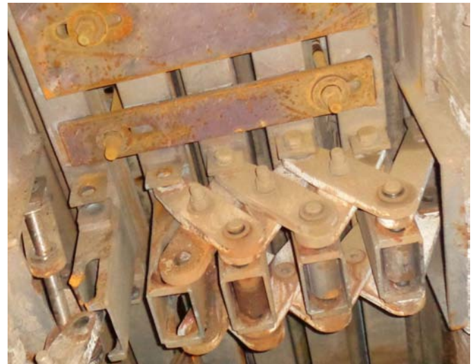
Junta modular existente
