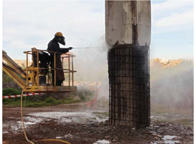
Reparaciones en pilas
