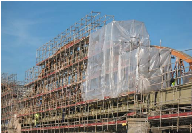
Encapsulado y medios auxiliares durante la construcción
