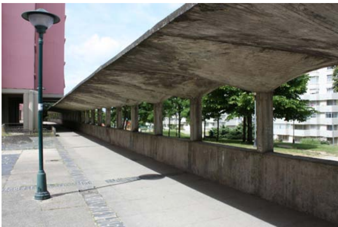
Paso cubierto con paraboloides disimétricos
