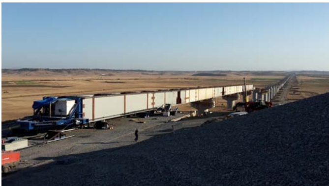
Vista General del tramo Sur
