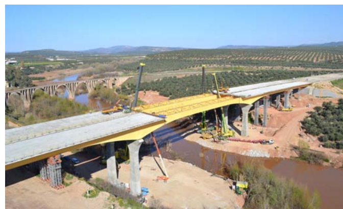
Puente de Guadalimar durante la construcción
