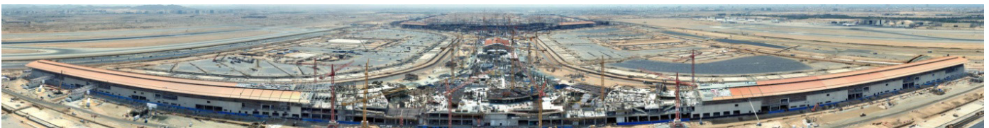
Situación en obra con gran parte de la estructura hormigón completada
