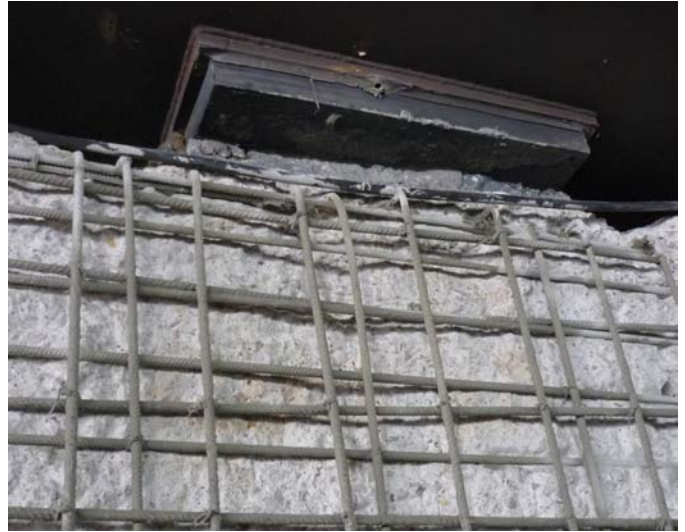
Reparación de desconchón y refuerzo de armado bajo aparato de apoyo
