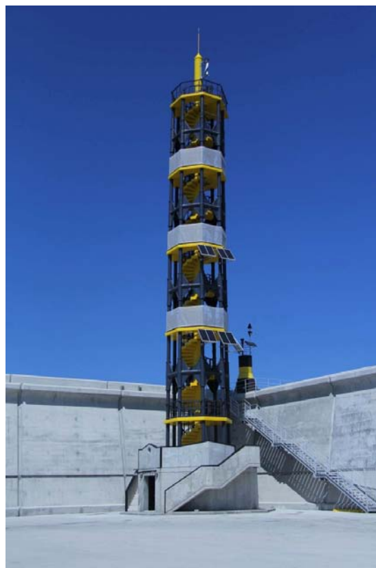
Figura 1. Imagen del faro en polímeros reforzados con fibra (PRF) una vez terminado
