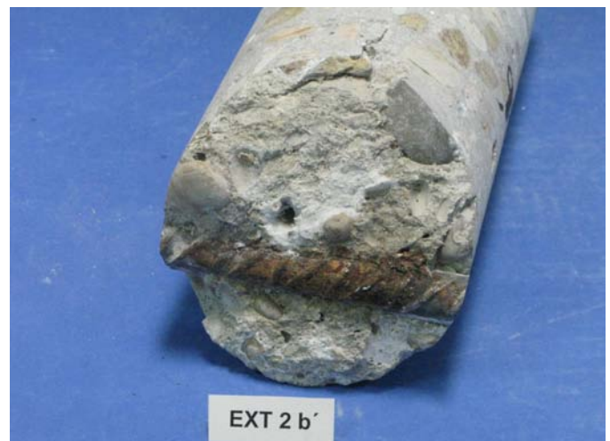
Depósitos blancos y armadura con corrosión
