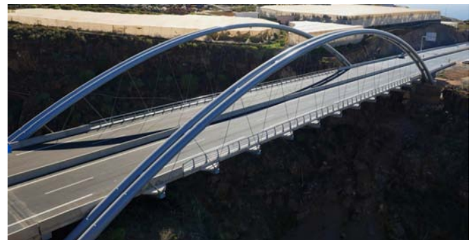
Vista de la estructura recién terminada
