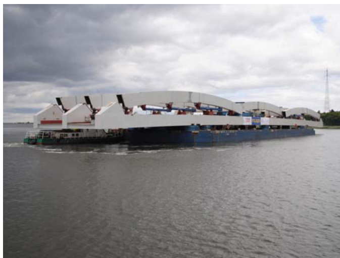
Transporte fluvial del arco pre-montado
