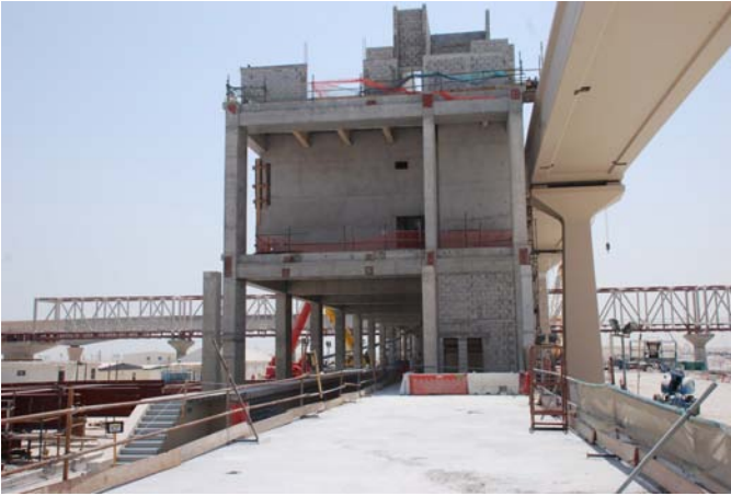
Ras Bu Fontas. Sección tipo de pórtico transversal, con una dirección del metro abajo a la izquierda
