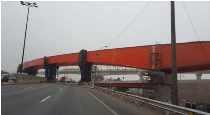
Vano 2 de 110 m. Cruce de la avenida Evitamiento
