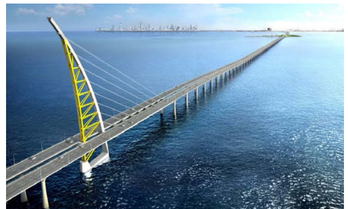
Canal de navegación en el viaducto principal
