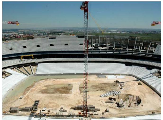
Vista graderío Este
