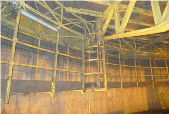
Plataforma de encofrado autodeslizante en el interior del silo
