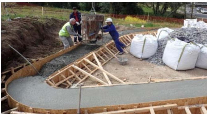
Cimentación de hormigón con concha de mejillón
