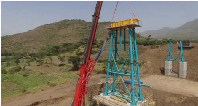
Pila metálica en celosía de acero
