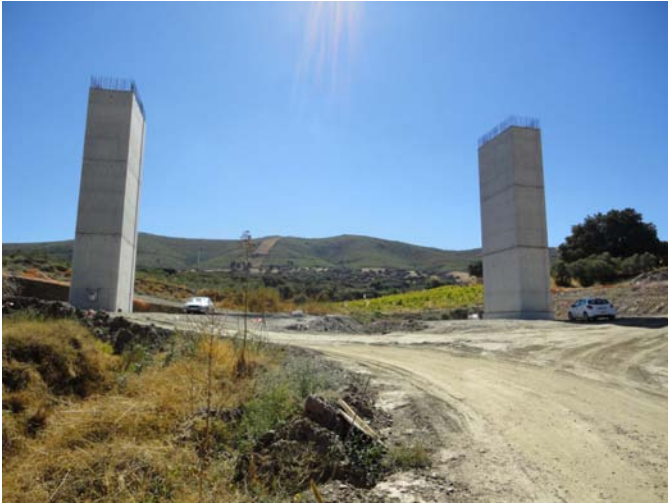
Alzado de pilas en ejecución
