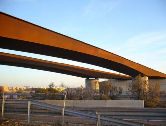
Cajones metálicos del puente sobre la A-62 durante la ejecución
