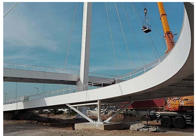
Vista con la rampa y pila
