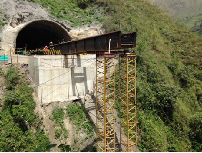
Lanzamiento de estructura metálica desde el vecino túnel
