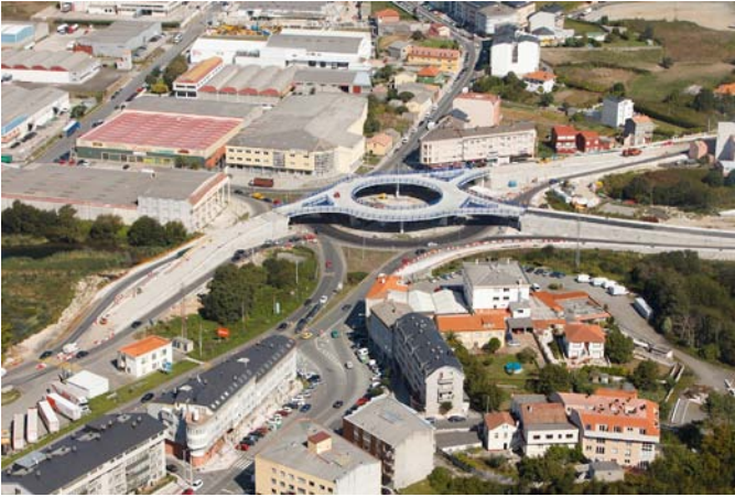
Enlace de Sabón. Vista aérea
