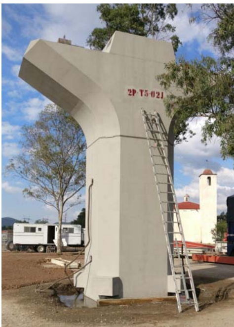
Montaje en blanco de subestructura prefabricada
