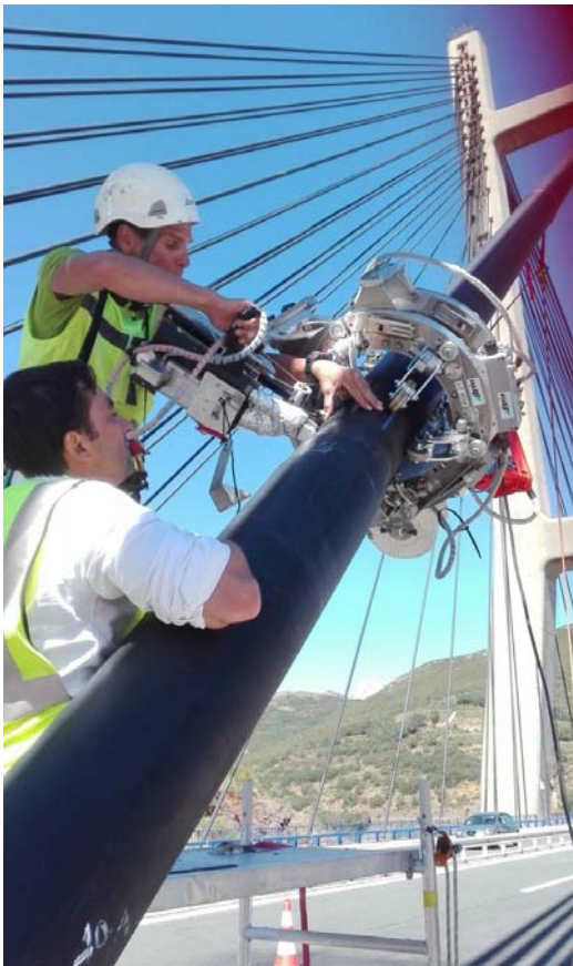
Robot para soldadura radial de vaina
