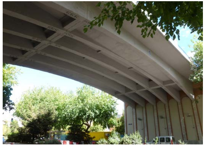
Figura 2. Imagen del puente tras su acondicionamiento
