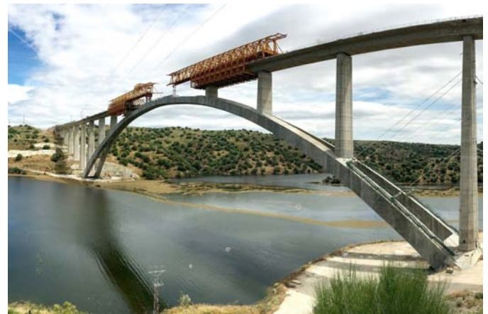
Construcción del tablero mediante autocimbra
