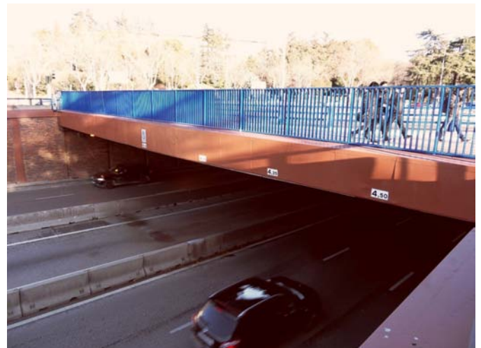
Imagen del paso inferior tras los trabajos de acondicionamiento
