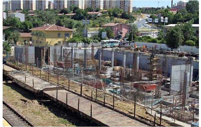
Administrador de construcción estructural funciona con 100 años concretos del proyecto
