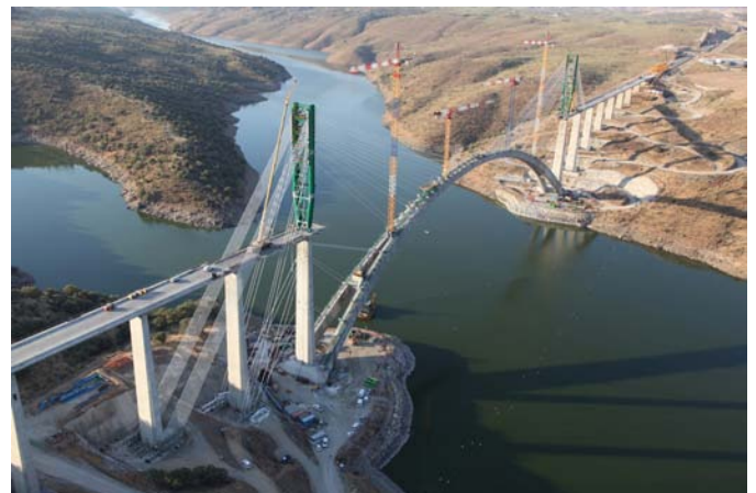
Vista general del arco tras retirada de carros
