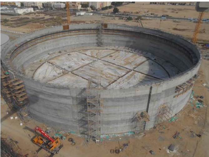
Depósito de hormigón postesado de Faisaliyah, con capacidad para 250.000 m 3 /tanque
