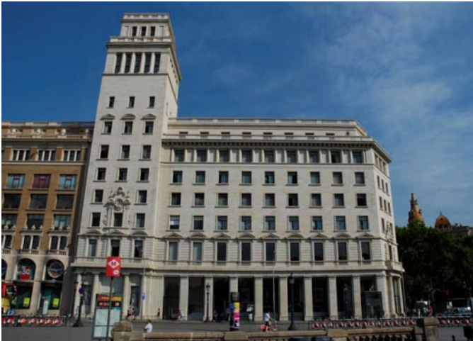
Vista general del edificio
