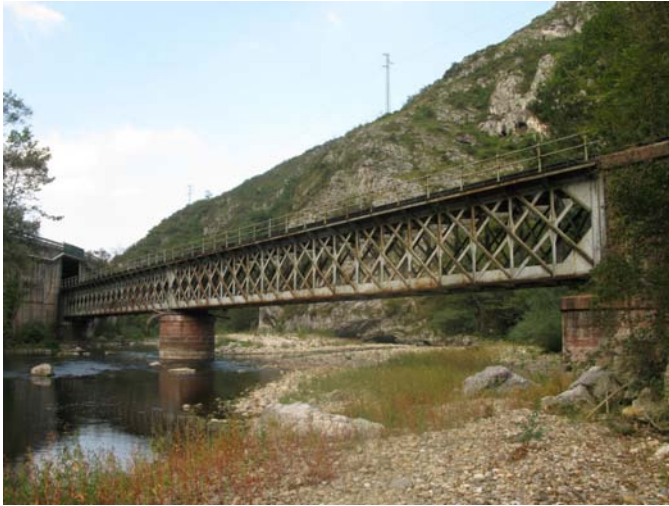
Puente ferroviario metálico antiguo
