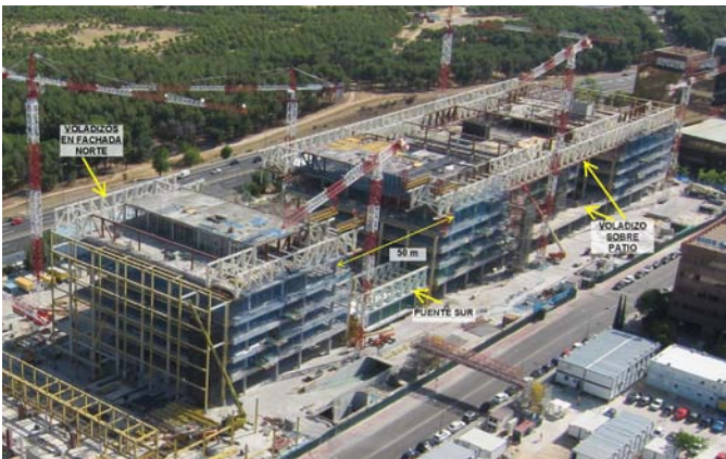
Vista general de la cubierta
