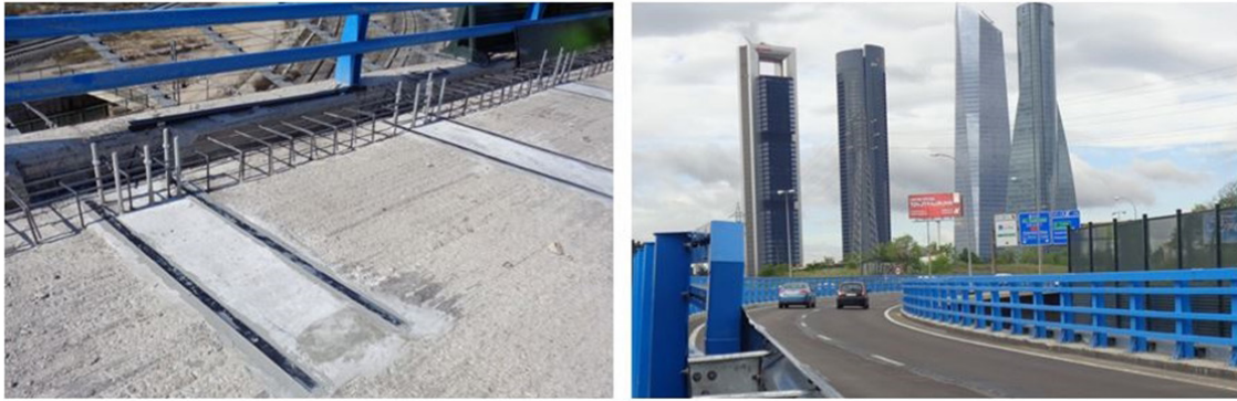
Sustitución de pretel H4b metálico con refuerzo de fibras de carbono
