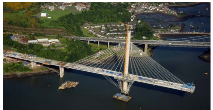
Puente durante la construcción
