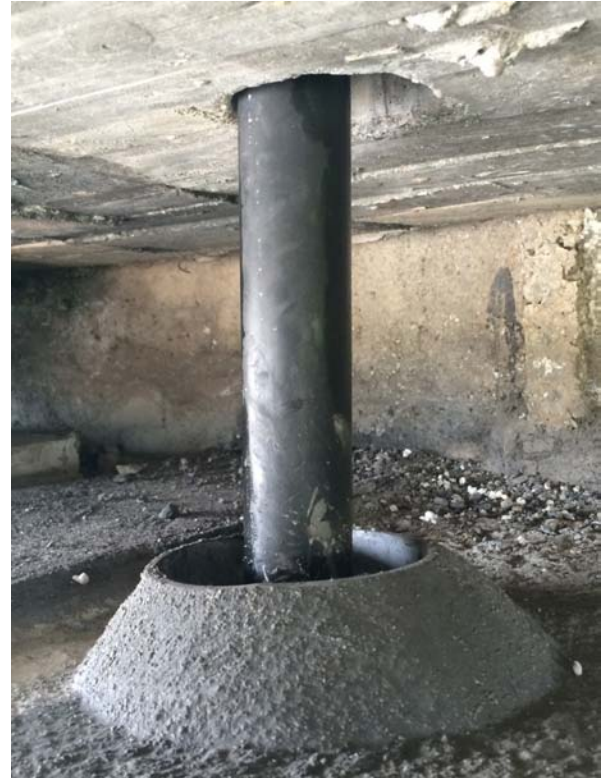
Anclaje vertical con barras pretensadas autoprotegidas
