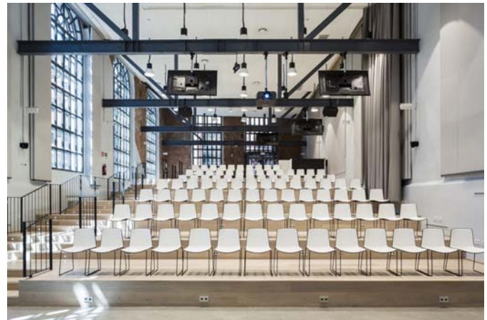
Auditorio del Google Campus Madrid, con las nuevas cerchas realizadas en base a las antiguas vigas
