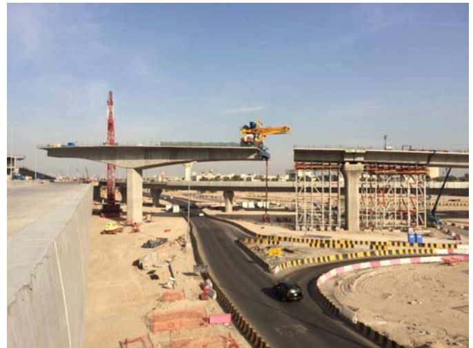
Figura 2. Montaje rampa de cruce con ejecución en voladizos con dovelas prefabricadas
