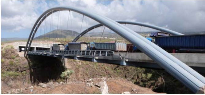
Vista de una de las fases de la prueba de carga
