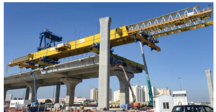
Construcción del viaducto principal con viga lanzadora, vano a vano
