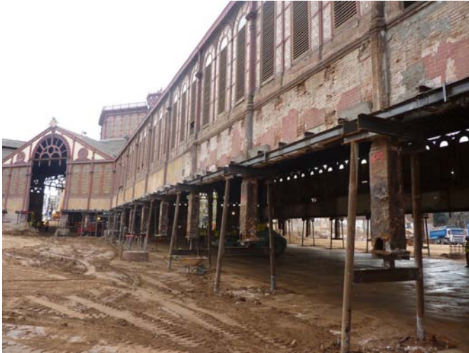
Apeo de la estructura existente
