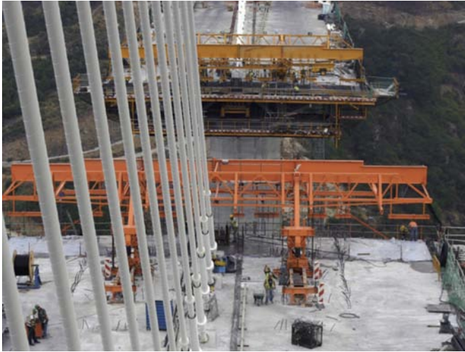
Carro de voladizos en el viaducto del Corgo
