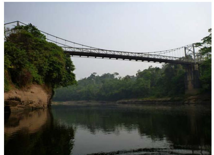
Vista del puente existente
