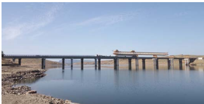
Panorámica del nuevo viaducto al frente y del existente al fondo, con el lanzador en funcionamiento
