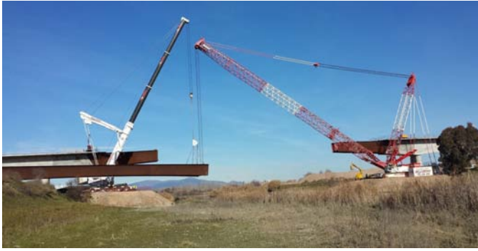
Montaje vano central
