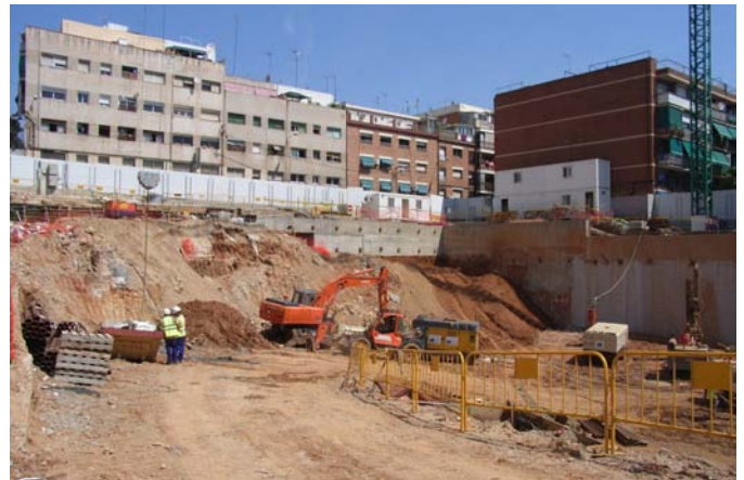
Ejemplo de excavación urbana con edificaciones adyacentes
