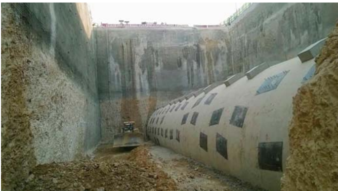
Refuerzo de túnel
