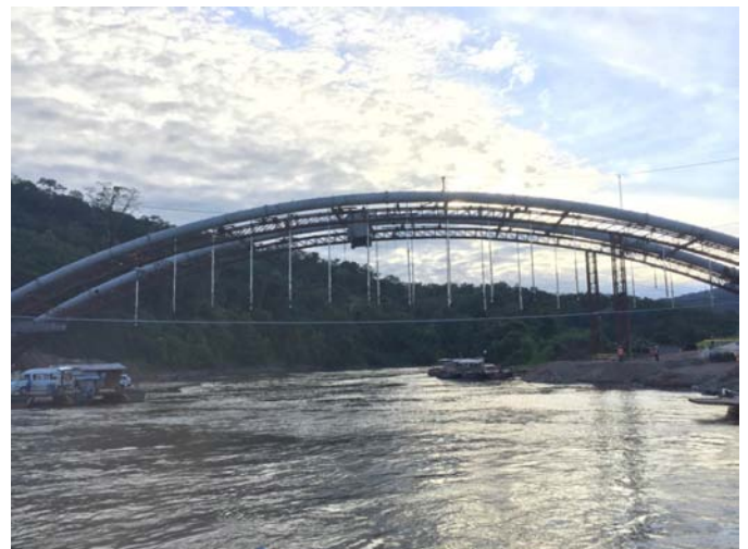
Vista del puente durante los trabajos
