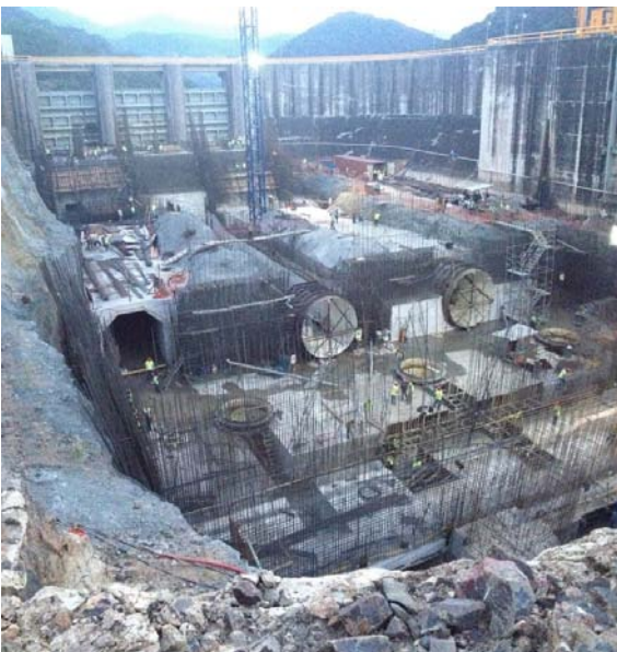
Fase de construcción de macizos de anclaje
