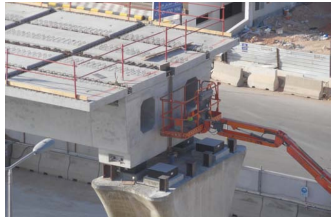
Montaje del tablero
