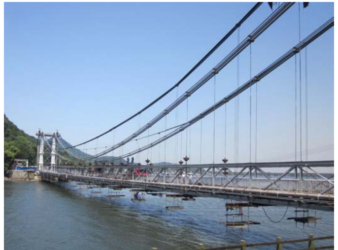
Cables definitivos colocados y tesados. Cables provisionales destesados
