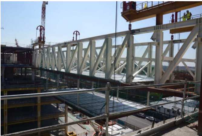
Izado “Puente Sur”
