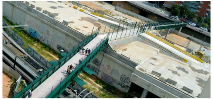
Pasarelas provisionales sobre las obras de ADIF, Barcelona (2015). Foto: barcelonasagrera.com
