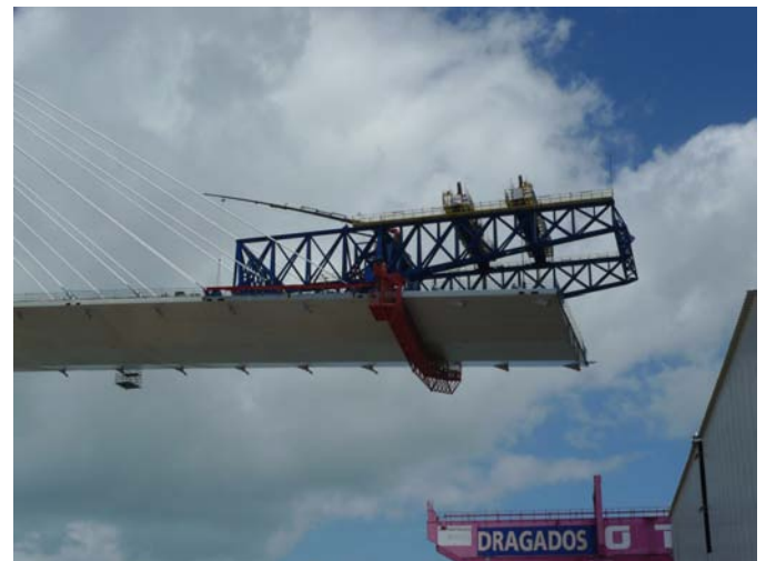
Carro de izado de dovelas en el puente de Cádiz
