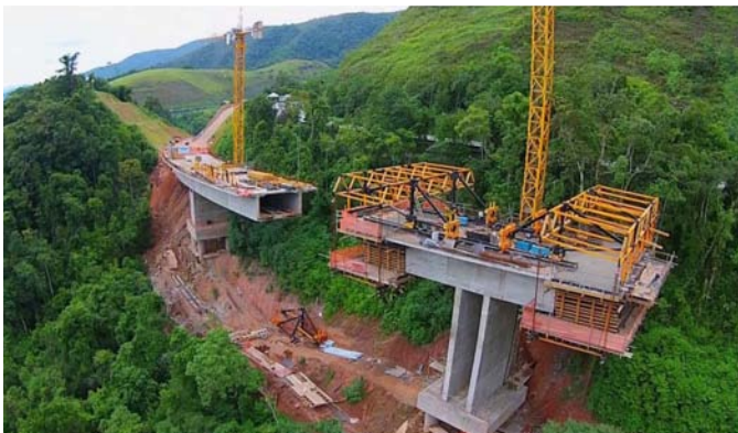
Fase del proceso constructivo de avance en voladizos (Obra 30)
