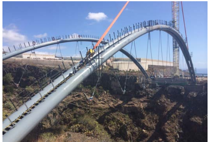
Fase de colocación de los arcos
