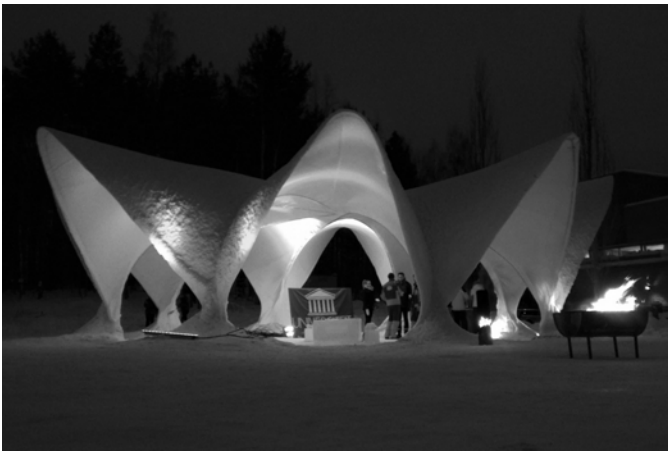
Vista general de la estructura
