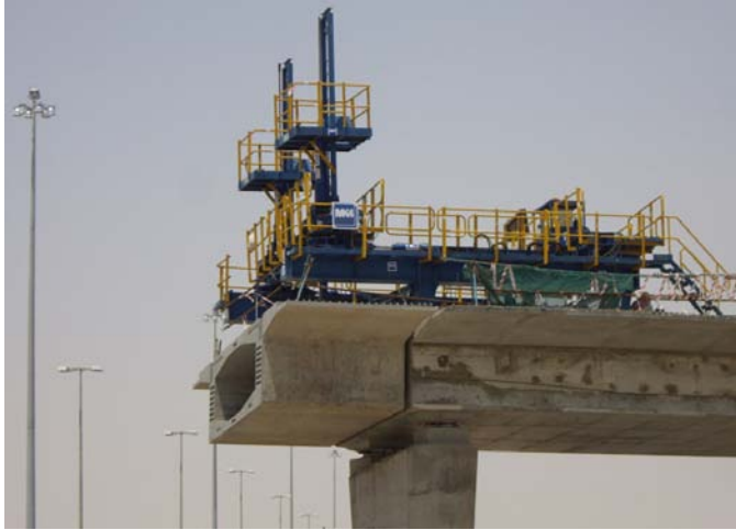
Vista General del izado de dovelas con carro de izado
