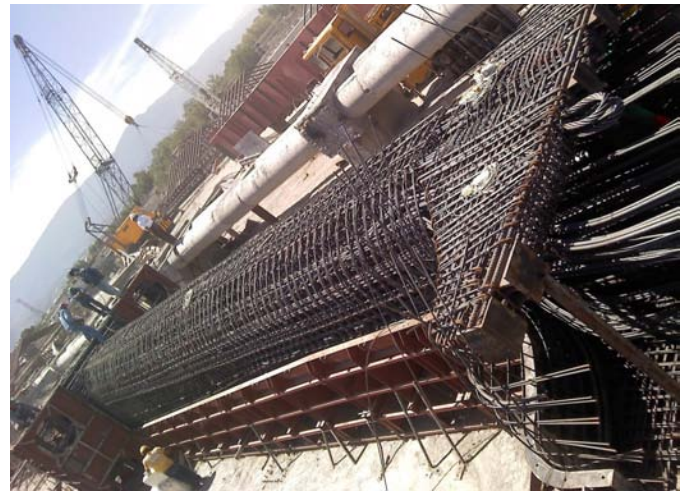
Instrumentación de una zapata-columna prefabricada pretensas
