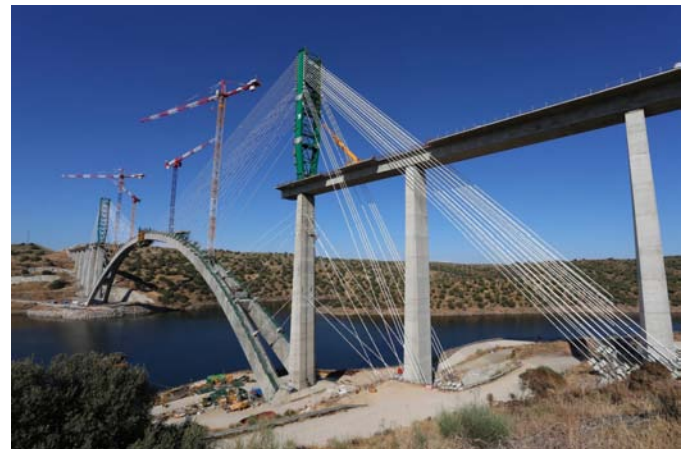
Alcanzando el cierre del arco
