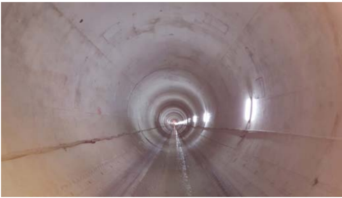
Figura 2. Acabado del revestimiento de hormigón del túnel de Renace III
