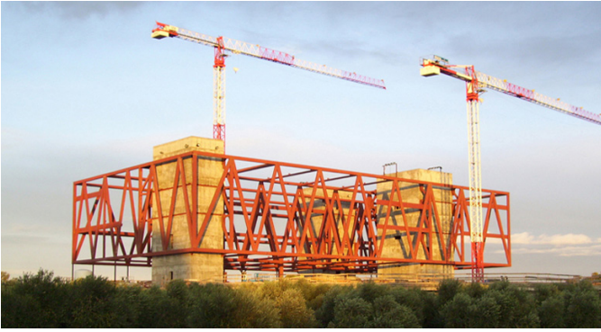
Vista general de la estructura metálica en la fase final de su ejecución
