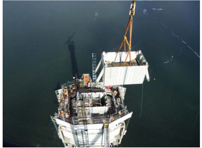
Colocación de un armario metálico
