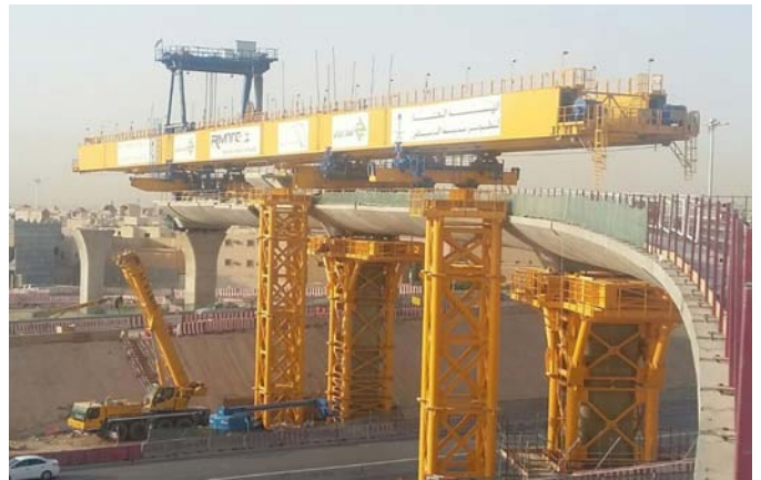
Construcción del último vano lateral en el puente continuo de la autopista de Jeddah
