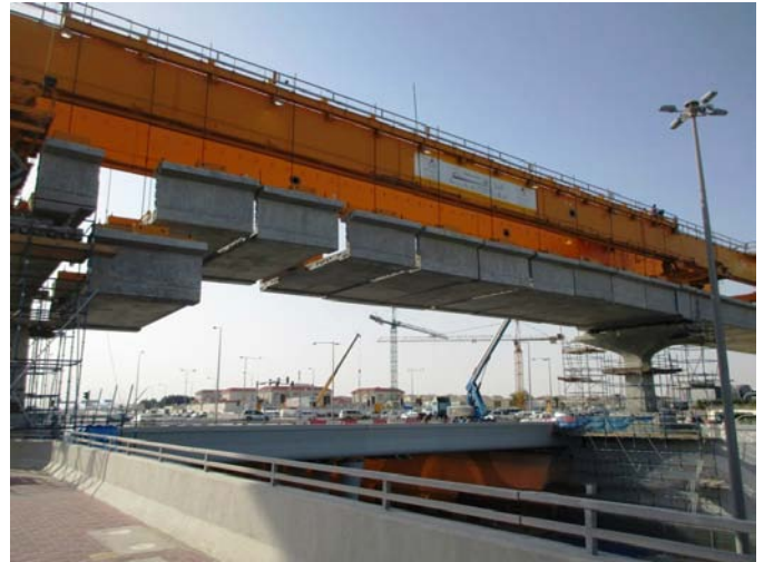
Operación de izado de dovelas prefabricadas para el vano de 44 m. de luz
