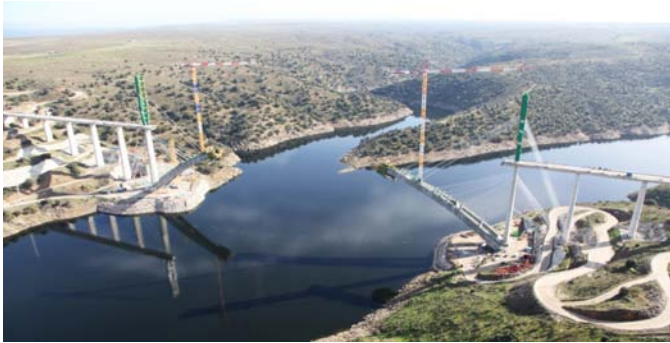
Vista general durante la construcción del tablero sobre el arco
