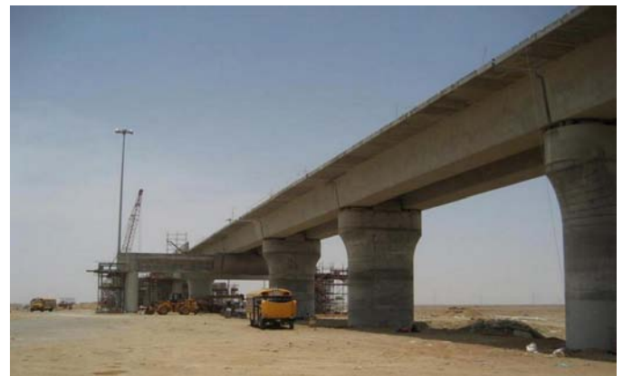
Figura 1. Vista del Viaducto 175 + 302 en construcción
