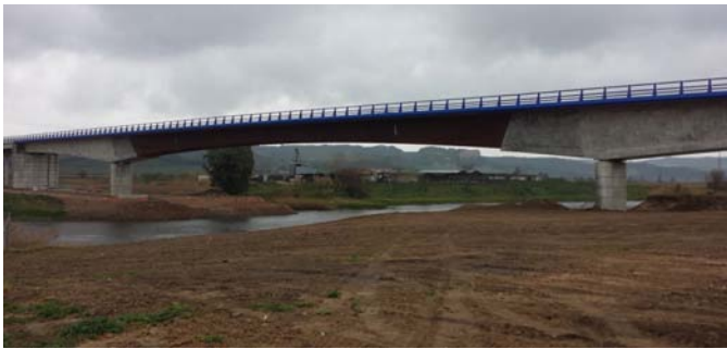
Alzado puente acabado
