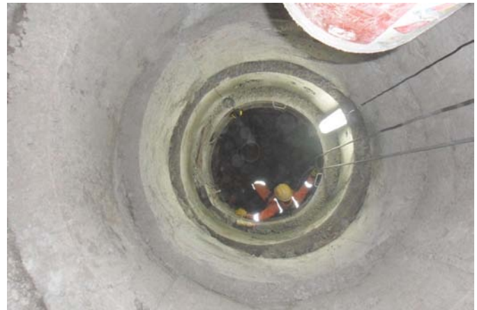
Excavando pilotes a mano
