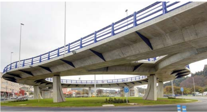
Enlace de Sabón. Vista inferior
