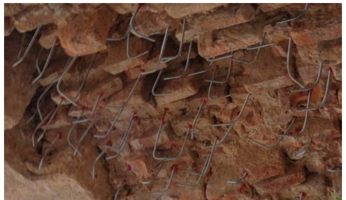
Varillas de acero fijadas al soporte para restituir la trabazón de la bóveda
