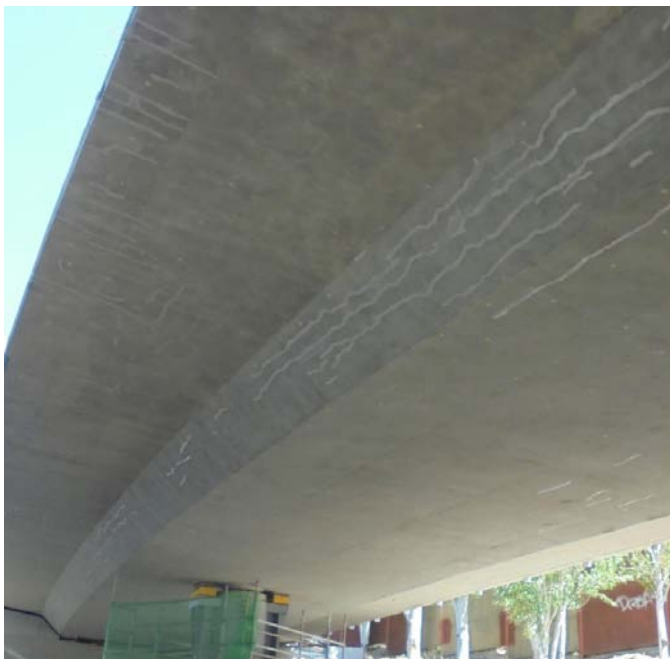
Vista general de estructura saneada con chorro de arena y tratamiento de fisuración mediante sellado
