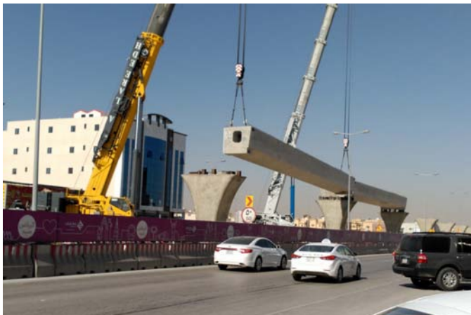
Colocación de vigas tipo de 36 m
