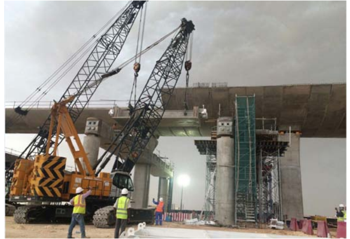
Izado de vigas prefabricadas de Mezzanine
