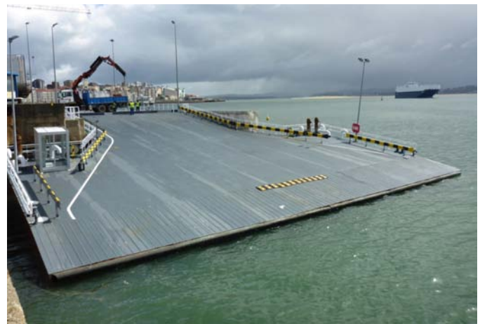
Figura 2. Rampa operativa en su nuevo emplazamiento
