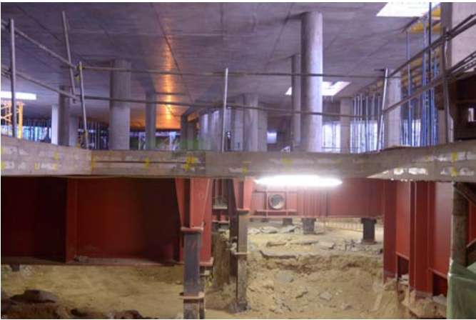
Figura 2. Vista de la interfaz entre el tajo ascendente y el descendente
