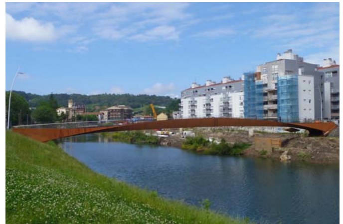
Pasarela Bicontentio Sinus en San Sebastián. Vista General
