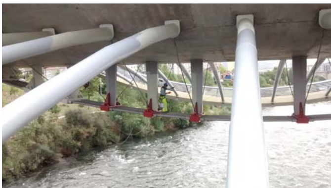
Trabajos en altura
