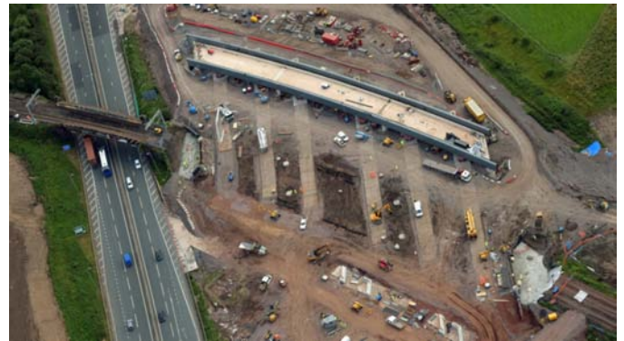
Vista aérea durante el proceso constructivo
