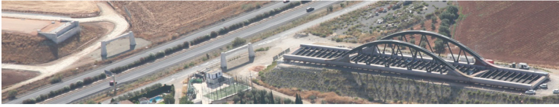
Viaducto sobre la A45, antes del empuje
