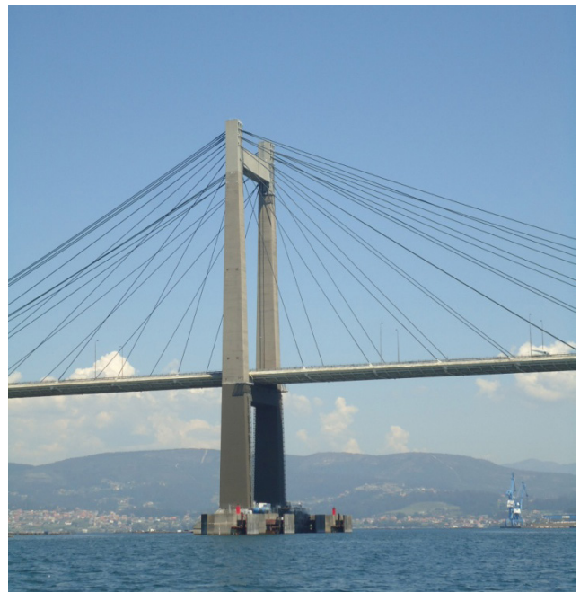
Vista general de la pila Norte tras la reparación
