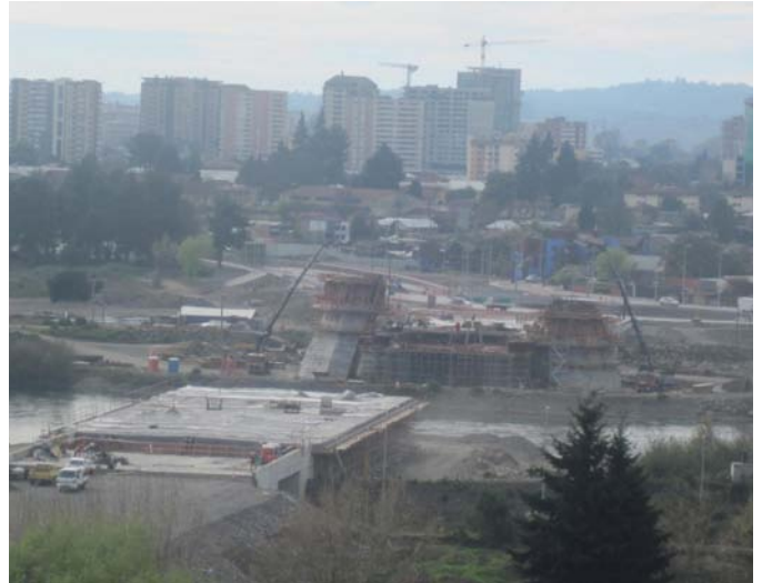
Vista general de la construcción del viaducto
