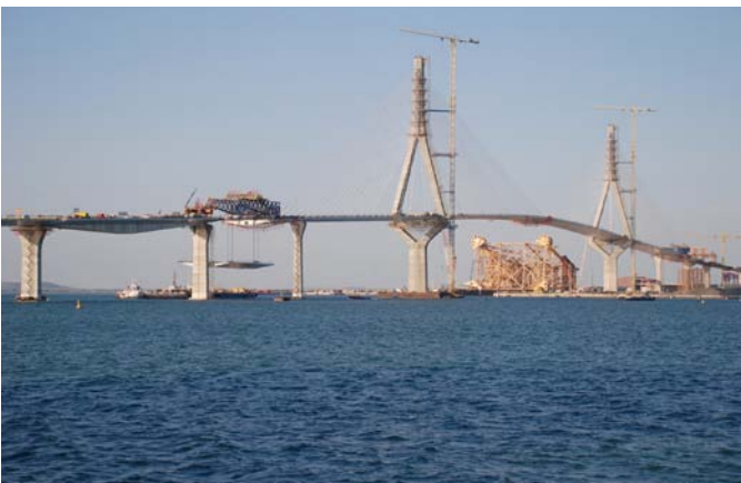
Colocación de la dovela extrema
