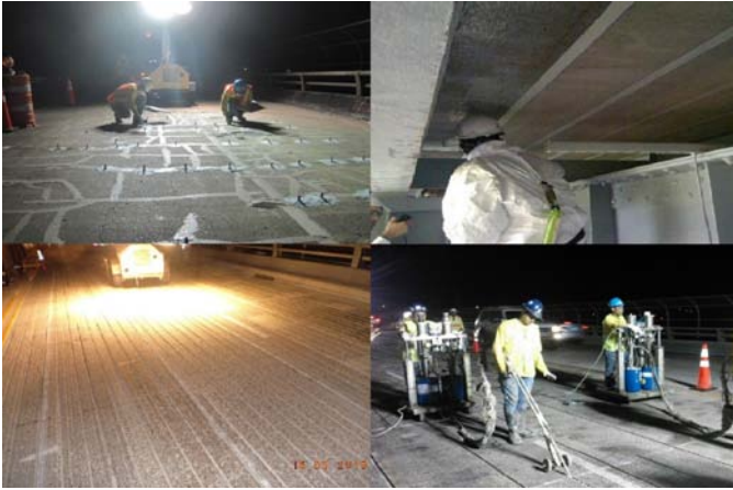
Técnicas de reparación y refuerzo en tablero
