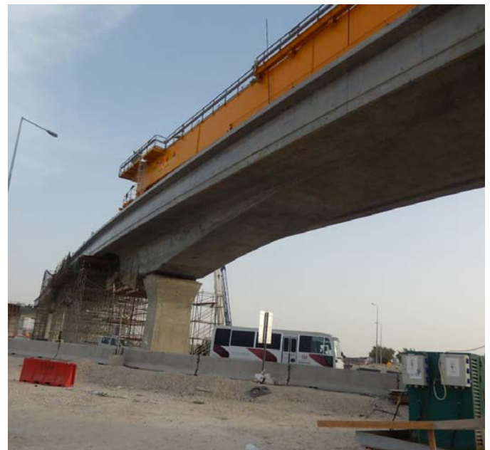
Puente continuo de canto variable ejecutado in situ
