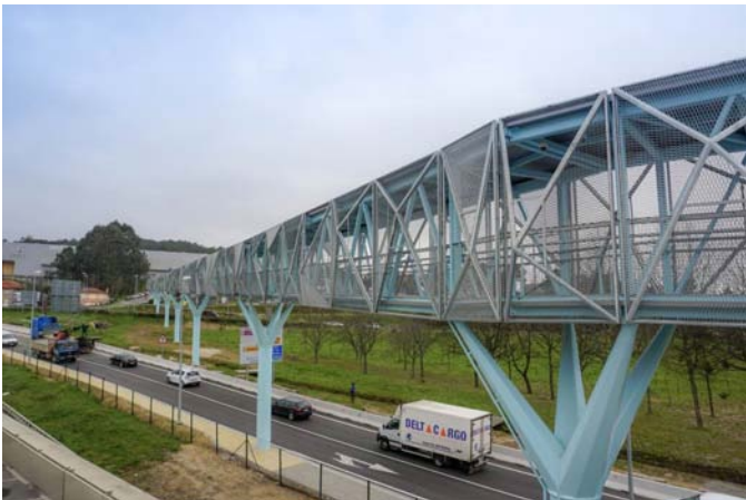
Vista general de la pasarela
