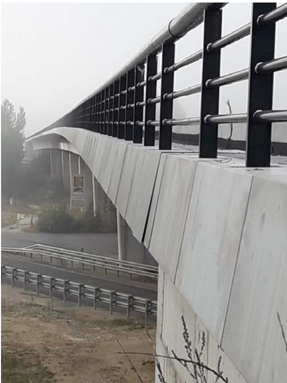
Vista lateral del viaducto terminado
