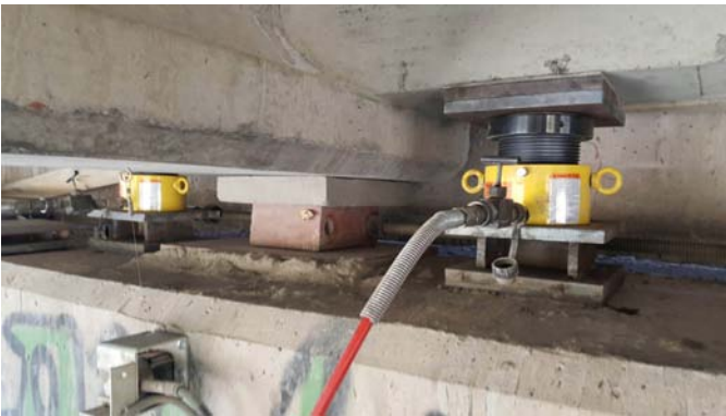
Puente levantado y ripado
