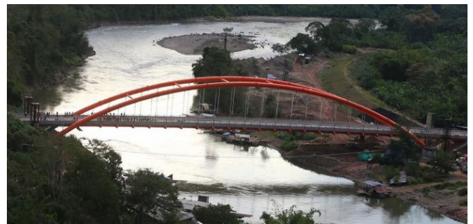
Vista general del puente
