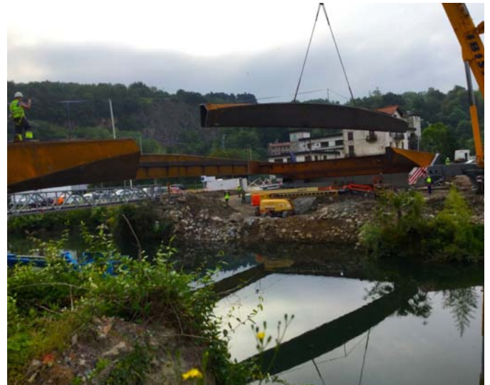
Puente Bicontentio en Martutene. Montaje del tramo central
