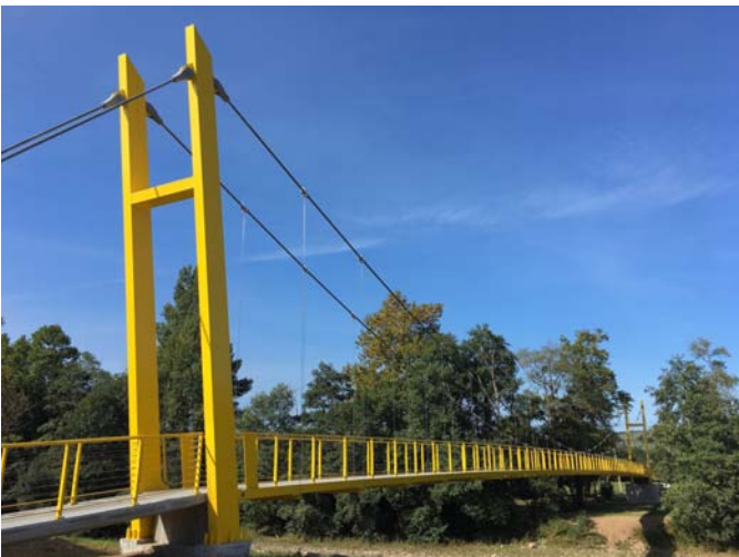
Vista general de la pasarela sobre el río Pas
