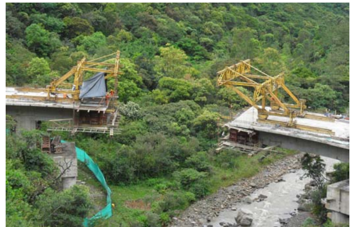
Avance en voladizo
