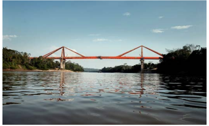
Estructura metálica del Puente sobre el río Pachitea una vez finalizado el lanzamiento
