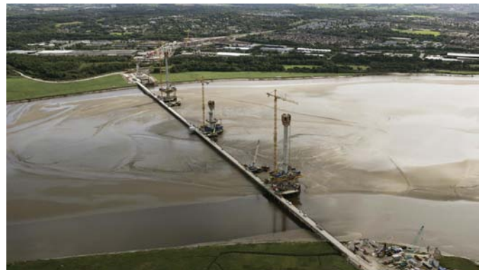
Puente principal atirantado en construcción
