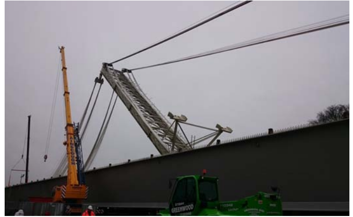
Maniobra de izado del mástil del atirantamiento
