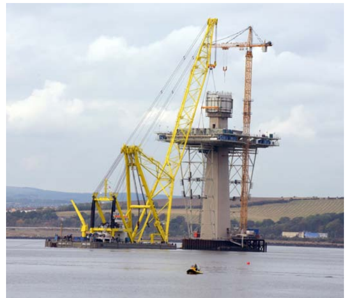
Colocación de dovela inicial sobre cimbra
