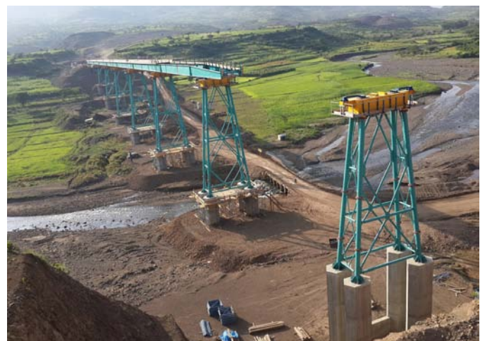
Puente empujado de 8 vanos
