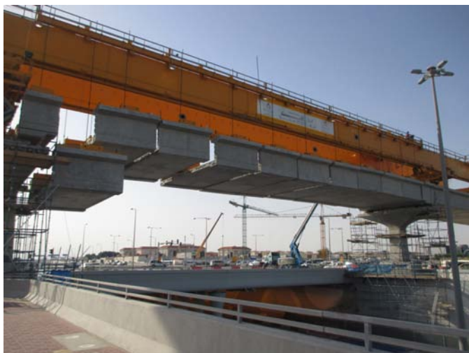
Precarga del vano
