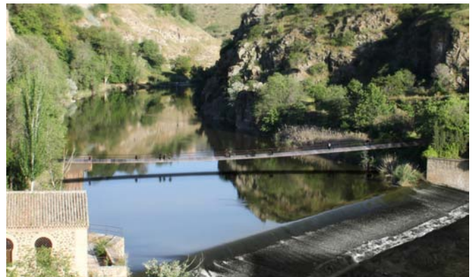
Pasarela banda tesa sobre el río Tajo en Toledo. Vista general
