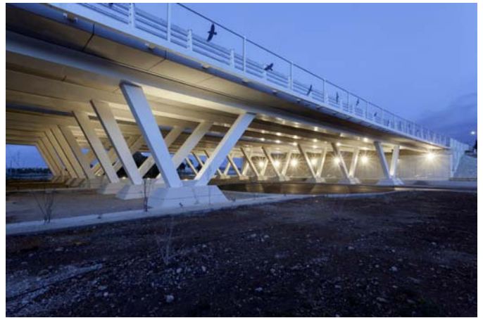
Vista general del puente
