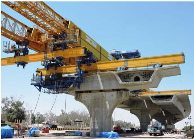
Figura 1. Montaje tronco principal con dovelas prefabricadas y grúa lanzadora
