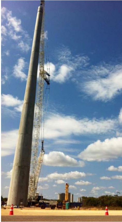
Torre durante el montaje
