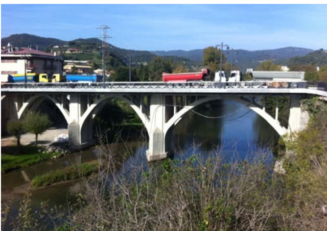
Ensanche Puente Sant Quirze de Besora
