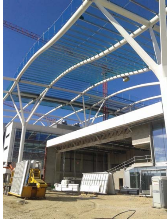
Cercha de auditorio y pilares arbóreos de marquesina
