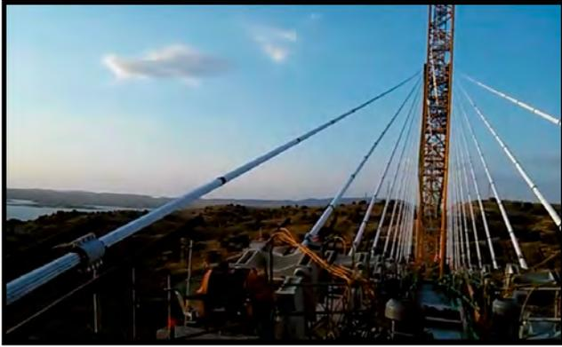
Figura 4. Fotograma de un video tomado en obra durante un episodio de vibraciones con amplitudes de unos 500 mm en el tirante situado a la izquierda de la imagen.
