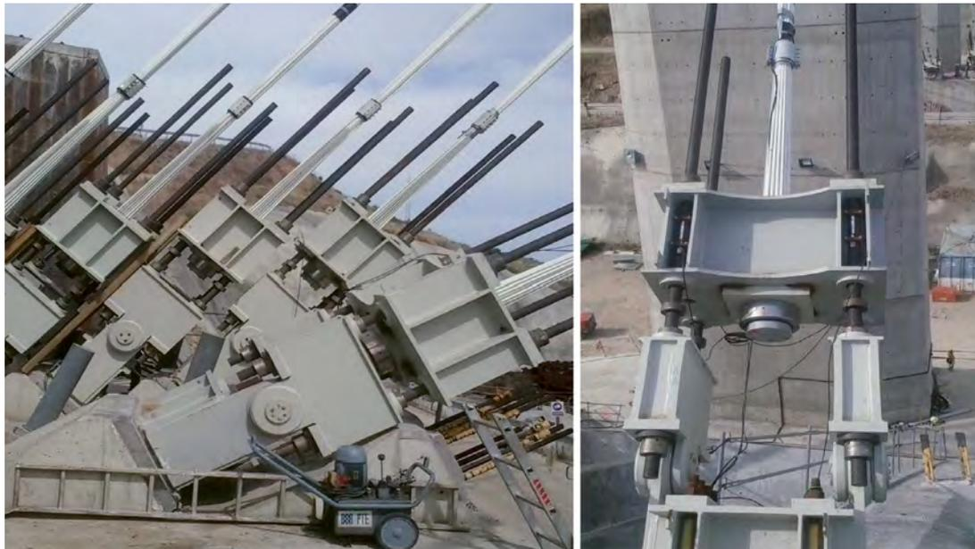
Figura 26. Bastidores. Anclaje al terreno y al arco.
