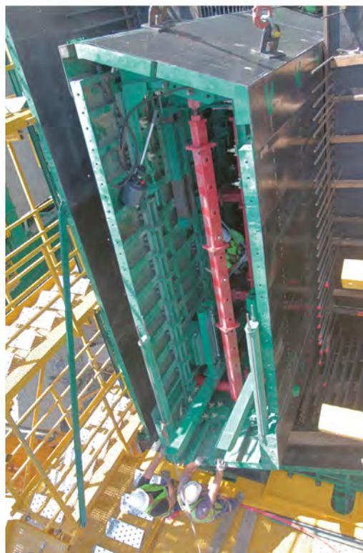
Figura 16. Detalle de paneles de encofrado interior.
