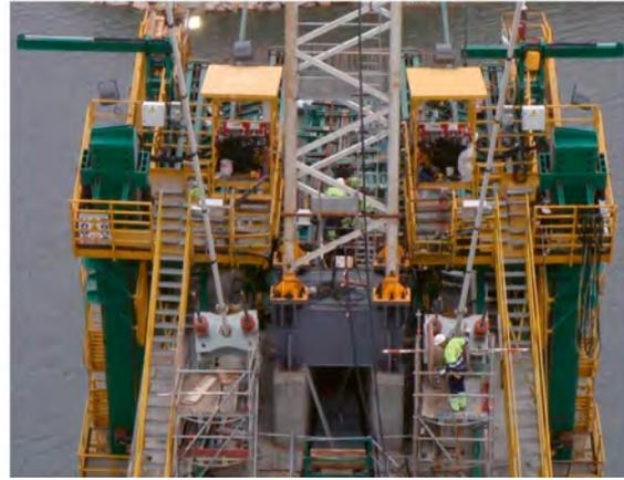
Figura 36. Grúa torre sobre las dovelas 14-15 y estructura metálica empleada en la base.
