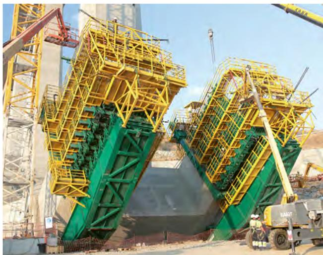
Figura 2. Carros de encofrado montados sobre el arranque.
