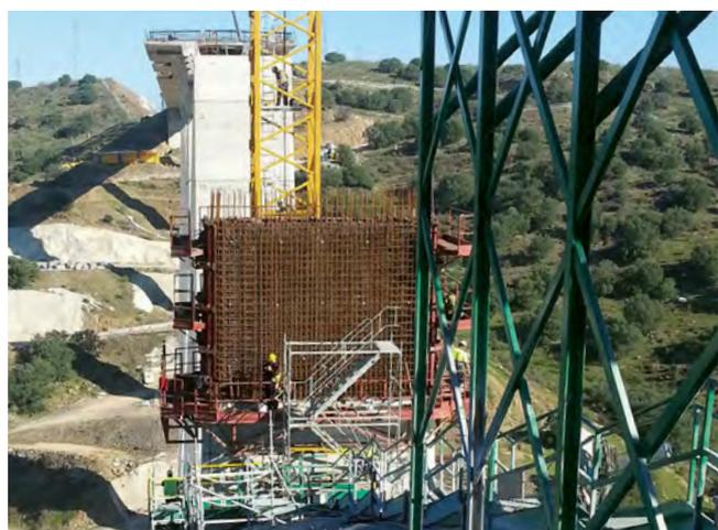
Figura 6. Tramo de armadura premontada colocado en pilastra.
