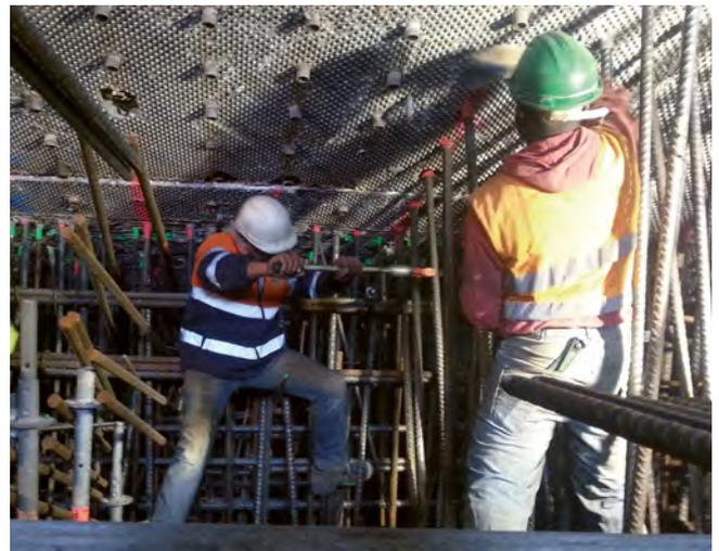
Figura 33. Ferrallado del diafragma de la pilastra 13.
