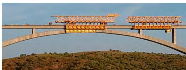
Figura 21. Fase 5 vano central. Retirada autocimbra sur.
