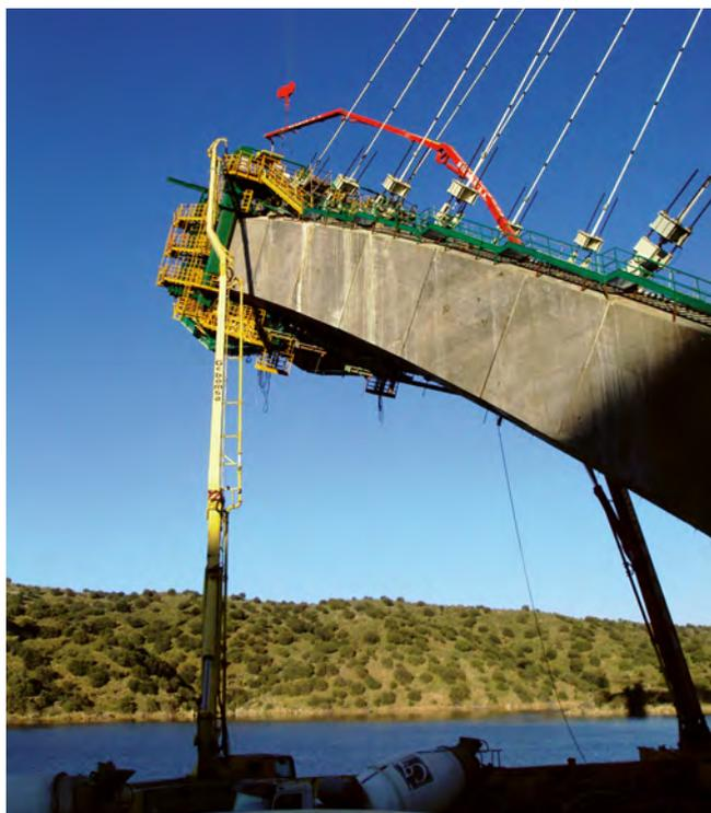
Figura 28. Hormigonado con autobomba de una dovela.
