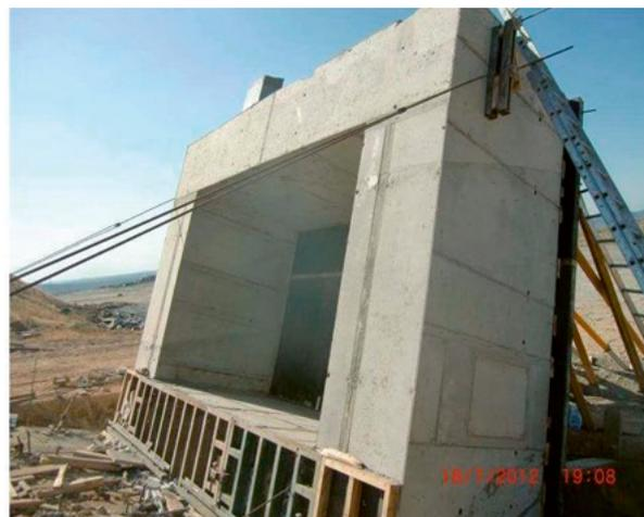
Figura 11. Dovela de prueba tras desmolde.
