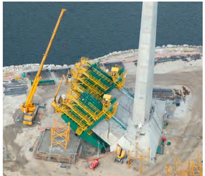
Figura 12. Montaje de los carros de avance una vez anclados en las dovelas 1 y 2.
