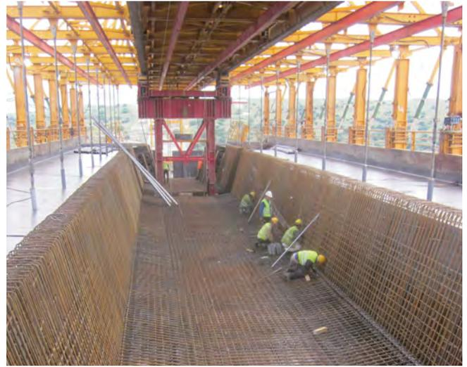
Figura 24. Ferrallado de un vano.
