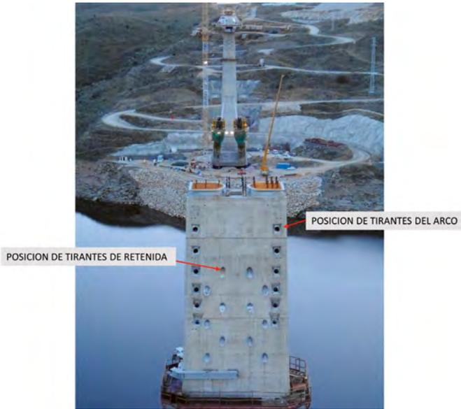
Figura 17. Detalle de posición de tirantes en pila.
