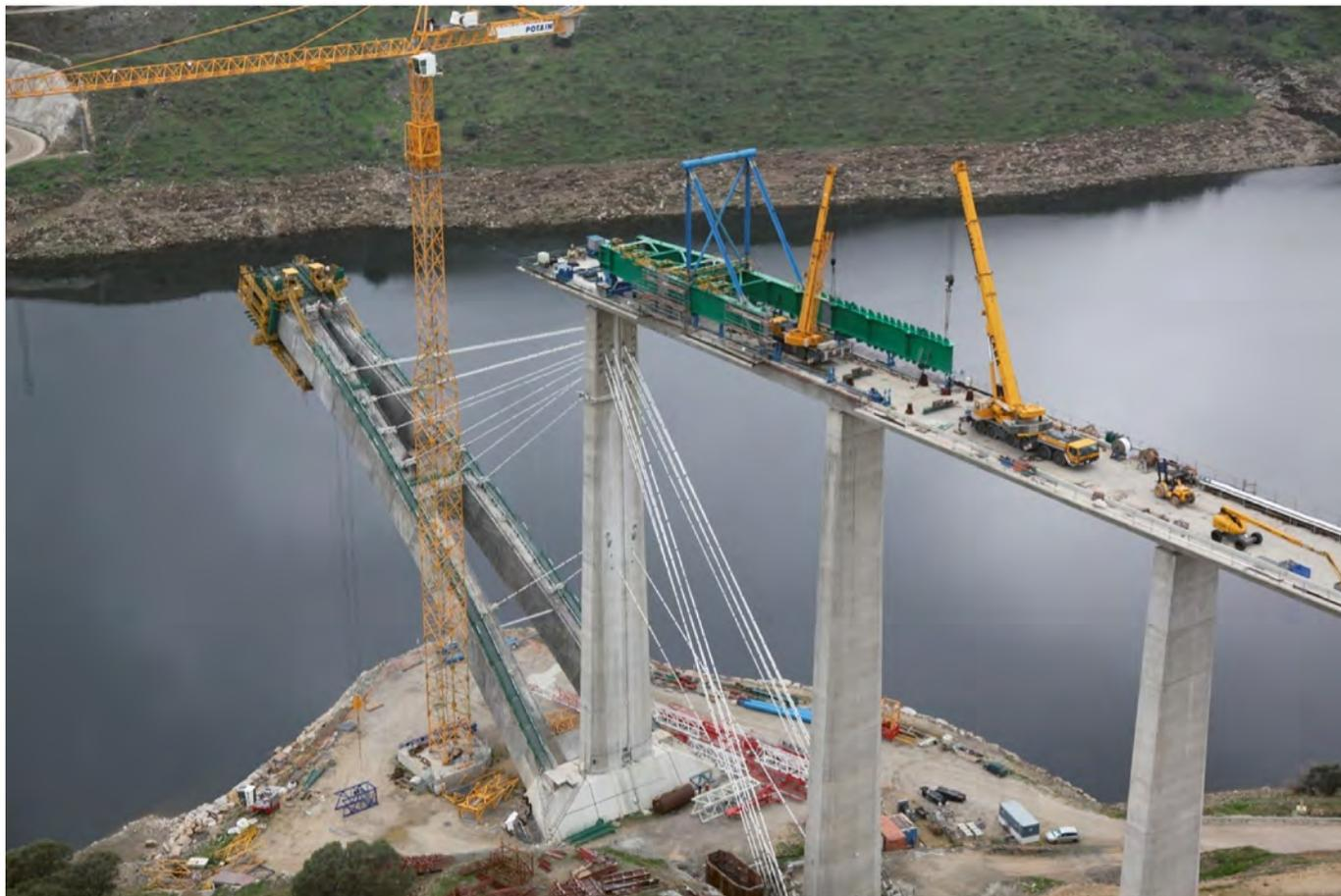
Figura 24. Montaje de torre sobre tablero.
