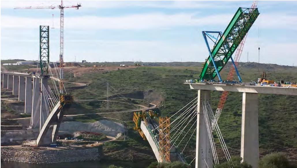
Figura 30. Vista torre en transferencia de carga.
