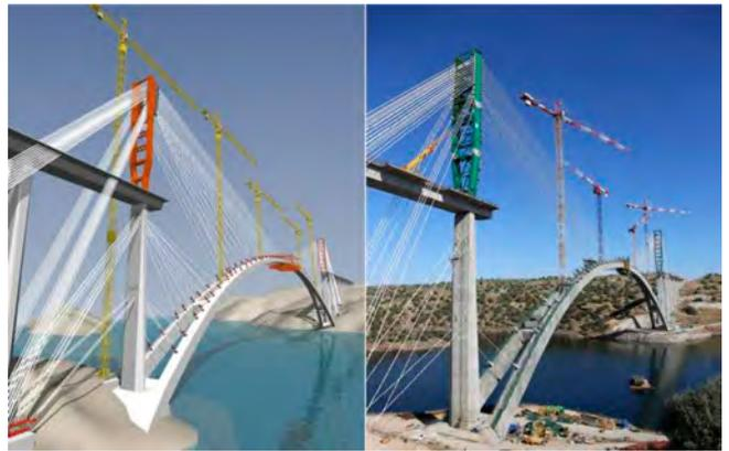
Figura 9. Comparativa entre el procedimiento constructivo desarrollado durante el proyecto, y la imagen real durante la ejecución de las obras.
