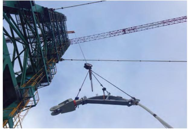
Figura 26. Izado de un tirante para su anclaje en el pilono.
