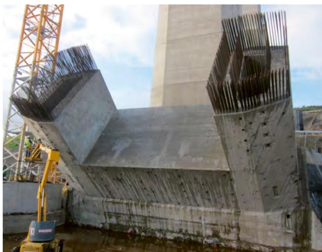
Figura 7. Dovelas 1 y 2 del arco.
