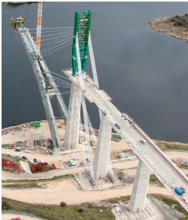
Figura 34. Huecos de tablero para el paso de tirantes de retenida.
