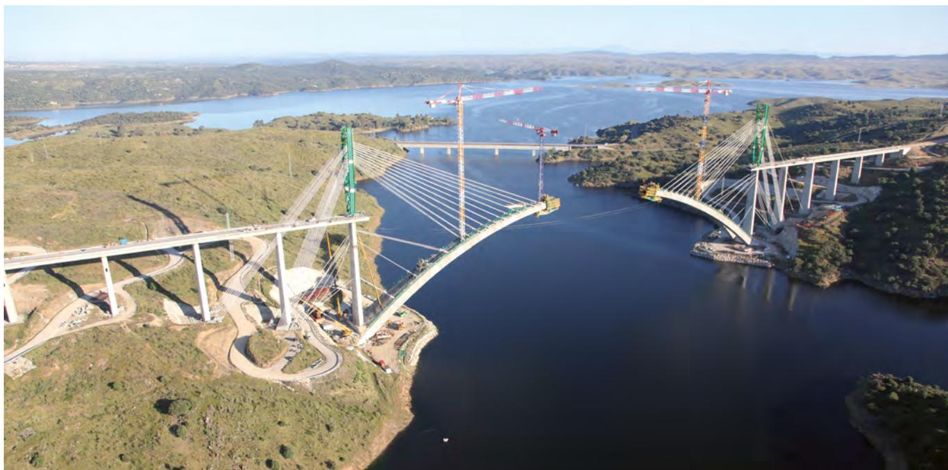
Figura 2. Ejecución del arco del viaducto de Almonte.
