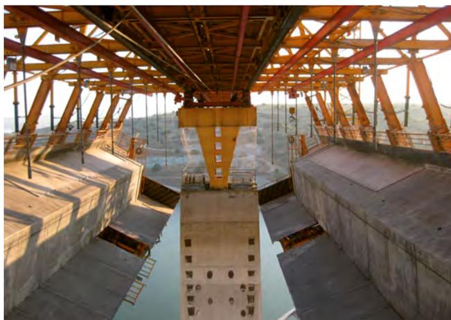
Figura 13. Pórtico de apoyo sobre pila P15.
