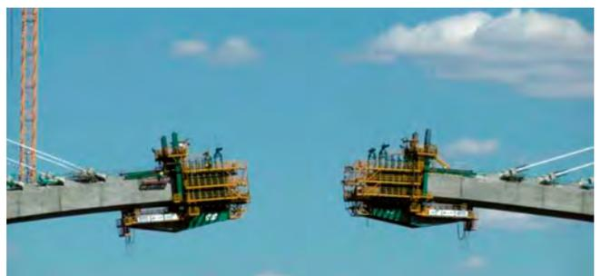
Figura 10. Ejecución de las últimas dovelas del arco.
