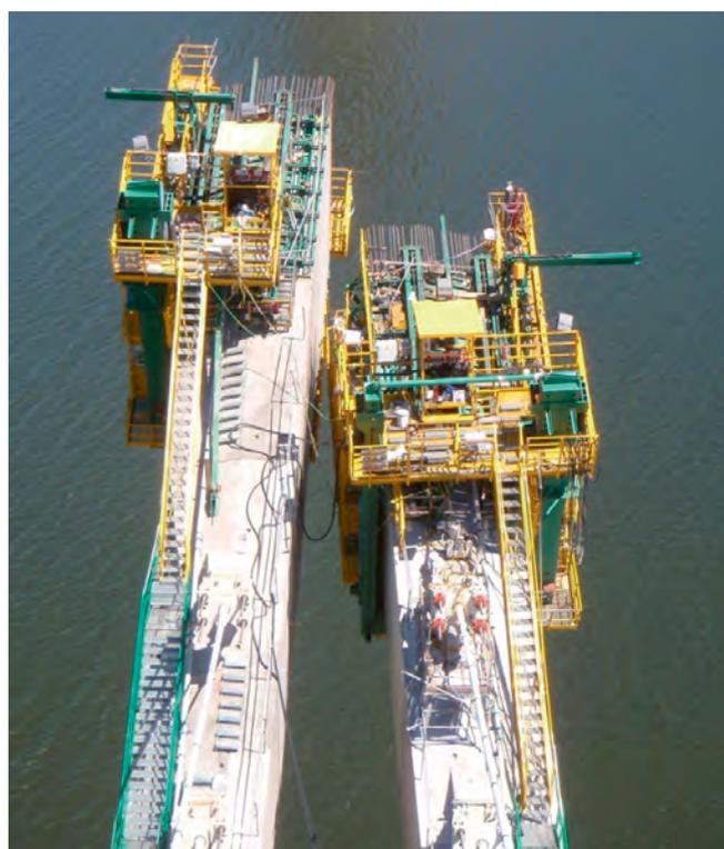
Figura 14. Unión de los carros de la margen sur.
