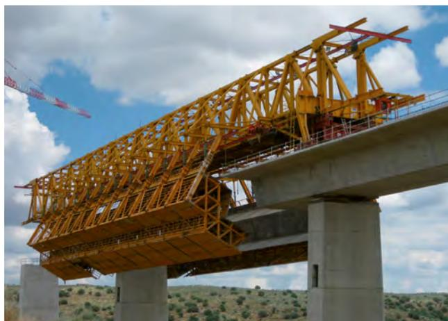
Figura 14. Imagen autocimbra con el encofrado exterior abierto.
