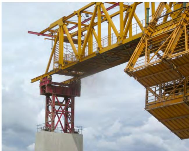
Figura 11. Pórtico de apoyo de pila empleado en la ejecución de los vanos de acceso.
