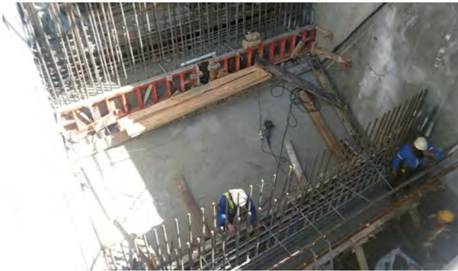
Figura 31. Ejecución del diafragma de la pilastra 14.
