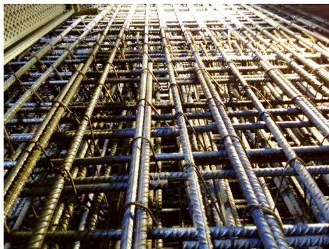
Figura 3. Armado de una de las dovelas.
