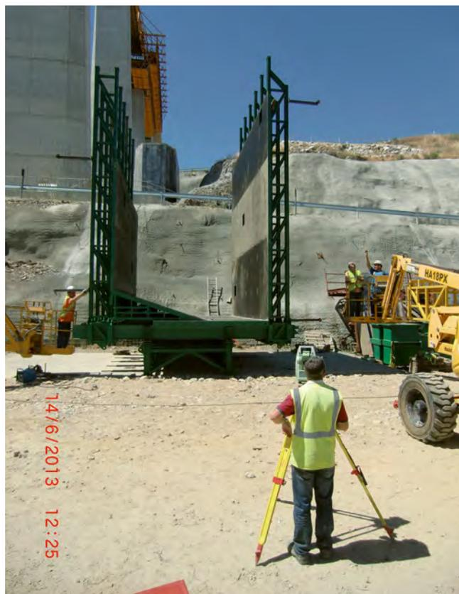
Figura 2. Control geométrico de encofrado.
