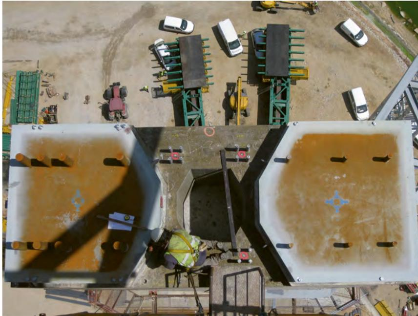
Figura 27. Apoyos POT provisionales de pila P15.
