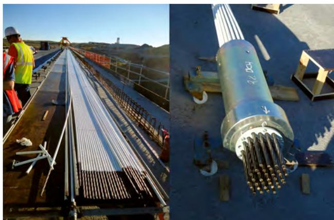
Figura 36. Proceso de premontaje del tirante.
