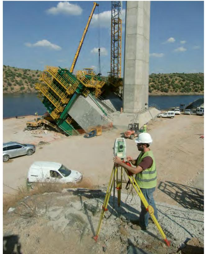
Figura 4. Toma de datos de posición del arco.
