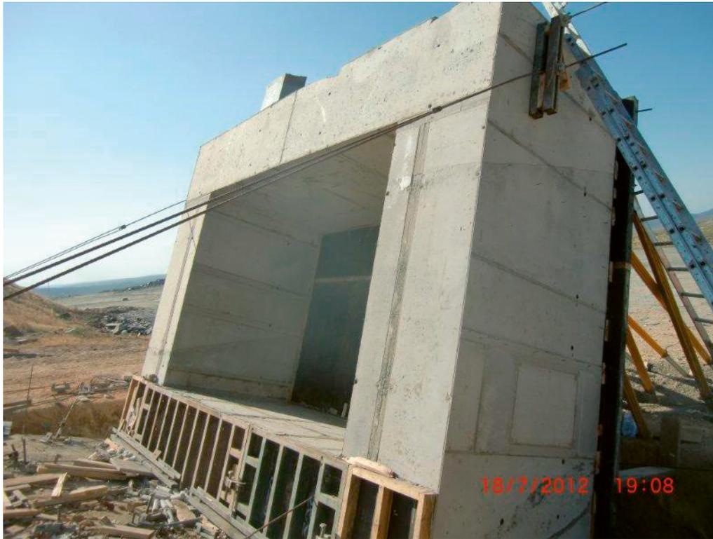
Figura 10. Dovela de prueba desencofrada.
