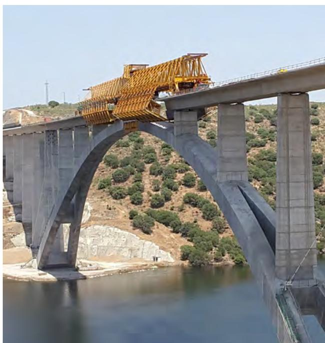
Figura 17. Cierre del encofrado en la cimbra sur.
