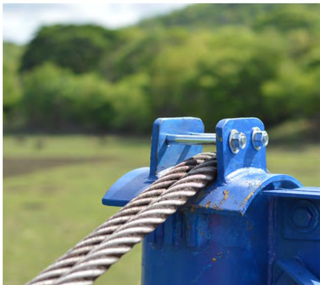
Figura 12. Detalle del anclaje en cabeza de torres.
