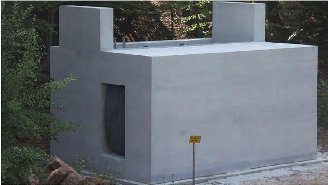
Fig. 10. Edificio experimental de hormigón infraligero (2014) [10].
