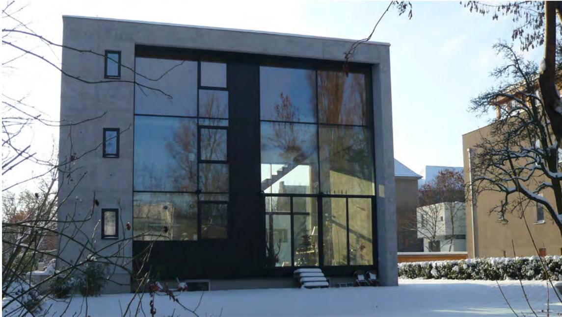
Fig. 1. Casa construida con hormigón infraligero en Berlín-Pankow (2007).
