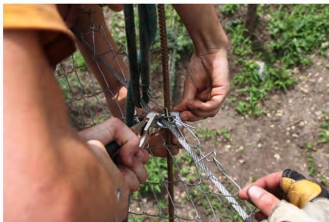
Figura 15. Detalle de conexión de la malla metálica a la péndola en la pasarela Monte Verde.
