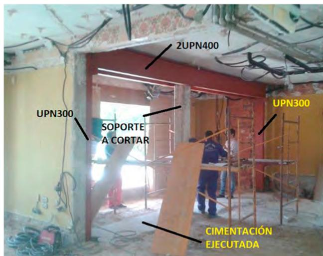
Figura 7. Estructura del puente antes de la operación de transferencia de cargas del pilar a la viga metálica.
