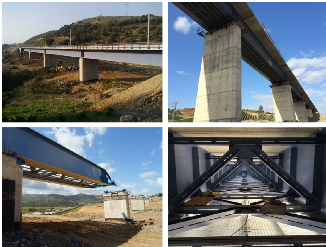
Figura 13. Vistas generales de los viaductos.
