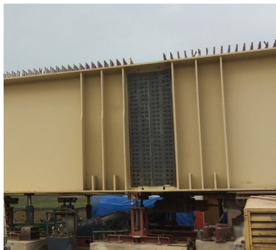
Figura 8. Unión provisional del tablero para el empuje entre tramo 2 y 3.
