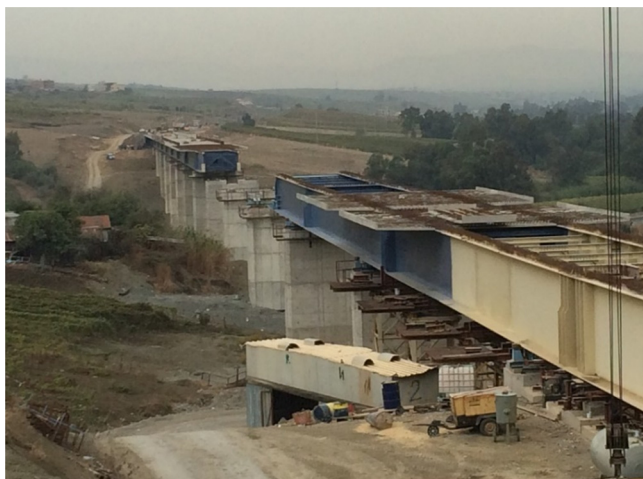
Figura 7. PK 24 empuje uno acabado y realizando empuje 2.
