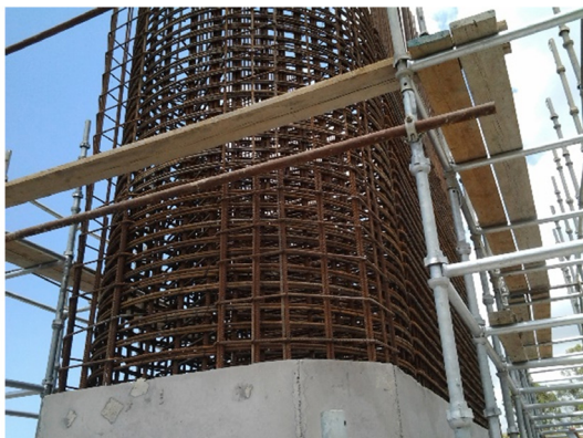
Figura 4. Detalles de armado en pila tipo.
