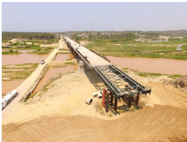
Figura 3. El tablero durante el empuje.
