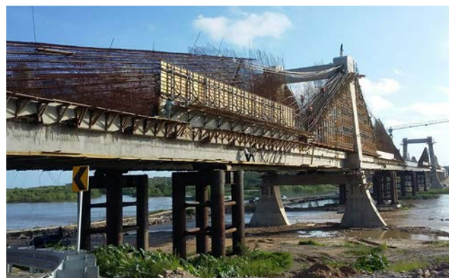
Figura 9. Las velas durante la construcción.
