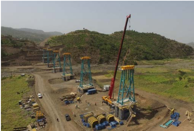
Figura 4. Izado de los capiteles.
