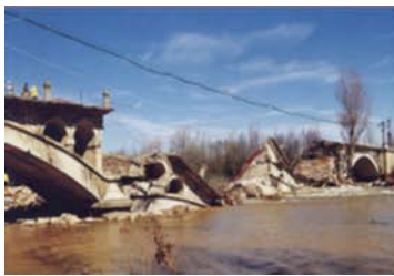
Figura 19. Esquema de la formación de un mecanismo de colapso por giro de una pila en el puente de Veguellina de Órbigo, León (construido en 1945).
