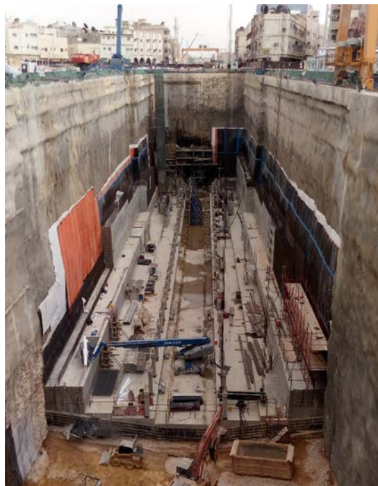
Figura 19. Módulos 1 a 3 de la contrabóveda finalizados.
