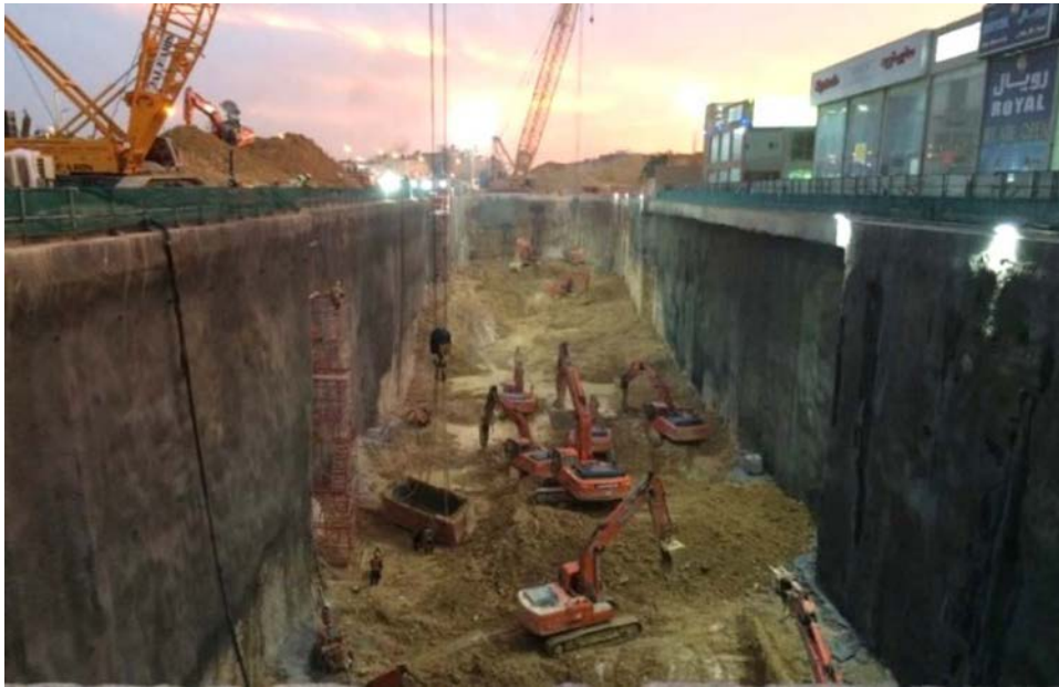
Figura 5. Trabajos de excavación en una estación profunda.
