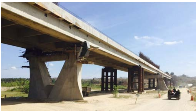
Figura 12. Los topes transversales en las pilas durante el empuje.
