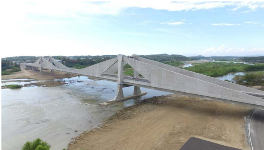
Figura 1. Vista general del puente.
