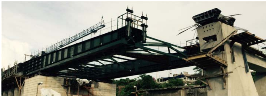
Figura 11. Vista de la nariz y de los balancines durante el empuje.
