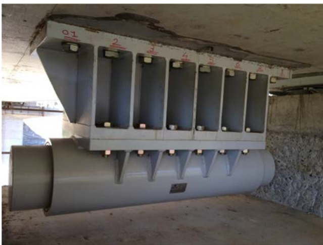
Figura 8. Ejemplo de dispositivo sísmico tipo PDS.
