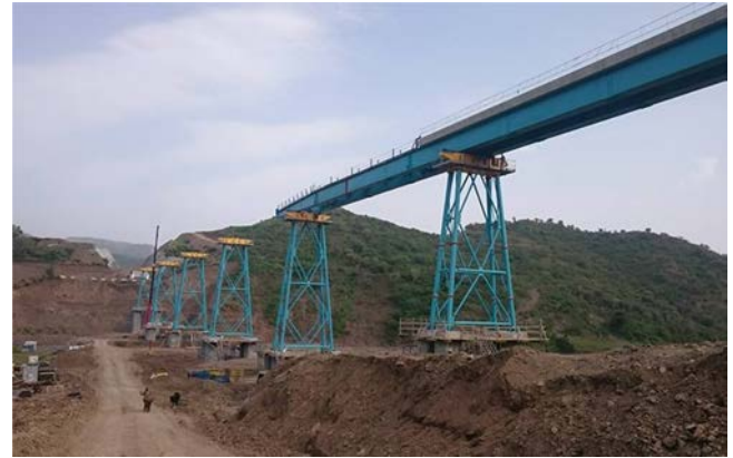
Figura 5. Fase de empuje de un viaducto de 8 vanos.
