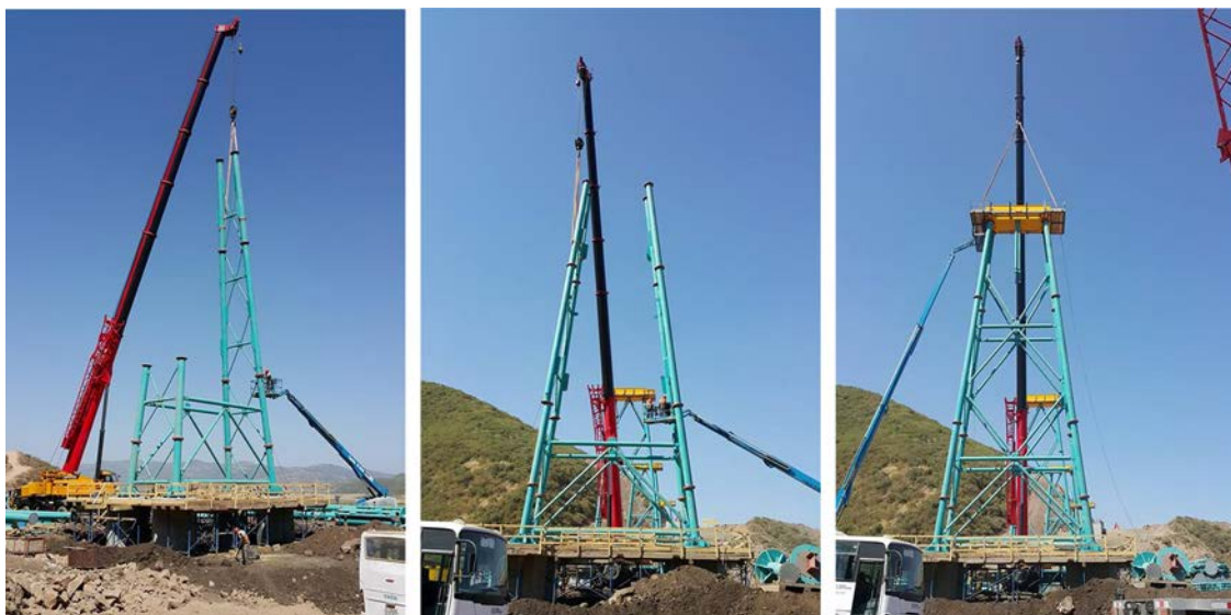
Figura 3. Montaje de las pilas in situ.
