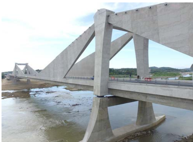
Figura 7. Torres de atirantamiento.
