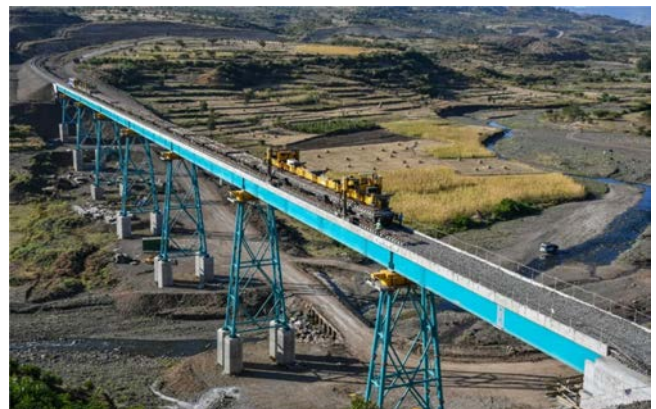
Figura 6. Viaducto de 8 vanos.
