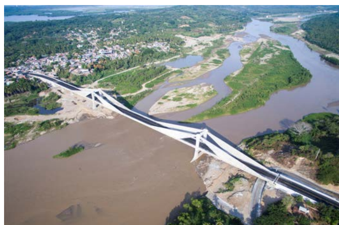
Figura 14. Vista aérea del puente terminado.
