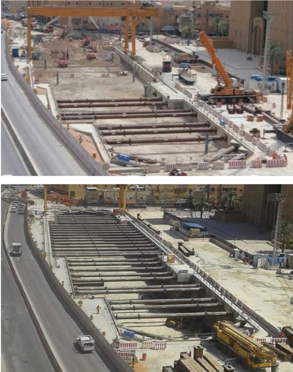
Figura 7. Diferentes fases de excavación de la estación 3E1.
