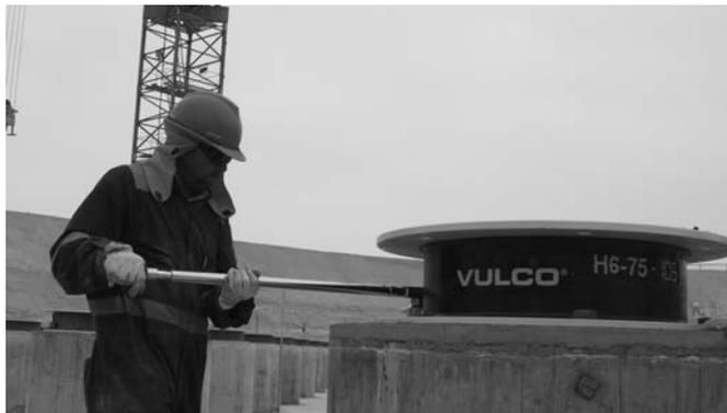
Figura 11. Apriete de los pernos inferiores de anclaje.
