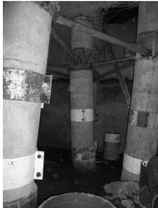
Figura 14. Pilotes inclinados.
