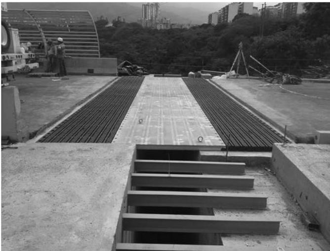
Figura 8. Vista de la junta durante su instalación.
