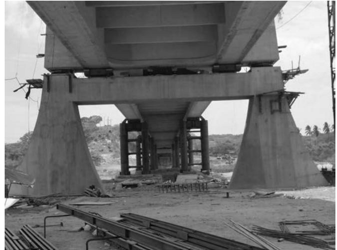
Figura 14. Vista de la torre 5, donde se aprecia el amortiguador transversal y los apoyos pendulares.
