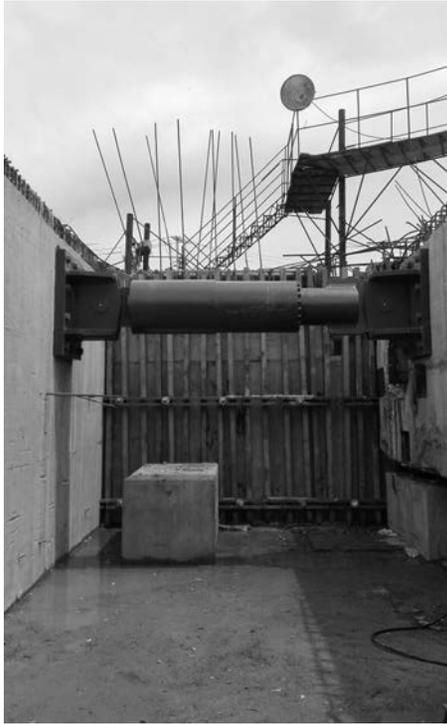
Figura 13. Vista de uno de los amortiguadores longitudinales del estribo 1.
