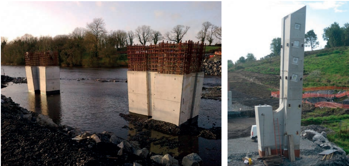
Figura 12. Vista de los pilonos en ejecución.
