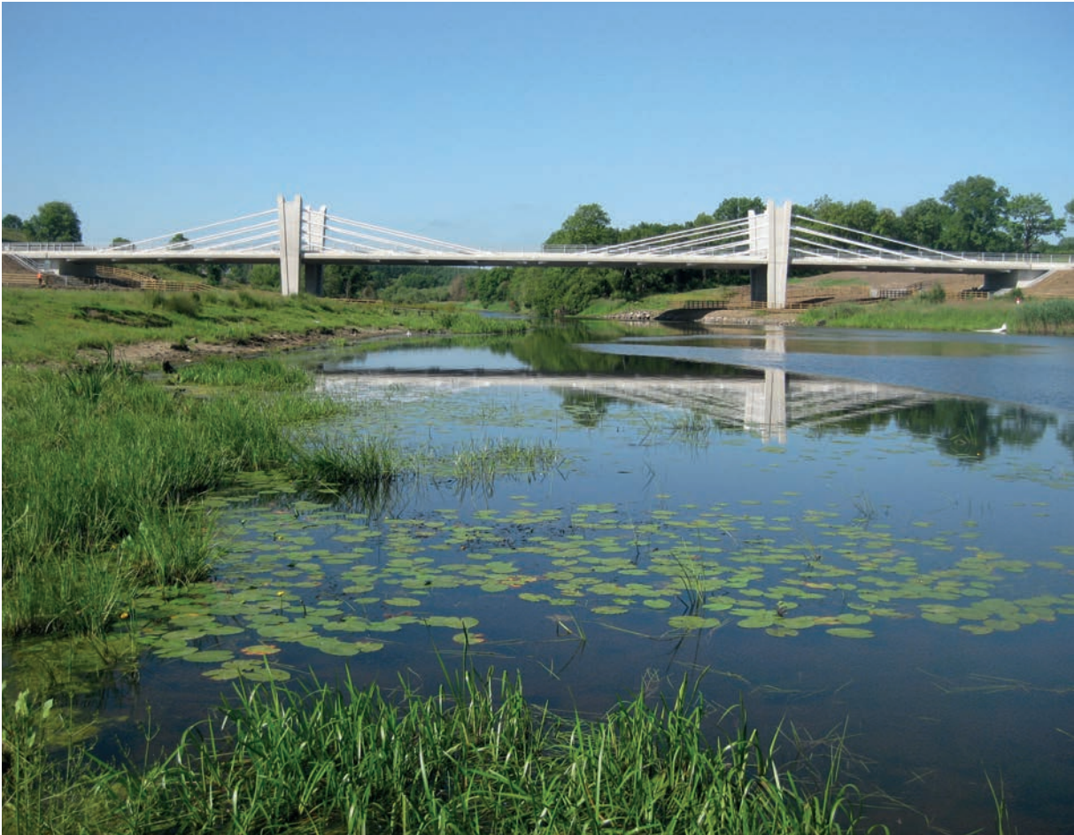
Figura 18. Acabado final del puente.
