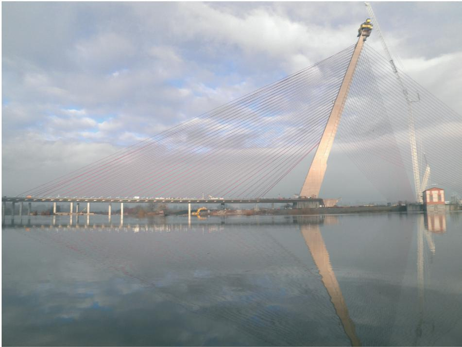
Figura 39. Construcción del pylon, tesado de cables y eliminación de pilas según avance del tesado
