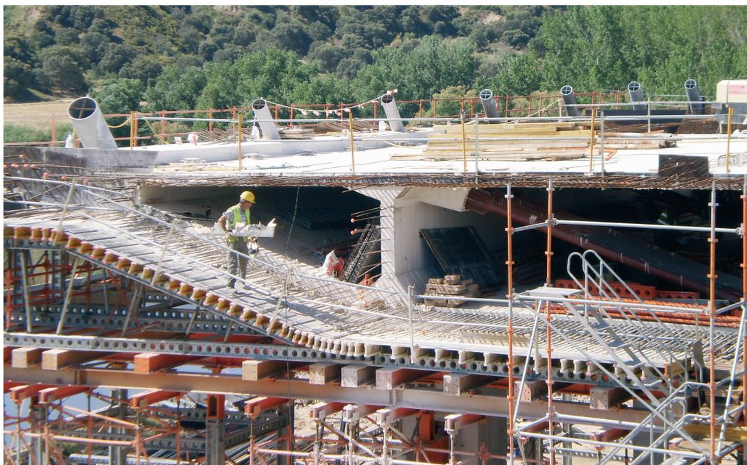
**Figura 5.** Diagonales del diafragma colocadas en hueco rectangular de la sección
