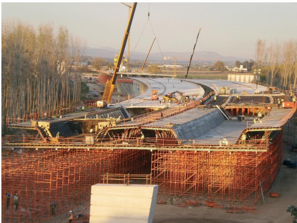
**Figura 37.** Frente de avance de los tableros gemelos del viaducto. Construcción por vanos sucesivos
