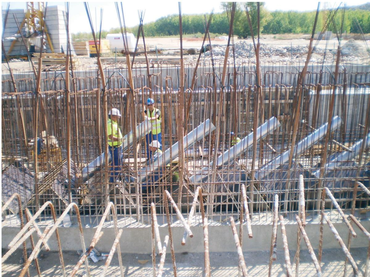
Figura 30. Salida de tubos guía de los muertos de anclaje
