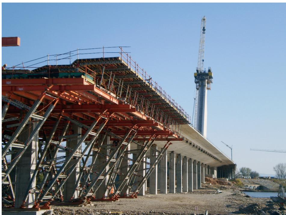
Figura 38. Frente de avance de tablero con ejecución simultánea de pilono
