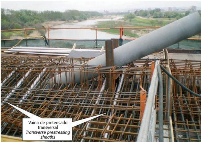
Figura 9. Vainas de pretensado transversal en la salida del tirante
