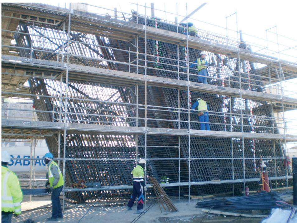
Figura 40. Célula metálica y ejecución de ferrallado a nivel de suelo para su posterior izado
