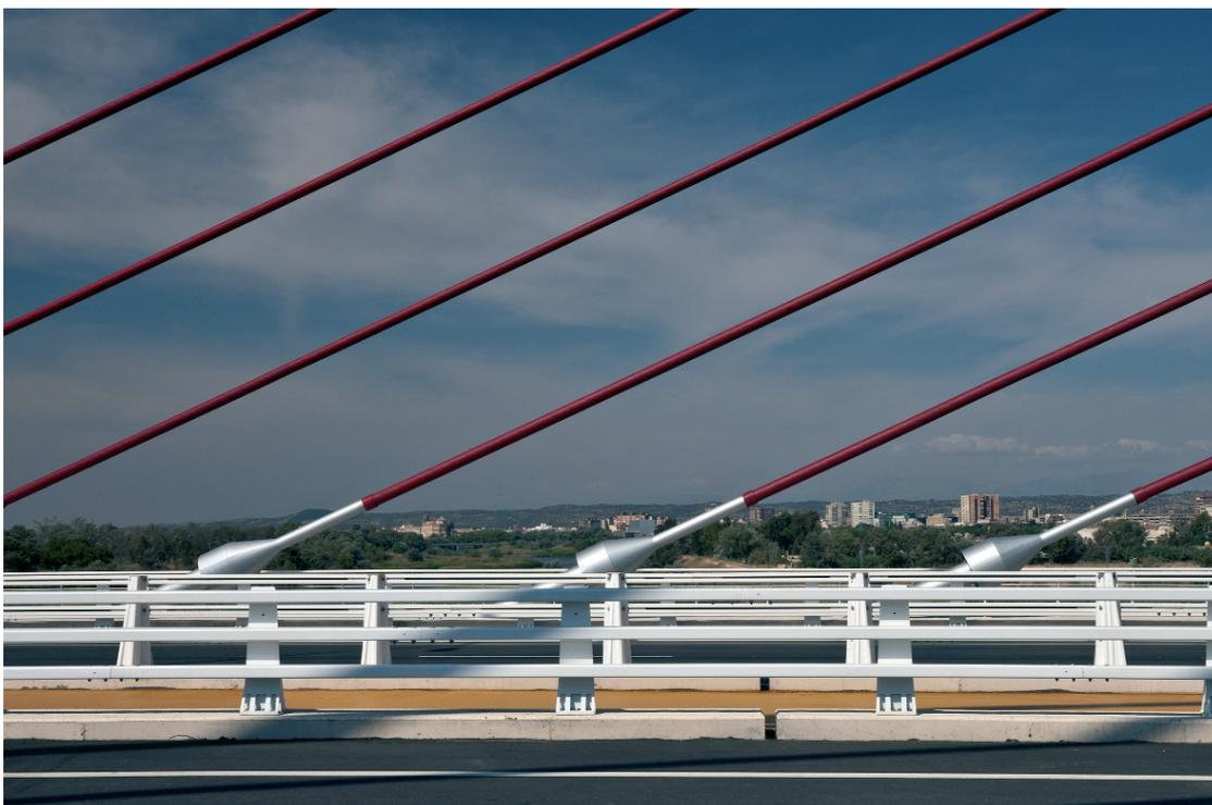
Figura 16. Tirantes separados longitudinalmente cada 7,00 metros en el tablero
