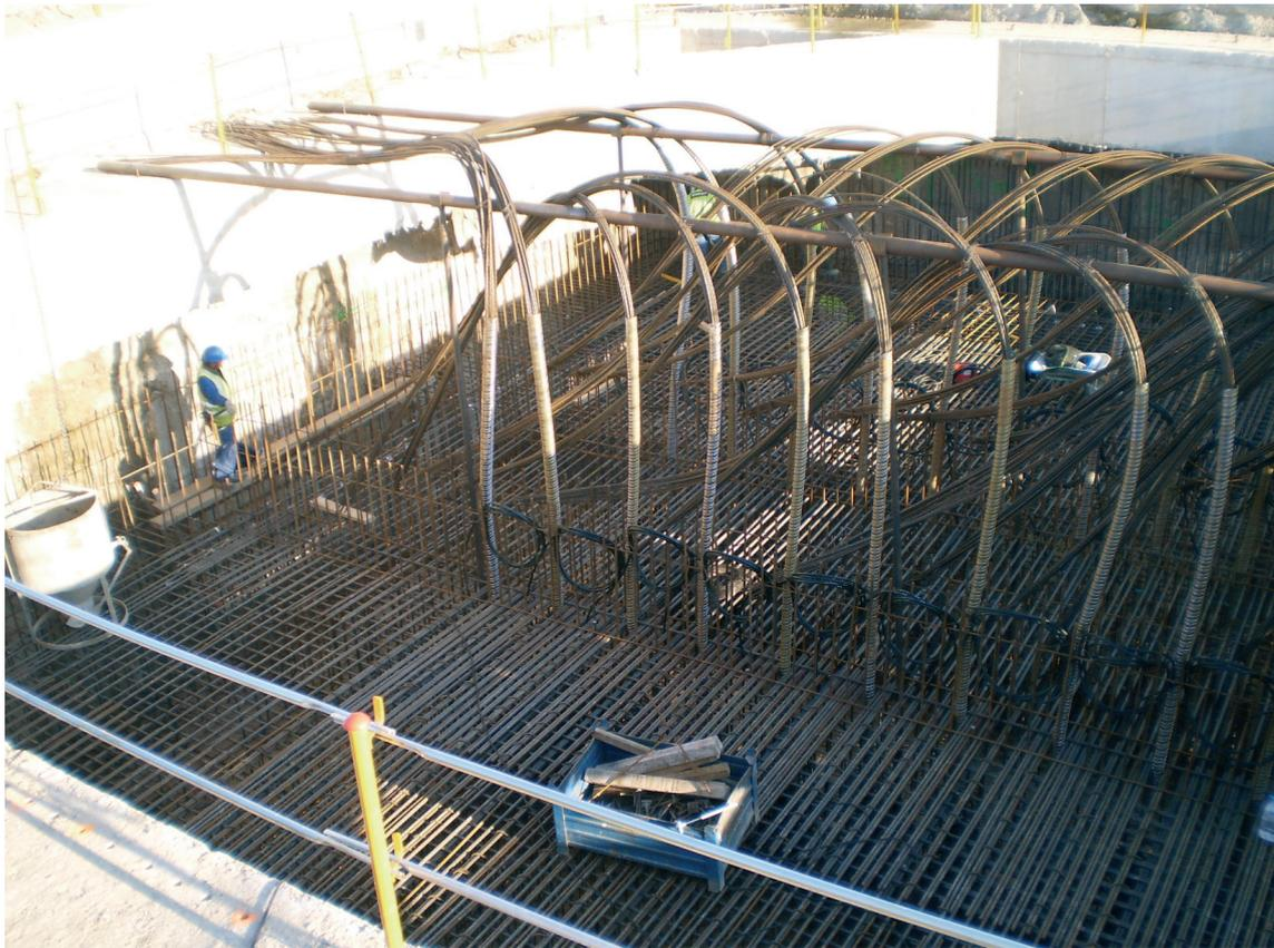
Figura 33. Muerto de anclaje. Armado de losa inferior y pretensados verticales
