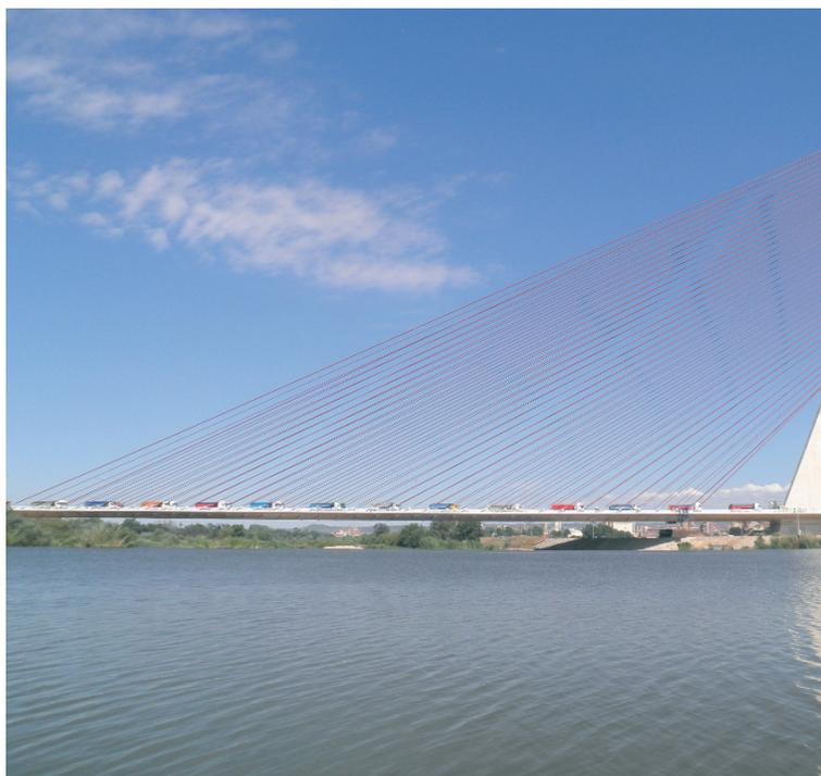
Figura 44. Prueba de carga
