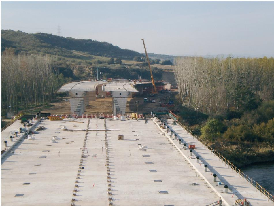
**Figura 36.** Avance del tablero del puente atirantado. Al fondo, los tableros del viaducto de acceso
