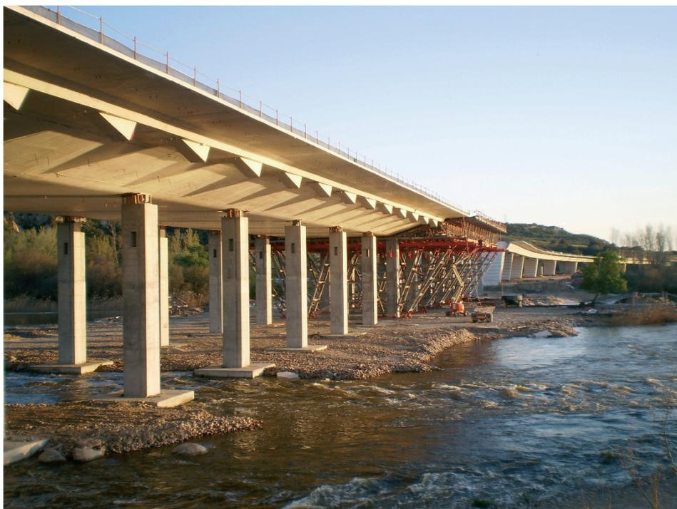
Figura 34. Tablero apoyado sobre pilas provisionales. Al fondo el viaducto de acceso
