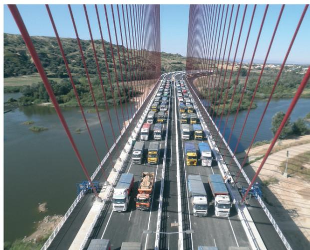
Figura 45. Fase de máxima carga en la prueba de carga
