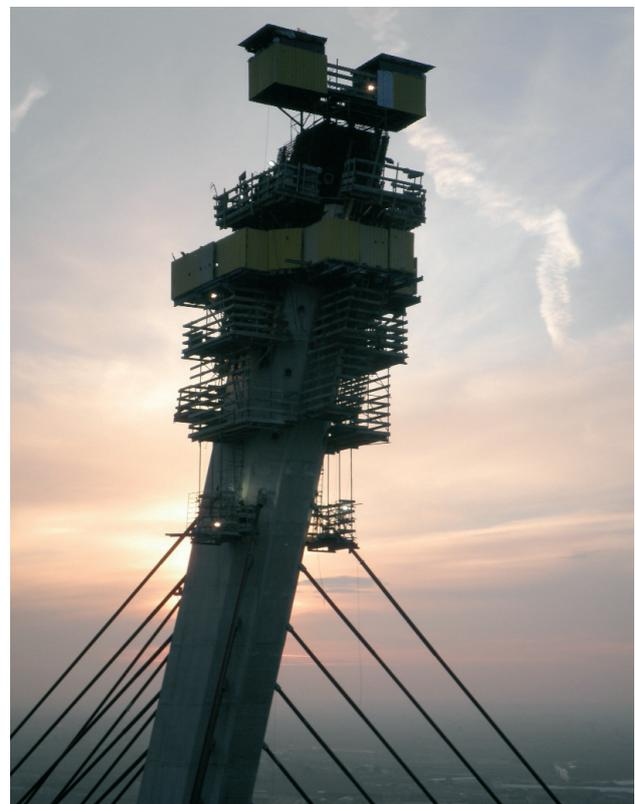
Figura 20. Encofrado autotrepante
