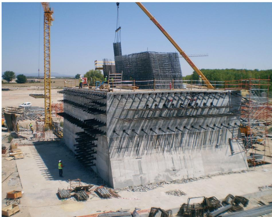
Figura 26. Mamparo en hormigón gris. Arranque de armado de pilono y pretensado transversal del mamparo
