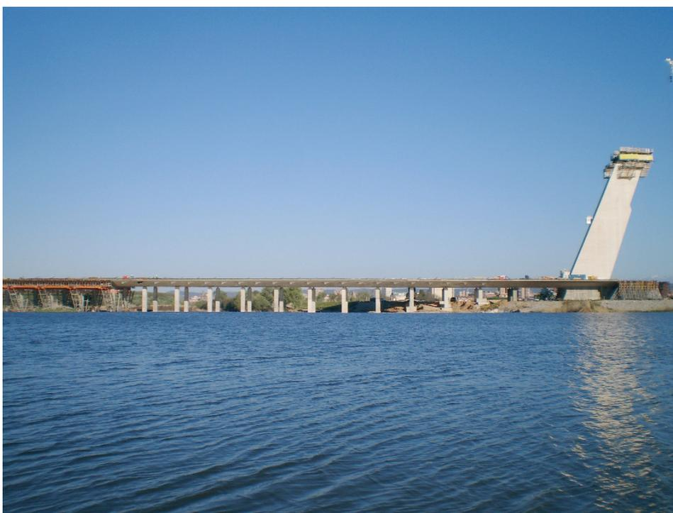
Figura 35. Tablero apoyado sobre pilas provisionales y pilono antes de colocar los cables
