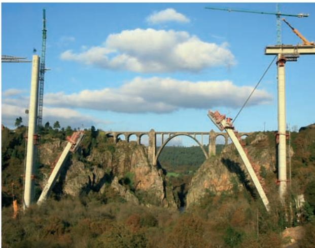
Figura 8. Alzado del arco en construcción
