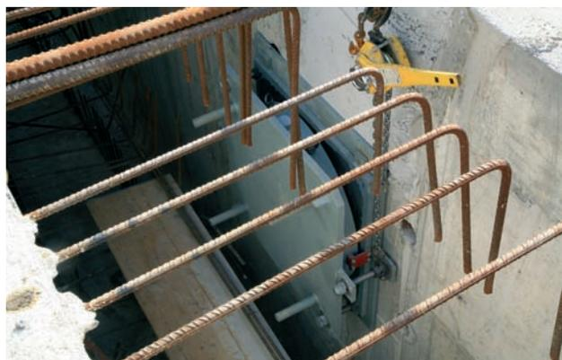
Figura 26. Apoyo POT instrumentado en estribo E1
