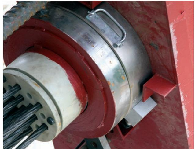
Figura 24. Célula de carga en anclaje pasivo de un tirante
