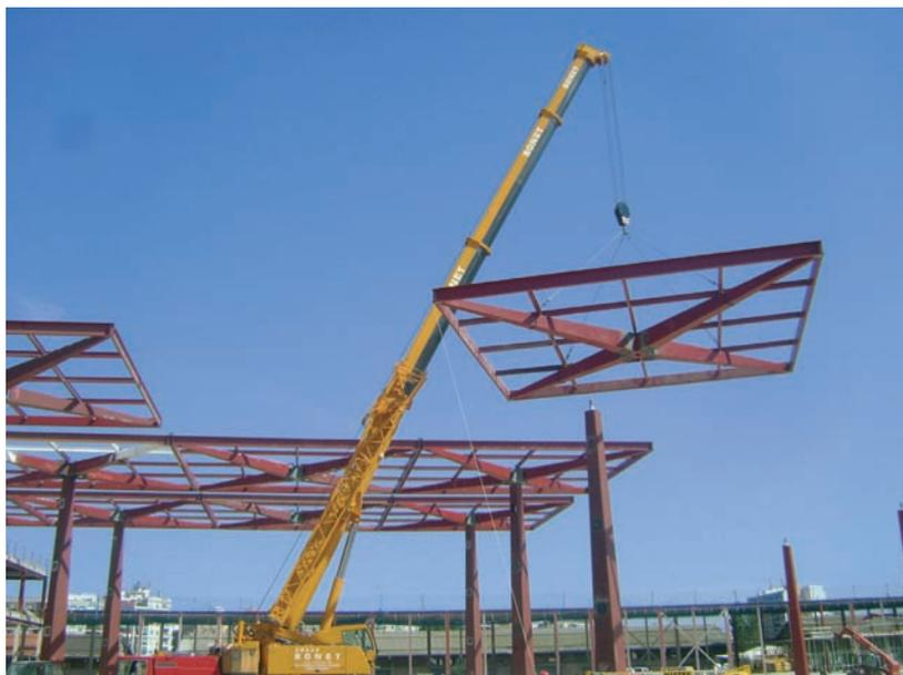
Figura 14. Montaje de un módulo mediante grúa
