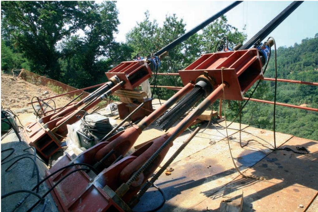
Figura 22. Estructura de transferencia en anclaje de retenida
