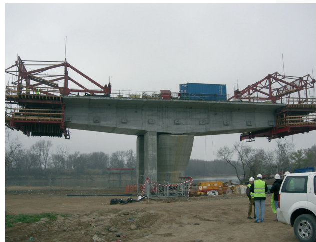
Figura 23. Avance en voladizo simétrico
