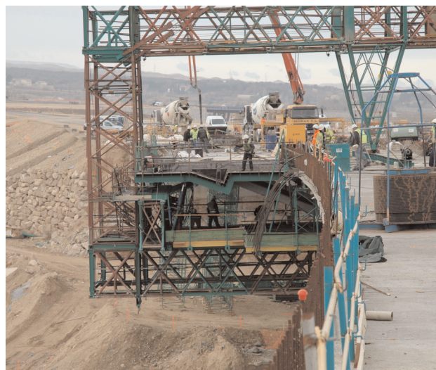
Figura 26. Detalle de brazo de encofrado 2ª fase
