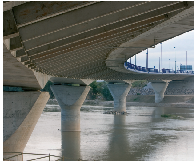
Figura 34. Vista inferior de tablero con drenaje
