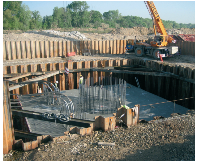
Figura 18. Encepado de pilas
