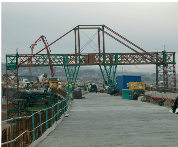
Figura 25. Carro de encofrado de voladizos
