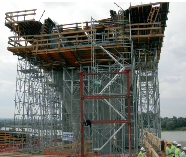
Figura 21. Cimbra de dovela 0
