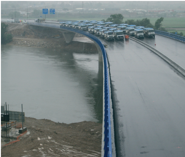
Figura 33. Prueba de carga
