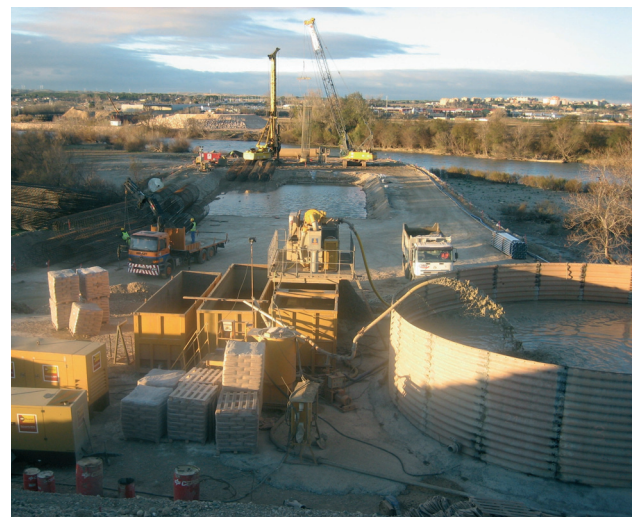
Figura 16. Balsa de lodos para ejecución de pilotes
