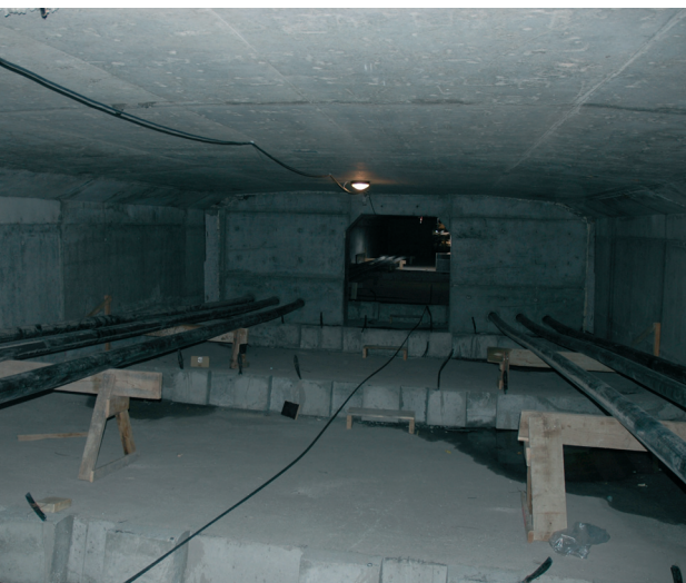
Figura 31. Montaje de vainas de pretensado exterior
