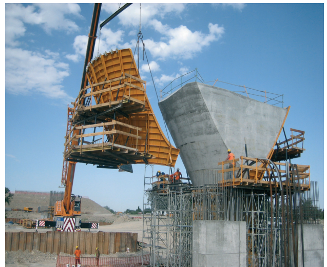
Figura 20. Encofrado de capitel
