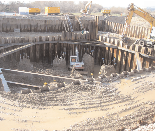
Figura 17. Doble Recinto de tablestacas
