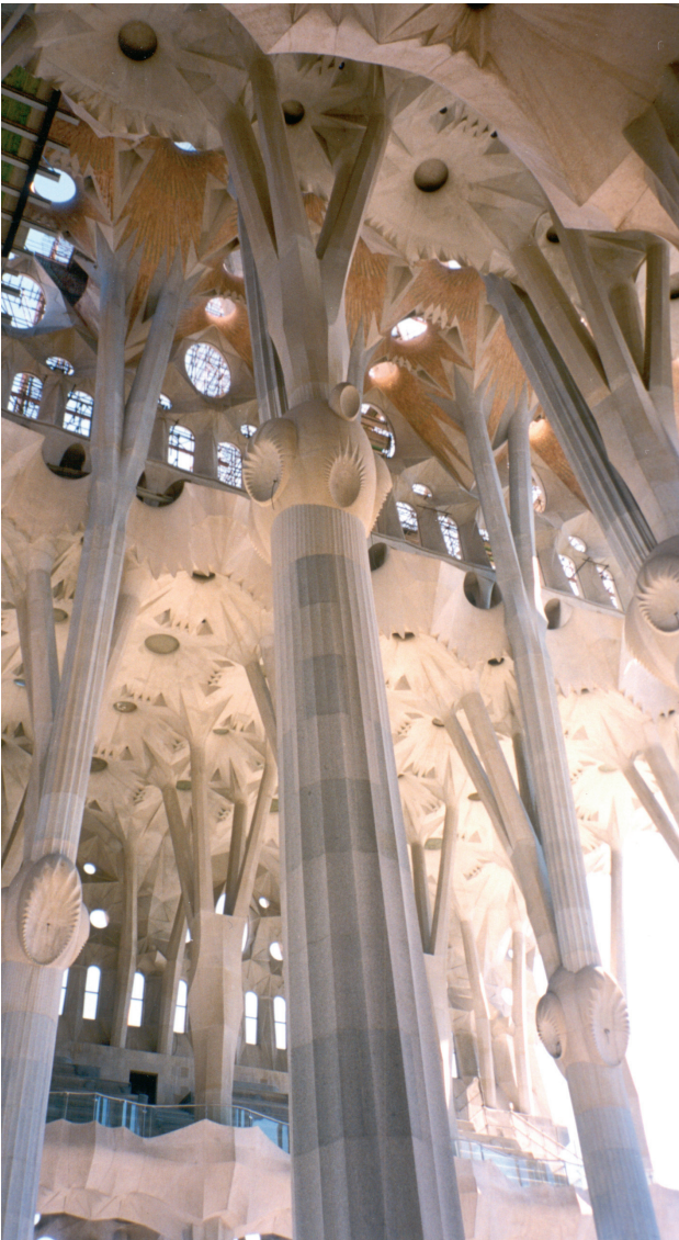
Figura 2. Cubiertas de las naves del cuerpo principal. Fuente: ATEFSF
