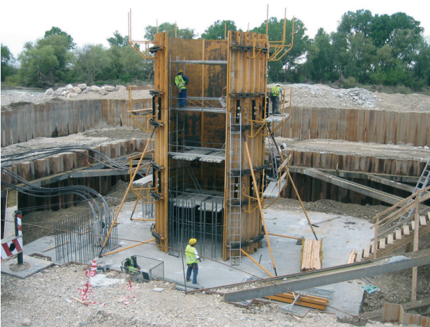
Figura 19. Encofrado de fuste
