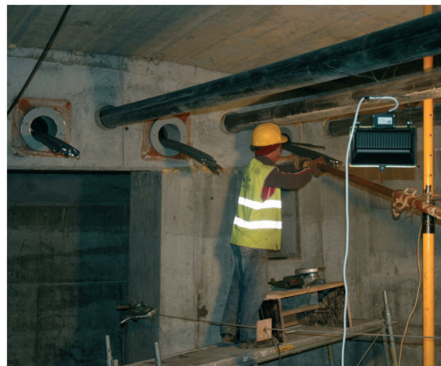
Figura 32. Enfilado de pretensado exterior
