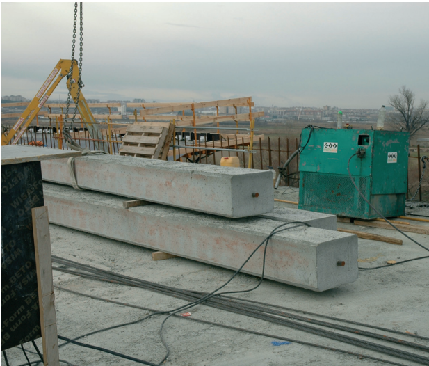
Figura 28. Jabalcones acopiados sobre el tablero
