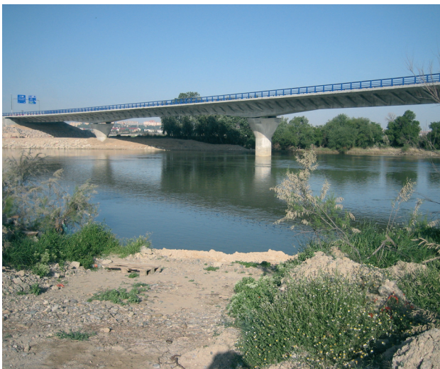
Figura 36. Vista del viaducto terminado
