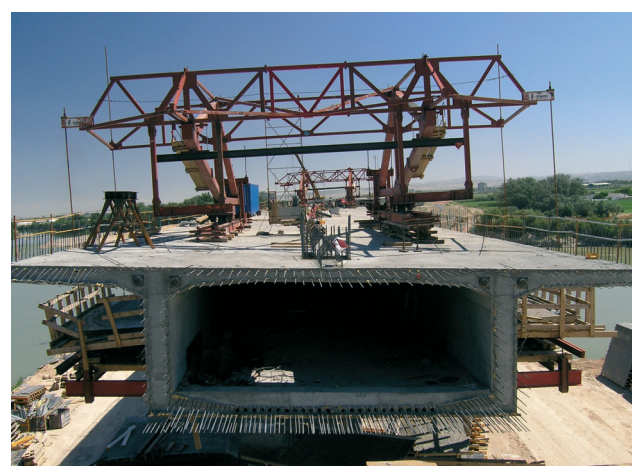
Figura 24. Vista del núcleo en 1ª fase
