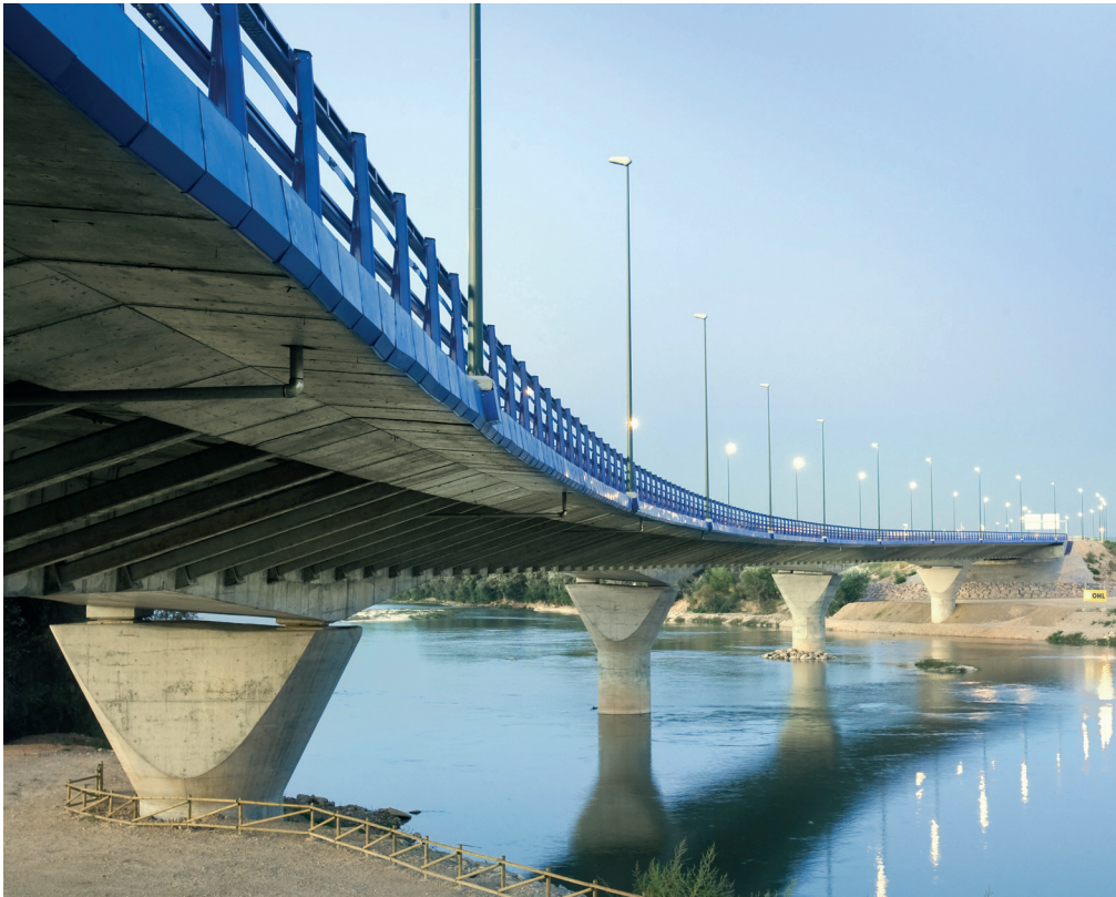
Figura 37. Vista del viaducto terminado
