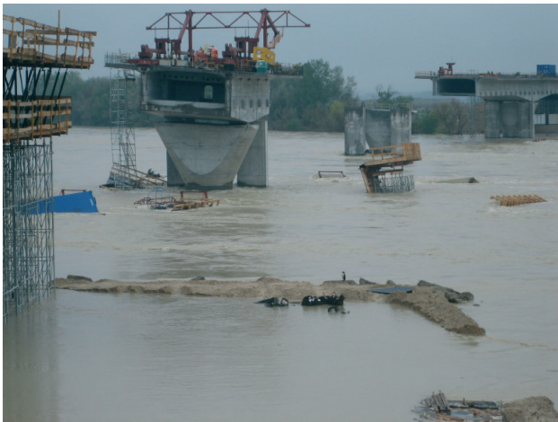
Figura 35. Riada durante construcción
