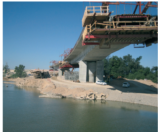
Figura 22. Avance en voladizo
