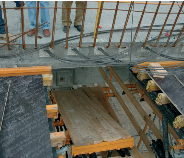
Figura 30. Vista del voladizo lateral del núcleo en 1ª fase
