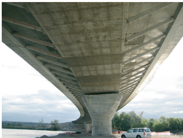
Figura 9. Tablero. Vista inferior
