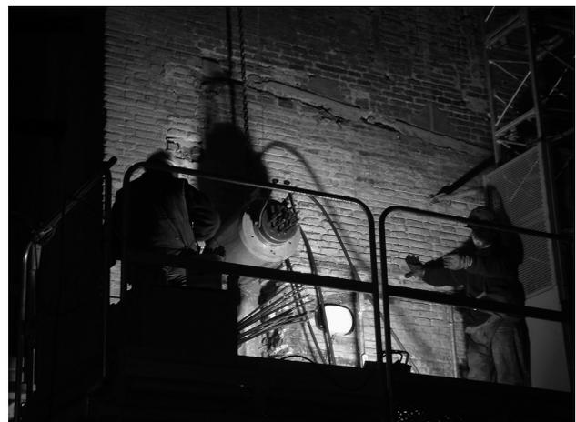
Figura 28. Ejecución del tesado del muro perimetral.
