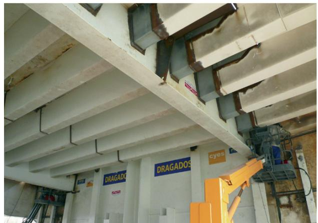
**Figura 35.** Unión entre tramos nuevos y existentes.
