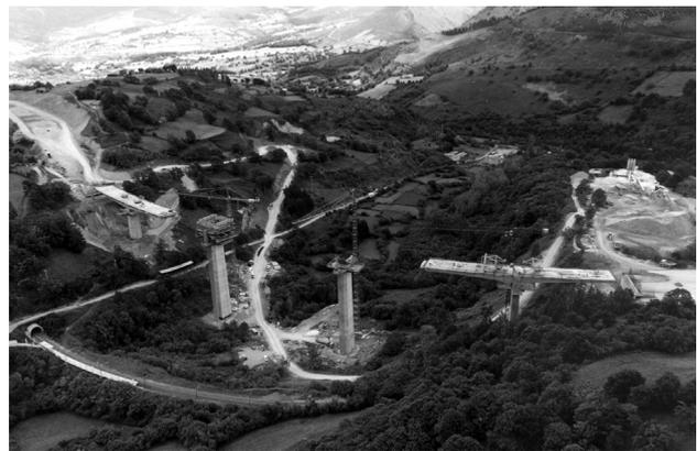
Figura 6. Construcción de la T de la pila 2.
