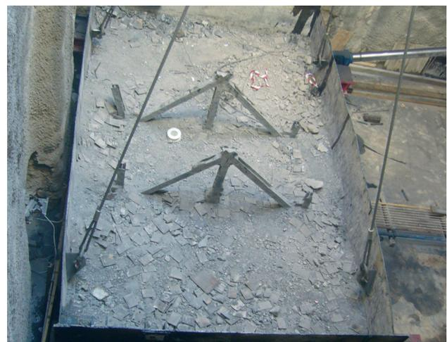
**Figuras 27 y 28.** Vaciado con retroexcavadora y descenso del contrapeso.
