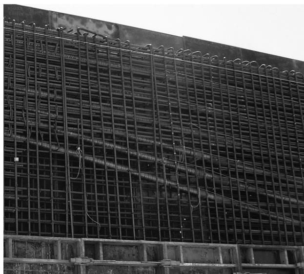
Figura 9. Vainas y armadura del muro lateral.
