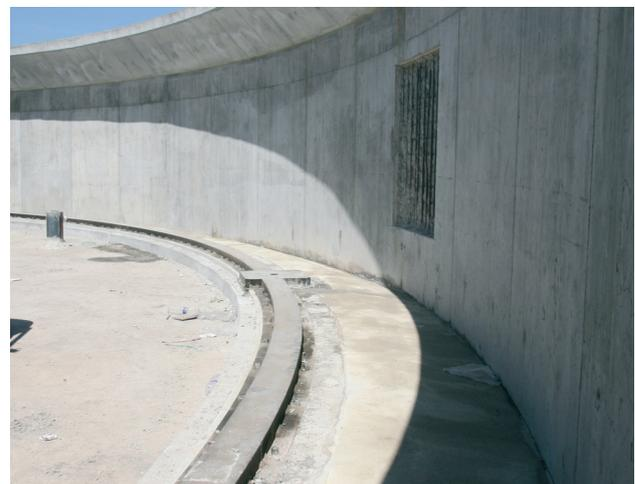
Figura 19. Carril de rodadura.
