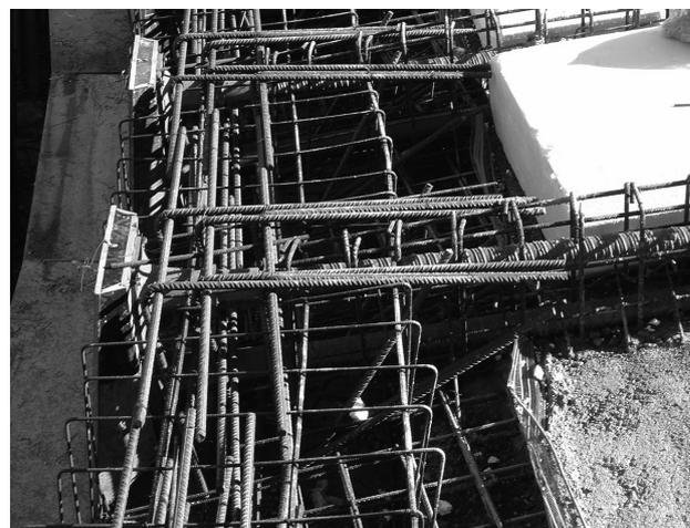
Figura 6. Detalle del anclaje pasivo.
