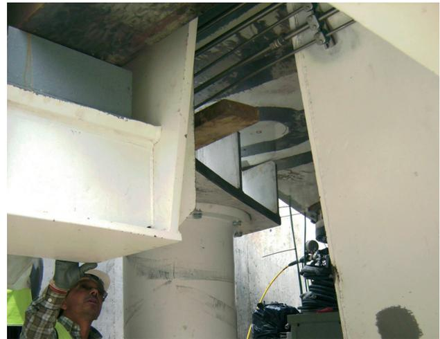
Figura 39. Colocación de patas de apoyo.
