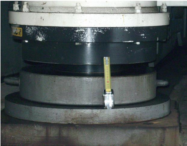
Figura 14. Pata de apoyo dorsal del puente.
