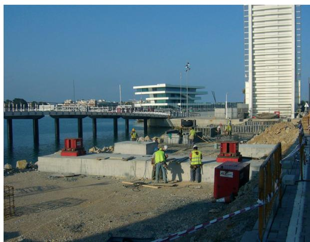
Figura 26. Ejecución de apeos sobre el relleno de la bocana.
