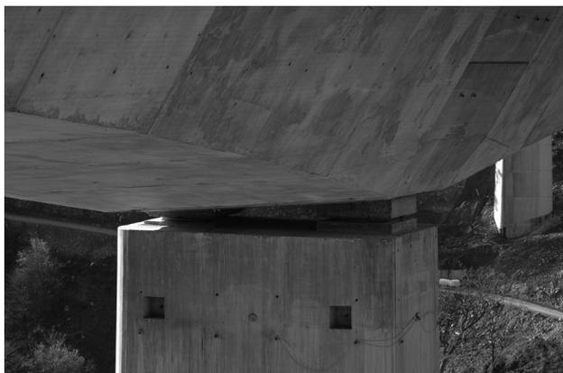
Figura 14. Detalle del apoyo del tablero sobre la pila.
