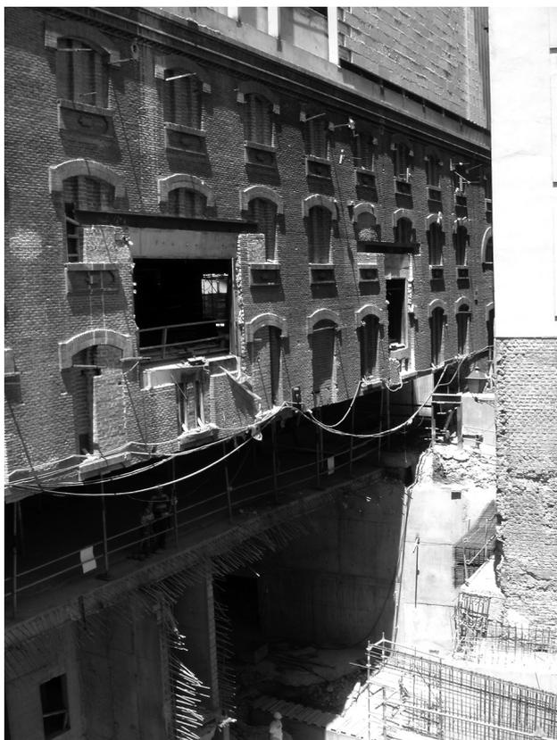
Figura 25. Muro perimetral postesado una vez desapareado.
