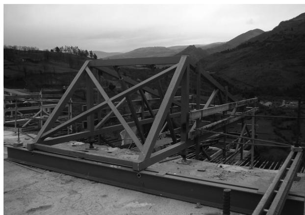
Figura 10. Carro para hormigonado de nervios laterales.
