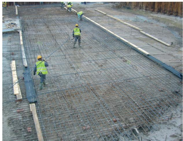
Figura 24. Ejecución de losas de solera.
