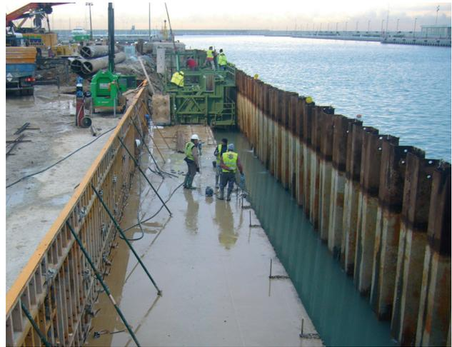
Figura 23. Ejecución del nuevo pretil del muelle
