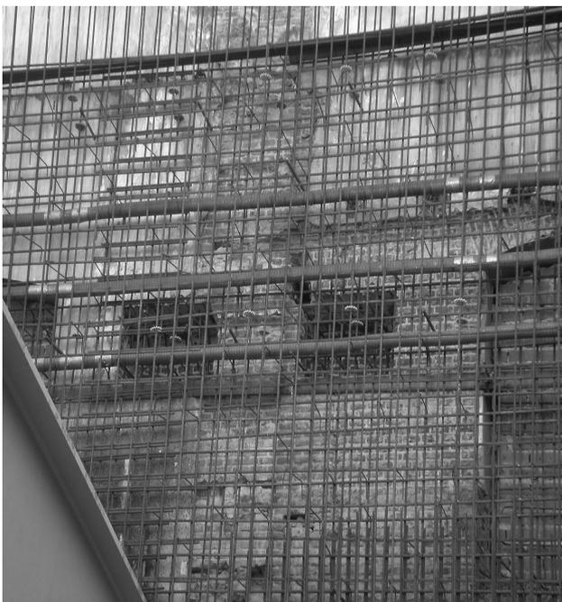
Figura 27. Colocación de las vainas de postesado en el muro perimetral.
