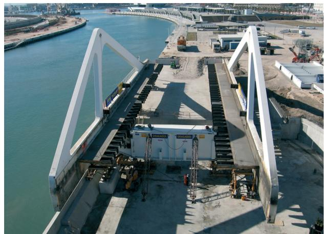
**Figura 34.** Semihojas en posición antes de incorporar los nuevos tramos centrales de 10 m. de anchura.
