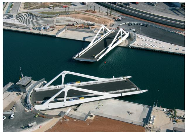
Figura 10. Movimiento de la hoja. Tableros isostáticos.
