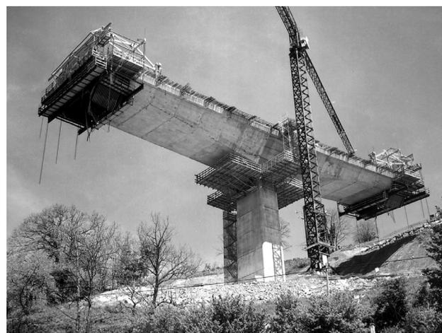
Figura 15. Construcción de la T de la pila 1.
