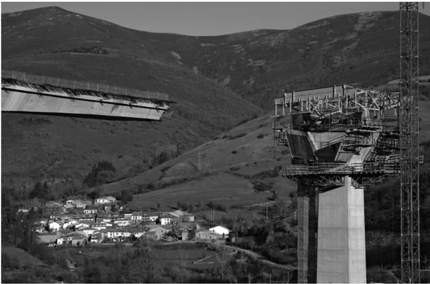
Figura 5. Montaje de carros de avance sobre dovela 0.
