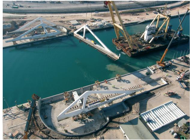
**Figuras 32 y 33.** Traslado con grúa flotante de las semihoja.
