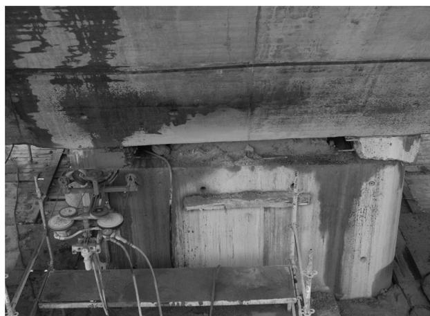
Figura 9. Corte de bloqueo provisional de pila.
