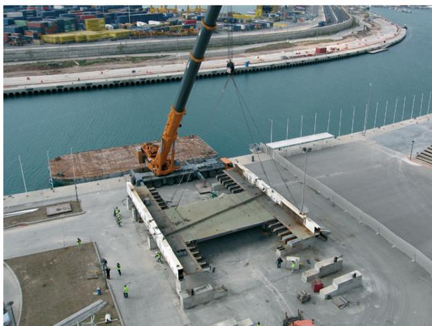
Figura 36. Traslado de los tramos de clave después del montaje en blanco.
