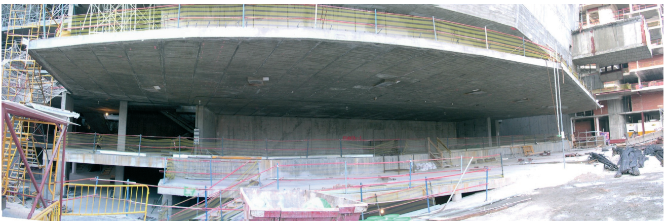
Figura 11. Vista inferior de la gran losa volada del Teatro Principal.
