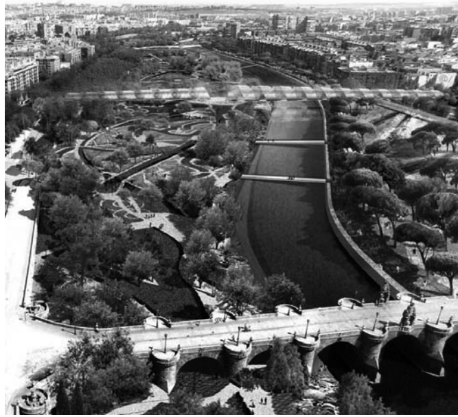
Dominique Perrault-MC2. Pasarela de la Arganzuela . Madrid.
