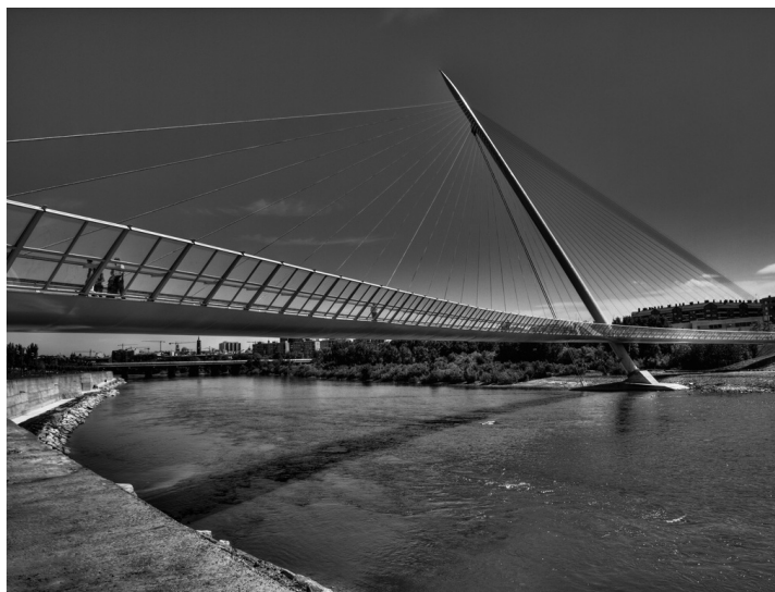
Pasarela de la Almozara sobre el río Ebro (2008; Javier Manterola) Zaragoza (España).
