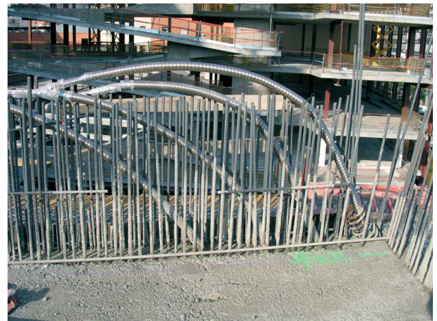
Figura 10. Pretensado de pantallas laterales del Teatro Principal
