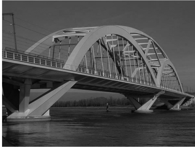
Marc Minram (Arq.) Bureau Greisch. Puente de Garde-Adhemar. TGV Sud. Francia, 2000.
