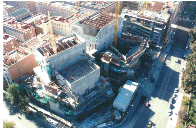
Figura 17. Teatros en construcción. En primer plano el Teatro Configurable.
