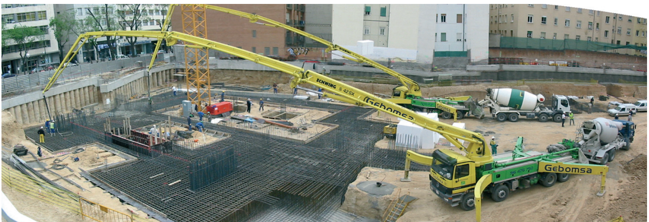
Figura 32. Hormigonado de la losa de cimentación del Teatro Configurable. Figure 32. Configurable Theatre foundation concreting.
