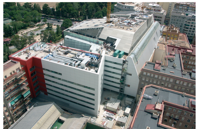
Figura 43. Vista lateral del edificio. Figure 43. Lateral view.
