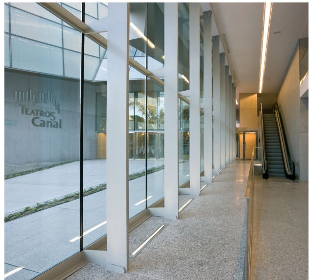
Figura 30. Fachadas inferiores terminadas. Figure 30. Lower façades.
