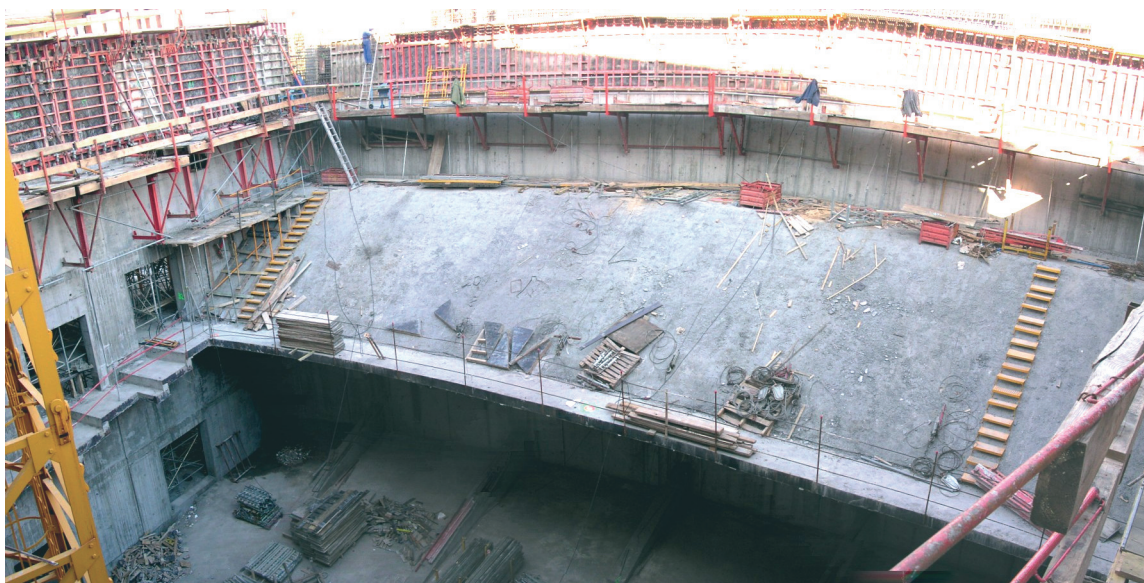
Figura 13. Vista superior del sistema estructural que conforma el anfiteatro. Figure 13. Amphitheatre structure upper view.
