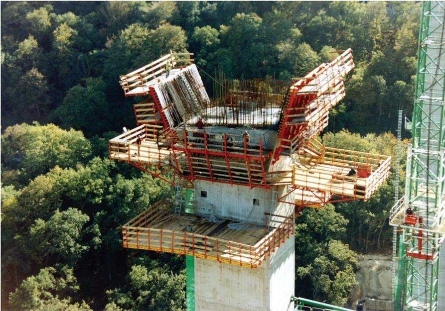
Figura 25. Ejecución de la dovela "0".
