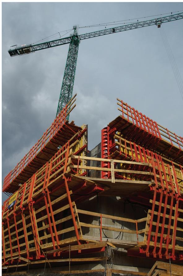
Figura 23. Detalle de autotrepa.
