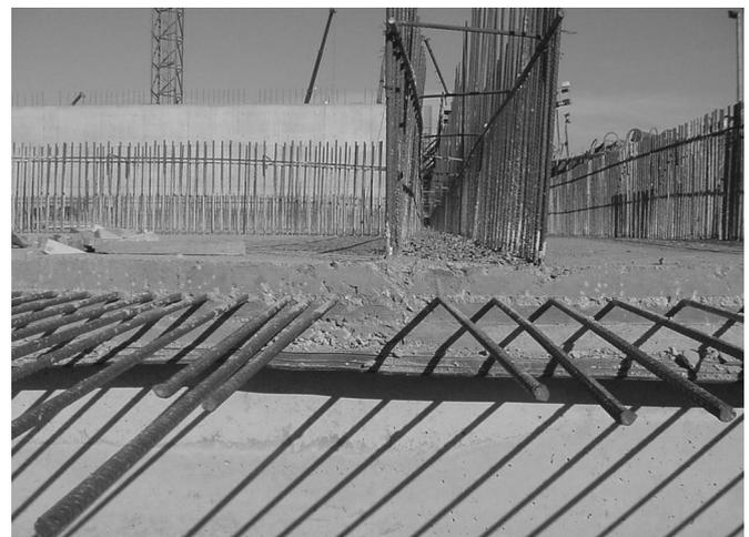
Figura 10. Vista del canto de la losa D-2-1 Mar con algunas esperas de armadura.
