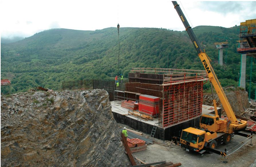
Figura 12. Ejecución de alzado de estribo 1.
