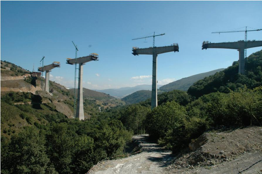
Figura 28. Avance progresivo de las "Ts" de la estructura.
