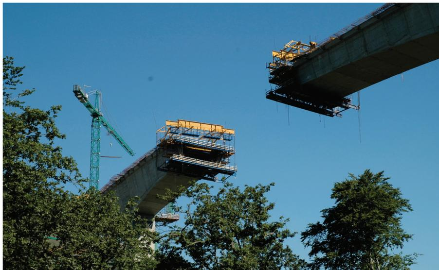
Figura 30. Detalle de carros acercándose en pilas 2 y 3.
