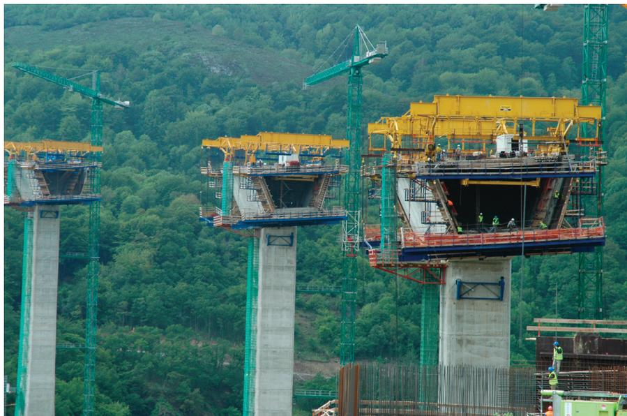
Figura 27. Ejecución de dovelas tipo mediante carros de avance.
