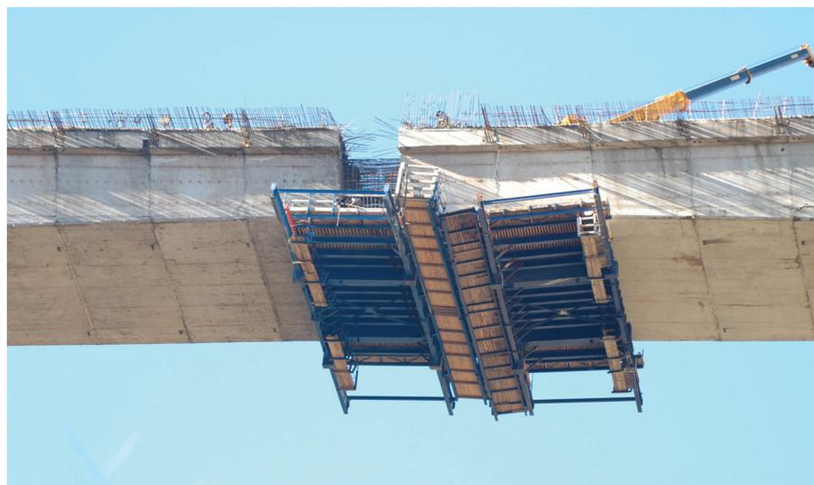
Figura 31. Vista inferior de encofrado de dovela de cierre
