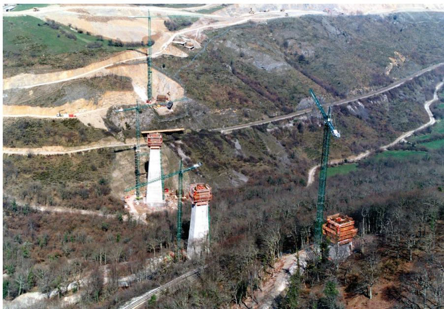
Figura 9. Vista general de ejecución de alzados de pilas.
