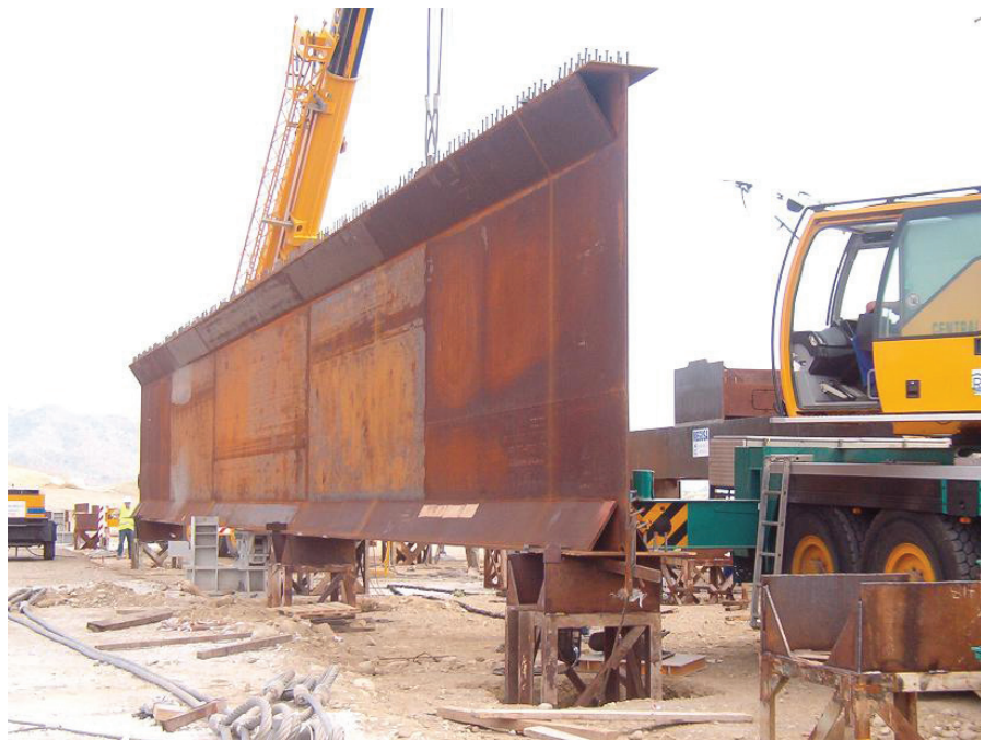
Fig. 9. Transporte y colocación de una viga metálica. Fig. 9. Transporting and placing a metal girder.
