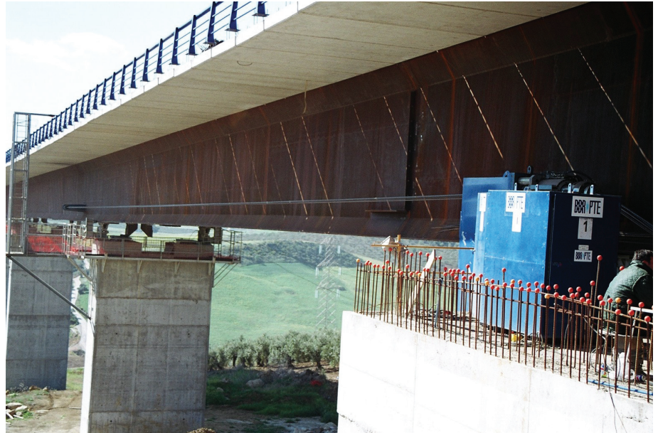
Figs. 16a y 16b. Cables de empuje (inferiores) y de retenida (superiores) del Estribo 1. Figs. 16a and 16b. Launching cables (bottom) and guy cables (top) of Abutment 1.
