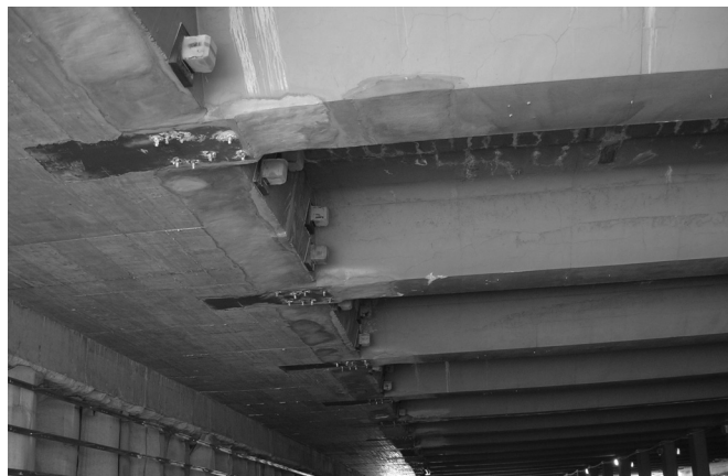
Figura 8. Detalle 2: Chapas conexión y postesado.
