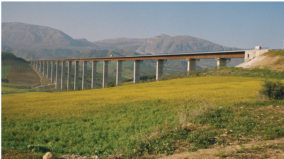
Fig. 25. Vista del viaducto concluido. Fig. 25. View of the finished viaduct.
