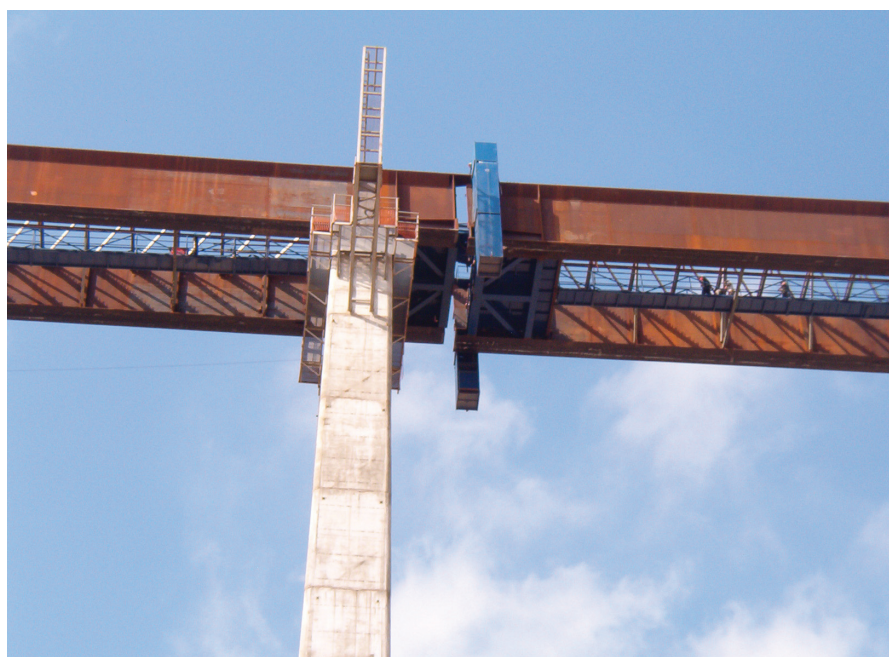
Fig. 24. Vista inferior del instante de unión de tramos. Fig. 24. Underneath view of the moment when stretches connected.
