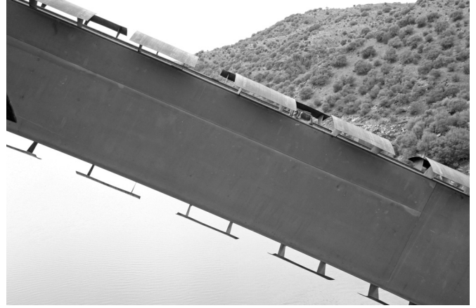
Figuras 4 y 5. Deflectores instalados en las esquinas externas de todos los arcos.
