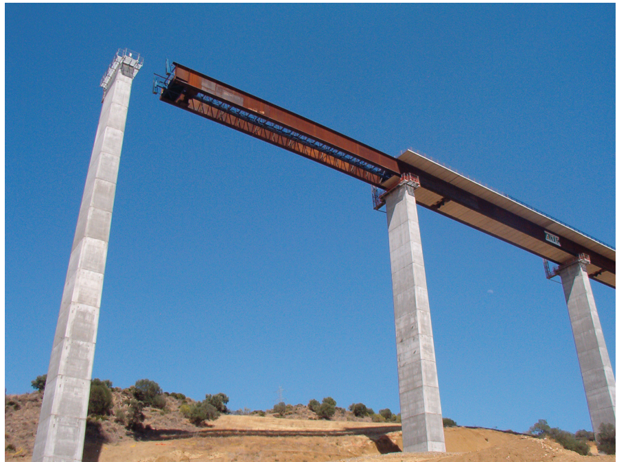
Fig. 23. Vista del voladizo antes de llegar a pila durante el empuje. Fig. 23. View of the cantilever before reaching a pier during launching.
