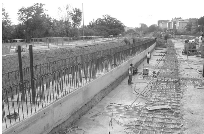
Figura 9. Viga de atado de pilotes.
