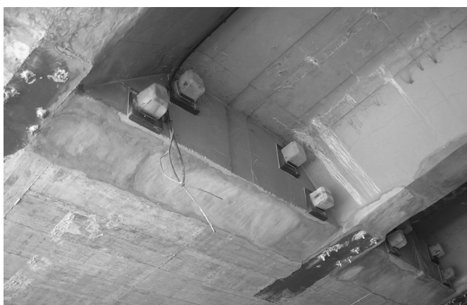
Figura 7. Detalle 1: Chapas conexión y postesado.
