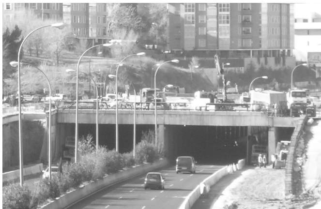
Figura 6. Solución adoptada en ejecución.
