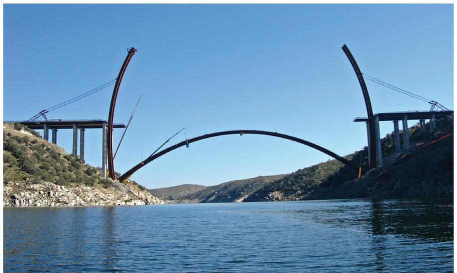
Figura 37. Semiarcos del segundo puente en posición vertical
