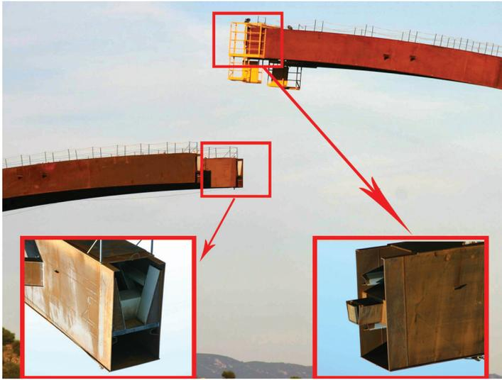
Figura 52. Sistema de enclavamiento automático en zona de clave. Esquema 1.
