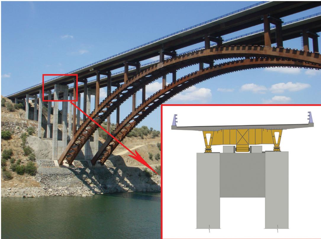
Figura 12. Diafragma para fijación transversal del tablero a la pila de arranque del arco
