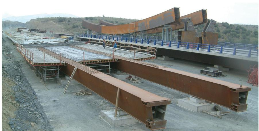
Figura 15. Construcción de tableros en tierra firme.
