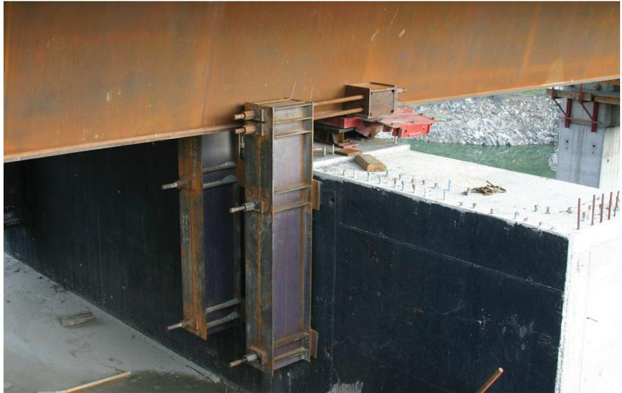
Figura 46. Sistema de fijación horizontal del tablero al estribo
