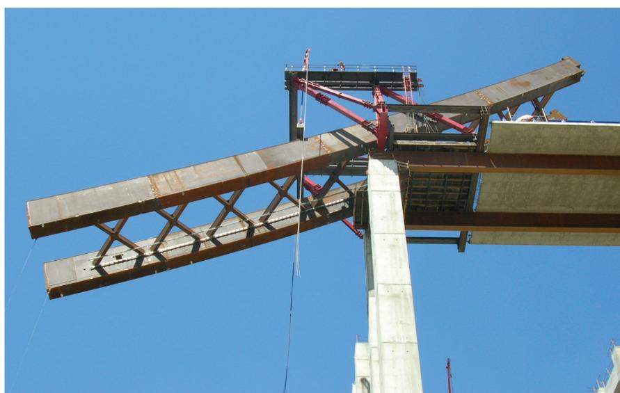
Figura 20. Basculamiento del primer cuarto de arco (2).
