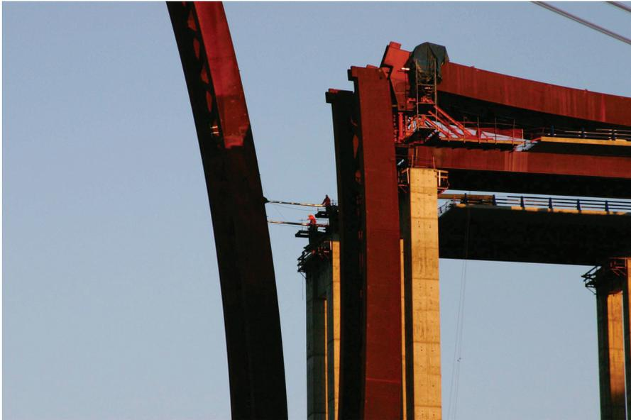
Figura 30. Inicio de la operación de abatimiento, mediante empuje de semiarco con gatos telescópicos.
