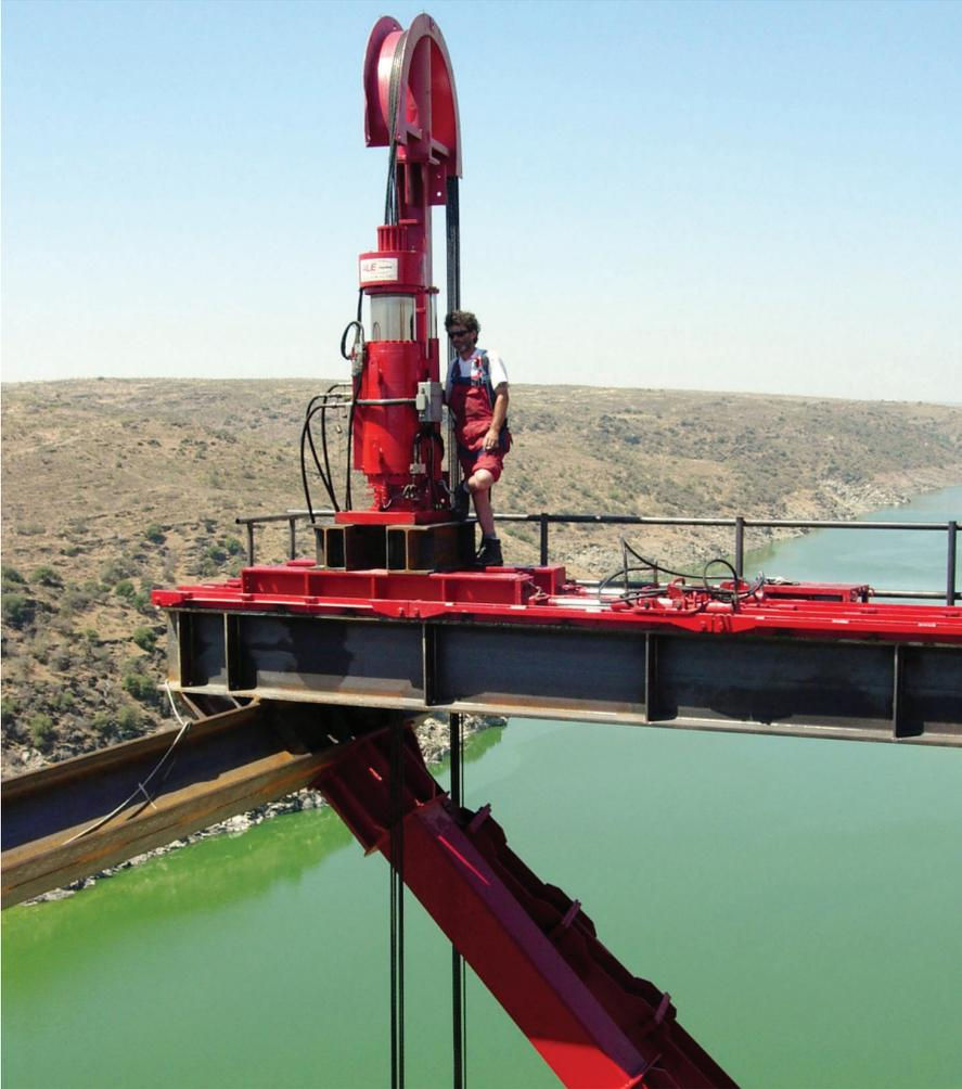
Figura 21. Pórtico de basculamiento. Detalle de un gato hidráulico.
