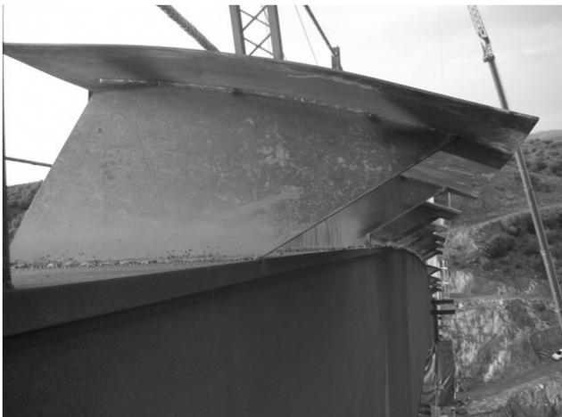
Figura 4. Deflectores instalados.
