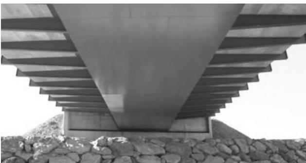
Figura 6. Vista inferior del tablero.
