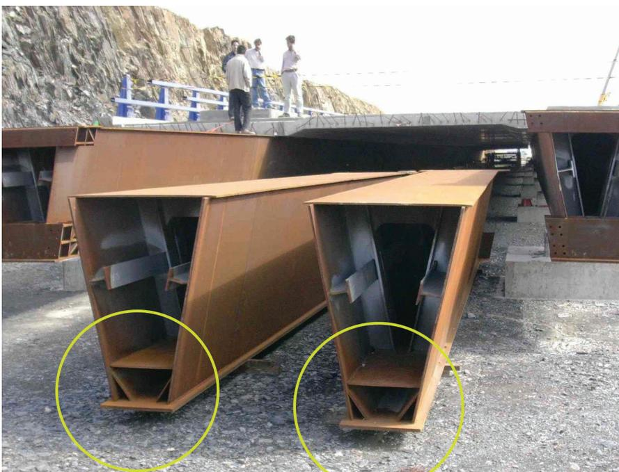
Figura 6. Tablero. Vigas – cajón metálicas. Rigidización en la parte inferior, apropiada para la situación de apoyo durante el empuje del tablero
