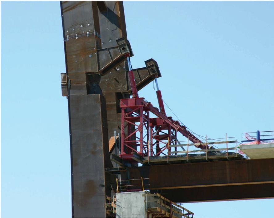
Figura 28. Posición final de basculamiento del segundo cuarto de arco.
