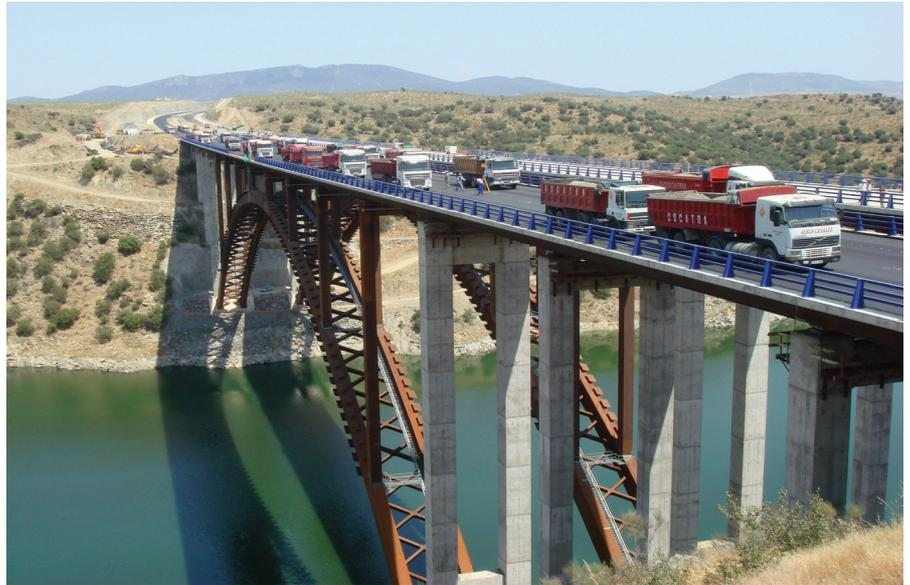
Figura 62. Prueba de carga.
