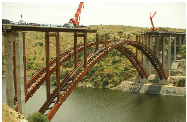
Figura 41. Empuje de tablero sobre arco (2).
