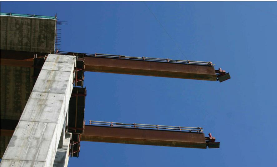
Figura 18. Zona frontal del tablero en fase de empuje.
