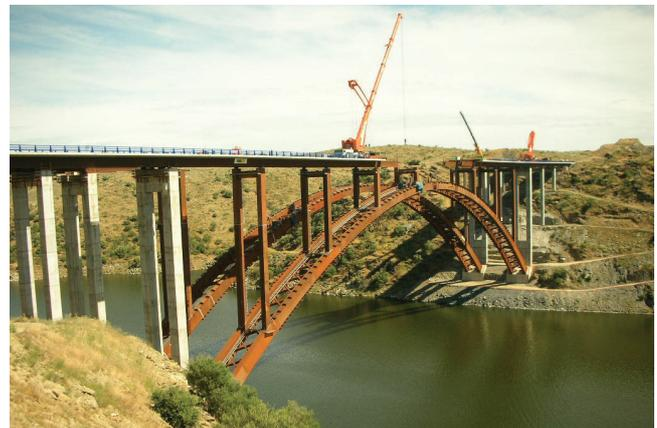
Figura 42. Empuje de tablero sobre arco (3).
