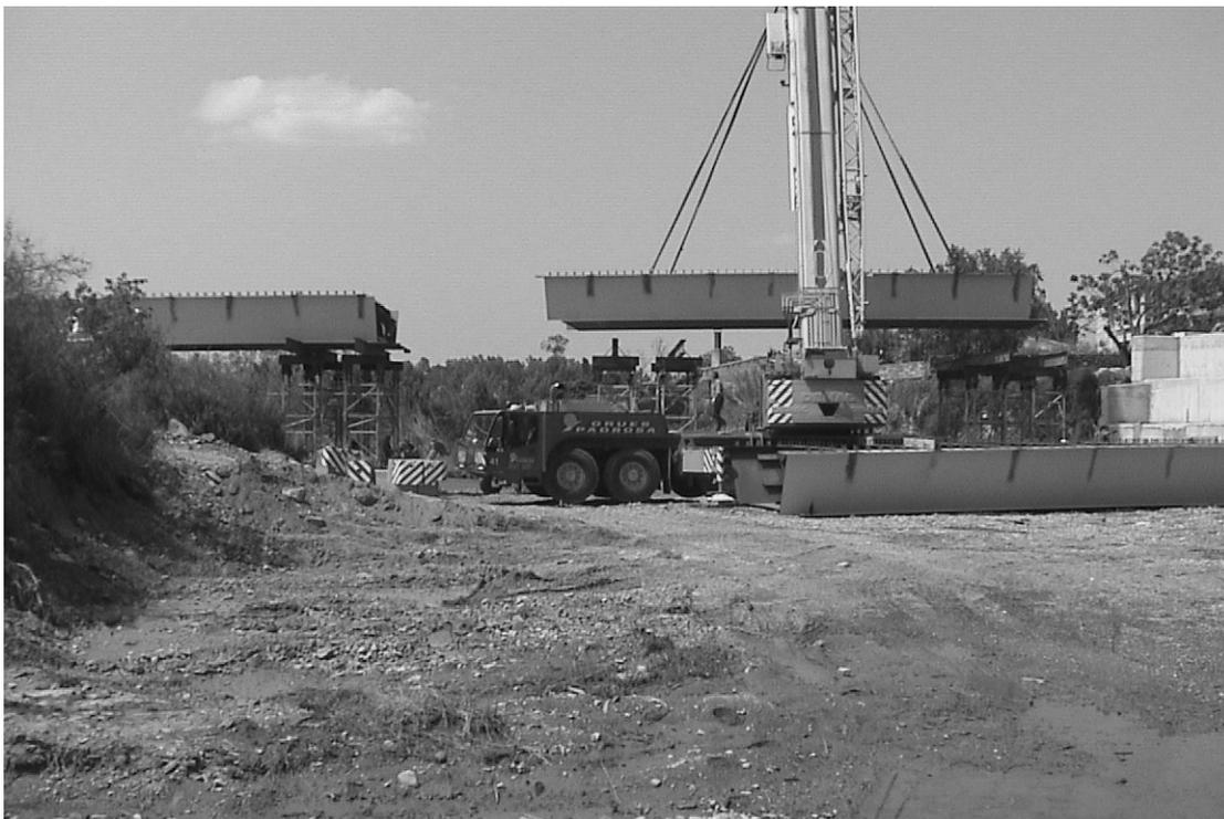
Figura 7. Montaje del tablero.
