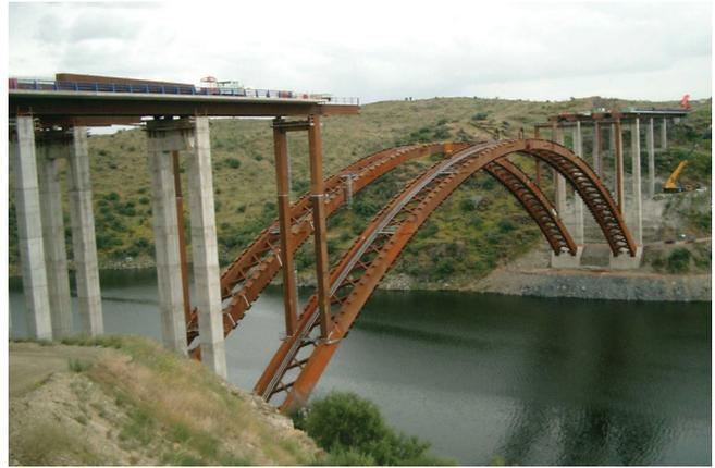
Figura 40. Empuje de tablero sobre arco (1).
