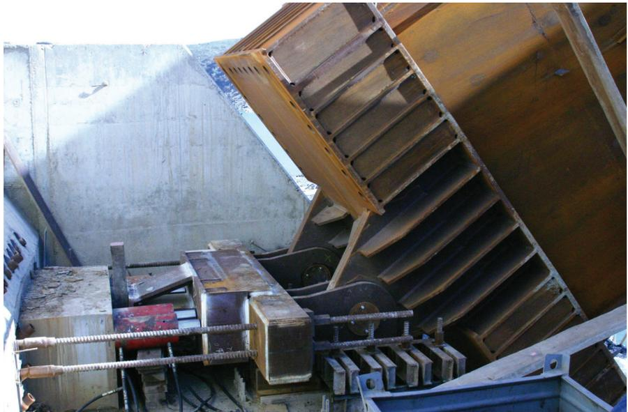
Figura 33. Pieza inferior de semiarco.
