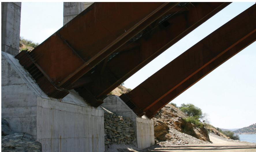
Figura 10. Empotramiento del arco.
