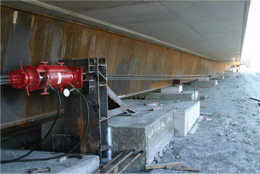
Figura 17. Gato y cable de tracción
