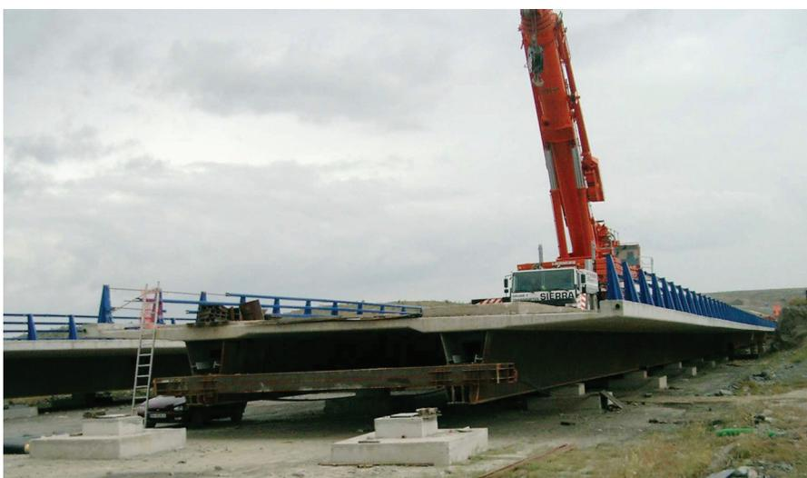
Figura 16. Empuje de un tablero. En la parte trasera, viga metálica transversal de empuje.
