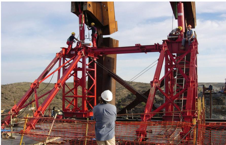
Figura 27. Estructura auxiliar sobre tablero.
