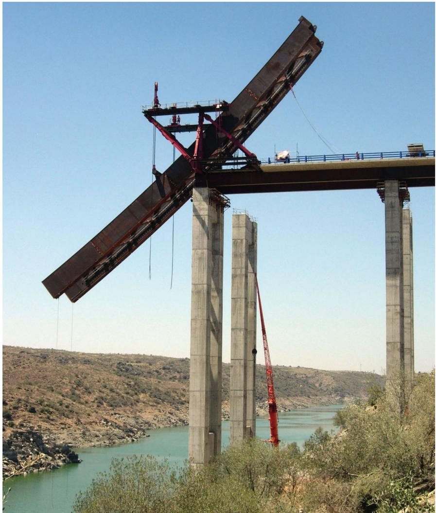
Figura 19. Basculamiento del primer cuarto de arco (1).
