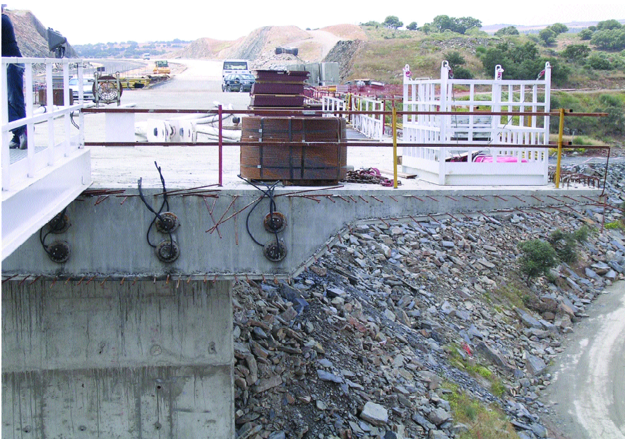
Fig.17. Detalles frente de fase del tablero. Fig.17. Details, front of deck phase.
