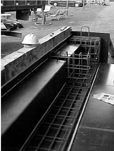
Figura 7. Armado de la viga V1-SFRC.
