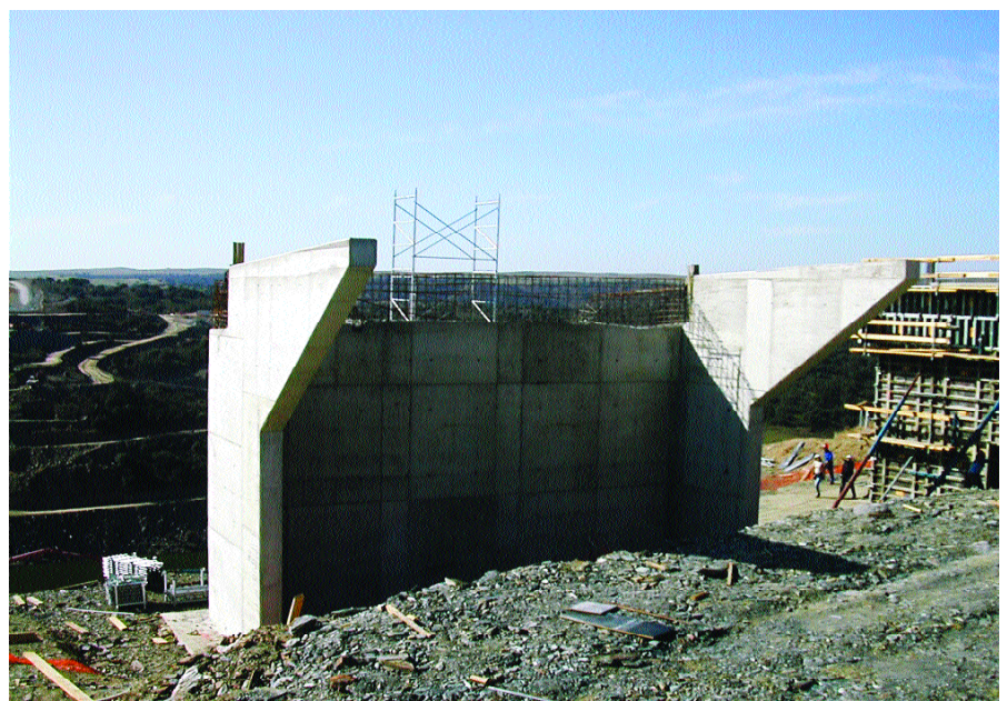
Fig.21. Alzado del Estribo 2. Fig.21. Elevation of Abutment 2.
