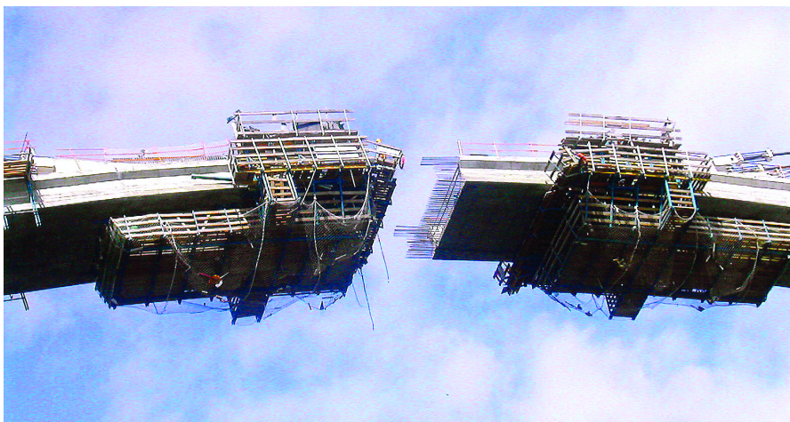
Fig.30. Carros enfrentados para la ejecución de la apertura en clave. Fig.30. Carriages facing each other for the crown opening's construction.
