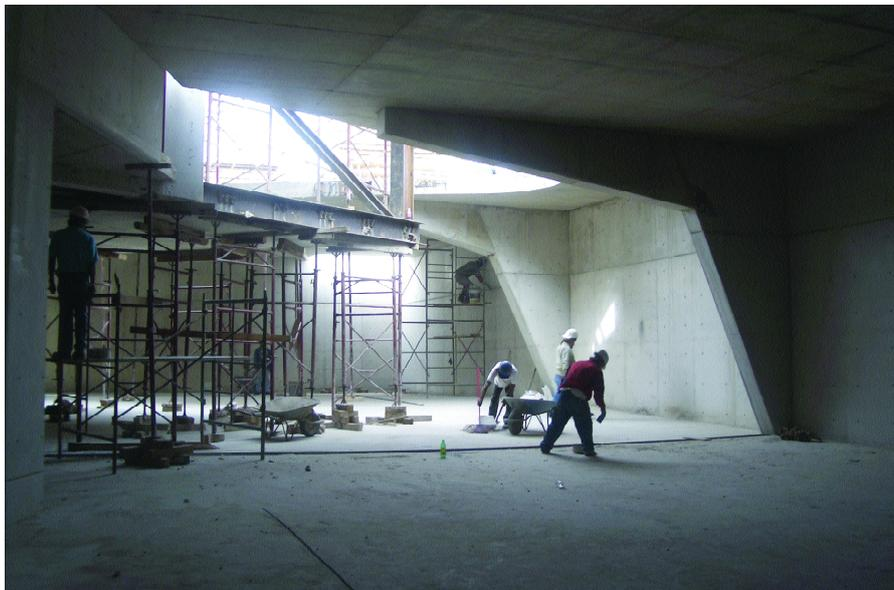
Figura 5. Zona del estacionamiento planta sótano -1 con los apoyos de sección variable y luces libres de aproximadamente 13 m.
