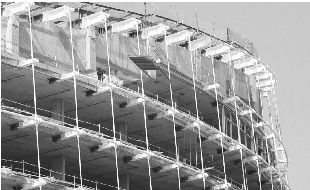
Figura 13. Detalle de tirantes exteriores, tetones exteriores de cuelgue de forjados, y tetones superiores de cuelgue exterior.
