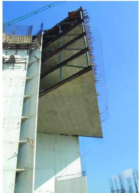
Figura 2. Vista lateral de módulo de oficinas con el voladizo principal de, aproximadamente, 8m y vista por debajo de la dirección de las viguetas postensadas.
