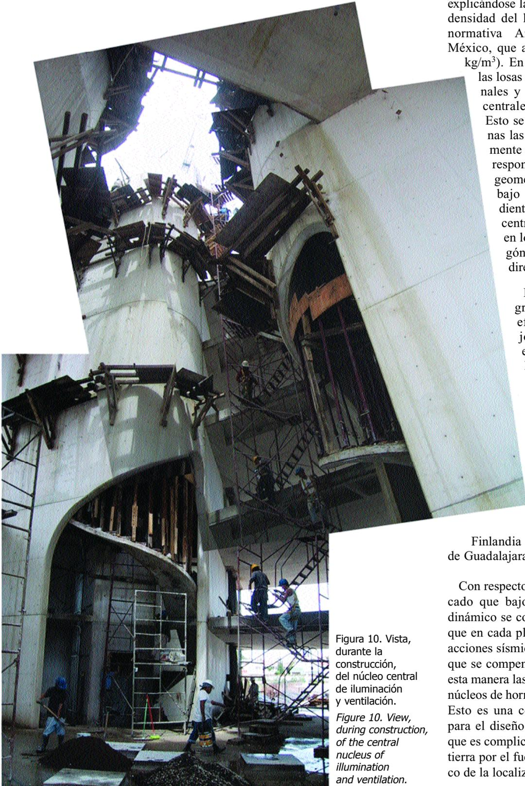
Figura 10. Vista, durante la construcción, del núcleo central de iluminación y ventilación.
