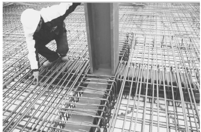
Figura 17. Tirantes interiores de Sectores II, y III. Unión mediante cruceas a forjados.
