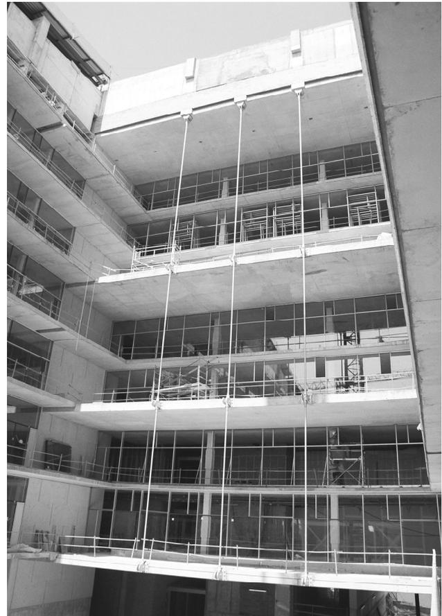
Figura 20. Interior del Sector I colgado con 2 HEM 300, y 3 tirantes de 76 mm de diámetro.
