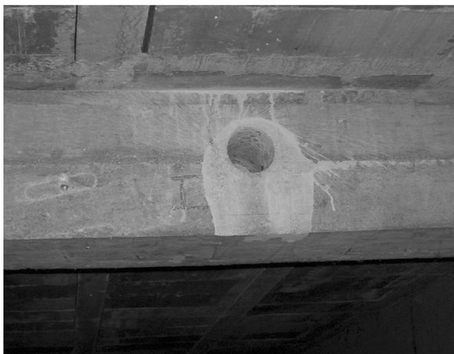
Figura 2. Extracción de probetas en vigas y pilares.
