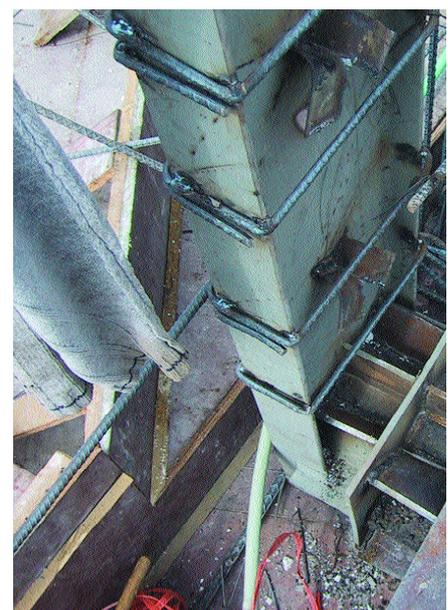
Figura 16. Detalle tipo para la conexión con perfiles tubulares y pletinas de refuerzo.
