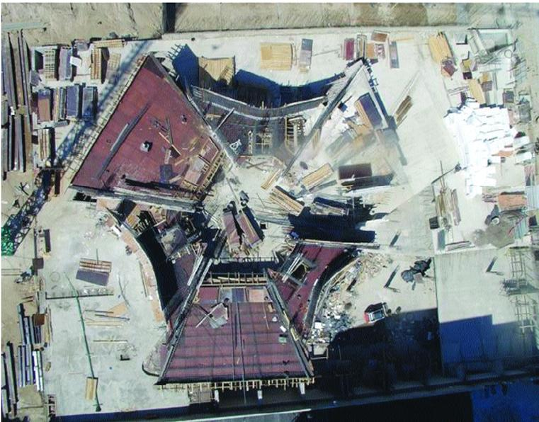
Figura 1. Vista en planta que muestra 2 módulos de oficinas, 3 núcleos de servicios y el área central interior para iluminación natural. En el módulo inferior se aprecia, además, la dirección de las viguetas postensadas paralelas a su fachada.
