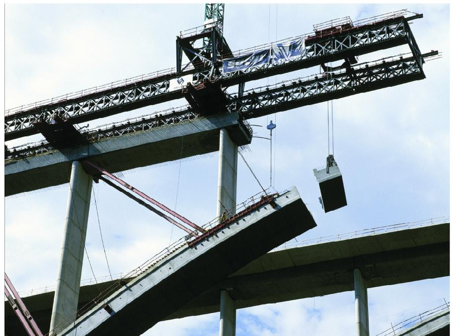
Figura 12. Montaje de una dovela prefabricada.
