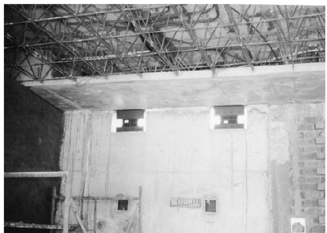
Figura 12(b). Pantalla con dissipadores SL.
