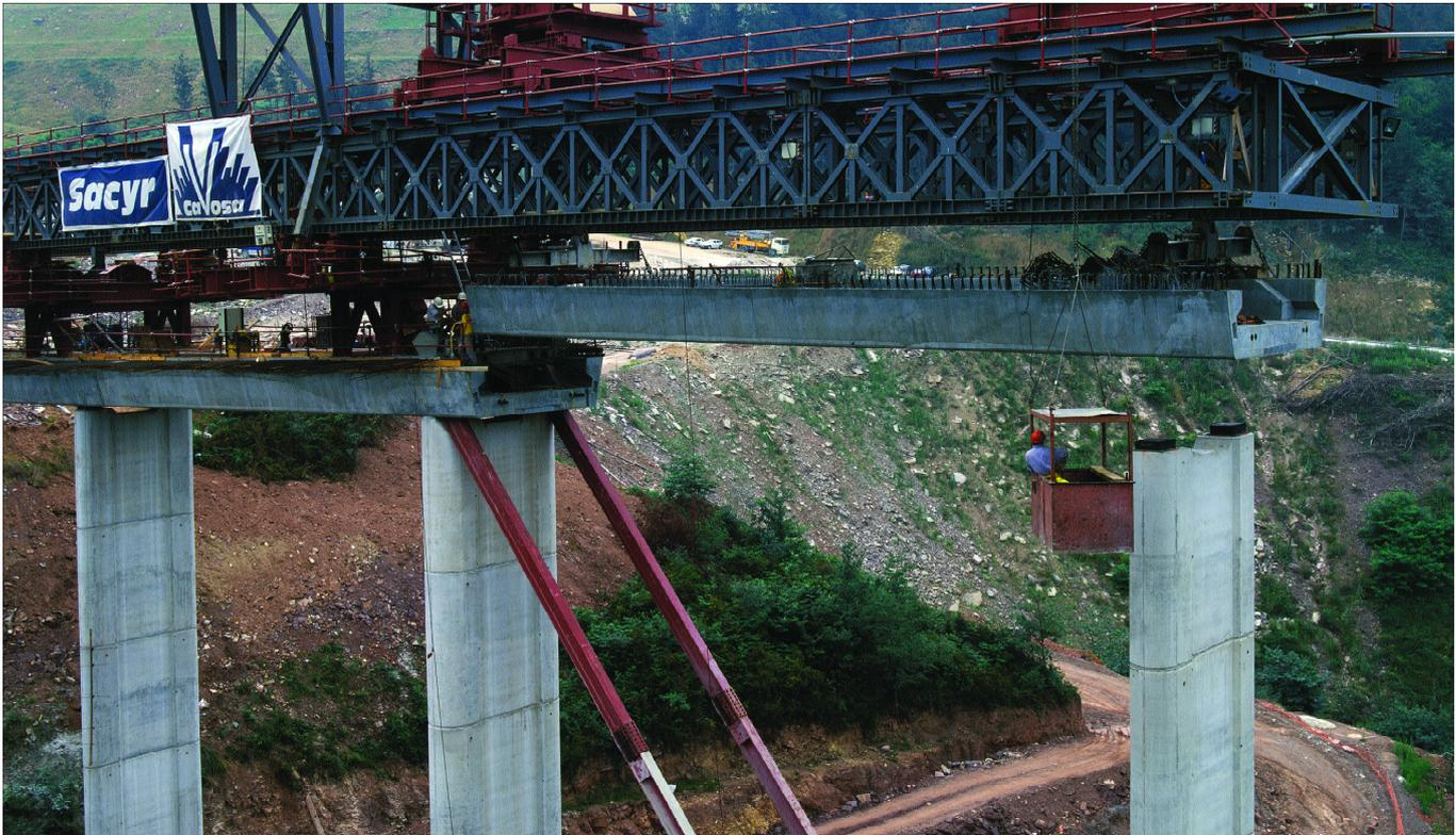
Figura 13. Montaje de una viga. Obsérvense los dos mecanismos de elevación.
