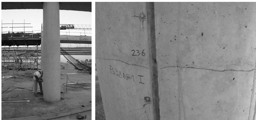
Figura 19. Fisuración horizontal detectada en los pilares extremos del pórtico en la zona de solape de las armaduras verticales.
