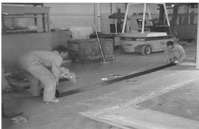
Figura 8. Preparación de las láminas de fibra de carbono para la reparación.
