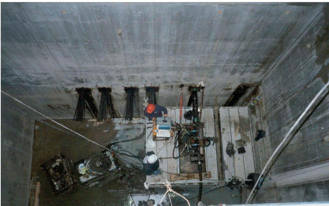
Figura 6.6.3.3. Enfilado tendones longitudinales 250 m
