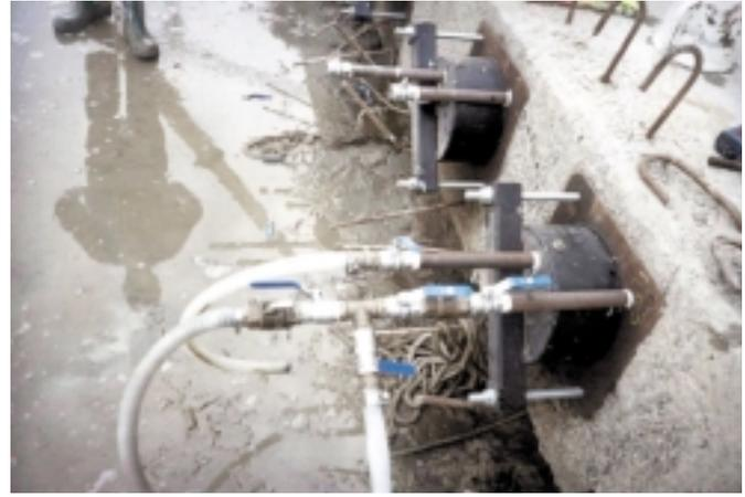
Figura 4.11. Anclaje preparado para la inyección al vacío.
