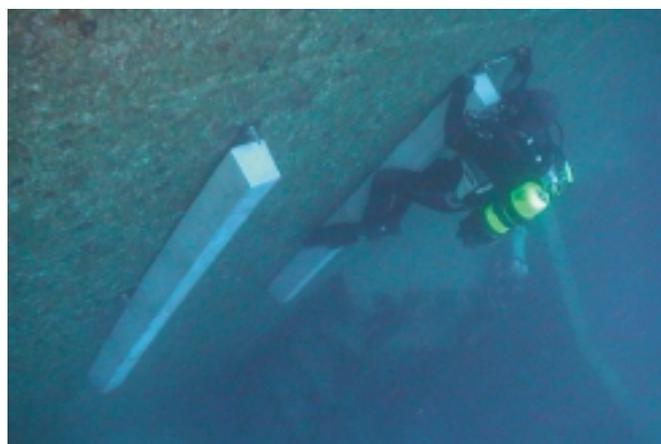
Figura 7.6.3. Instalación de los ánodos de sacrificio.
