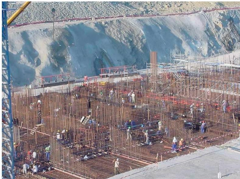
Figura 5.4.1. Aspecto general de los trabajos de armado.
