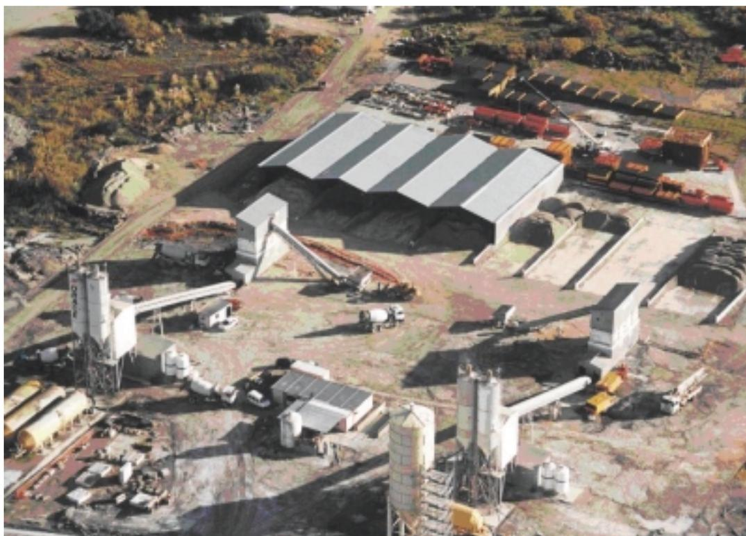
Figura 3.2.2 Vista aérea de las dos plantas de hormigón Skako y zona de acopio de áridos con el techo correspondiente a los áridos finos.
