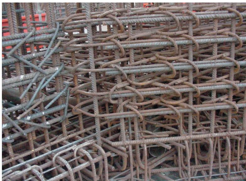
Figura 5.4.2. Horquillas y cercos de armado transversal.
