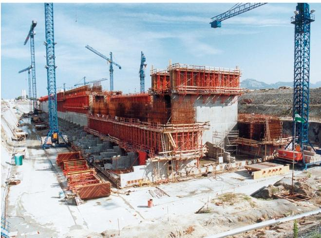
Figura 6.5.2. Encofrado trepante para los muros.
