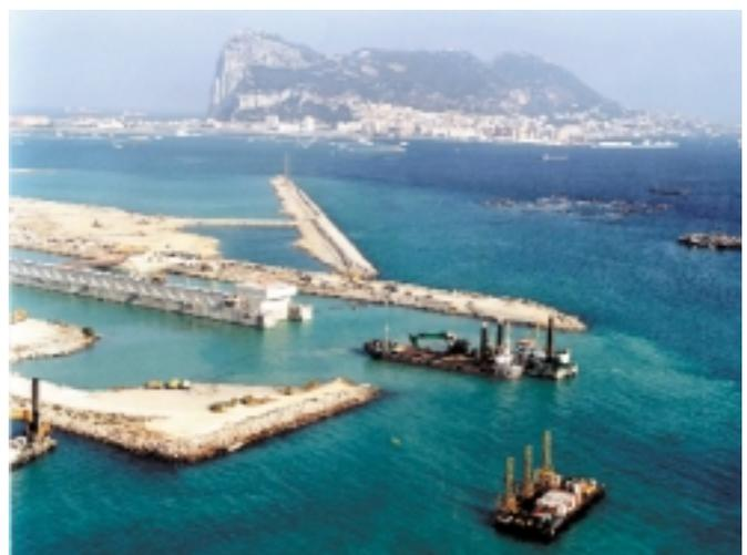
Figura 7.3.7. Draga Razende Bol y equipo de perforación.
