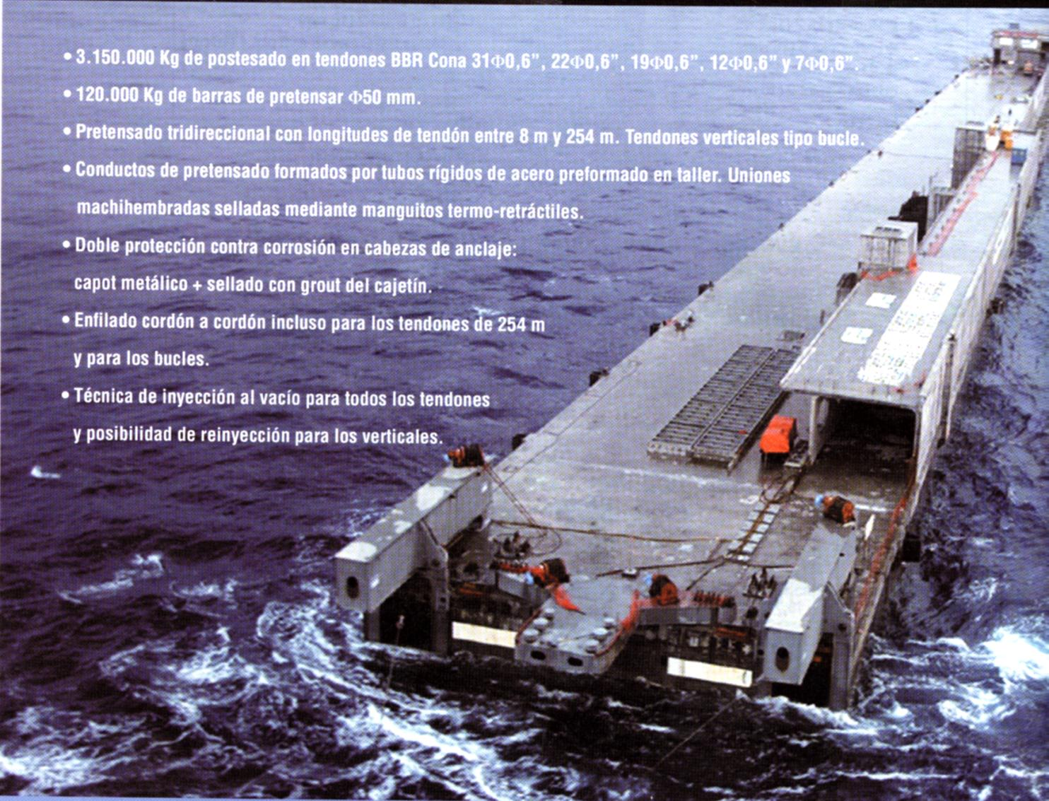
AMPLIACIÓN DEL PUERTO DE MÓNACO. Suministro y ejecución de los trabajos de postesado del dique semi-flotante.
