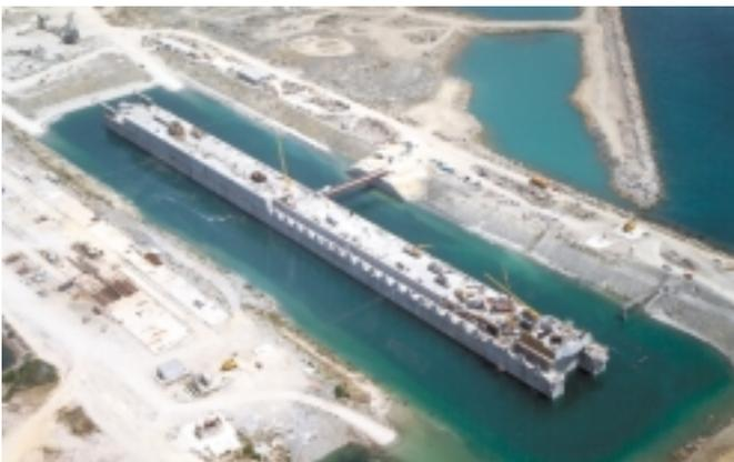
Figura 7.4.1 Dique en proceso de flotación.
