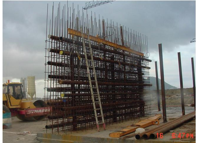
Figura 5.4.4. Prefabricación de cajas de armadura y tubos.
