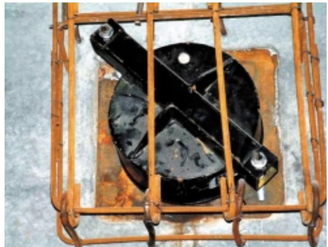
Figura 4.12. Anclaje preparado para el sellado.
