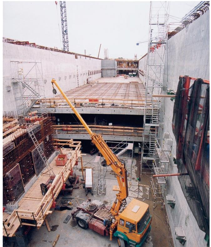
Figura 6.5.3. Encofrado de losas.
