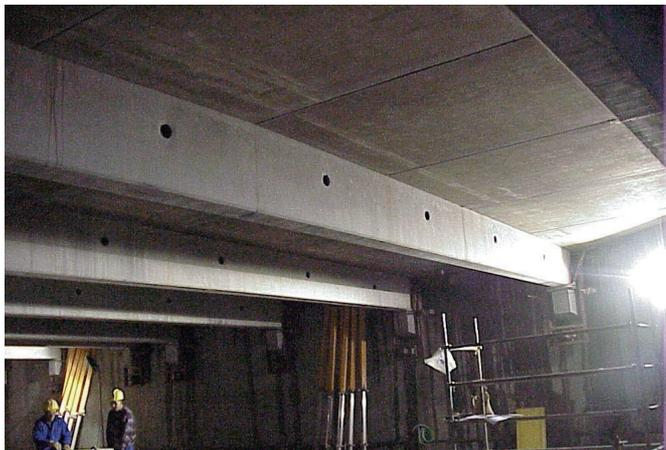
Figura 6.4.9. Vigas y prelosas prefabricadas.
