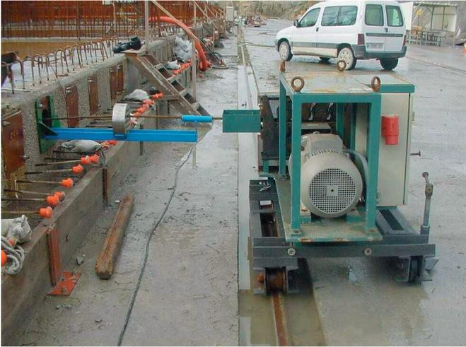
Figura 6.6.3.1. Enfiladora sobre carro de traslación.
