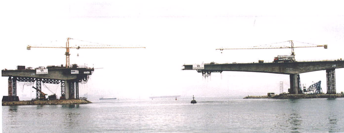
Foto 11. Construcción del semivano principal manteniendo la torre provisional en el vano adyacente. Photo 11. Construction of the main span keeping the tower in the adjacent span.
