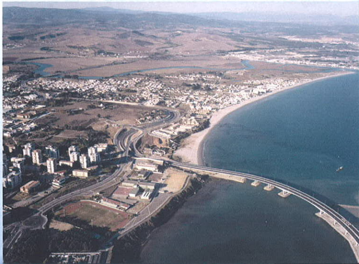
• Acceso Norte al Puerto de Algeciras. Cádiz.
