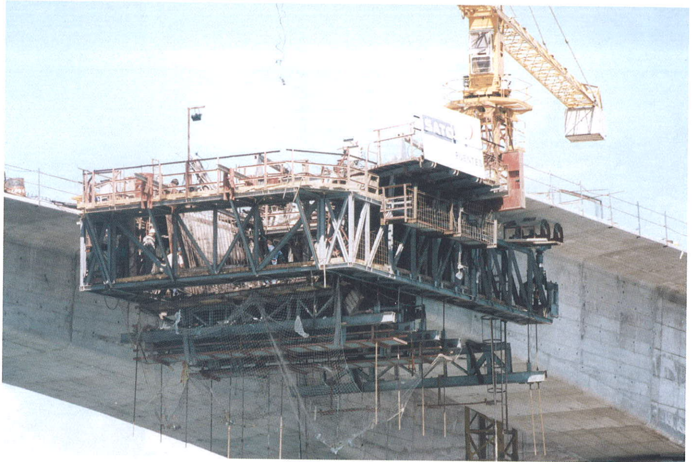
Foto 9. Detalle del carro de avance en voladizo. Photo 9. View of the carriage.
