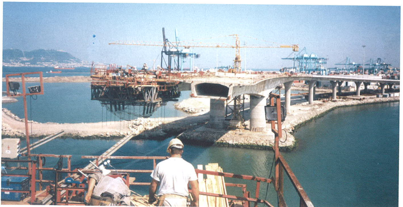
Foto 10. Vista general de la construcción. Photo 10. View of construction process.
