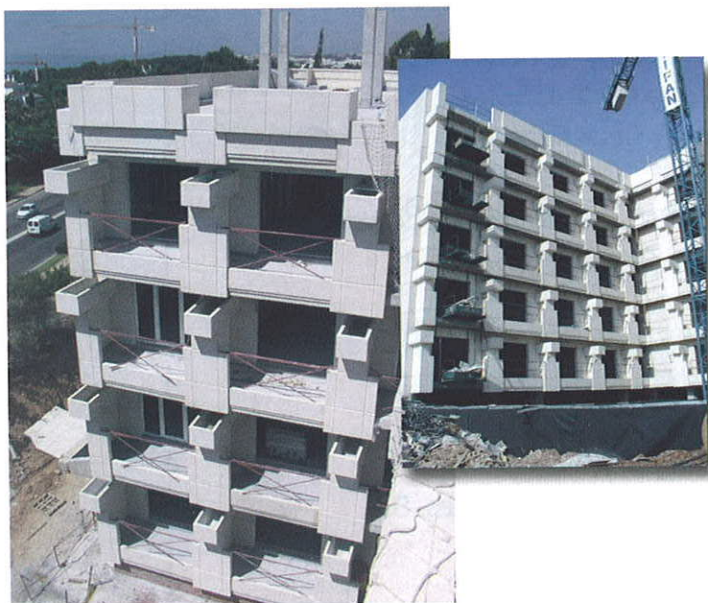
Cerramiento arquitectónico para Hotel NH. Marbella. Málaga.
