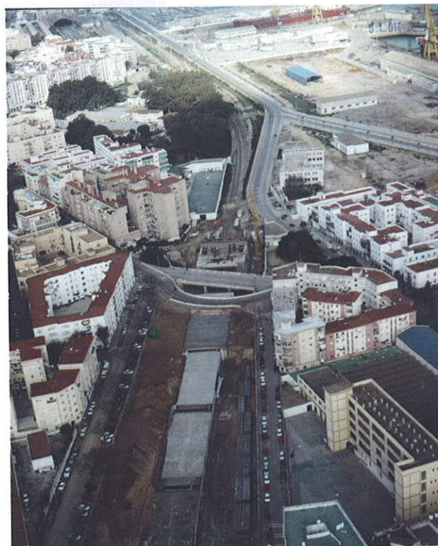
Soterramiento de vías. Cádiz.
