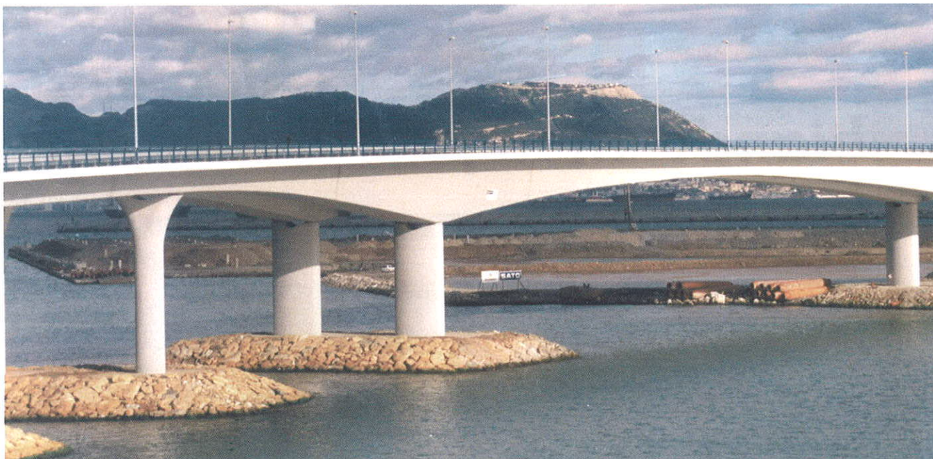
Foto 12. Detalle del canal de navegación con el puente terminado. Photo 12. View of the navigation channel.
