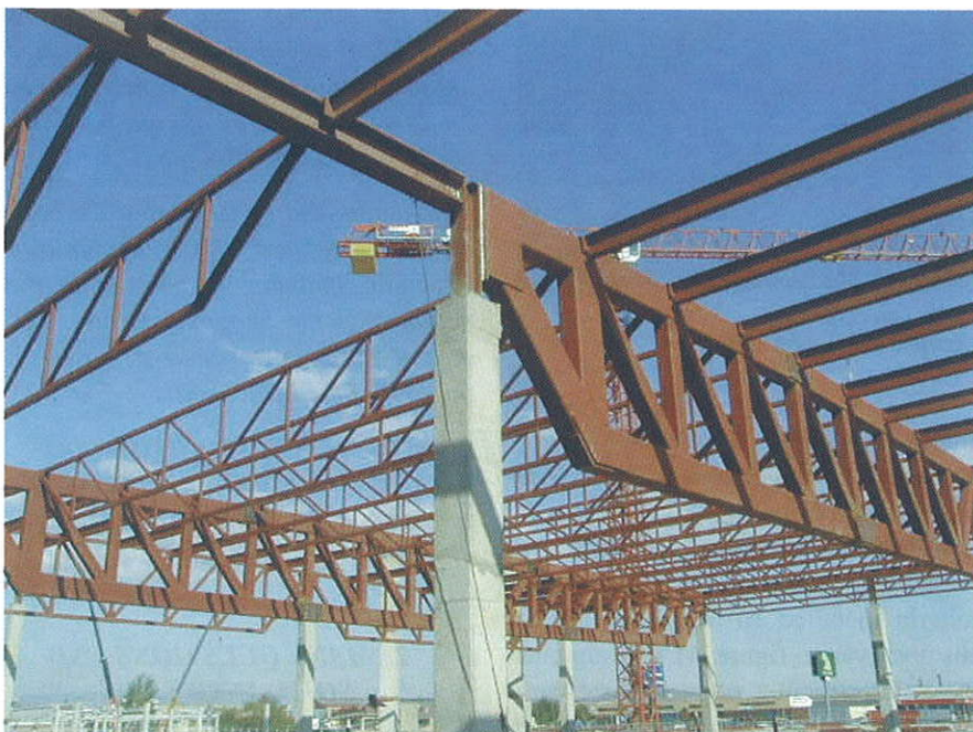
Figura 5. Foto cerchas metálicas. Figure 5. Metallic structure of roof.
