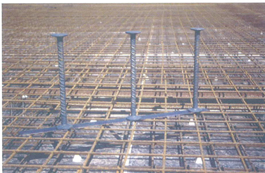
Figura 13. Armadura de punzonamiento. Figure 13. Punching shear reinforcement.
