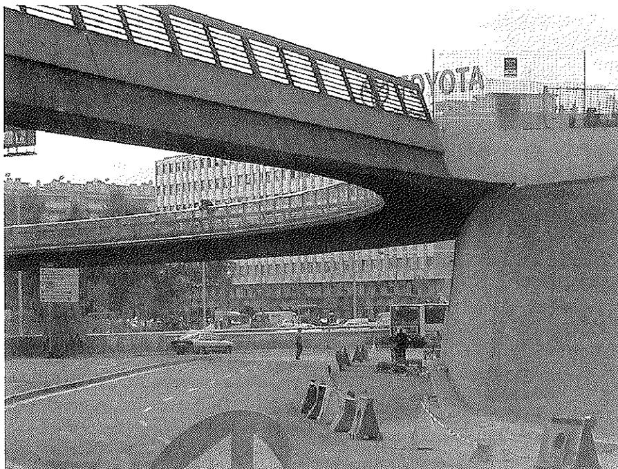
Fig. 7. Vista general de las pasarelas apoyadas en el voladizo mixto sobre el muro de hormigón. Se aprecia la continuidad de la cara inferior del voladizo y las pasarelas.
