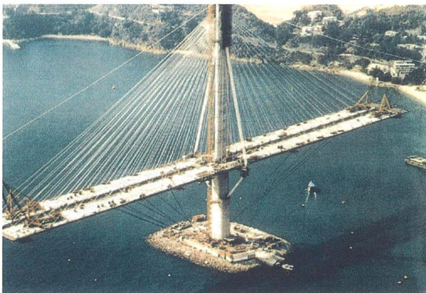
Figura 55. Detalle de la pila durante la construcción del puente de Ting Kau.
