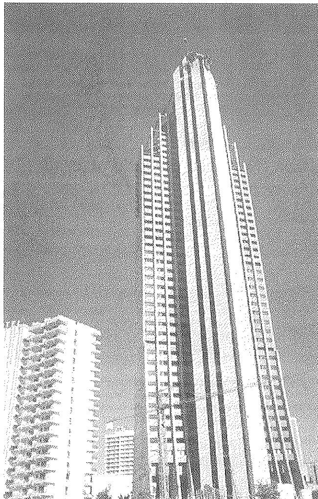
Figura 17. Bali III (52 pisos y record actual de altura en España). (Arqtos. A. Escario, F. Sanchís y R. Luelmo + CYPE Ingenieros Estudios y Proyectos, S.A.)
