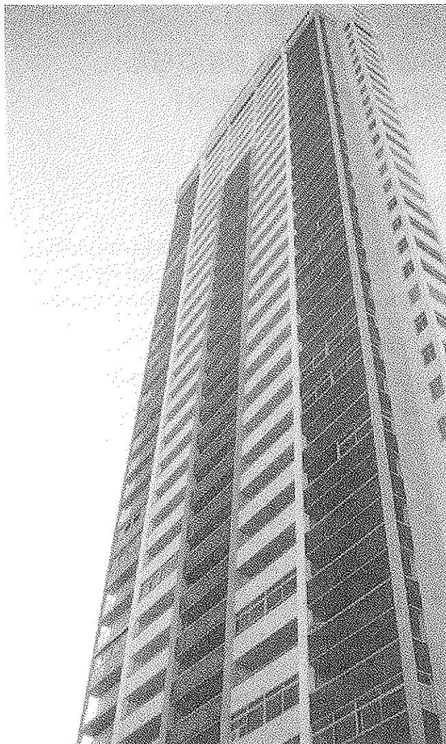
Figura 18. Torre Soinsa (42 pisos). (Arq. J. Nombela + CYPE Ingenieros Estudios y Proyectos, S.A.)
