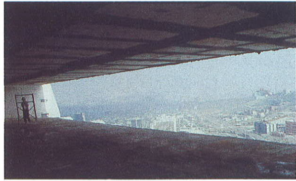
Figura 15. Una planta con excepcional diaphanidad. En el espacio comprendido entre los núcleos de hormigón no existe un solo elemento estructural vertical (Tirante o pilar).
