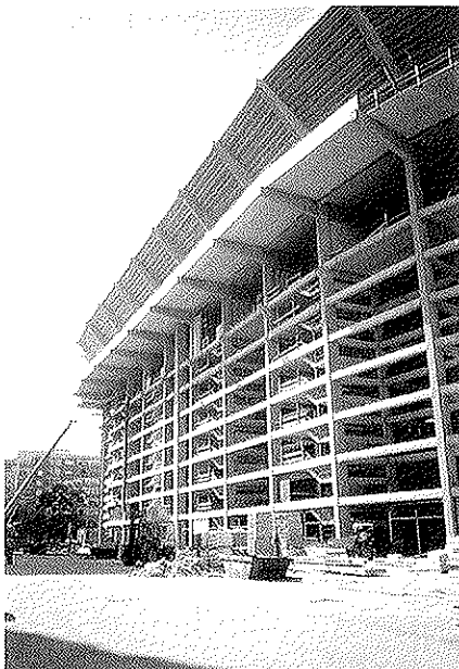
Foto 2. Vista exterior estructura acabada.
