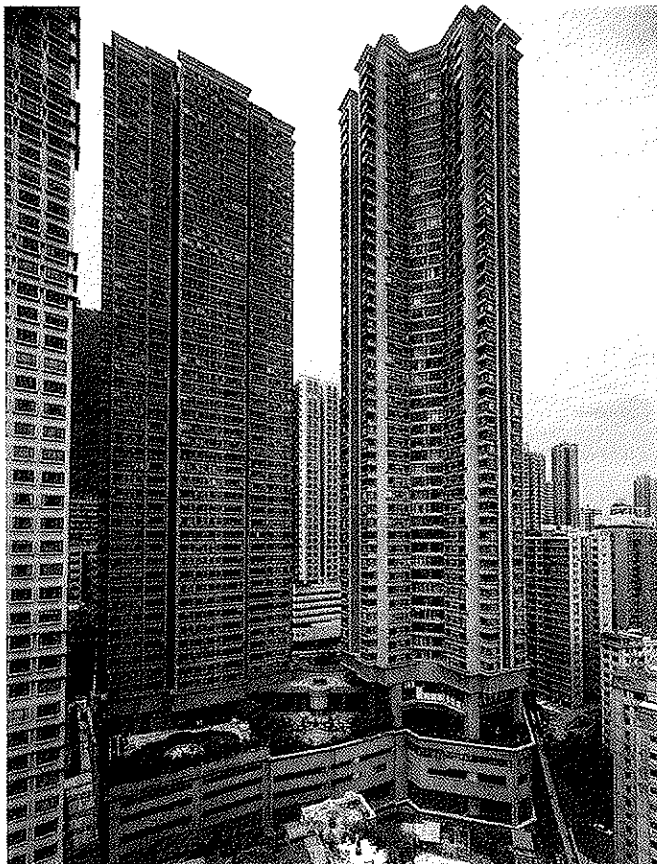
Figura 19. Robinson Place (Hong Kong). Arquitecto: Ng Chun Man & Associates. Proyecto estructural: Ng Chun Man & Associates.
