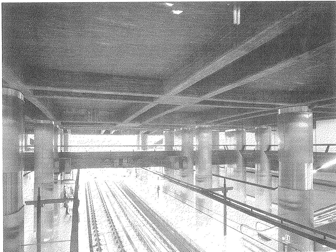
Figura 3. Estructura de hormigón postesado en la Estación de Ferrocarril Príncipe Pio, de Madrid. Proyecto estructural: Carlos Fernández Casado, S.L.
