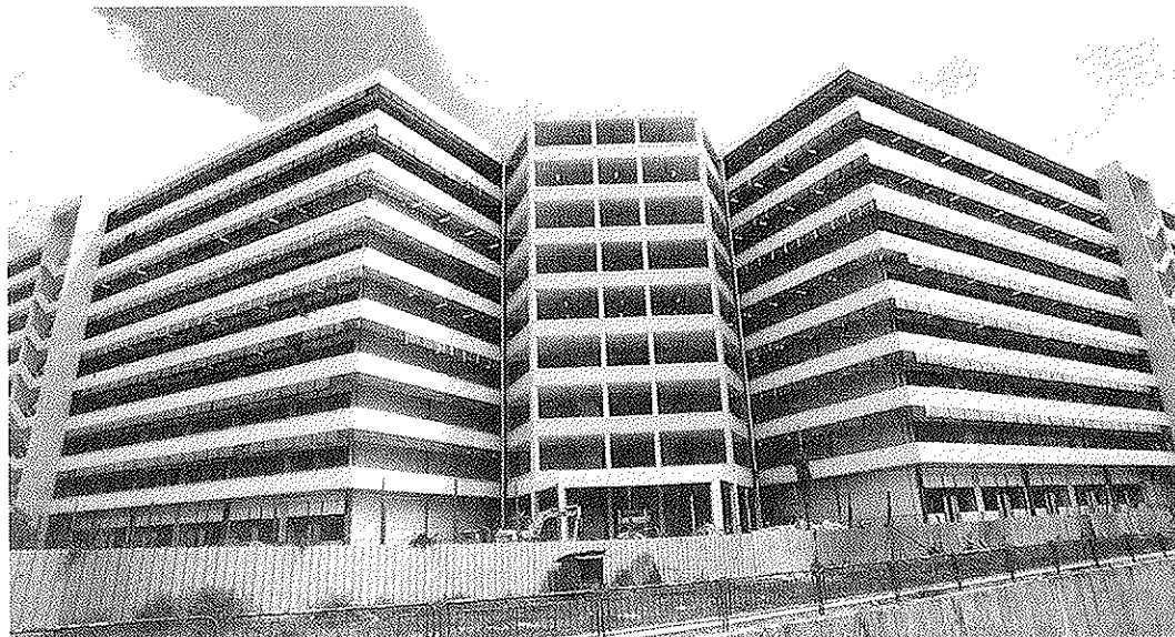
Figura 22. Woodlands Industrial park (Singapur). (Imagen facilitada por cortesía de VSL).
