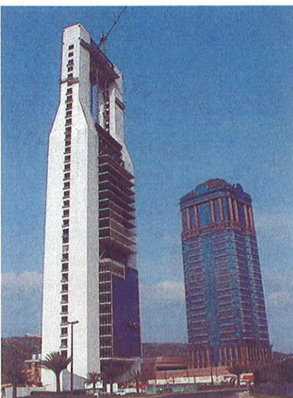
Imagen real. En construcción. Octubre, 1999. Real view, under construction, October, 1999.
