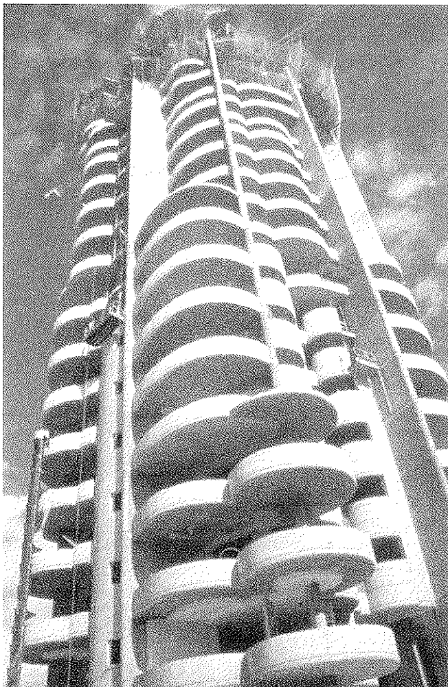
Figura 16. Torre Neguri-Gane (43 pisos). (Arq. R. Pérez-Guerras + CYPE Ingenieros Estudios y Proyectos, S.A.).
