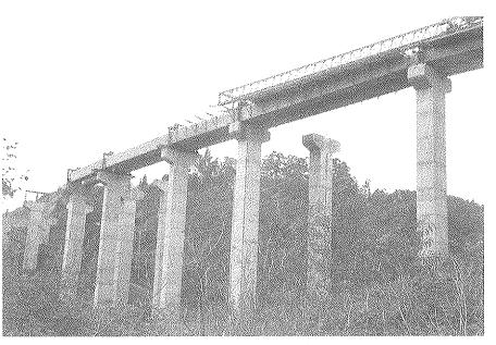
Fig. 5. Proceso de lanzamiento de vigas.
