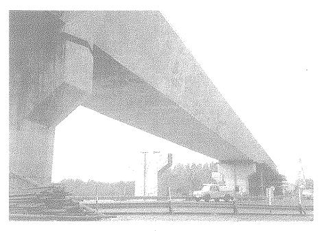
Figura 3. Construcción del tablero, por fases.
