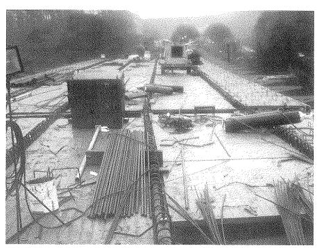
Fig. 9. Colocación de ferralla sobre prelosas.
