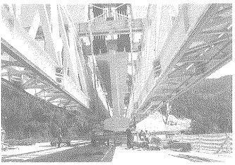
Fig. 2. Viga prefabricada transportada por el lanzador.
