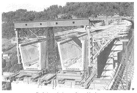
Fig. 6. Apoyo de vigas en pilas provisionales.
