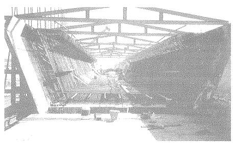
Figura 5. Construcción del tablero. Montaje de armaduras.
