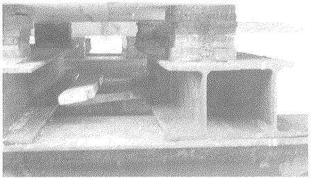
Fig. 12. Apoyo provisional en el instante del desapeo.
