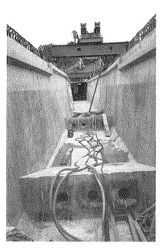
Fig. 8. Vista interior de los cajones montados.
