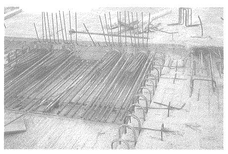
Fig. 4a.- Anclajes de postesado en losa.
