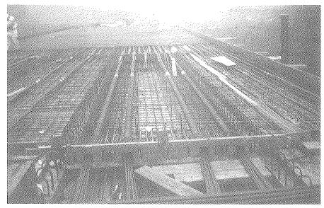
Fig. 4b.- Disposición general del postesado de losa.
