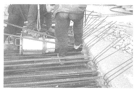
Fig. 10. Postesado de losa.
