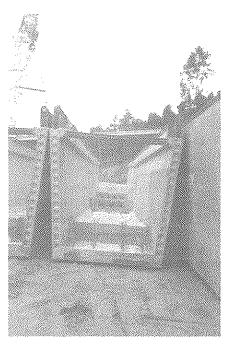
Fig. 3.- Viga con cuña de postesado.
