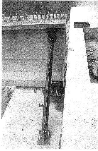
Fig. 9. Casquillo de arriostramiento de viga de borde.
