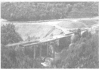
Fig. 1. Lanzador ubicado sobre las pilas del viaducto.
