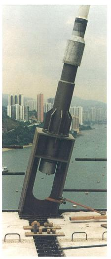
Figura 11. Anclajes de los cables en el tablero. Figure 11. Cable anchorages on the deck.
