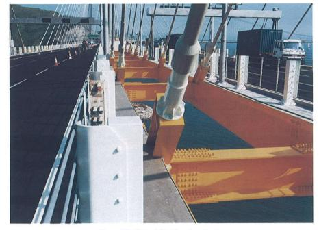
Figura 23. Vista del tablero terminado. Figure 23. View of finished deck.
