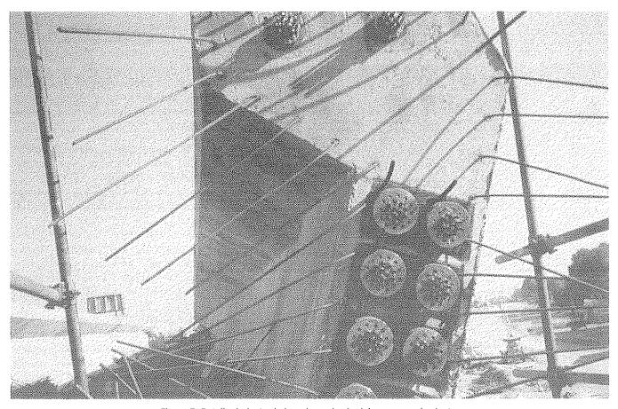
Figura 7. Detalle de junta de hormigonado. Anclajes con acoplamiento.
