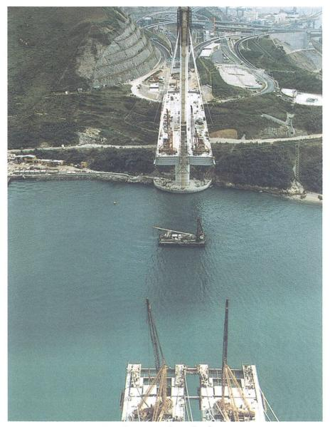
Figura 21. Montaje de paneles típicos. Figure 21. Typical deck panel erection.
