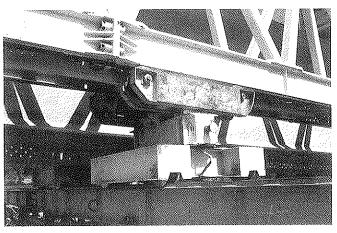
Fig. 11. Rodillos locos de recepción del lanzador sobre pilas.
