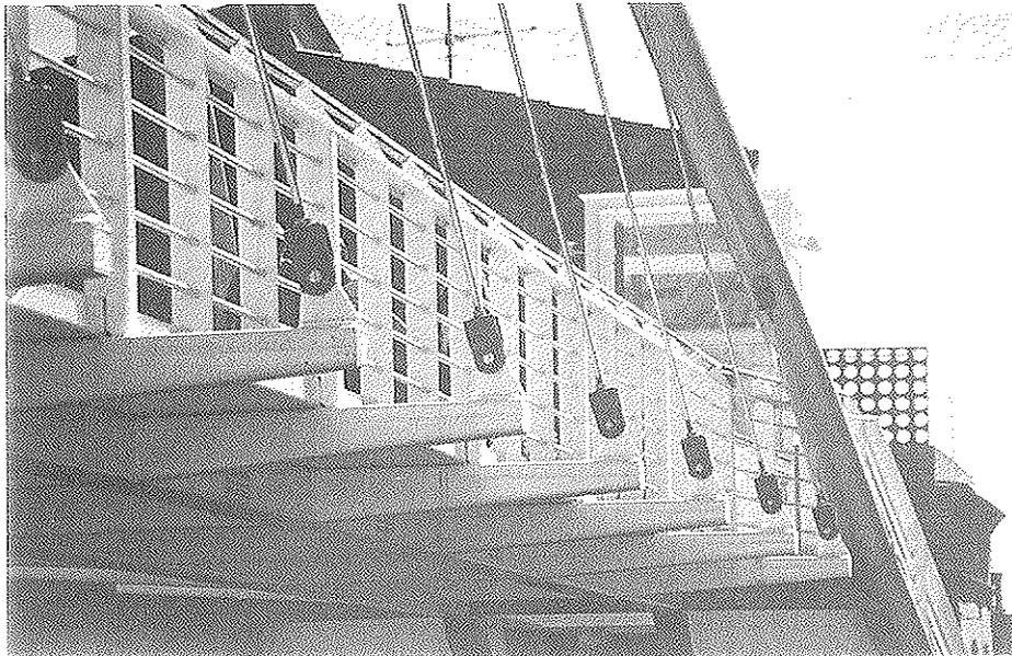
Fig. 21. Anclajes de los tirantes al tablero.
