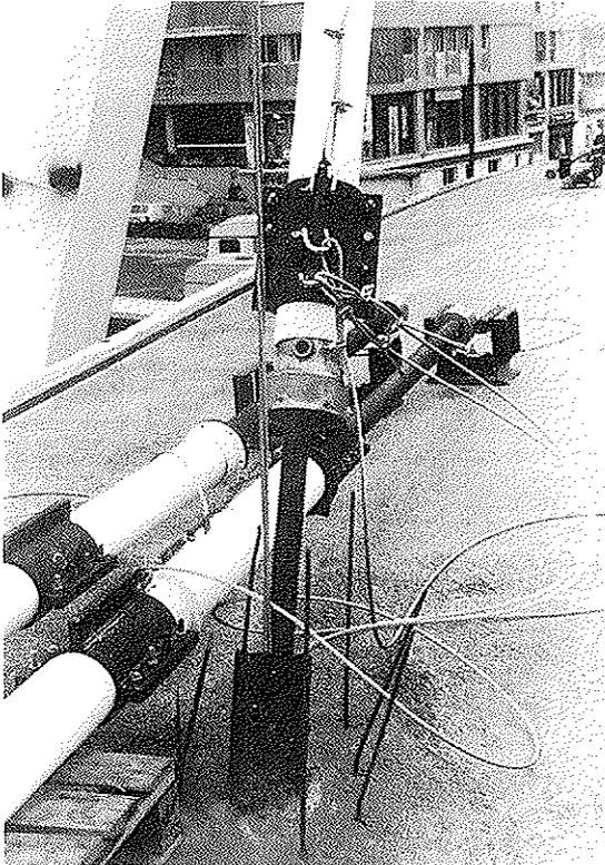
Fig. 13. Detalle de tirantes antes del montaje.
