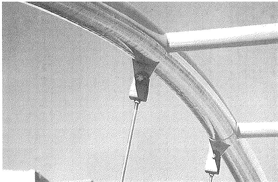
Fig. 20. Anclajes de los tirantes al arco.
