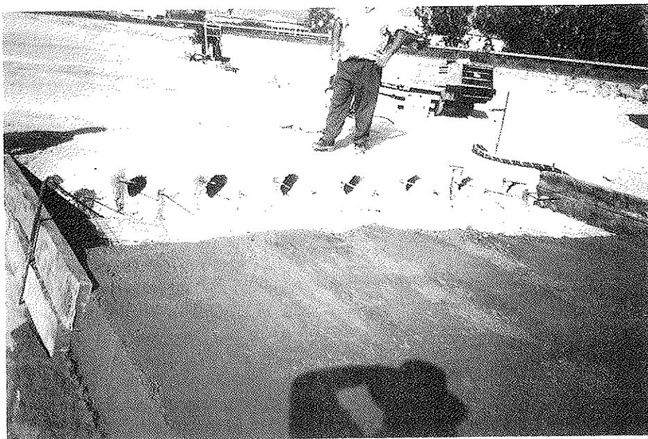
Foto nº 2. Tramo de carretera ejecutado por Cubiertas, S.A. mediante losa aligerada.
