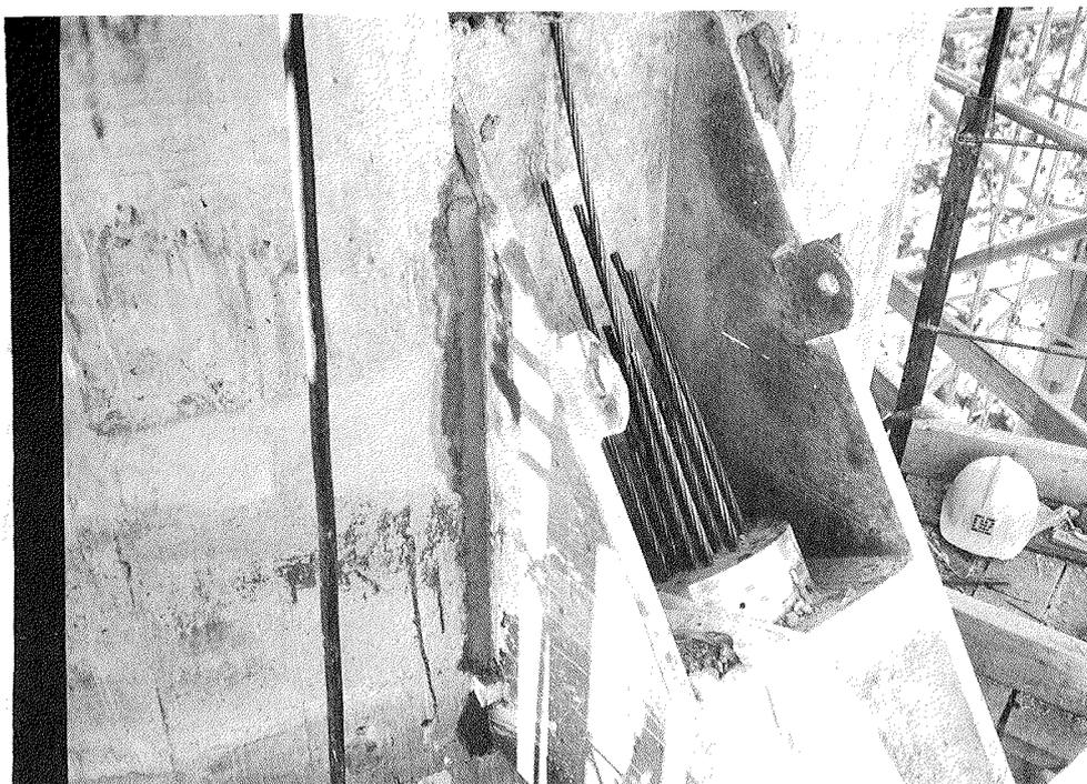
Fig. 15: Pieza de anclaje al fuste. Cables provisionales C-1 y C-2.
