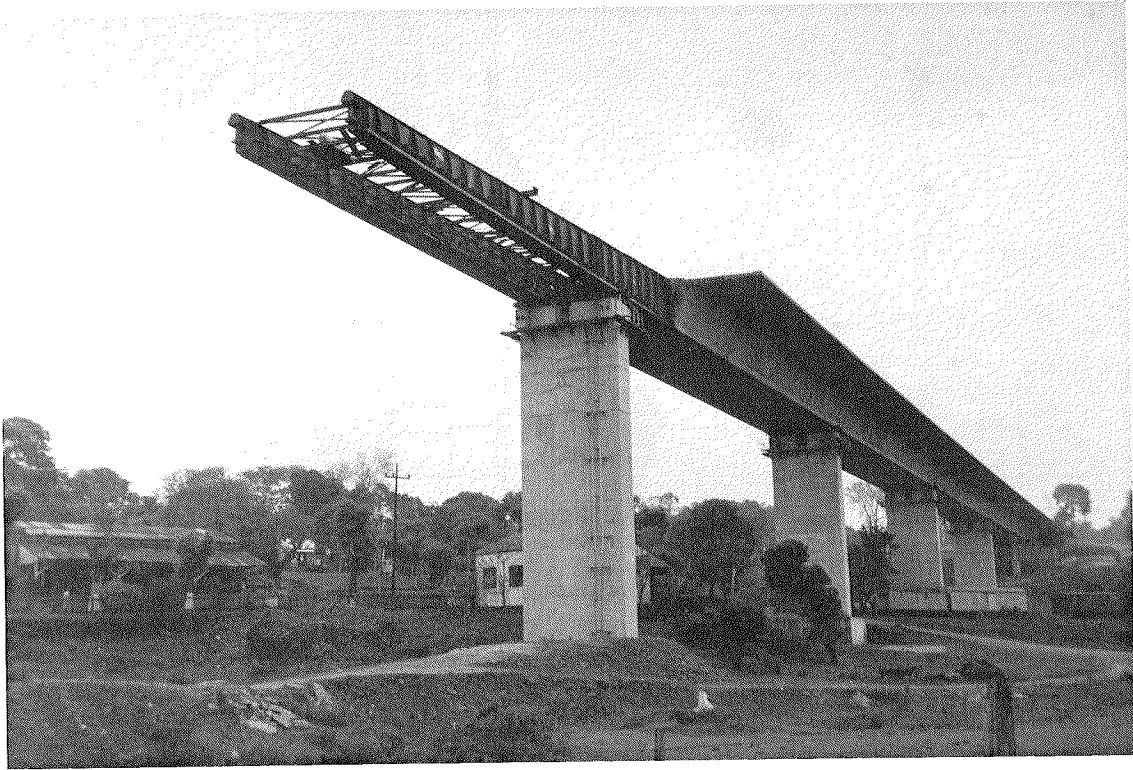
El Viaducto Paraguayo en construcción.
