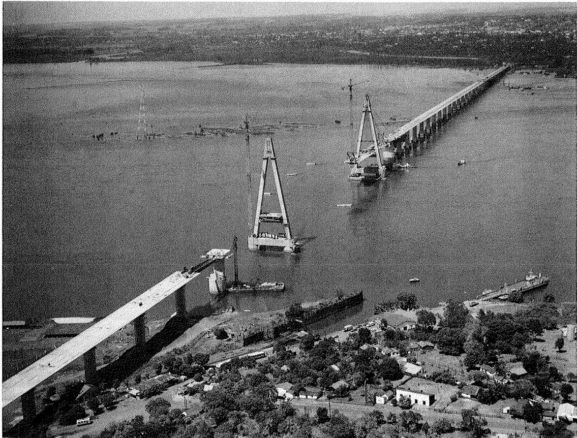
Vista general durante la construcción del puente.
