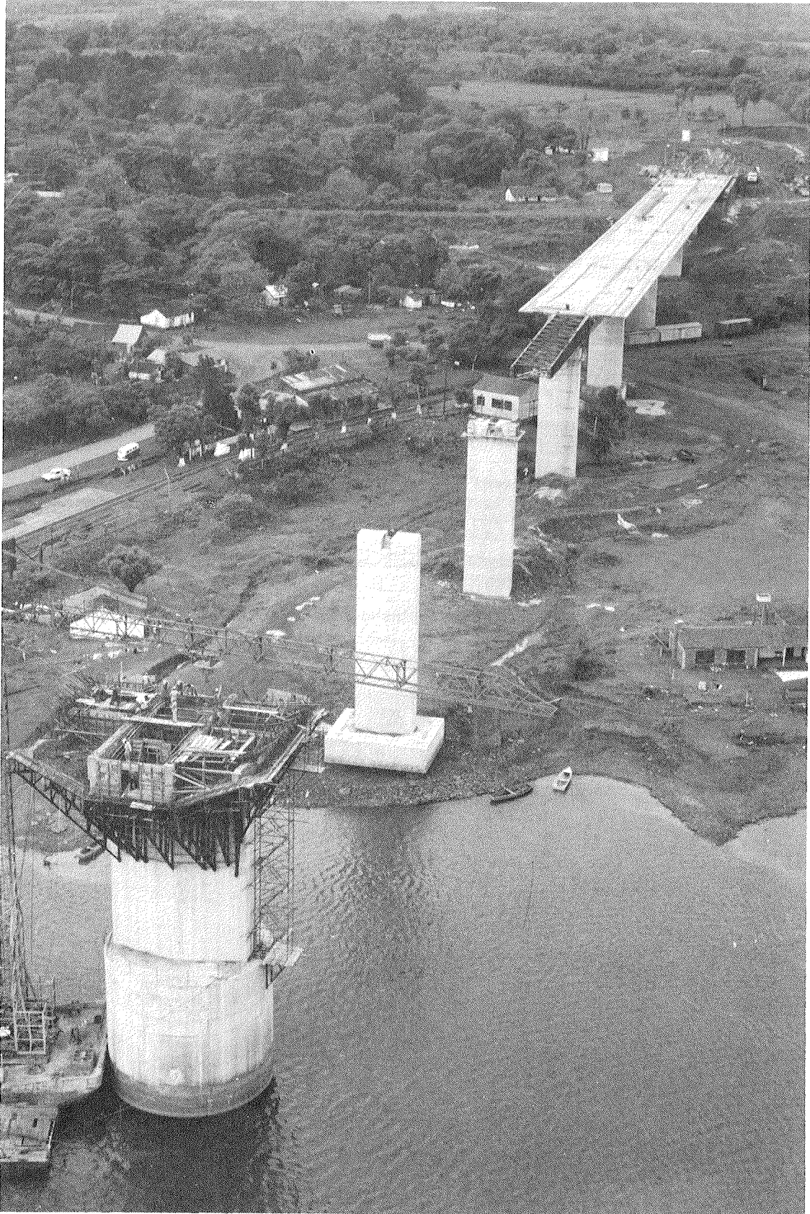
Viaducto Paraguay construido por el procedimiento de empuje acompasado.
