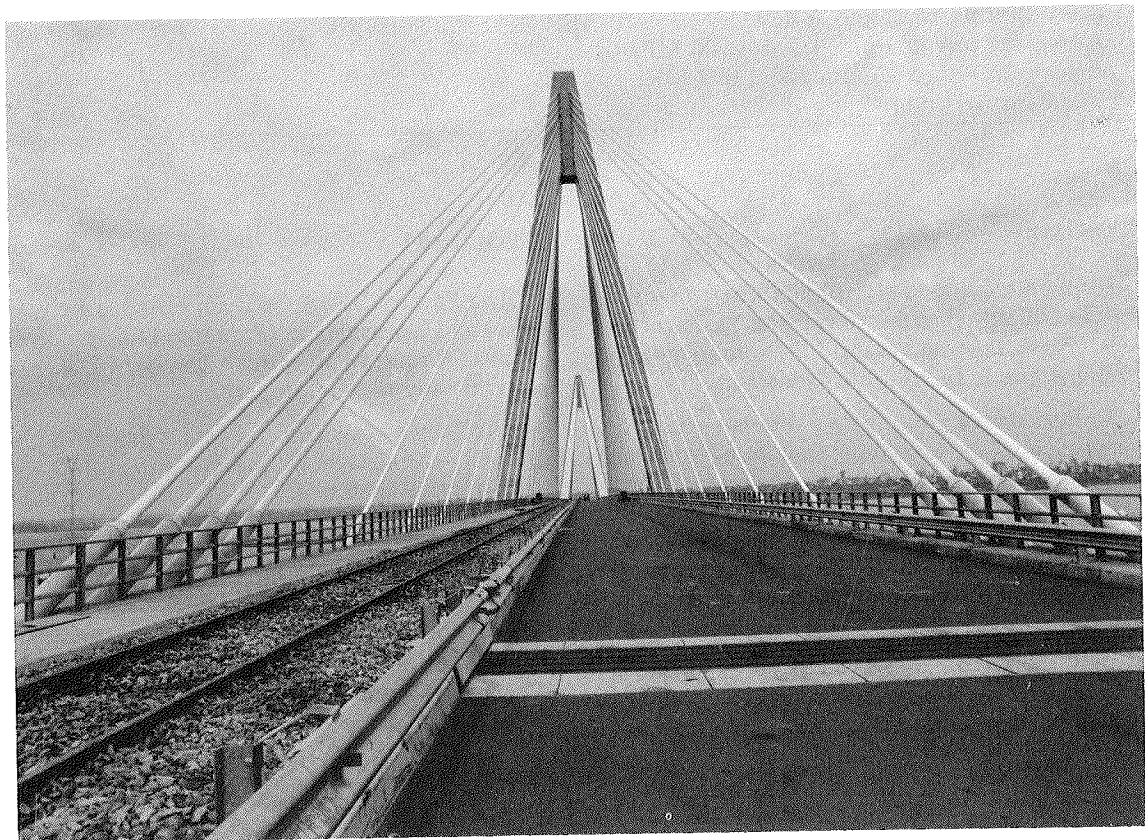
Puente Principal: Vía férrea, calzada bituminosa, junta de dilatación.
