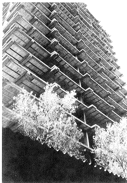
Foto 2. Estructura tradicional de vigas descolgadas, viguetas y bovedillas.
