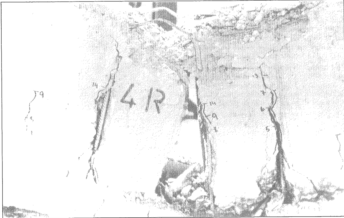
Foto 21. Agotamiento por tracción de la armadura original.
