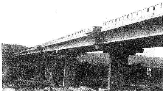
Fig. 32. Vista de la junta entre vanos prefabricados.
