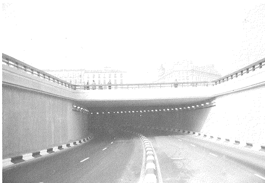
Fig. 10A. Paso inferior de Atocha. Embocadura.
