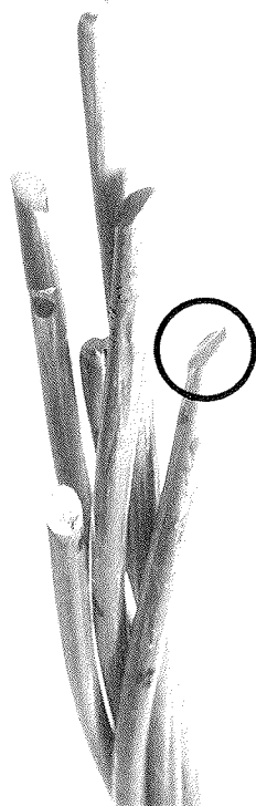
Foto 7. Rotura en obra descrita en el texto.
