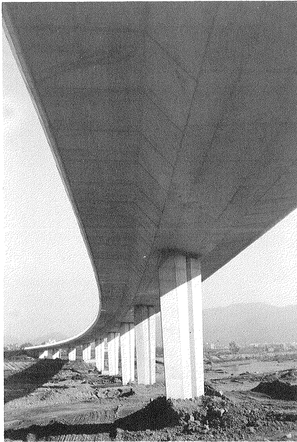
Fig. 3B. Este puente tiene una curvatura y una oblicuidad extraordinariamente fuertes.
