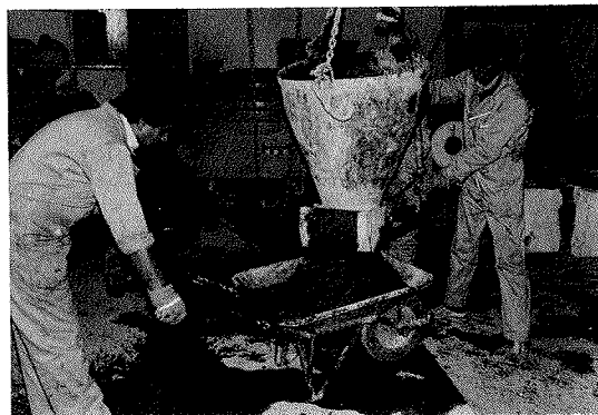
Foto 4. Descarga del hormigón.
