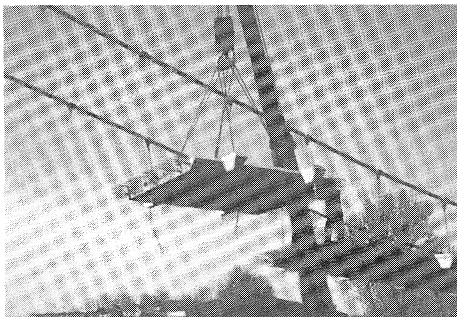
Fig. 11C. Montaje de una dovela del tablero.
