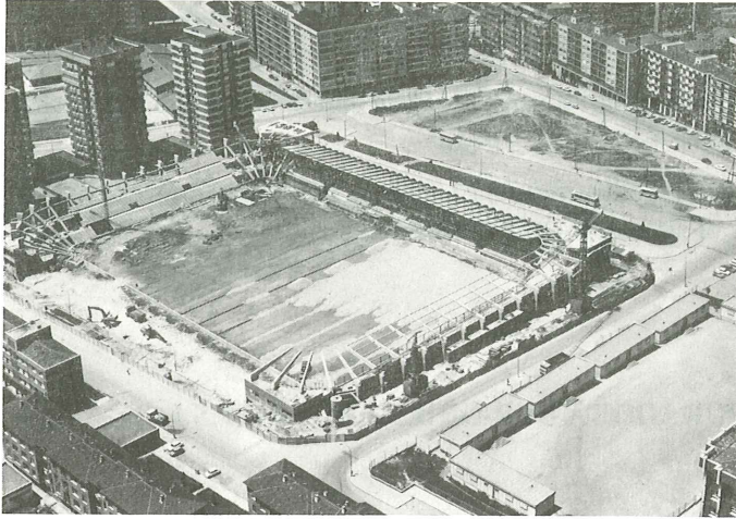
Fig. 2.1. Vista general del Estadio en construcción.
