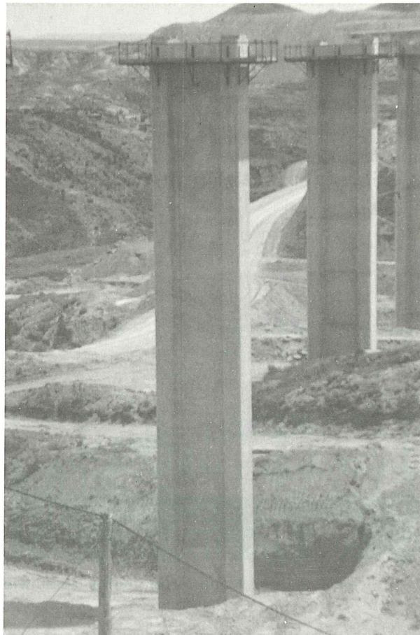
Fig. 14. Pila, con pasarela de madera para el manejo de las almohadillas, durante el lanzamiento.
