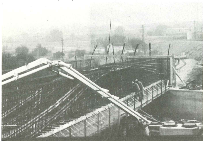
Fig. 30. Cables de pretensado longitudinal y hormigonado.
