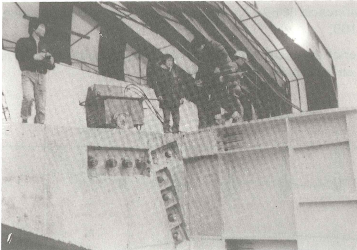
Fig. 2. KEUM GOK CHUN BRIDGE Detalle unión nariz con losa y parque de prefabricación.
