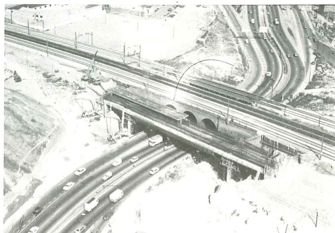
Fig. 31. Hormigonado del primer tablero.
