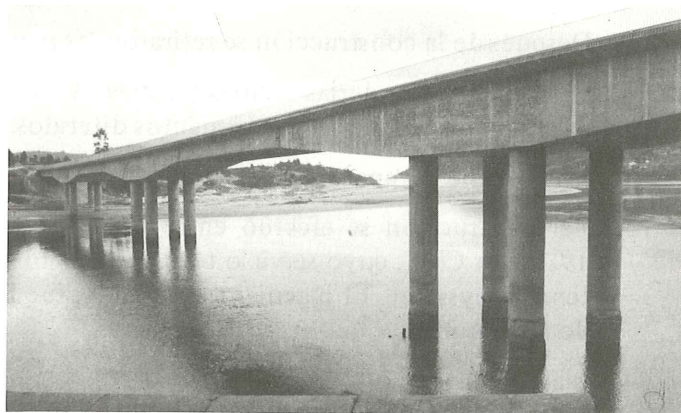
Fig. 21. Vista estructura acabada. Se han retirado las penínsulas.
