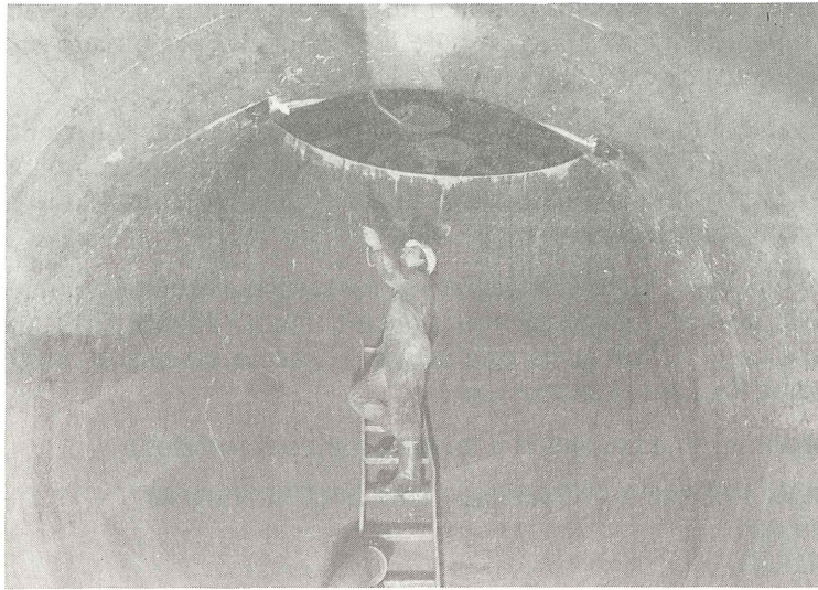
Tubería achicada para inspección y limpieza.
