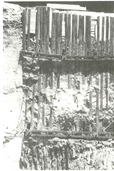
Fig. 26. Pantalla de carriles pretensados contra el terraplén.
