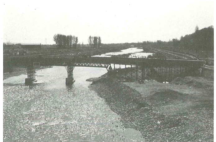
Fig. 6. Cimbra y encofrado del vano central.
