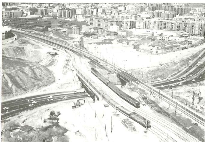
Fig. 32. Traslado de las vías de Andalucía y depósito. Huevo del puente de ladrillo.
