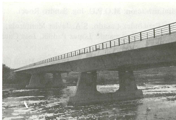
Fig. 1. c) Vista del puente terminado.
