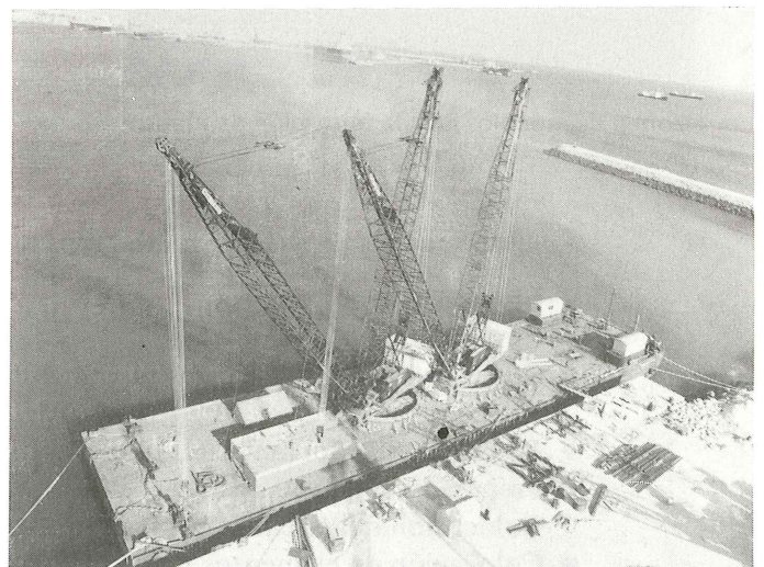
Equipo de montaje. Dracaza XIII con 2 Manitowoc 4.100 para montaje. Foto N° 7
