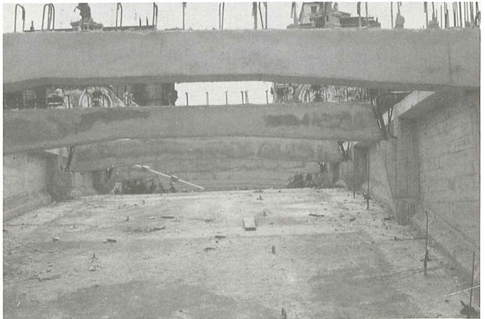
Fig. 17. Nervios transversales de tablero superior.
