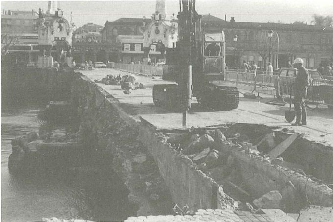
Fig. 11. Demolición de las viejas bóvedas.
