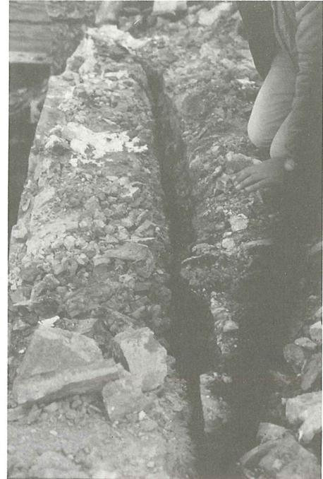
Fig. 12. Detalle de grietas existentes en las viejas bóvedas.
