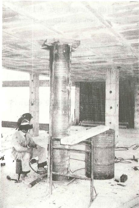
Foto 8. En esta fotografía se puede apreciar un pilar reforzado mediante un zunchado cilíndrico en una estructura normal de edificación constituida a base de forjados bidireccionales.
