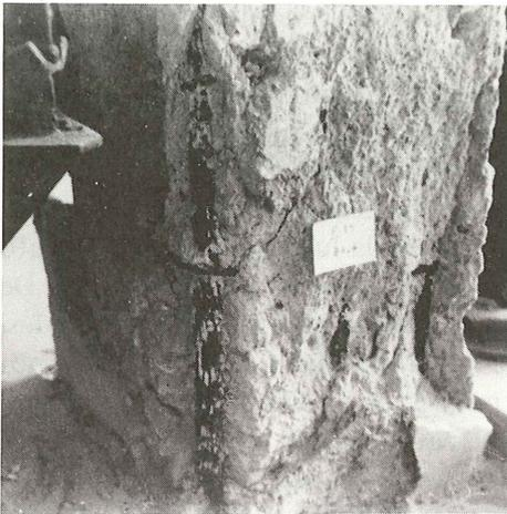
Foto 2. En esta fotografía se aprecia el estado de degradación tan avanzado en que se encontraba el hormigón de un pilar, juntamente con la corrosión total de las armaduras.
