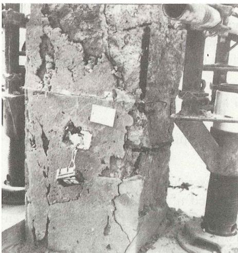
Foto 4. En esta fotografía, además de una fuerte degradación del hormigón junto con una corrosión muy avanzada de las armaduras, se puede observar un enfoscado superficial del pilar sin fines estructurales.
