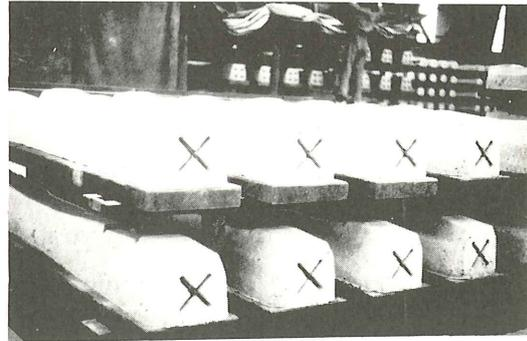
Fig. 4. Acopio de travesías curadas que van a entrar en fase de tesado.
