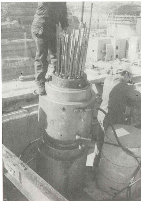
Fotografía 33. Tensando un tendón vertical.
