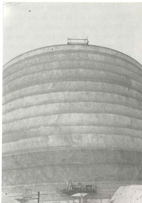
El muro se hormigonó empleando como encofrado, en su paramento externo, la barrera de vapor ya construida y en su paramento interno, placas metálicas elevadas mediante procedimiento convencional.
