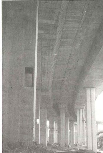
Existen tres geometrías distintas; una para las rampas de incorporación, otra para las de salida y otra para los casos en que una rampa de entrada y otra de salida están muy próximas lo que exige un sobreecho constante entre ellas para el trenzado de los vehículos. Con estos tres tipos se han realizado todas las rampas del viaducto.
