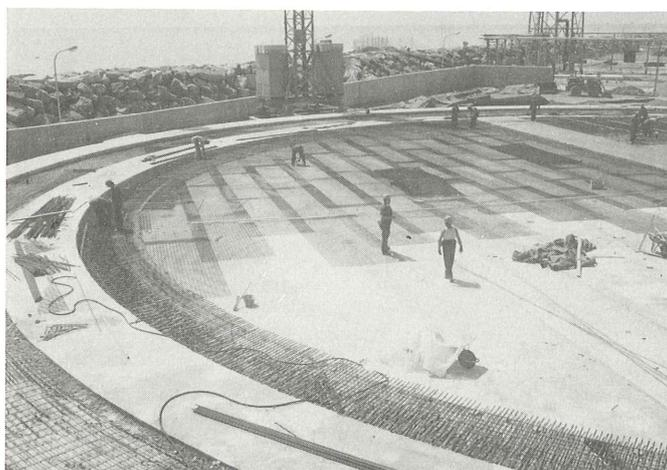
Esta cimentación lleva incorporada un sistema de calefacción eléctrica, a fin de evitar el progresivo enfriamiento del terreno.
