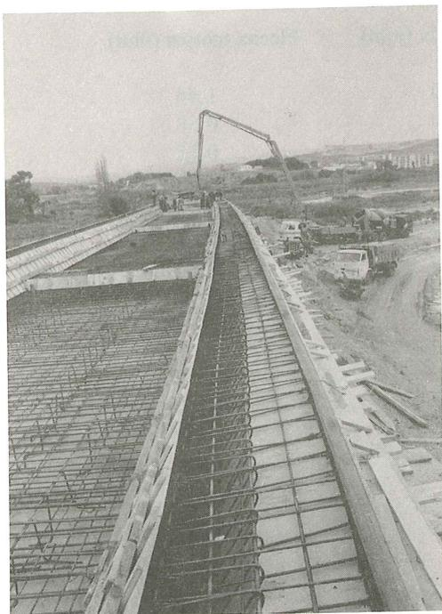
Fig. 8. Hormigonado del tablero.
