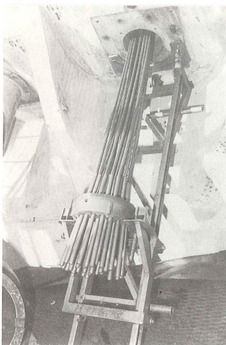
Fotografía 26. Colocación de un bloque anclaje en un tendón de la cúpula.
