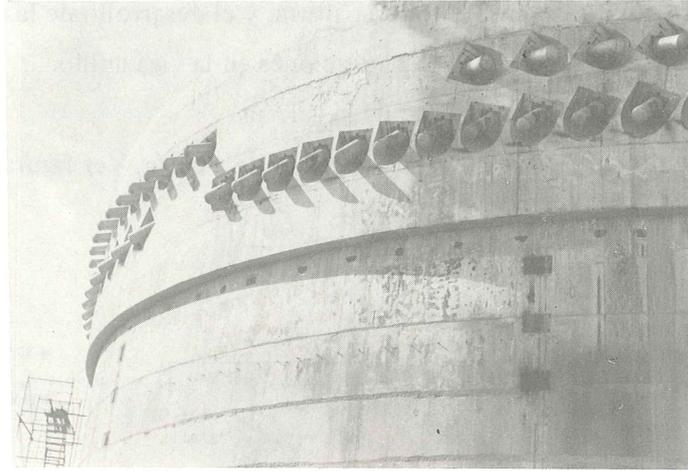
Fotografía 4. Viga anillo mostrando el saliente y los anclajes de los tendones de la cúpula.
