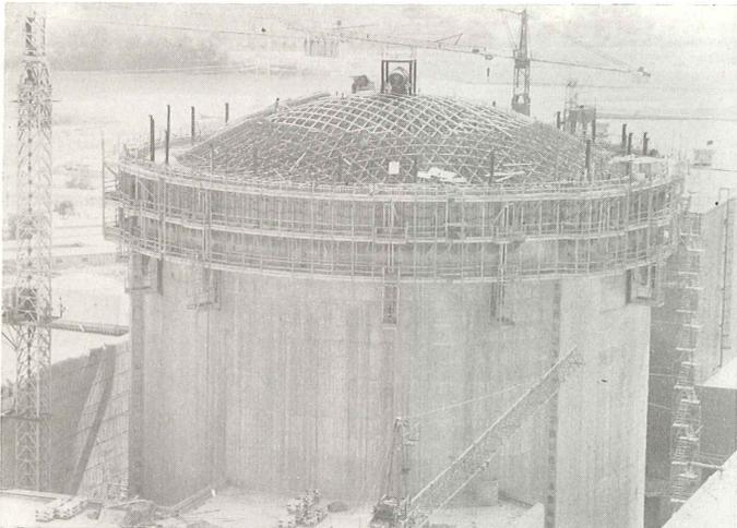
Fotografía 21: Edificio Contención—Vainas de los tendones de la cúpula terminadas.
