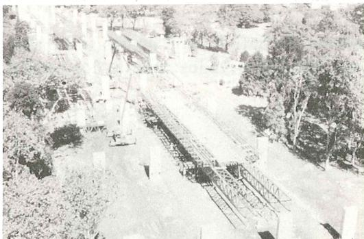
Fig. 10. Montaje de las cimbras autoportantes.
