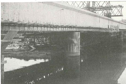
Fig. 12. Pretensado transversal.
