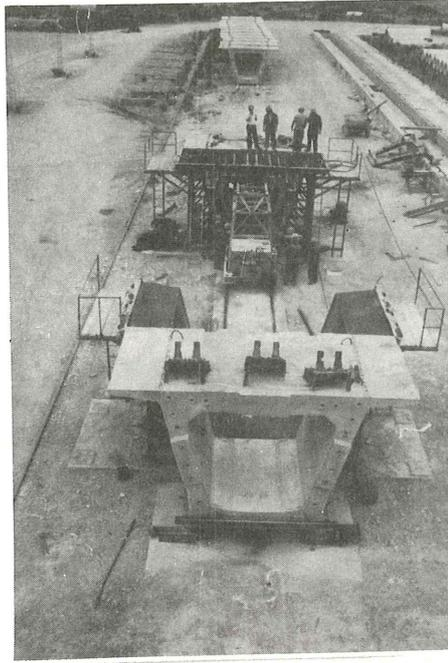
Fig. 2. Taller de prefabricación de las dovelas.
