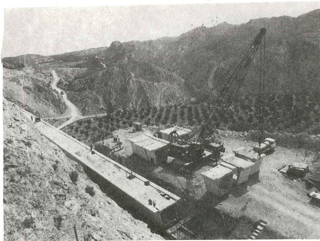
Fig. 3. Descarga y colocación de dovelas.
