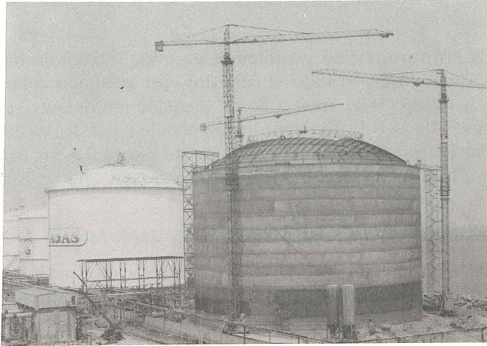
Para su construcción se ha presurizado el tanque a una presión admisible para la chapa de la cúpula, evitando que el peso del hormigón fresco fuese soportado por la estructura metálica.
