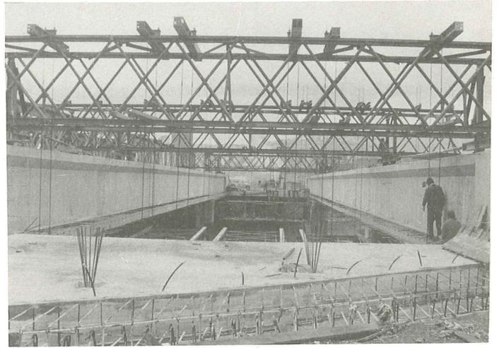
Fig. 11. Primera fase de hormigonado de la losa
