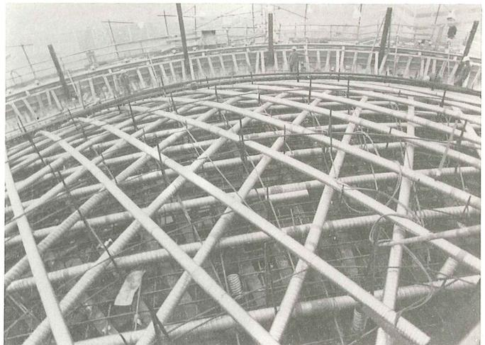
Fotografía 22: Detalle de las vainas de las tres capas de tendones de la cúpula.
