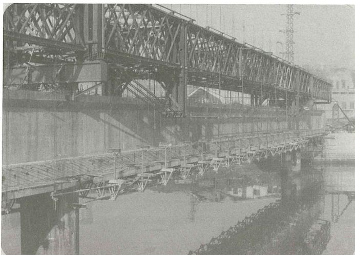
Fig. 8. Viga aguas arriba, antes de desencofrar el fondo.
