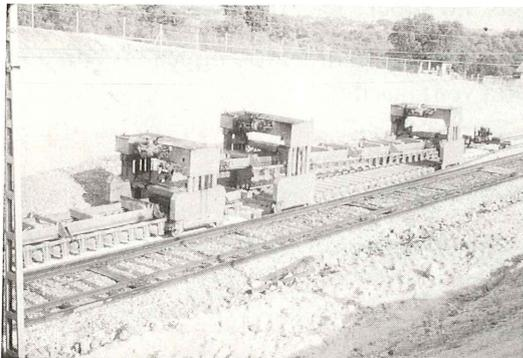
Fig. 7. Colocación de traviesas en obra mediante pórticos
