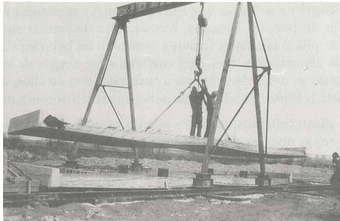
Fig. 6. Almacenamiento de placas prefabricadas
