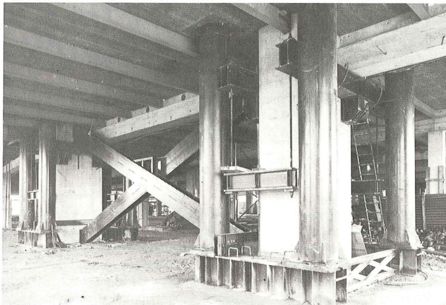
**Figura 29.— Arriostramiento de la base de los soportes de una de las torres de elevación. (Foto Bouygues).**
