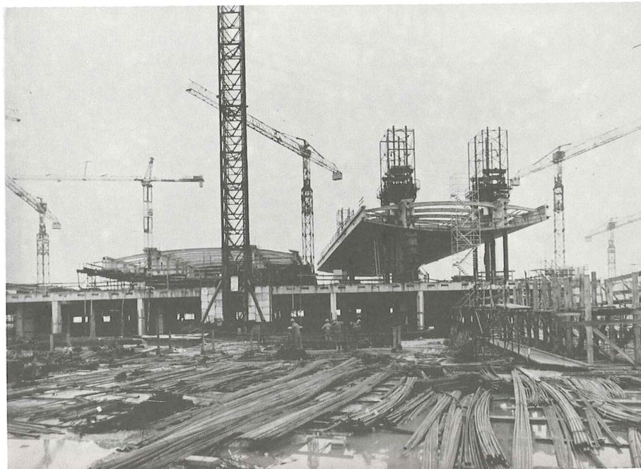
Figura.21.— Construcción de los cajones de la cubierta.
