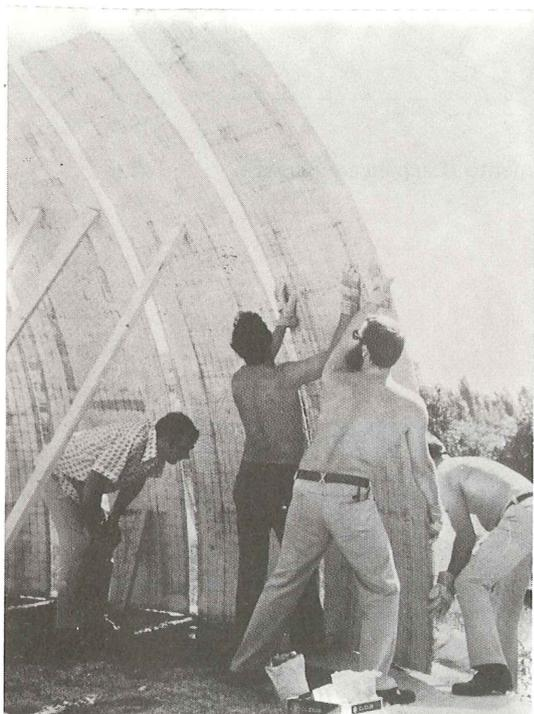
Fig. 24,25,26: Vivienda unifamiliar en ferrocemento: construcción Lachance y Picard.
