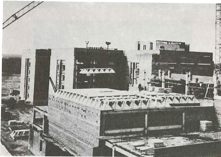
Fig. 39: Cubierta plana prefabricada en URSS.
