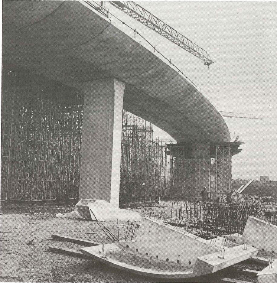
**Figura 31.**— Una de las piezas prefabricadas utilizadas en la construcción de los viaductos.
