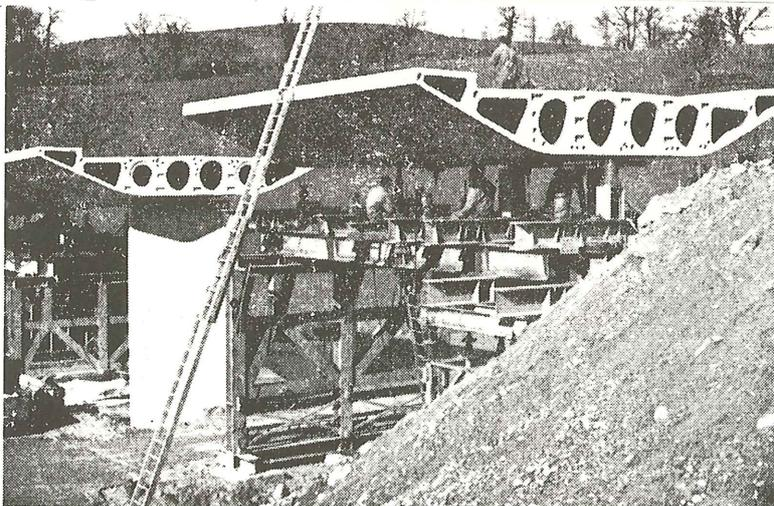
Fig. 1.13 Dovelas de sección alveolar para pasos superiores.
