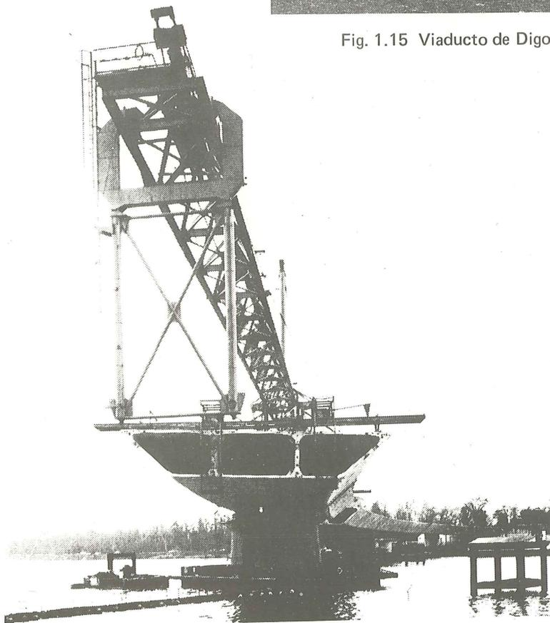
Fig. 1.16 Puente de Genevilliers. Colocación de una dovela.
