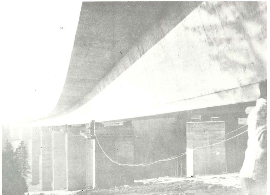
Fig. 12.7 Viaducto de Klagenfurt construido por empujamiento.
