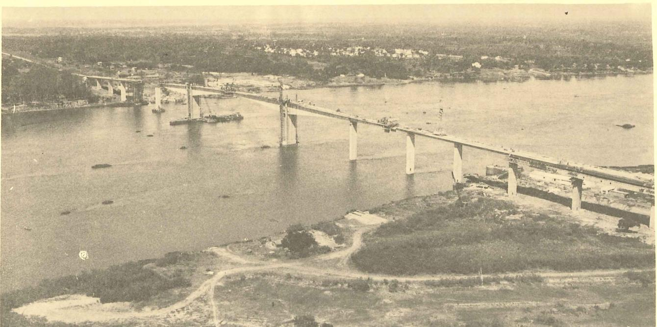
La unión entre accesos y tramo central se realiza mediante apoyos de neopreno-teflón que permiten movimientos horizontales, pero no verticales relativos, actuando como una rótula. Sobre estas dos rótulas existen las únicas juntas de calzada de toda la plataforma, previstas para absorber unos desplazamientos relativos de 66 y 28 cm.
