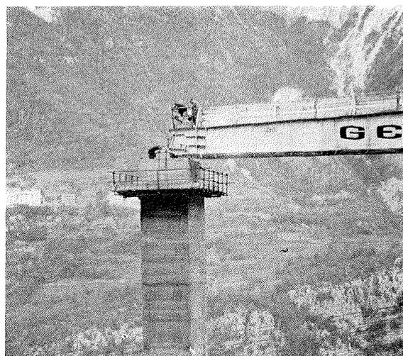
Fig. 5. — Encuentro del pescante metálico con una de las pilas del puente.
